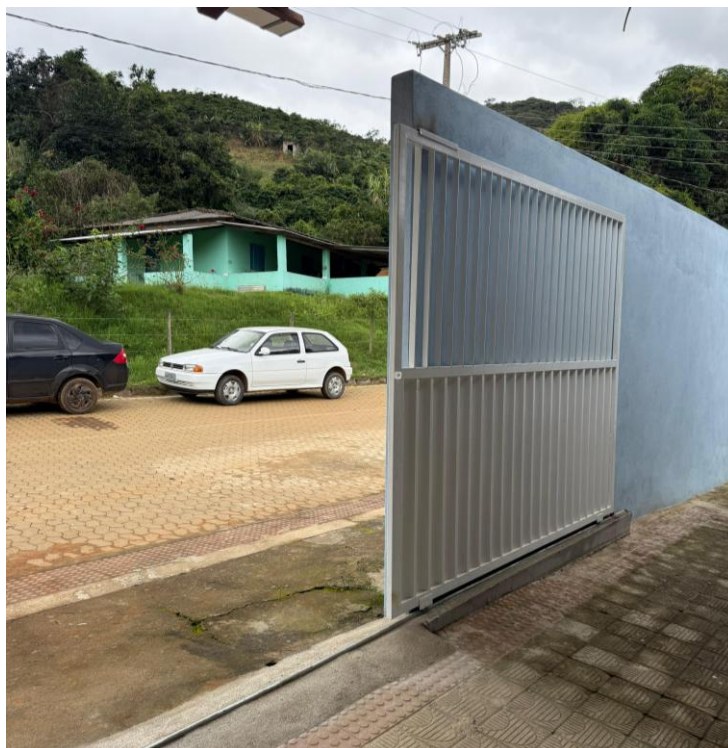
Fotos 01, 02 e 03 – Item 03.09 – Portão de ferro de correr em barra chata, inclusive chumbamento
