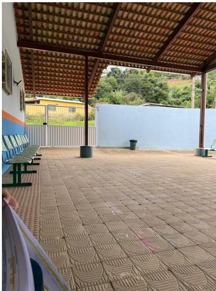
Foto 06 – Itens 13.03 e 13.04 - Índice de preço para remoção de entulho decorrente da execução de obras; Limpeza geral da obra (edificação)
