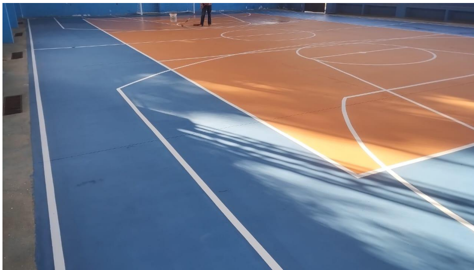
Foto 12 – Item 18.04.01 PINTURA COM TINTA À BASE DE RESINAS ACRÍLICAS, MARCAS DE REFERENCIA SUVINIL, CORAL OU NOVACOR, SOBRE PISO DE CONCRETO A DUAS DEMÃOS
