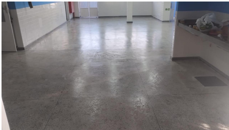
Foto 12 – Item 18.04.01 PINTURA COM TINTA À BASE DE RESINAS ACRÍLICAS, MARCAS DE REFERENCIA SUVINIL, CORAL OU NOVACOR, SOBRE PISO DE CONCRETO A DUAS DEMÃOS
