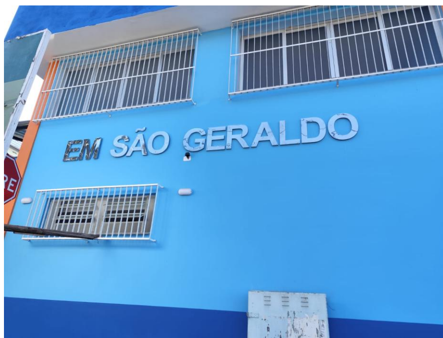
Fotos 02 e 03– Item 14.01.01 - LETREIRO DE IDENTIFICAÇÃO EM RELEVO INOX COM 12 LETRAS COM 40 CM DE ALTURA, FORNECIMENTO E INSTALAÇÃO.
