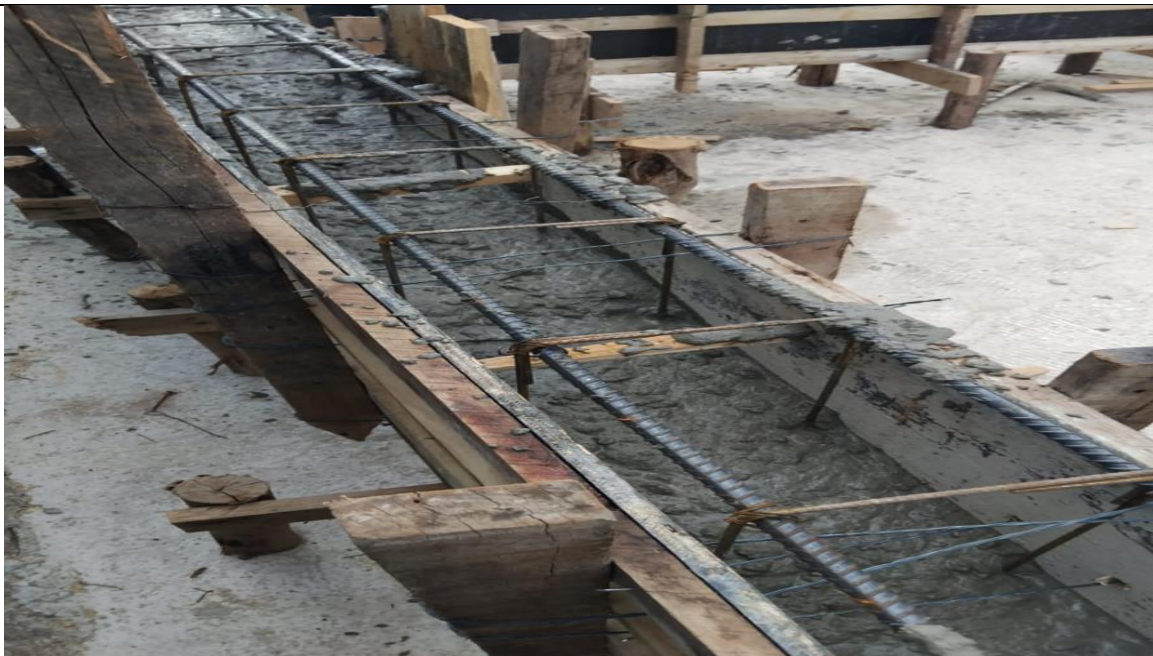
Foto 31 - 06.03.03 FORNECIMENTO, DOBRAGEM E COLOCAÇÃO EM FÔRMA, DE ARMADURA CA-50 A MÉDIA, DIÂMETRO DE 6.3 A 10.0 MM.
