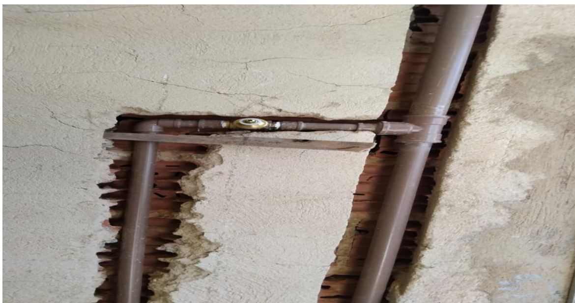
Foto 38 - 07.05.01 TUBO DE PVC RÍGIDO SOLDÁVEL MARROM, DIÂM. 25MM (3/4"), INCLUSIVE CONEXÕES.
