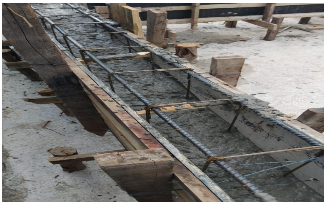
Foto 30 - 06.03.02 FÔRMA DE TÁBUA DE MADEIRA DE 2.5 X 30.0 CM PARA FUNDAÇÕES, LEVANDO-SE EM CONTA A UTILIZAÇÃO 5 VEZES (INCLUIDO O MATERIAL, CORTE, MONTAGEM, ESCORAMENTO E DESFORMA).
