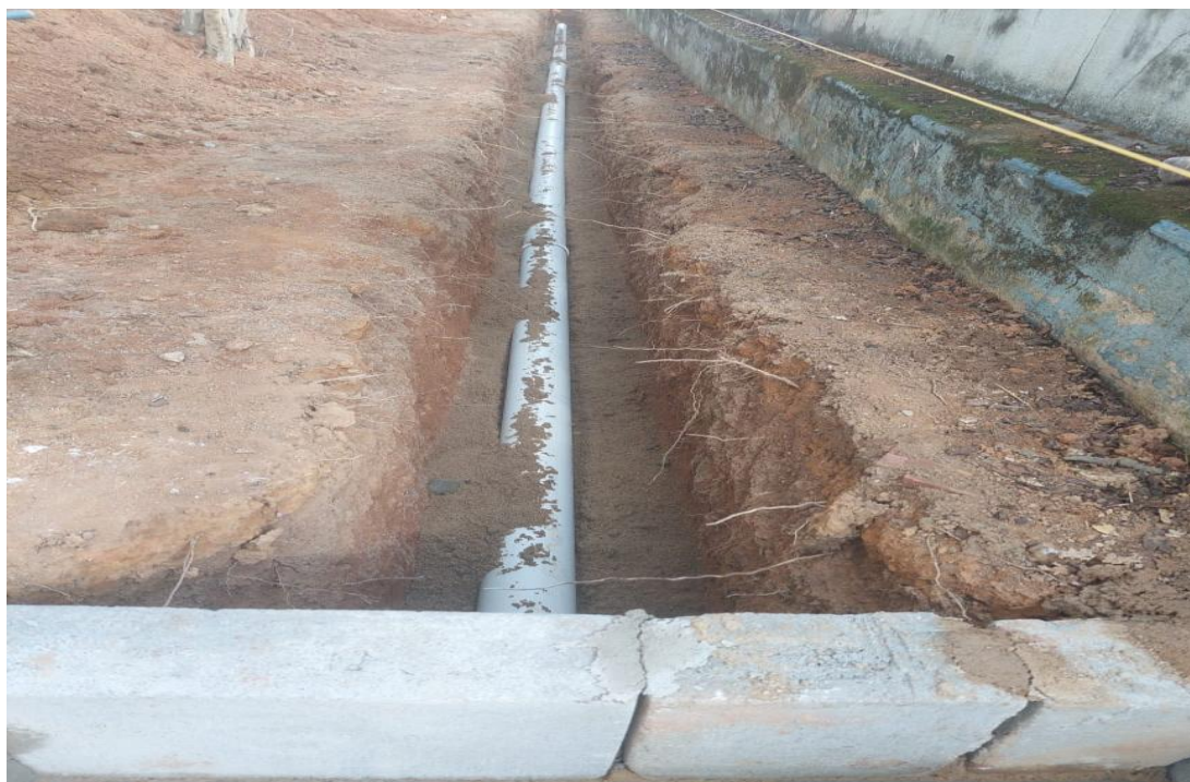
Foto 40 - 14.03 TUBO PVC, SÉRIE R, ÁGUA PLUVIAL, DN 150 MM, FORNECIDO E INSTALADO EM CONDUTORES VERTICAIS DE ÁGUAS PLUVIAIS. AF_06/2022
