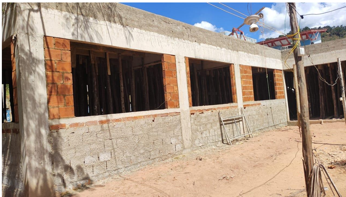
Foto 28 - 03.08.09 Verga/contraverga reta de concreto armado 10 x 5 cm, Fck = 15 MPa, inclusive forma, armação e desforma.
