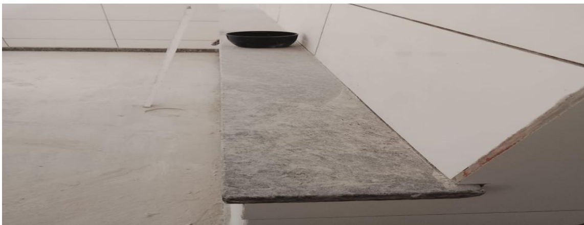
Foto 27 – Item 03.08.07 - Peitoril de granito cinza polido, 15 cm, esp. 3cm
