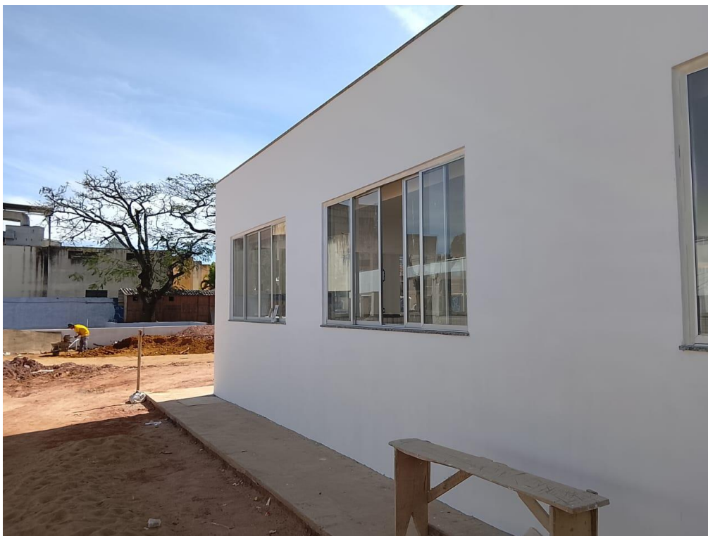
Foto 13 – Item 03.02.08. Emassamento de paredes e forros, com duas demãos de massa acrílica, marcas de referência Suvinil, Coral ou Metalatex.
