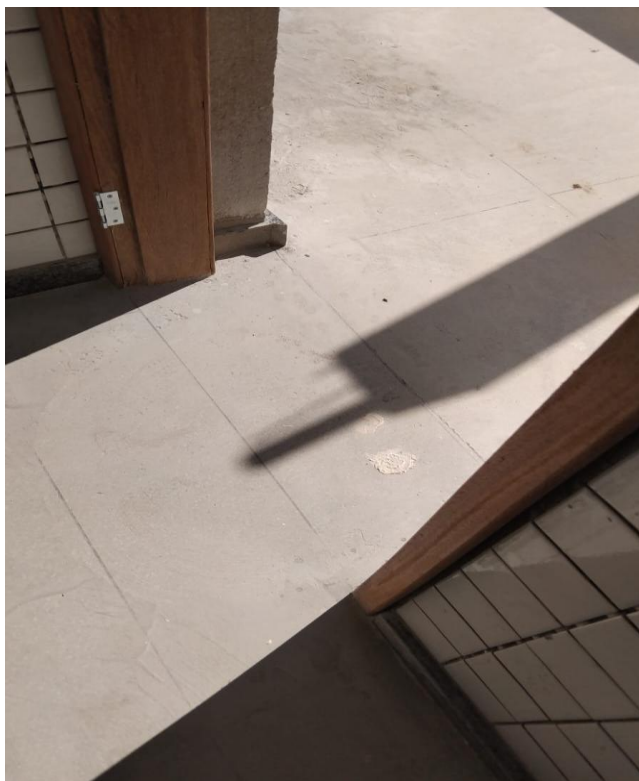
Foto 17 – Item 03.06.06 - Soleira de argamassa de alta resistência tipo granilite ou equivalente de qualidade comprovada, largura de 15cm, executado com cimento e granitina grana
