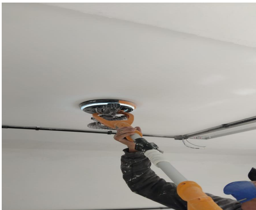
Fotos 05 e 06 – Item 03.02.03 - LIXAMENTO DE PAREDE COM PINTURA ANTIGA PVA PARA RECEBIMENTO DE NOVA CAMADA DE TINTA
