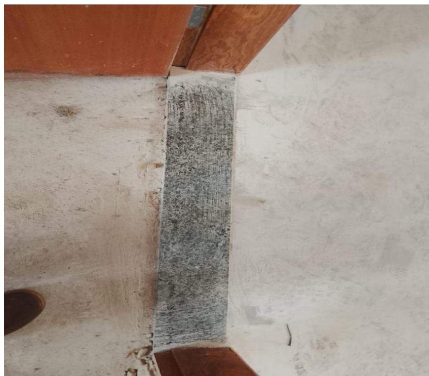
Foto 16 – Item 03.06.03 - SOLEIRA DE GRANITO ESP. 2 CM E LARGURA DE 15 CM
