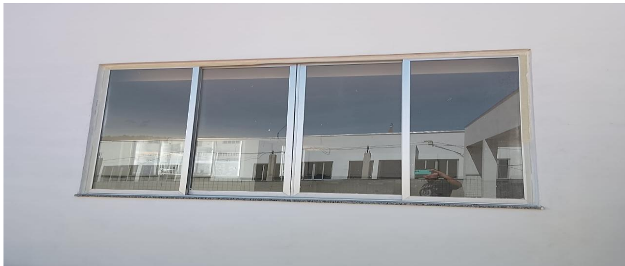
Fotos 23, 24 e 25 – Itens 03.08.01 e 03.08.05 - JANELA DE CORRER PARA VIDRO EM ALUMÍNIO ANODIZADO COR NATURAL, LINHA 25, COMPLETA, INCL. PUXADOR COM TRANCA, ALIZAR, CAIXILHO E CONTRAMARCO, EXCLUSIVE VIDRO; Vidro plano transparente liso, com 4 mm de espessura
