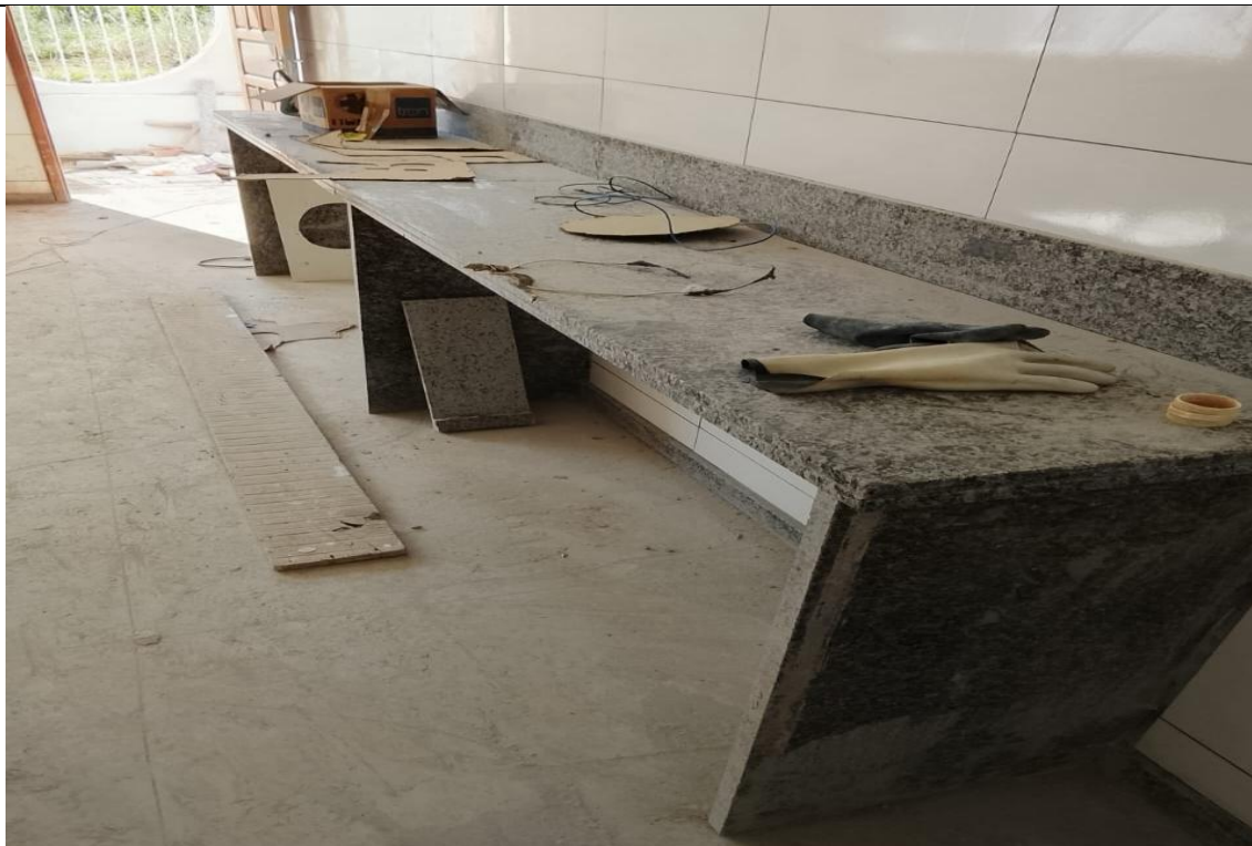
Foto 33 - 06.09.02.02 BANCADA DE GRANITO CINZA ANDORINHA, ESPESSURA DE 2 CM COM ABERTURA PARA CUBA DE EMBUTIR, E RODABANCADA H=7CM ESP.=2CM.
