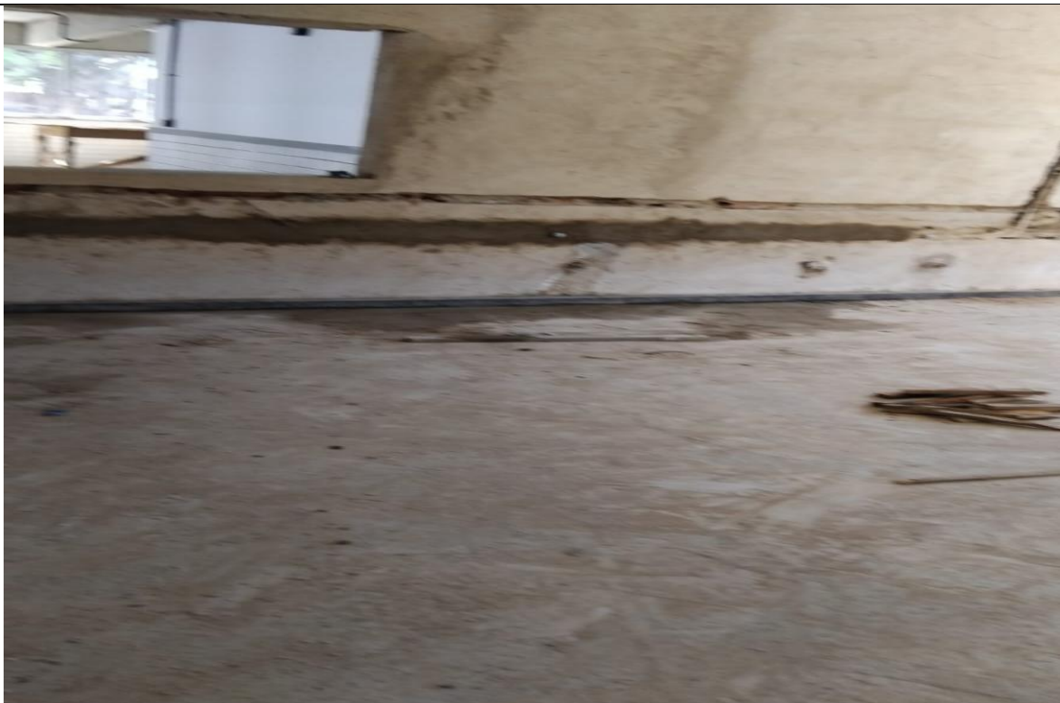
Foto 39 - 07.05.22 Abertura e fechamento de rasgos em alvenaria, para passagem de tubulações, diâm. 1/2" a 1".
