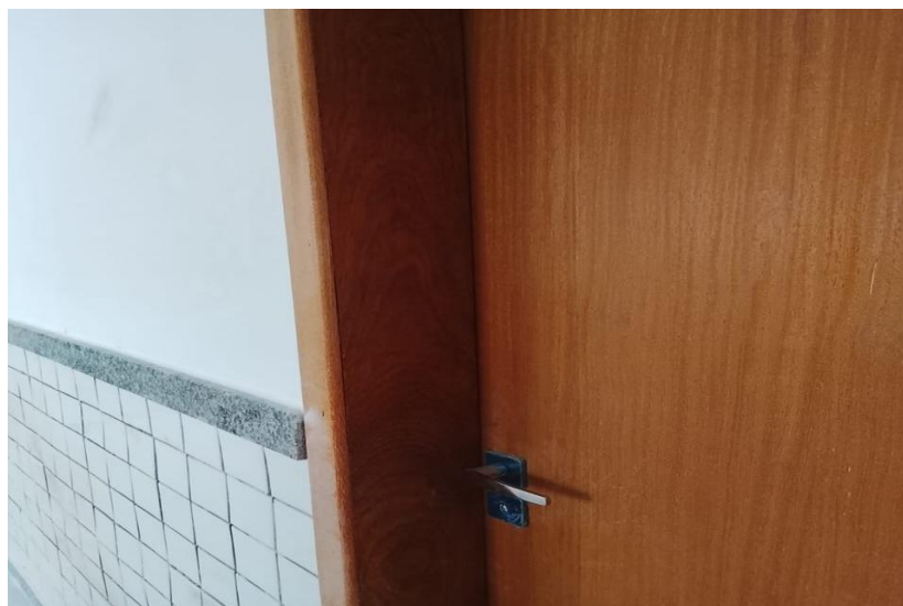
Foto 18 – Itens 03.07.01 e 03.07.08 - PORTA EM MADEIRA DE LEI TIPO ANGELIM PEDRA OU EQUIV.C/ENCHIMENTO EM MADEIRA 1A.QUALIDADE ESP. 30MM P/ PINTURA, INCLUSIVE ALIZARES, DOBRADIÇAS E FECHADURA EXTERNA EM LATÃO CROMADO LAFONTE OU EQUIV., EXCLUSIVE MARCO, NAS DIM.:0.60 X 2.10 M; MARCO DE MADEIRA DE LEI DE 1ª (PEROBA, IPÊ, ANGELIM PEDRA OU EQUIVALENTE) COM 15X3 CM DE BATENTE, NAS DIMENSÕES DE 0.80 X 2.10 M
