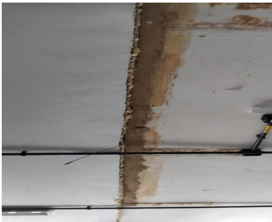
Fotos 03 e 04 – Item 03.01.03 - Execução de junta de dilatação 2 x 2 cm considerando 1cm de aplicação de isopor e 1cm de aplicação de mastique elástico do tipo sikaflex 1a ou equivalente.
