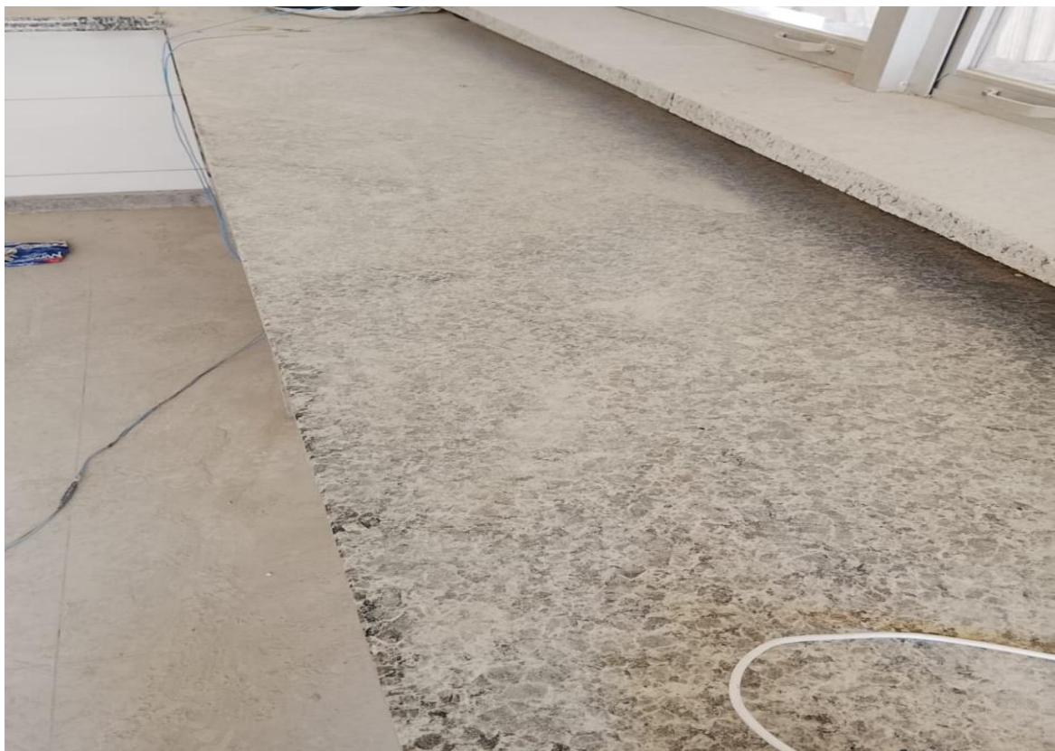
Foto 37 - 07.04.01 BANCADA DE GRÁNITO COM ESPESSURA DE 2 CM.
