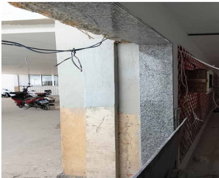
Fotos 21 e 22 – Item 03.07.11 - Contramarco de granito para portas de vidro com 0,23cm de largura e 3 cm de esp
