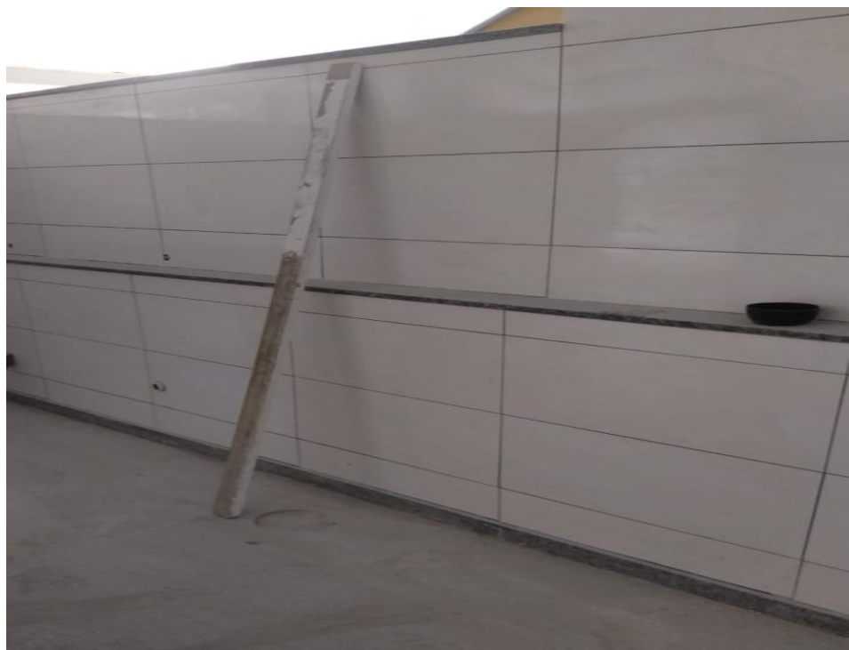
Fotos 09 e 10 – Item 03.02.06 - REVESTIMENTO CERÂMICO PARA PAREDES INTERNAS COM PLACAS TIPO ESMALTADA PADRÃO POPULAR DE DIMENSÕES 20X20 CM, ARGAMASSA TIPO AC I, APLICADAS NA ALTURA INTEIRA DAS PAREDES. AF_02/2023_PE
