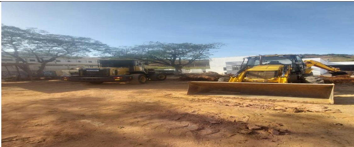
Foto 29 - 06.02.01 ESCAVAÇÃO MECÂNICA EM MATERIAL DE 1A. CATEGORIA.
