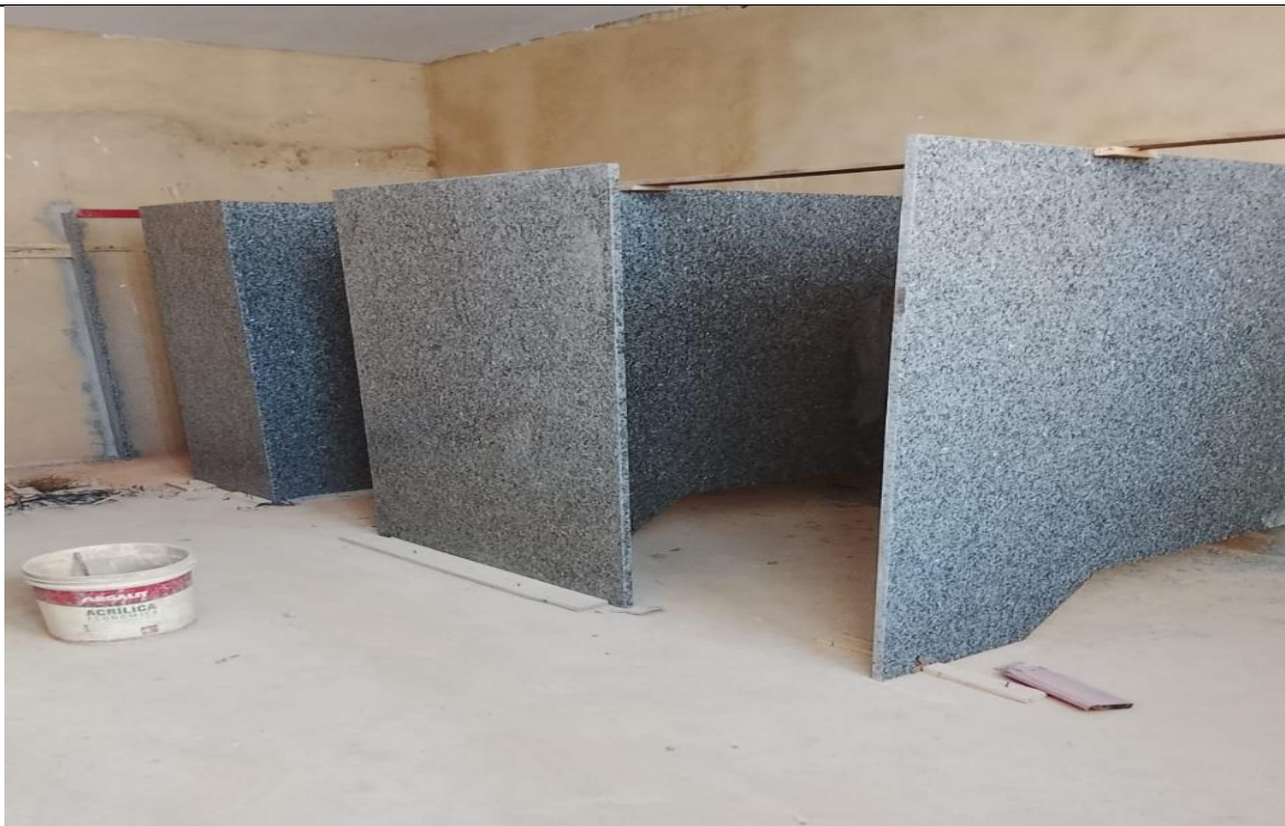
Fotos 34 e 35 - 07.03.07 DIVISÓRIA DE GRANITO CINZA ANDORINHA COM 3 CM DE ESPESSURA, FIXADA COM CANTONEIRA DE FERRO CROMADO.
