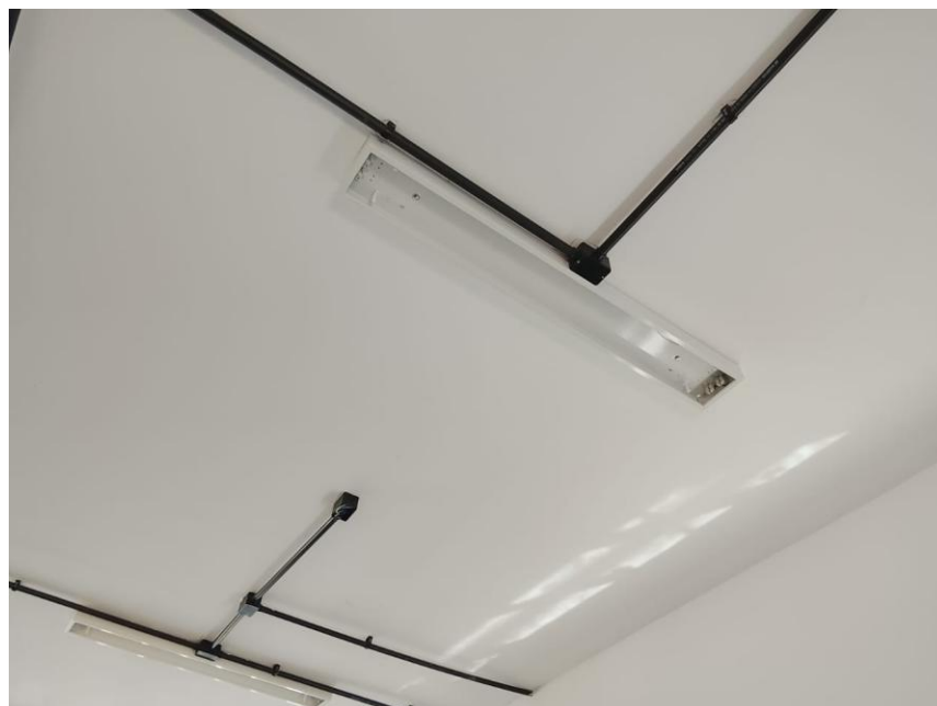
Foto 13 – Item 03.02.08. Emassamento de paredes e forros, com duas demãos de massa acrílica, marcas de referência Suvinil, Coral ou Metalatex.
