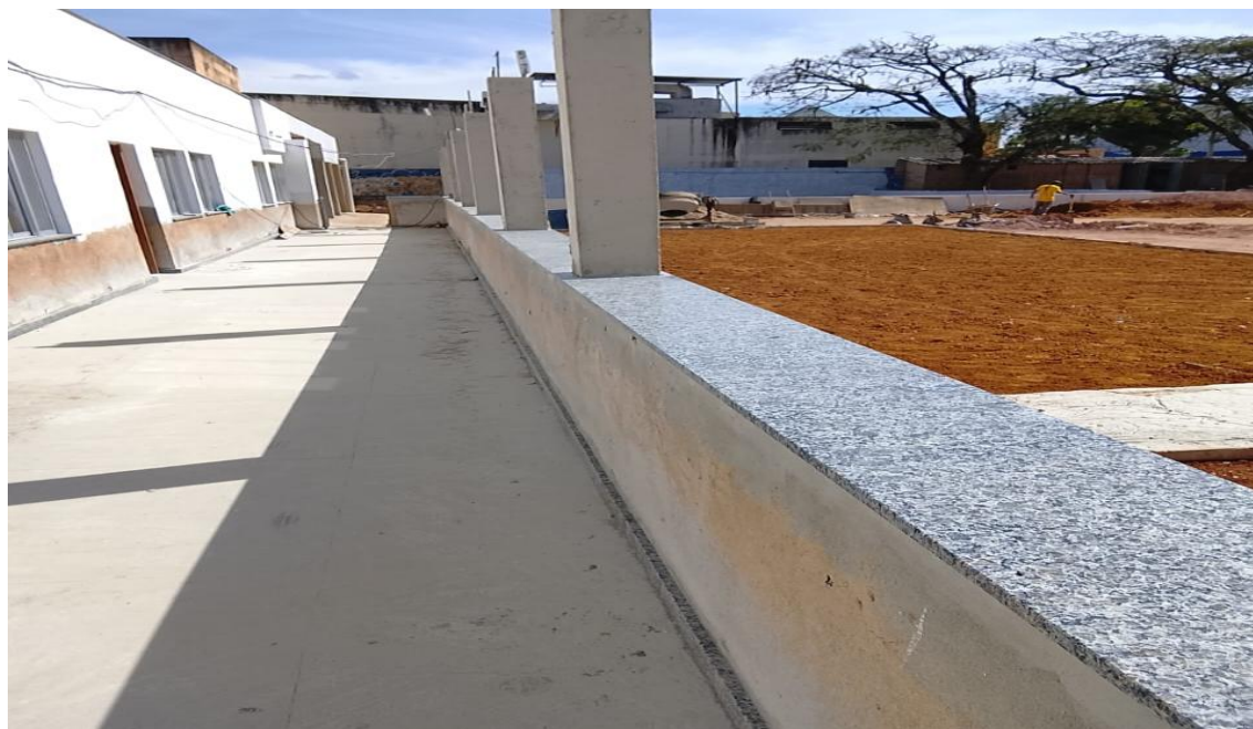
Foto 26 – Item 03.08.06 - Peitoril de granito cinza polido, 25 cm, esp. 3cm
