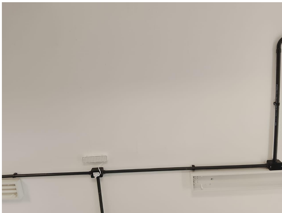
Fotos 14 e 15 – Item 03.02.09. Emassamento de paredes e forros, com duas demãos de massa à base de PVA, marcas de referência Suvinil, Coral ou Metalatex
