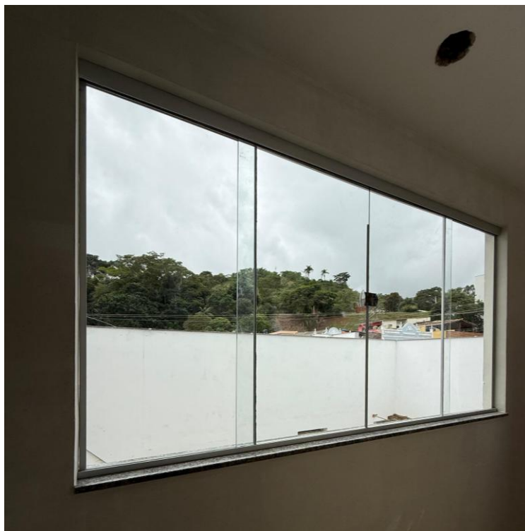
Fotos 16 e 17 – Itens 08.05 e 11.04 Fornecimento e instalação de janela em vidro temperado incolor 8mm, inclusive perfis e ferragens; Peitoril de granito cinza polido
