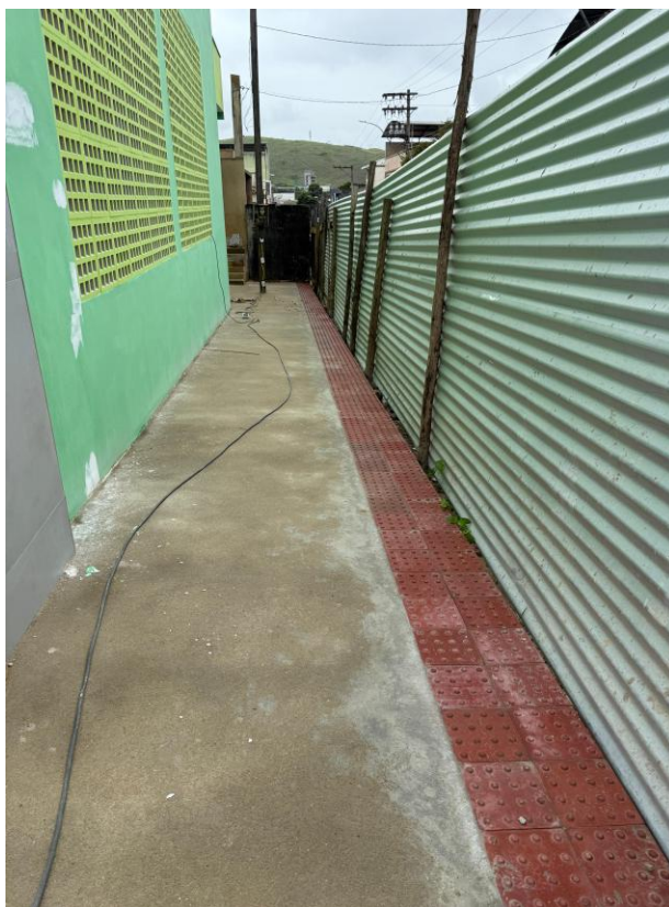
Fotos 35 e 36 – Itens 10.01, 10.02 e 10.04 - Fornecimento e assentamento de ladrilho hidráulico pastilhado, vermelho; Lastro regularizado de concreto não estrutural, espessura de 8 cm; Piso de cimentoado camurçado
