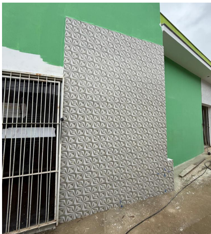
Fotos 19, 20 e 21– Itens 11.01 e 11.02 - Chapisco de argamassa de cimento e areia média ou grossa lavada, no traço; Reboco tipo paulista de argamassa de cimento, cal hidratada CH1 e areia média ou grossa lavada no traço 1:0.5:6, espessura 25 mm
