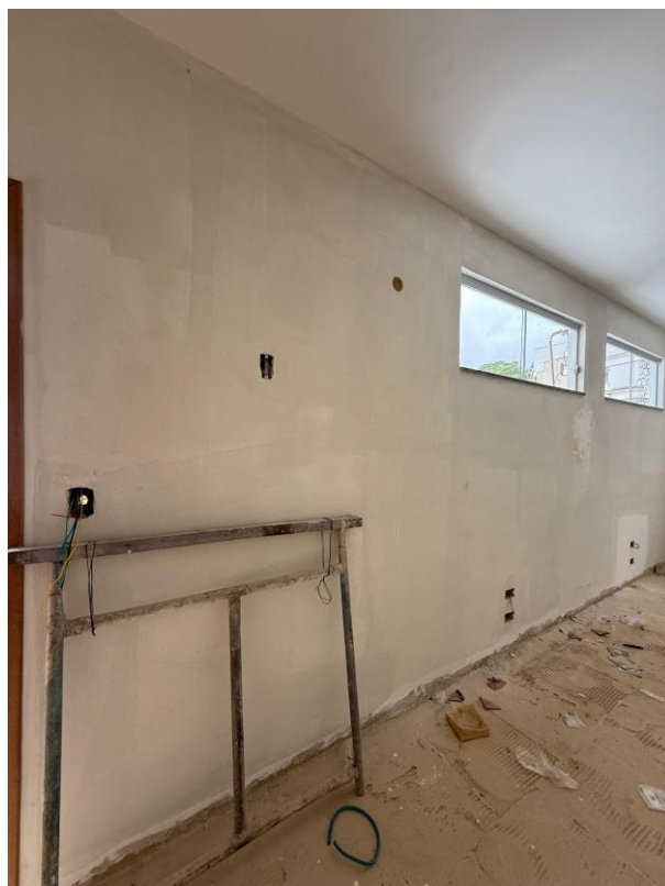
Fotos 03 – Item 02.02 - Retirada de revestimento antigo em reboco
