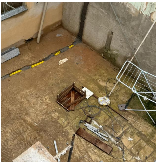
Fotos 01 e 02 – Item 02.01 - Demolição de piso revestido com cerâmica
