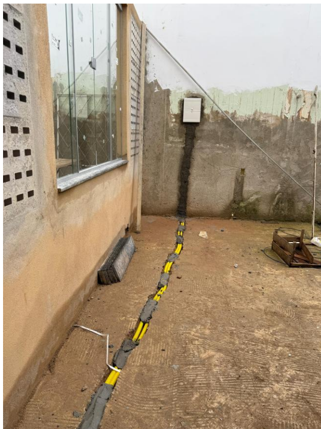
Foto 33 – Item 13.14 - Fio de cobre termoplástico, com isolamento para 750V, seção de 2.5 mm 2
