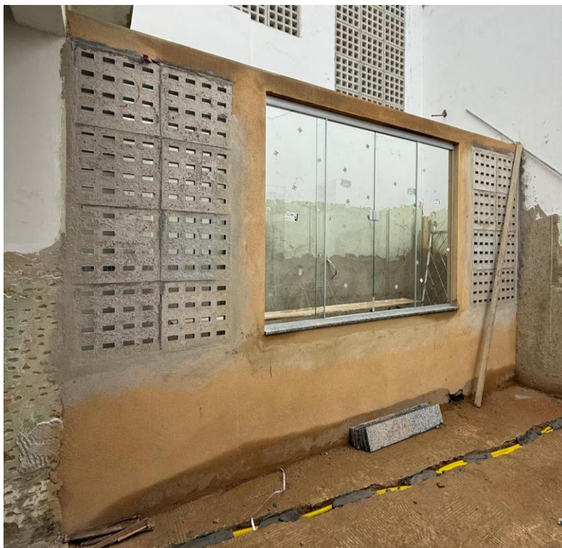
Foto 13 – Itens 06.04 e 08.05 - Alvenaria de blocos cerâmicos 10 furos 10x20x20cm, assentados c/argamassa de cimento; Fornecimento e instalação de janela em vidro temperado incolor 8mm, inclusive perfis e ferragens
