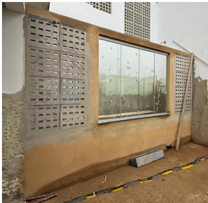
Fotos 19, 20 e 21– Itens 11.01 e 11.02 - Chapisco de argamassa de cimento e areia média ou grossa lavada, no traço; Reboco tipo paulista de argamassa de cimento, cal hidratada CH1 e areia média ou grossa lavada no traço 1:0.5:6, espessura 25 mm
