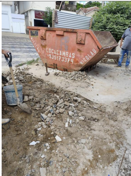
Fotos 42 e 43 – Item 04.11 - Índice de preço para remoção de entulho decorrente da execução de obras (Classe A CONAMA – NBR 10.004 - Classe II-B), incluindo aluguel da caçamba, carga, transporte e descarga em área licenciada
