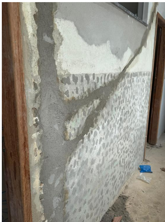
Fotos 03 – Item 02.02 - Retirada de revestimento antigo em reboco
