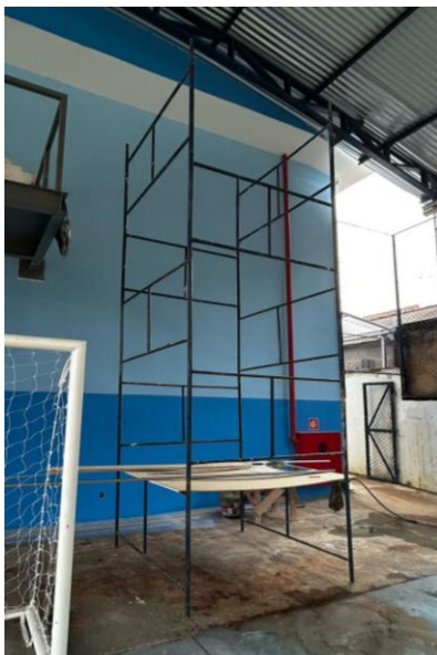
Foto 01 – Item 01.02 - LOCAÇÃO DE ANDAIME METÁLICO PARA FACHADA - TIPO TORRE (ALUGUEL MENSAL)
