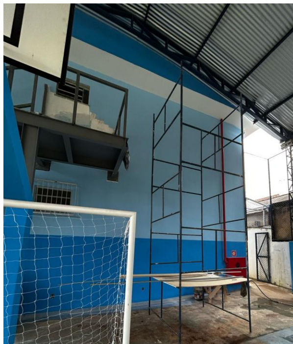
Fotos 02 e 03 – Item 05.02.03 - APLICAÇÃO MANUAL DE PINTURA COM TINTA LÁTEX ACRÍLICA EM PAREDES, DUAS DEMÃOS
