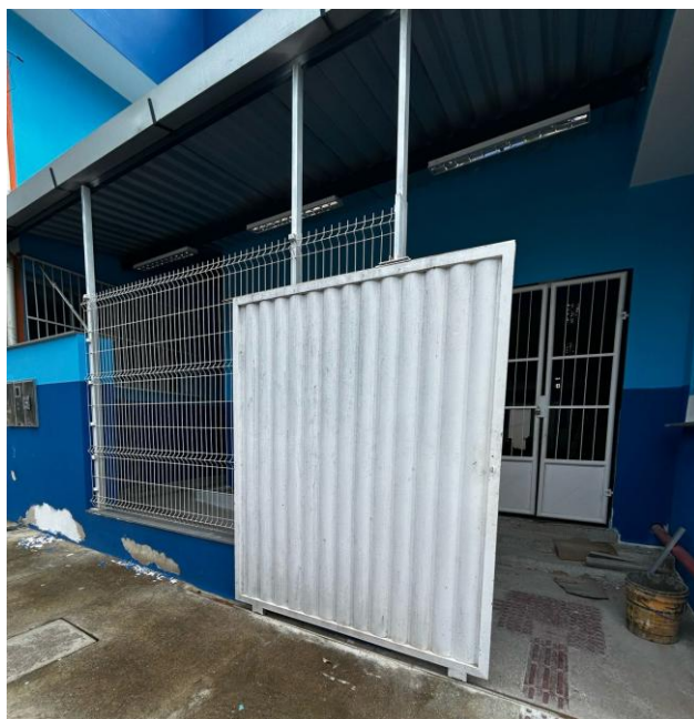
Foto 09 – Item 09.01.08 - PORTÃO ELETRÔNICO DE CORRER EM CHAPA TIPO PAINEL LAMBRIL 1,20 X 3,00M, COM REQUADRO, ACABAMENTO NATURAL COM TRILHOS E ROLDANAS
