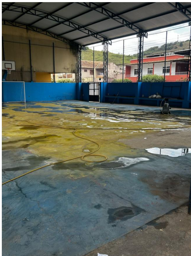
Foto 19 – Item 19.01 - LIMPEZA GERAL DE OBRAS (QUADRAS, PRAÇAS E JARDINS)
