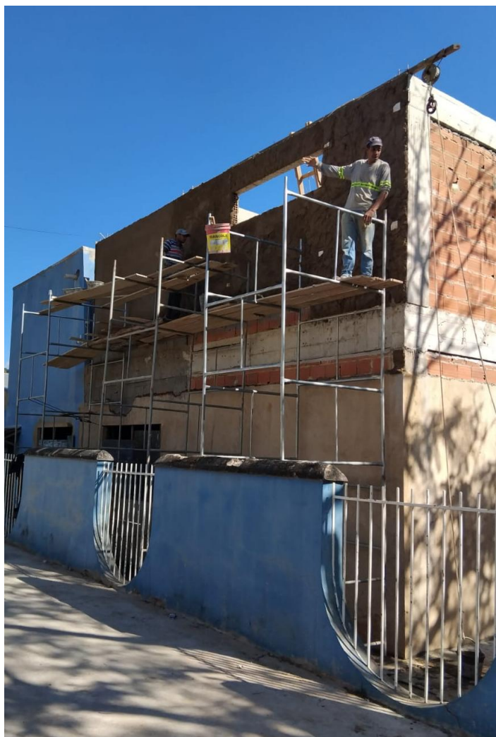
Figura 1 - Item 01.11 - LOCAÇÃO DE ANDAIME METÁLICO PARA FACHADA - TIPO TORRE (ALUGUEL MENSAL)
