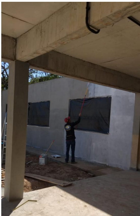
Figura 2 - Item 03.02.05 - PINTURA COM TINTA ACRÍLICA, MARCAS DE REFERÊNCIA SUVINIL, CORAL OU METALATEX, INCLUSIVE SELADOR ACRÍLICO, EM PAREDES E FORROS, A TRÊS DEMÃOS
