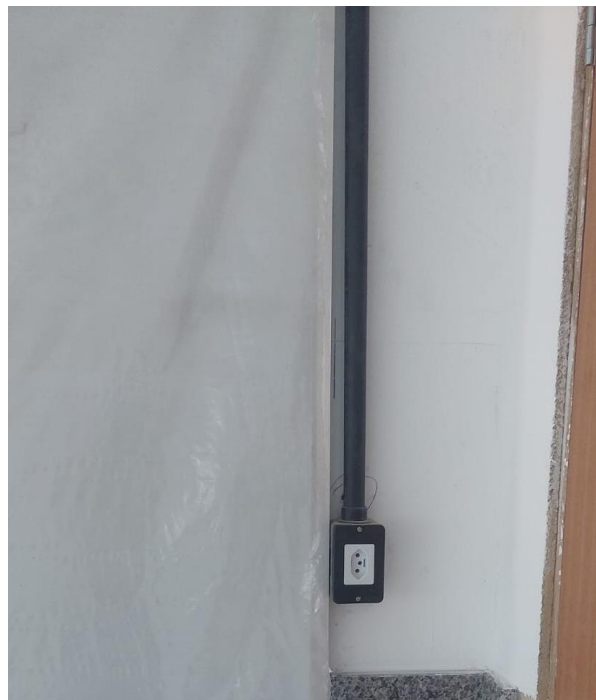
Figura 15 - Item 09.07.01 - TOMADA PADRÃO BRASILEIRO LINHA BRANCA, NBR 14136 2 POLOS + TERRA 10A/250V, COM PLACA 4X2" PARA CONDULETE
