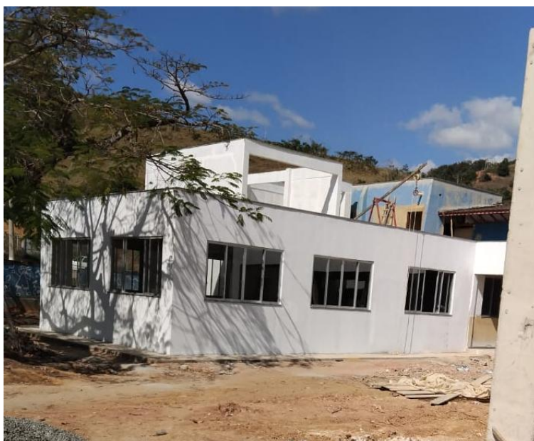
Figura 3 - Item 03.02.05 - PINTURA COM TINTA ACRÍLICA, MARCAS DE REFERÊNCIA SUVINIL, CORAL OU METALATEX, INCLUSIVE SELADOR ACRÍLICO, EM PAREDES E FORROS, A TRÊS DEMÃOS
