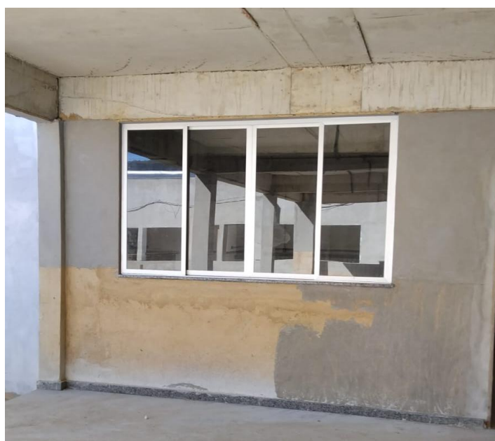
Figura 7 - Item 03.08.01 - JANELA DE CORRER PARA VIDRO EM ALUMÍNIO ANODIZADO COR NATURAL, LINHA 25, COMPLETA, INCL. PUXADOR COM TRANCA, ALIZAR, CAIXILHO E CONTRAMARCO, EXCLUSIVE VIDRO
