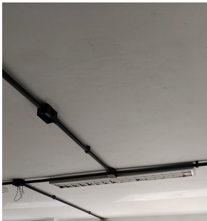
Figura 5 - Item 03.04.02 - PINTURA COM TINTA LÁTEX PVA, MARCAS DE REFERÊNCIA SUVINIL, CORAL OU METALATEX, INCLUSIVE SELADOR EM PAREDES E FORROS, A TRÊS DEMÃOS
