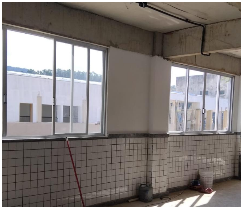
Figura 8 - - Item 03.08.01 - JANELA DE CORRER PARA VIDRO EM ALUMÍNIO ANODIZADO COR NATURAL, LINHA 25, COMPLETA, INCL. PUXADOR COM TRANCA, ALIZAR, CAIXILHO E CONTRAMARCO, EXCLUSIVE VIDRO
