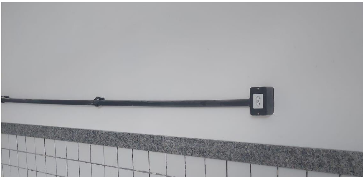
Figura 16 - Item 09.07.01 - TOMADA PADRÃO BRASILEIRO LINHA BRANCA, NBR 14136 2 POLOS + TERRA 10A/250V, COM PLACA 4X2" PARA CONDULETE
