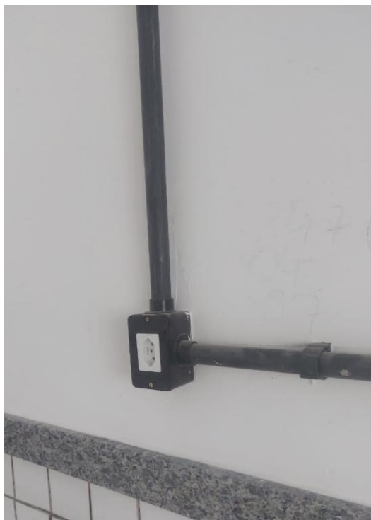
Figura 14 - Item 09.07.01 - TOMADA PADRÃO BRASILEIRO LINHA BRANCA, NBR 14136 2 POLOS + TERRA 10A/250V, COM PLACA 4X2" PARA CONDULETE
