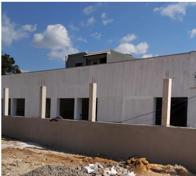
Figura 4 - Item 03.02.05 - PINTURA COM TINTA ACRÍLICA, MARCAS DE REFERÊNCIA SUVINIL, CORAL OU METALATEX, INCLUSIVE SELADOR ACRÍLICO, EM PAREDES E FORROS, A TRÊS DEMÃOS
