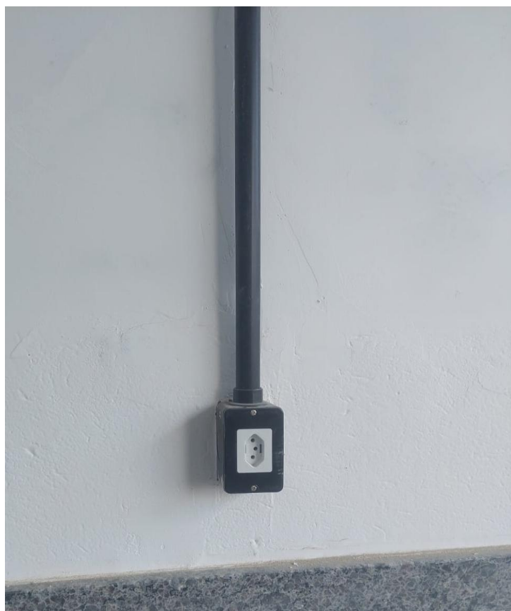
Figura 13 - Item 09.07.01 - TOMADA PADRÃO BRASILEIRO LINHA BRANCA, NBR 14136 2 POLOS + TERRA 10A/250V, COM PLACA 4X2" PARA CONDULETE
