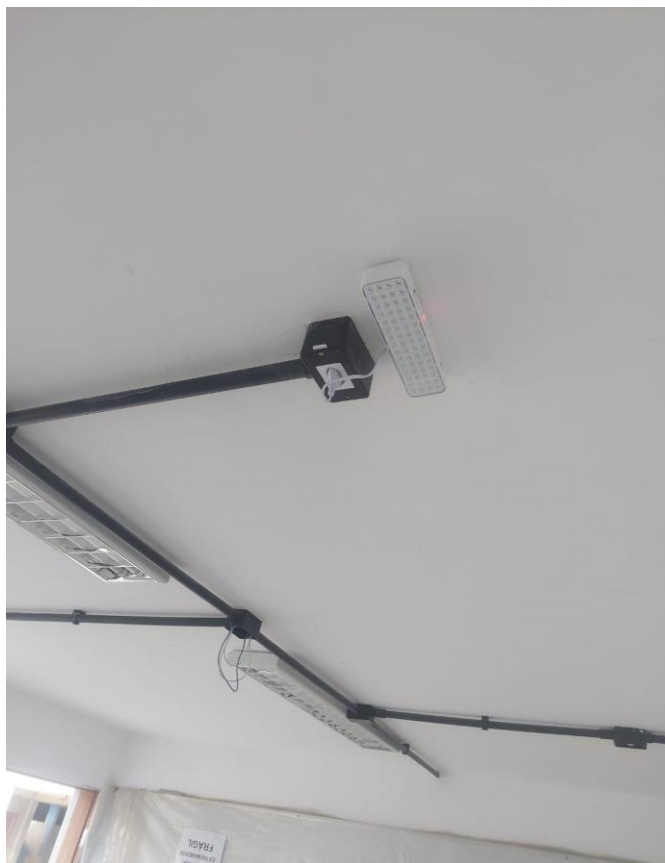
Figura 6 - Item 03.04.02 - PINTURA COM TINTA LÁTEX PVA, MARCAS DE REFERÊNCIA SUVINIL, CORAL OU METALATEX, INCLUSIVE SELADOR EM PAREDES E FORROS, A TRÊS DEMÃOS
