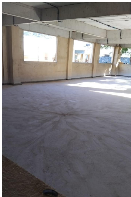
Foto 09 – Item 03.05.03 - ISO ARGAMASSA ALTA RESISTENCIA TIPO GRANILITE OU EQUIV
