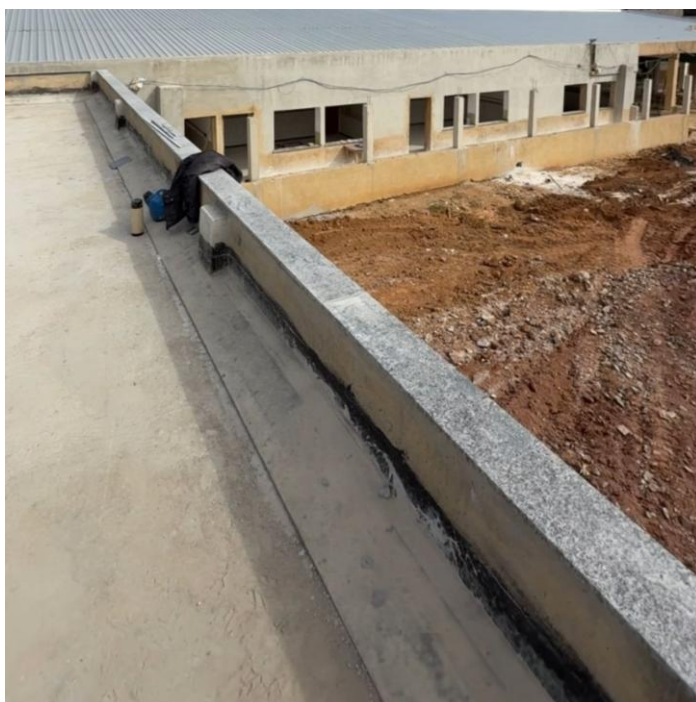
Fotos 04, 05 e 06 – Item 03.03.04 e 07.04.03- CHAPIM SOBRE MUROS LINEARES, EM GRANITO OU MARMORE, L=25CM, ASSENTADO COM ARGAMASSA 1:6 COM ADITIVO. Af_11/2020
