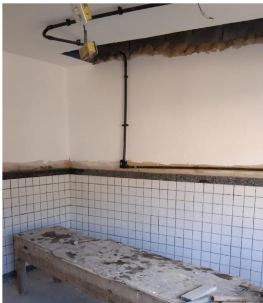
Fotos 02 e 03 – Itens 03.02.03 e 03.02.05 - LIXAMENTO DE PAREDE COM PINTURA ANTIGA PVA PARA RECEBIMENTO DE NOVA CAMADA DE TINTA; PINTURA COM TINTA ACRILICA, MARCAS DE REFERENCIA SUVINIL, CORAL OU MELATEX
