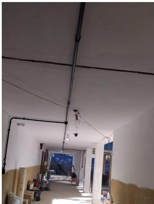
Fotos 07 e 08 – Itens 03.04.01 e 03.04.02 - LIXAMENTO MANUALL EM TETO PARA REMOÇÃO DE TINTA; PINTURA COM TINTA LATEX, PVA MARCAS DE REFERENCIA SUVINIL, CORAL OU METALATEX, INCLUSIVE SELADOR EM PAREDES E FORROS, A TRES DEMÃOS.
