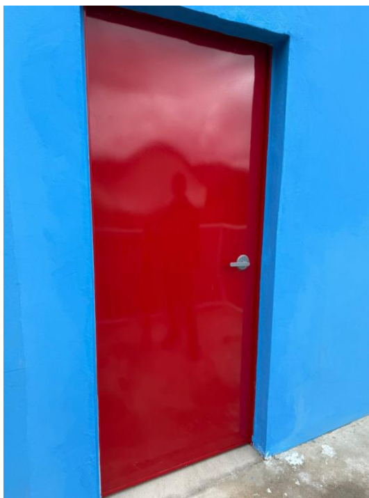
Foto 12- Itens 01.02 e 05.04 - Demolição de alvenaria; Fornecimento e instalação de porta corta-fogo para saída de emergência.
