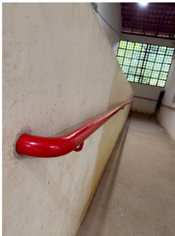
Fotos 01, 02, 03 e 04 – Itens 02-08 – corrimão de tubo de ferro galvanizado diâmetro 3 fixado na parede a cada 1.50m, inclusive pintura a óleo
