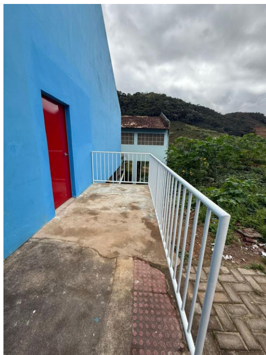
Foto 14 – Item 08.01 - GUARDA-CORPO DE AÇO GALVANIZADO DE 1,10M, MONTANTES TUBULARES DE 1.1/4 ESPAÇADOS DE 1,20M, TRAVESSA SUPERIOR DE 1.1/2, GRADIL FORMADO POR TUBOS HORIZONTAIS DE 1 E VERTICAIS DE 3/4, FIXADO COM CHUMBADOR MECÂNICO. AF_04/2019_PS
