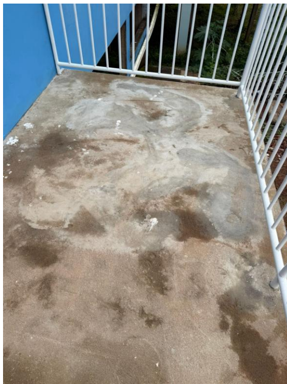
Foto 13 - 03.01 – fornecimento, preparo e aplicação de concreto
