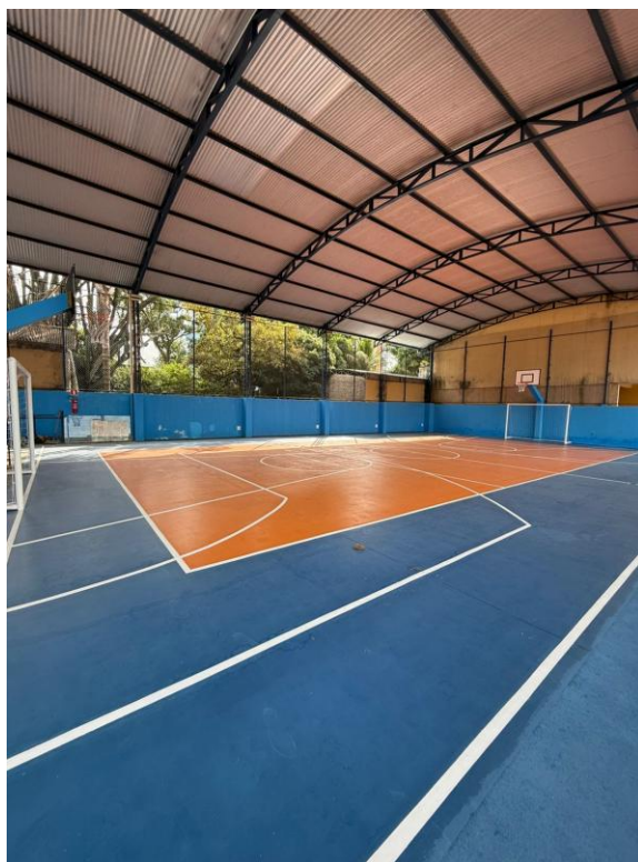
Fotos 03 e 04 – Item 18.04.02 pintura a base de epóxi, marcas de referência Suvinil, coral ou metalatex, a duas demãos, inclusive fundo anticorrosivo a uma demão, em metal e 19.02 - Limpeza geral da obra (edificação)
