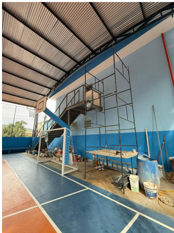
Foto 11 – Itens 01.02 – Locação de andaime metálico para fachada – tipo torre (aluguel mensal)
