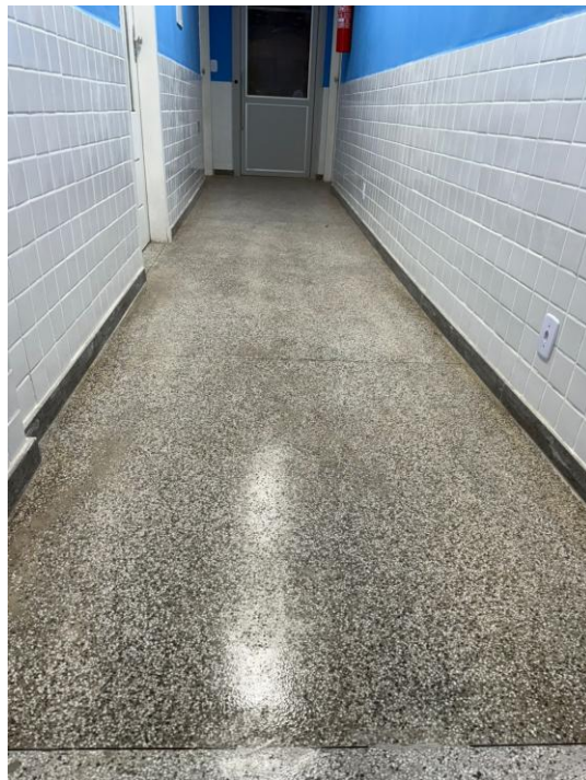
Foto 10 – Itens 08.01.06 - Pintura com tinta à base de resinas acrílicas, marcas de referência Suvinil, Coral ou Novacor, sobre piso de concreto a duas demãos
