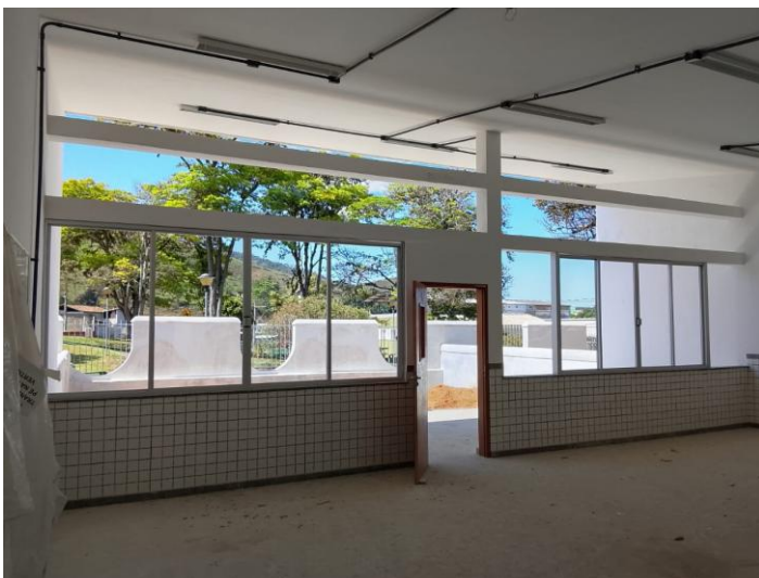
Fotos 22 e 23 – Itens 03.07.07 e 03.08.05 - PORTA DE ABRIR COM MOLA HIDRÁULICA DE 2,20 X 2,10M, EM VIDRO TEMPERADO, 2 FOLHAS, COM BARRA ANTIPÂNICO, ESPESSURA 10MM, INCLUSIVE ACESSÓRIOS; Vidro plano transparente liso, com 4 mm de espessura.
