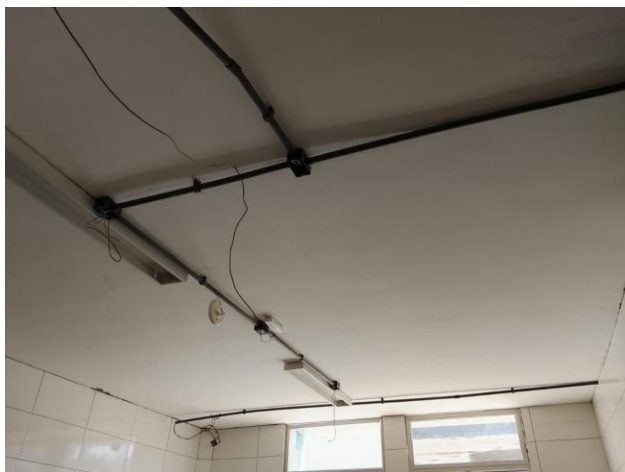
Fotos 11, 12 e 13 – Item 03.02.09 - Emassamento de paredes e forros, com duas demãos de massa à base de PVA, marcas de referência Suvinil, Coral ou Metalatex.
