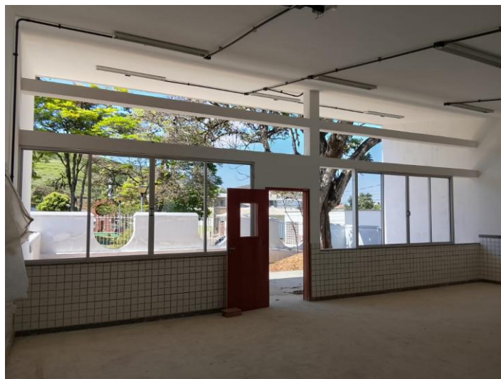
Fotos 22 e 23 – Itens 03.07.07 e 03.08.05 - PORTA DE ABRIR COM MOLA HIDRÁULICA DE 2,20 X 2,10M, EM VIDRO TEMPERADO, 2 FOLHAS, COM BARRA ANTIPÂNICO, ESPESSURA 10MM, INCLUSIVE ACESSÓRIOS; Vidro plano transparente liso, com 4 mm de espessura.
