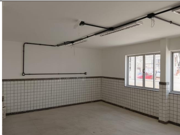
Fotos 02, 03, 04 e 05 – Itens 03.02.05 - PINTURA COM TINTA ACRÍLICA, MARCAS DE REFERÊNCIA SUVINIL, CORAL OU METALATEX, INCLUSIVE SELADOR ACRÍLICO, EM PAREDES E FORROS, A TRÊS DEMÃOS.
