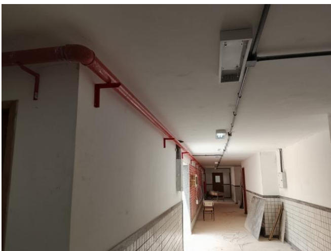
Foto 28 – Item 12.01 - TUBO DE AÇO GALVANIZADO, INCLUSIVE CONEXÕES, DIÂM. 25MM (1").
