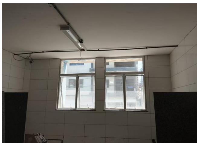
Fotos 06, 07 e 08 – Item 03.02.06 - REVESTIMENTO CERÂMICO PARA PAREDES INTERNAS COM PLACAS TIPO ESMALTADA PADRÃO POPULAR DE DIMENSÕES 20X20 CM, ARGAMASSA TIPO AC I, APLICADAS NA ALTURA INTEIRA DAS PAREDES. AF_02/2023_PE.
