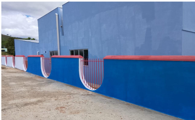
Fotos 09 e 10 - Item 03.02.08 - Emassamento de paredes e forros, com duas demãos de massa acrílica, marcas de referência Suvinil, Coral ou Metalatex.
