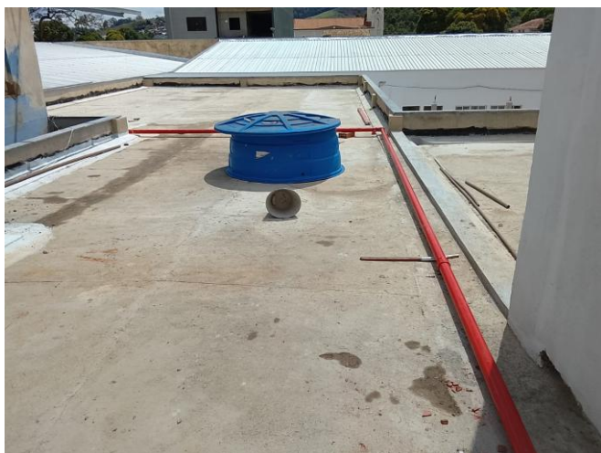
Foto 28 – Item 12.01 - TUBO DE AÇO GALVANIZADO, INCLUSIVE CONEXÕES, DIÂM. 25MM (1").
