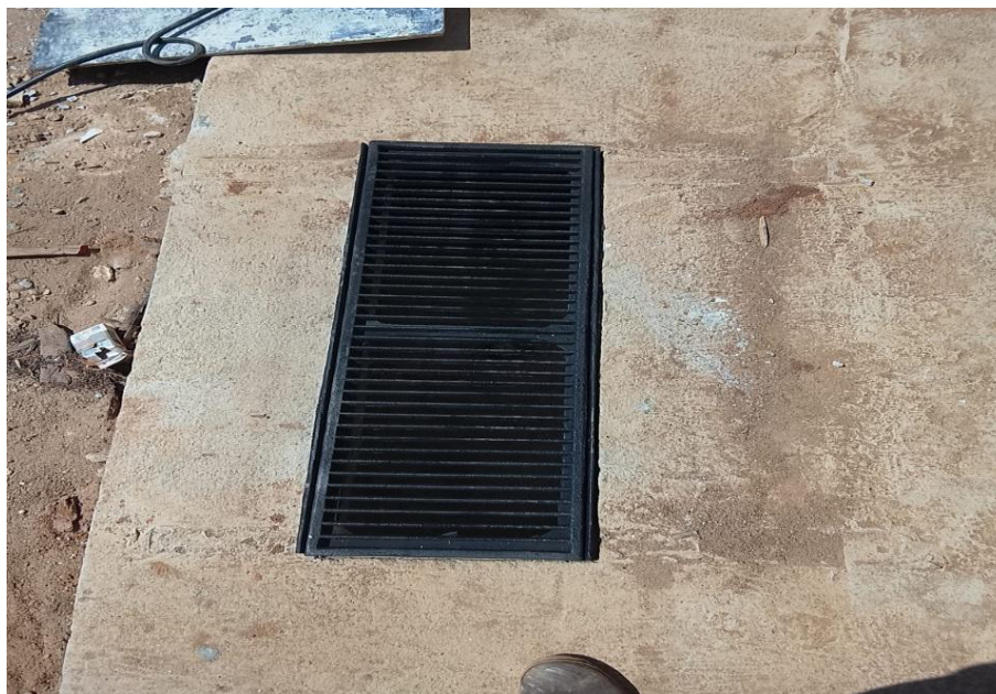
Foto 35 – Item 14.09 Canaleta em alvenaria 0,60x0,50x35,00, com tampa de concreto armado e grelha de ferro fundido, fixadas em caixilhos.
