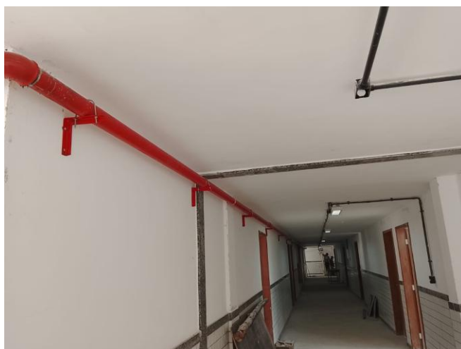
Fotos 29, 30 e 31 – Item 12.02 - TUBO DE AÇO GALVANIZADO, INCLUSIVE CONEXÕES, DIÂM. 65MM (2 1/2").
