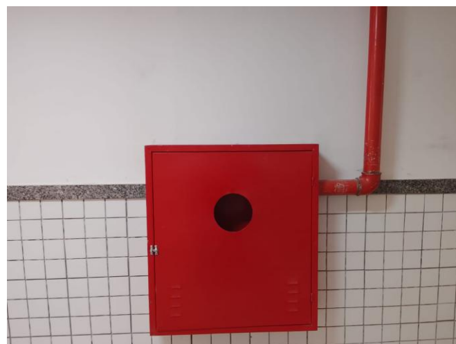
Fotos 33 e 34 – Item 12.04 HIDRANTE DE PAREDE, COM ABRIGO EM CHAPA, 60X90X17CM, COM SUPORTE E MANGUEIRA 20M 63MM, ADAPTADOR ROSCA FÊMEA E ENGATE RÁPIDO, ESGUICHO EM LATÃO REGULÁVEL, REGISTRO GLOBO ANGULAR 45º/ 63MM.
