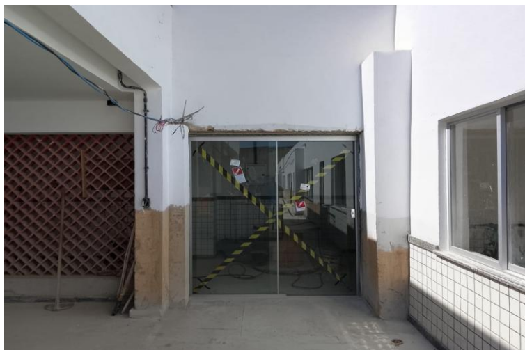
Fotos 20 e 21 – Item 03.07.07 - PORTA DE ABRIR COM MOLA HIDRÁULICA DE 2,20 X 2,10M, EM VIDRO TEMPERADO, 2 FOLHAS, COM BARRA ANTIPÂNICO, ESPESSURA 10MM, INCLUSIVE ACESSÓRIOS.
