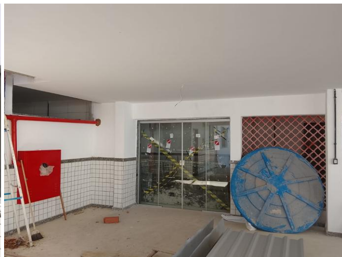
Fotos 20 e 21 – Item 03.07.07 - PORTA DE ABRIR COM MOLA HIDRÁULICA DE 2,20 X 2,10M, EM VIDRO TEMPERADO, 2 FOLHAS, COM BARRA ANTIPÂNICO, ESPESSURA 10MM, INCLUSIVE ACESSÓRIOS.
