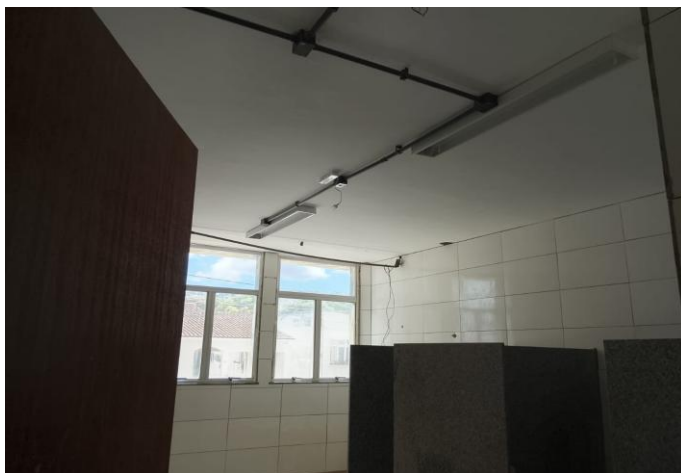
Fotos 09 e 10 - Item 03.02.08 - Emassamento de paredes e forros, com duas demãos de massa acrílica, marcas de referência Suvinil, Coral ou Metalatex.
