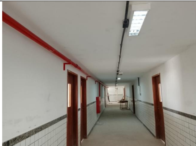
Fotos 02, 03, 04 e 05 – Itens 03.02.05 - PINTURA COM TINTA ACRÍLICA, MARCAS DE REFERÊNCIA SUVINIL, CORAL OU METALATEX, INCLUSIVE SELADOR ACRÍLICO, EM PAREDES E FORROS, A TRÊS DEMÃOS.
