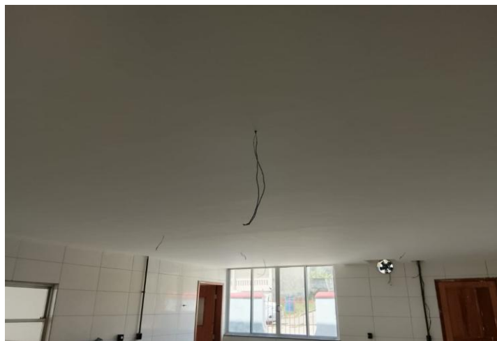
Fotos 16 e 17 – Itens 03.04.02 e 03.04.03 - PINTURA COM TINTA LÁTEX PVA, MARCAS DE REFERÊNCIA SUVINIL, CORAL OU METALATEX, INCLUSIVE SELADOR EM PAREDES E FORROS, A TRÊS DEMÃOS; Emassamento de paredes e forros, com duas demãos de massa à base de PVA, marcas de referência Suvnil, Coral ou Metalatex.
