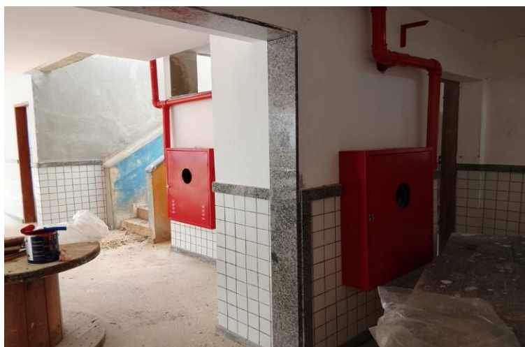
Fotos 33 e 34 – Item 12.04 HIDRANTE DE PAREDE, COM ABRIGO EM CHAPA, 60X90X17CM, COM SUPORTE E MANGUEIRA 20M 63MM, ADAPTADOR ROSCA FÊMEA E ENGATE RÁPIDO, ESGUICHO EM LATÃO REGULÁVEL, REGISTRO GLOBO ANGULAR 45º/ 63MM.
