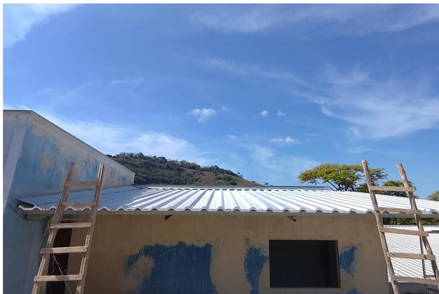
Foto 14 – Itens 03.03.01 e 03.03.02 - FORNECIMENTO DE ESTRUTURA METALICA E ENGRADAMENTO METÁLICO, EM AÇO, SOBRE LAJE PARA TELHA METÁLICA TERMOACÚSTICA, COBERTURA PADRÃO PRÉDIO ESCOLAR, EXCLUSIVE TELHA, INCLUSIVE FABRICAÇÃO, TRANSPORTE, MONTAGEM, APLICAÇÃO DE FUNDO PREPARADOR ANTI-CORROSIVO, UMA (1) DEMÃO E PINTURA ESMALTE DUAS (2) DEMÃOS; TELHAMENTO COM TELHA METÁLICA TERMOACÚSTICA E = 30 MM, COM ATÉ 2 ÁGUAS, INCLUSO IÇAMENTO. AF_07/2019.
