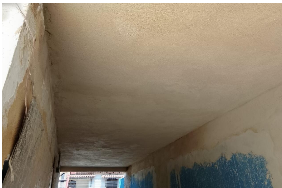
Foto 15 – Item 03.03.05. Laje pré-fabricada treliçada para forro simples revestido, vão até 3.5m, capeamento 2cm, esp. 10cm, Fck = 150Kg/cm2
