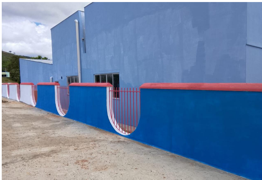
Foto 24 – Itens 03.09.01 e 03.09.02 - LIMPEZA DE AÇO COM LIXAMENTO E ESCOVAMENTO COM ESCOVA DE AÇO, ATÉ A COMPLETA REMOÇÃO DE PARTÍCULAS SOLTAS, MATERIAIS INDESEJÁVEIS E CORROSÃO; PINTURA COM TINTA ESMALTE SINTÉTICO, MARCAS DE REFERÊNCIA SUVINIL, CORAL OU METALATEX, A DUAS DEMÃOS, INCLUSIVE FUNDO ANTICORROSIVO A UMA DEMÃO, EM METAL.
