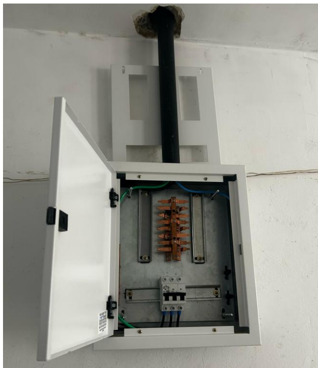
Fotos 31 e 32 – Item 09.04.01 - – Quadro distrib. energia embutido ou semi embutido, capac. p/16 disj.
