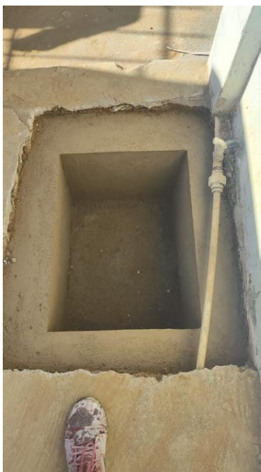
Fotos 20 e 21 – Itens 09.02.04 e 09.02.05 – Caixa de passagem 300x300x12MM, com tampa parafusada; Caixa de passagem 400x400x120MM, com tampa parafusada.
