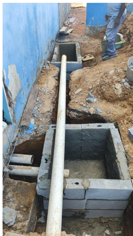
Fotos 22, 23 e 24 – Itens 09.02.06 e 09.02.07 – Caixa de passagem de alvenaria de blocos de concreto
