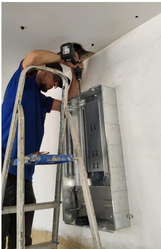
Fotos 20 e 21 – Itens 09.02.04 e 09.02.05 – Caixa de passagem 300x300x12MM, com tampa parafusada; Caixa de passagem 400x400x120MM, com tampa parafusada.
