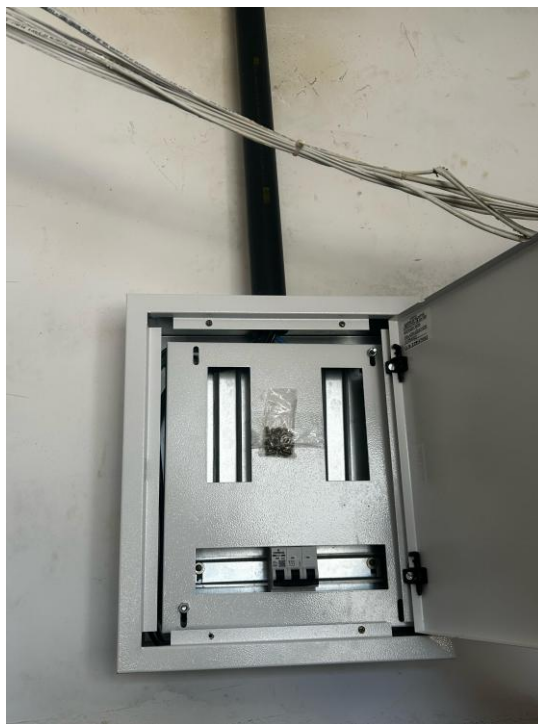
Fotos 31 e 32 – Item 09.04.01 - – Quadro distrib. energia embutido ou semi embutido, capac. p/16 disj.
