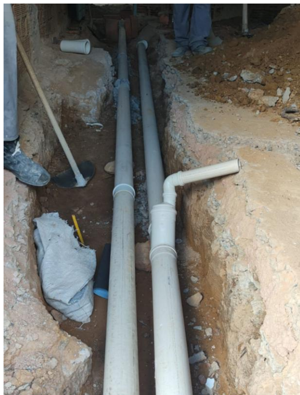
Fotos 13 e 14 – Item 07.06.01 – Tubo de PVC rígido soldável branco, para esgoto
