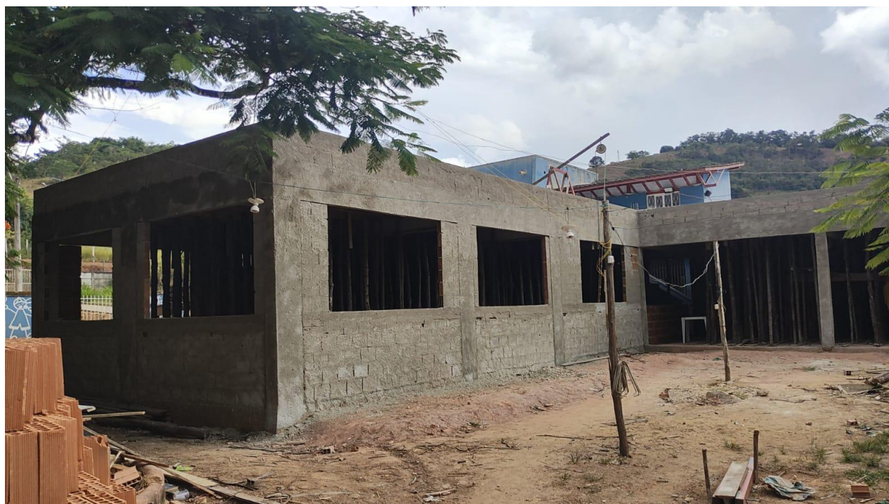
Fotos 05 e 06 – Item 03.02.01 – Chapisco com argamassa de cimento e areia média ou grossa lavada
