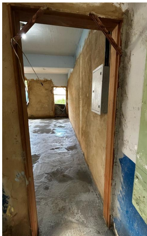
Fotos 09, 10, 11 e 12 – Item 06.09.01.03 - Marco de madeira de lei de 1ª (Peroba, Ipê, Angelim Pedra ou equivalente) com 15x3 cm de batente, nas dimensões de 0.60 x 2.10 m
