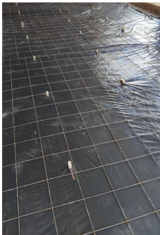
Fotos 05 e 06 – Itens 06.08.01.01 e 06.08.01.02 - ARMAÇÃO PARA EXECUÇÃO DE RADIER, PISO DE CONCRETO OU LAJE SOBRE SOLO, COM USO DE TELA Q-92. AF_09/2021; LASTRO IMPERMEABILIZADO DE CONCRETO NÃO ESTRUTURAL, ESPESSURA DE 6 CM
