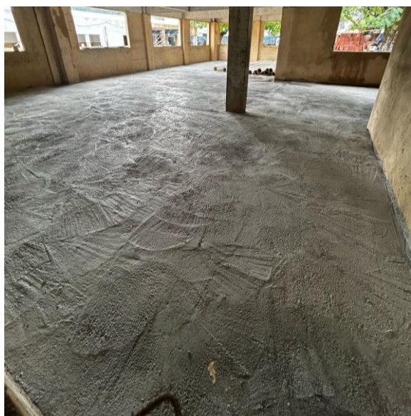
Fotos 07 e 08 – Item 06.08.01.04 e 06.08.01.05 - PISO ARGAMASSA ALTA RESISTÊNCIA TIPO GRANILITE OU EQUIV DE QUALIDADE COMPROVADA; CAMADA SEPARADORA PARA EXECUÇÃO DE RADIER, PISO DE CONCRETO
