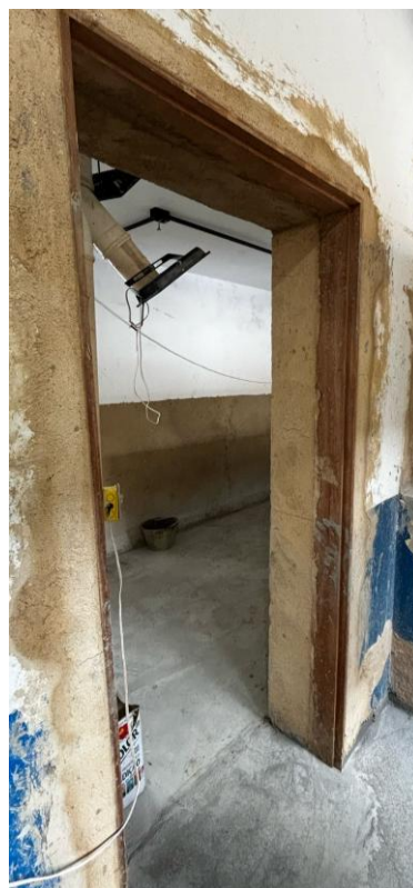
Fotos 09, 10, 11 e 12 – Item 06.09.01.03 - Marco de madeira de lei de 1ª (Peroba, Ipê, Angelim Pedra ou equivalente) com 15x3 cm de batente, nas dimensões de 0.60 x 2.10 m
