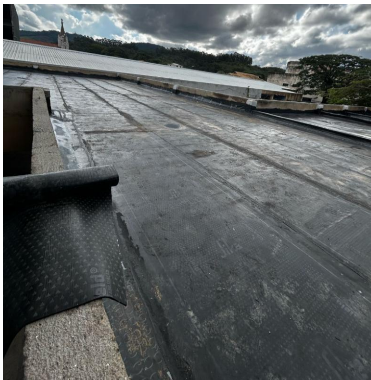
Fotos 03 e 04 – Item 06.06.01 - ÍNDICE DE IMPERM.C/ MANTA ASFÁLTICA ATENDENDO NBR 9952, ASFALTO POLIMERIZADO ESP.3MM, REFORÇ.C/ FILME INT. POLIETILENO, REGUL. BASE C/ ARG.1:4 ESP.MÍN.15MM, PROTEÇÃO MEC. ARG.1:4 ESP.20MM E JUNTAS DILAT.
