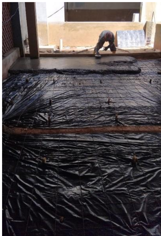
Fotos 05 e 06 – Itens 06.08.01.01 e 06.08.01.02 - ARMAÇÃO PARA EXECUÇÃO DE RADIER, PISO DE CONCRETO OU LAJE SOBRE SOLO, COM USO DE TELA Q-92. AF_09/2021; LASTRO IMPERMEABILIZADO DE CONCRETO NÃO ESTRUTURAL, ESPESSURA DE 6 CM
