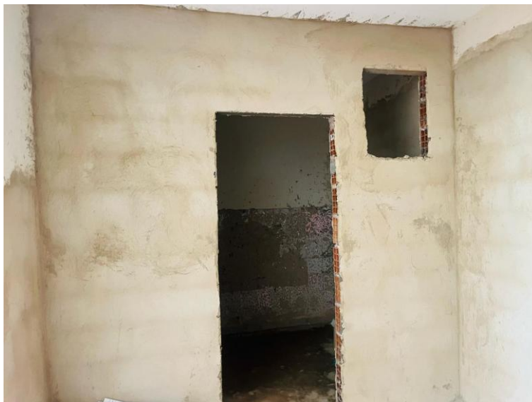
Fotos 01 e 02 – Item 02.10 - Retirada de alizar de madeira
