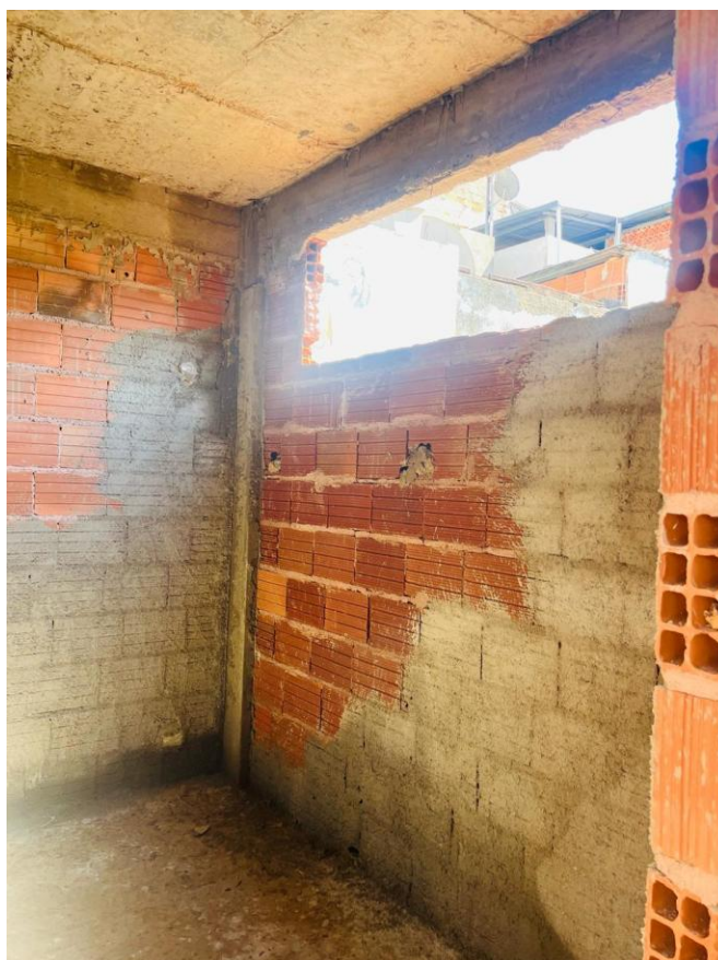
Fotos 03 e 04 – Item 05.01 - Verga/contraverga reta de concreto armado 10 x 5 cm, Fck = 15 MPa, inclusive forma, armação e desforma
