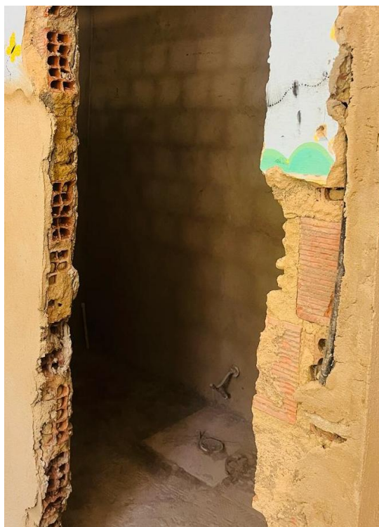
Fotos 07, 08, 09, 10, 11, 12, 13 e 14 – Itens 10.01, 10.02 e 10.03 - Chapisco de argamassa de cimento; Emboço de argamassa de cimento; Reboco tipo paulista de argamassa de cimento
