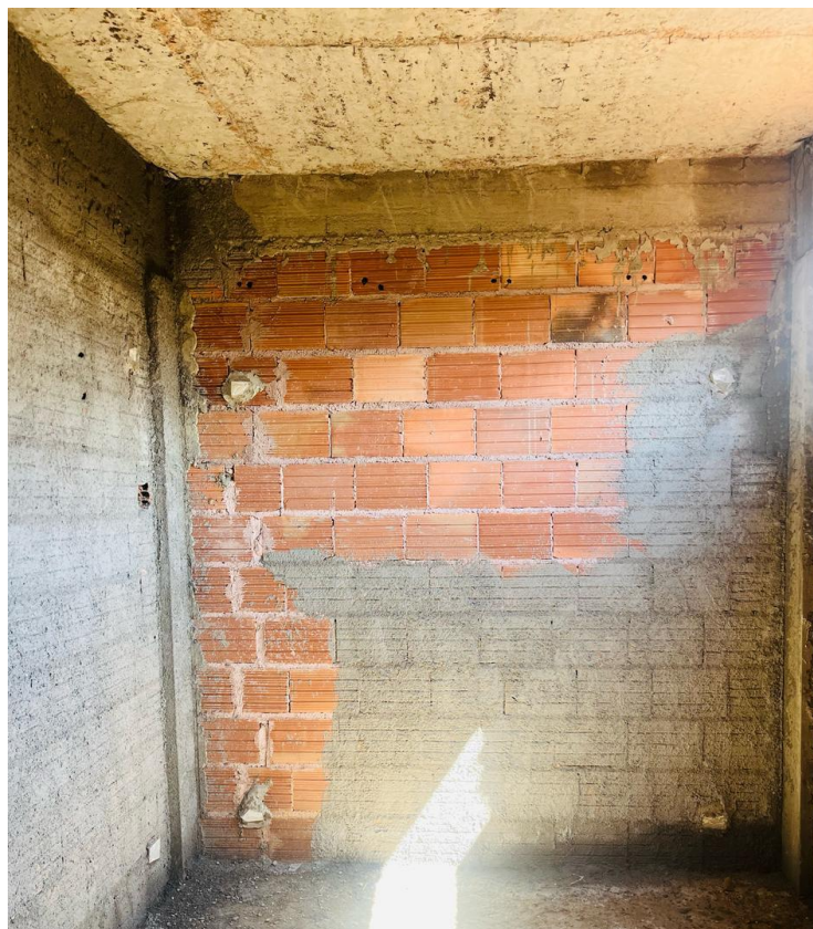
Fotos 05 e 06 – Item 05.03 - Alvenaria de blocos cerâmicos 10 furos 10x20x20cm, assentados c/argamassa de cimento, cal hidratada CH1 e areia traço 1:0,5:8, esp. das juntas 12mm e esp. das paredes s/revestimento, 10cm (bloco comprado na fábrica, posto obra)
