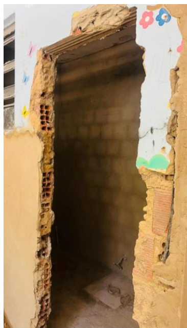
Fotos 01 e 02 – Item 02.10 - Retirada de alizar de madeira
