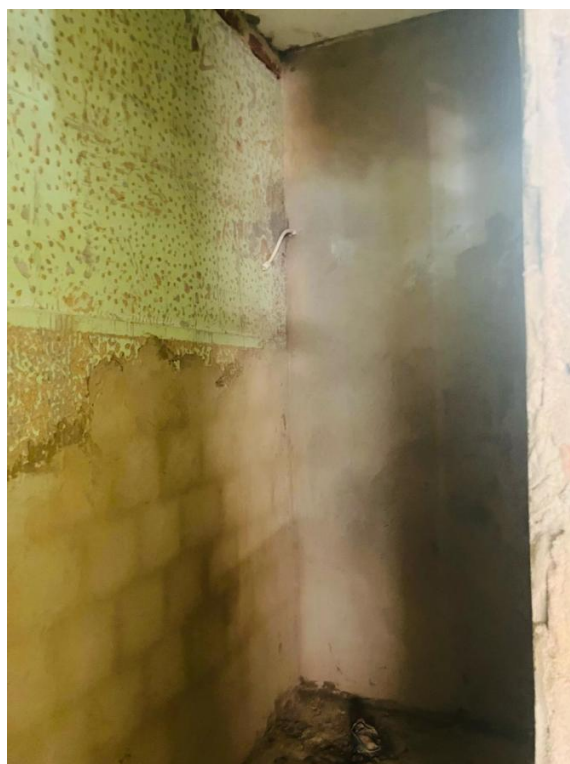
Fotos 15, 16 e 17 – Itens Ponto para esgoto primário (vaso sanitário); Ponto para esgoto secundário (pia, lavatório, mictório, tanque, bidê, etc...)
