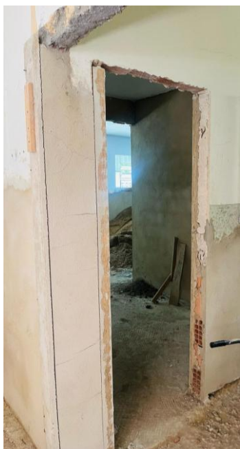
Fotos 01 e 02 – Item 02.10 - Retirada de alizar de madeira
