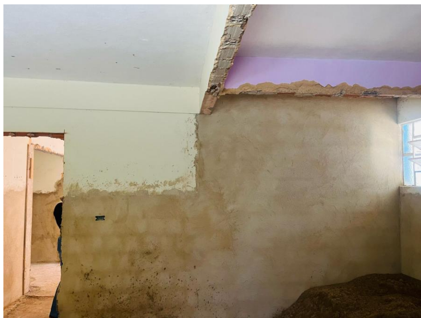
Fotos 05 e 06 – Item 05.03 - Alvenaria de blocos cerâmicos 10 furos 10x20x20cm, assentados c/argamassa de cimento, cal hidratada CH1 e areia traço 1:0,5:8, esp. das juntas 12mm e esp. das paredes s/revestimento, 10cm (bloco comprado na fábrica, posto obra)
