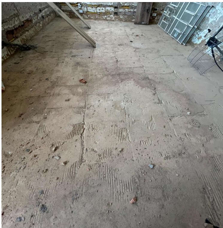
Fotos 03, 04 e 05– Item 02.01 - – Demolição de piso revestido com cerâmica – 2º Pavimento
