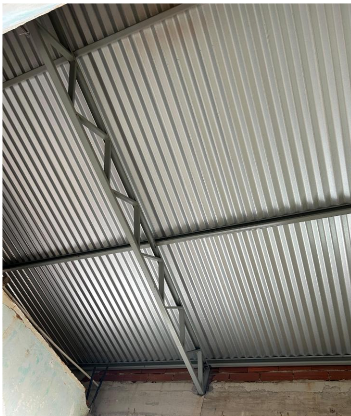
Fotos 18 e 19 – Item 07.04, 07.05 e 07.06 – FABRICAÇÃO E INSTALAÇÃO DE TESOURA INTEIRA EM AÇO; FABRICAÇÃO E INSTALAÇÃO DE TESOURA INTEIRA EM AÇO
