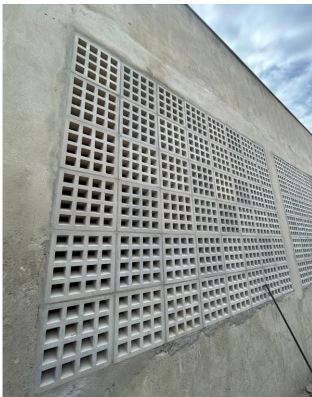
Fotos 13 e 14 – Item 06.01 - Cobogó de concreto 40 x 40 x 10 cm - Fachada
