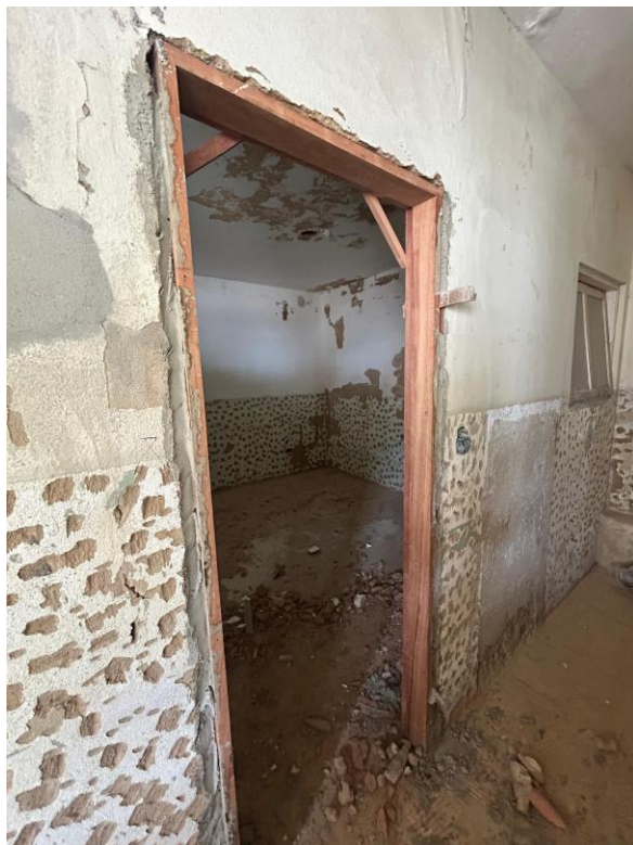
Fotos 20 e 21 - Item 08.04 - Marco de madeira de lei de 1ª (Peroba, Ipê, Angelim Pedra ou equivalente) com 15x3 cm de batente, nas dimensões de 0.70 x 2.10 m
