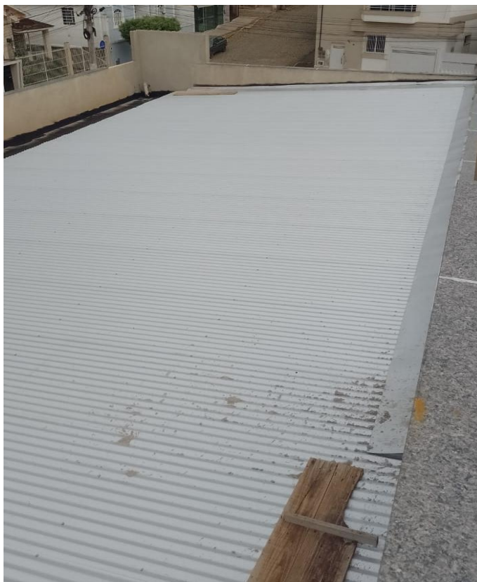
Fotos 16 e 17 – Item 07.01 e 07.03 – Rufo de chapa metálica e Calha em chapa galvanizada com largura de 40 cm
