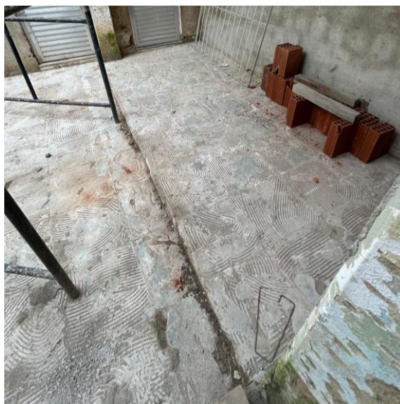
Fotos 01 e 02 - Item 02.01 – Demolição de piso revestido com cerâmica – Área de serviço
