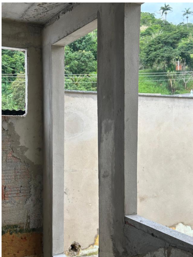
Fotos 11 e 12 – Item 05.07 e 05.08 – Fornecimento, dobragem e colocação em fôrma
