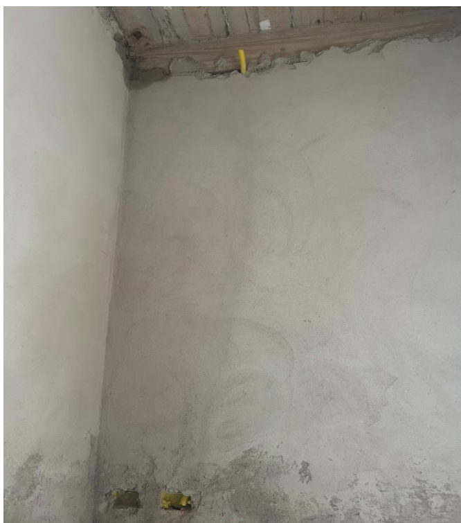
Fotos 06, 07, 08, 09 e 10 – Item 02.11 - Abertura e fechamento de rasgos em alvenaria, para passagem de tubulações
