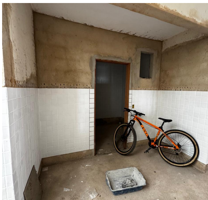
Figura 15 - Banheiro PCD parte externa
