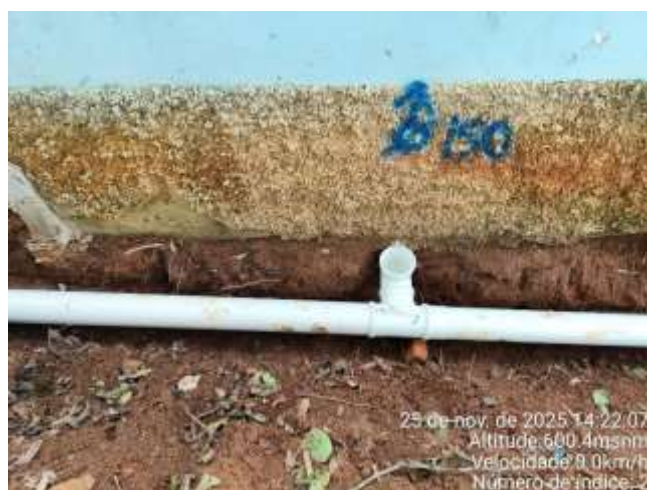
Foto 14: Tubos de PVC Ø 150 mm.
