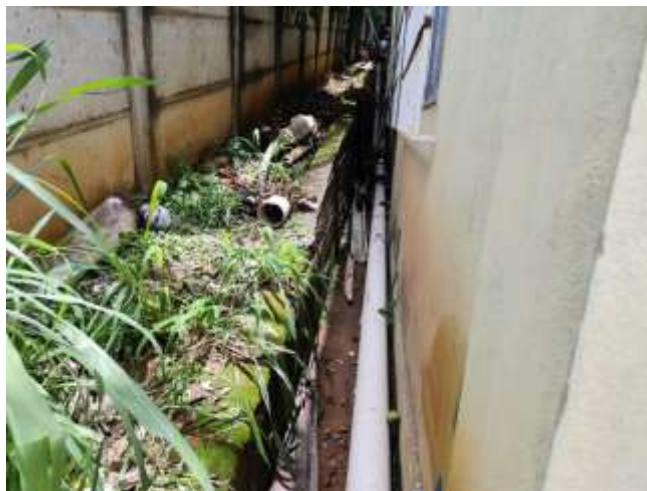
Foto 13: Tubos de PVC Ø 100 mm.
