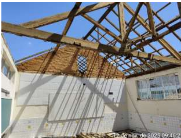
Foto 3: Remoção de engradamento de madeira e telha fibrocimento
