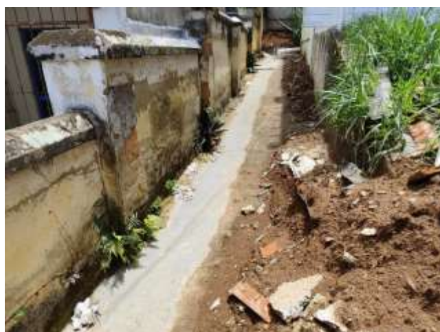
Foto 12: Demolição de piso, lastro de concreto e piso cimentado.
