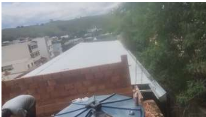
Foto 7: Platibanda, telha e calha.
