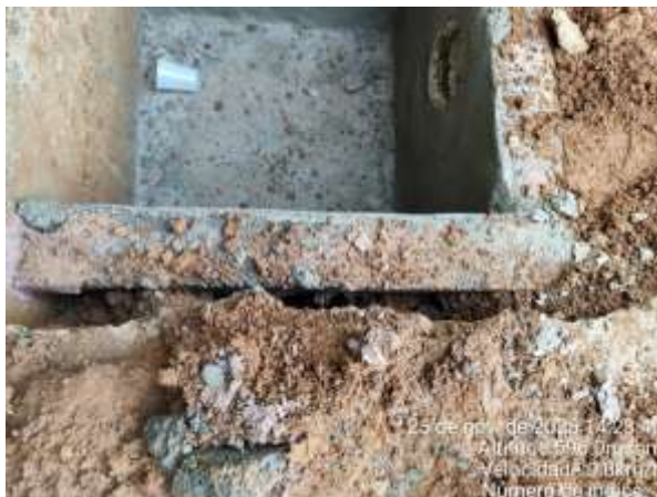
Foto 15: Caixa de inspeção.
