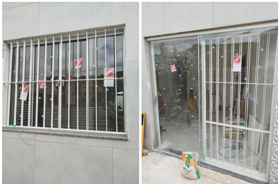
Figuras 3 e 4 – Itens 02.10, 08.05, 08.06, 08.07, 08.09 e 17.04 - Retirada de grades, gradis, alambrados, cercas e portões; Fornecimento e instalação de janela em vidro temperado incolor 8mm, inclusive perfis e ferragens; Porta em vidro temperado 10mm, incolor, inclusive ferragens de fixação e instalação, exclusive puxador - Rev 01_10/2021; Portão de ferro de correr em barra chata, inclusive chumbamento; Grade de ferro em barra chata, inclusive chumbamento; Pintura sobre metal, aplicação manual, com duas demãos de tinta esmalte sintético, referência Suvinil, Coral ou Metalatex, inclusive uma demão de fundo anticorrosivo.
