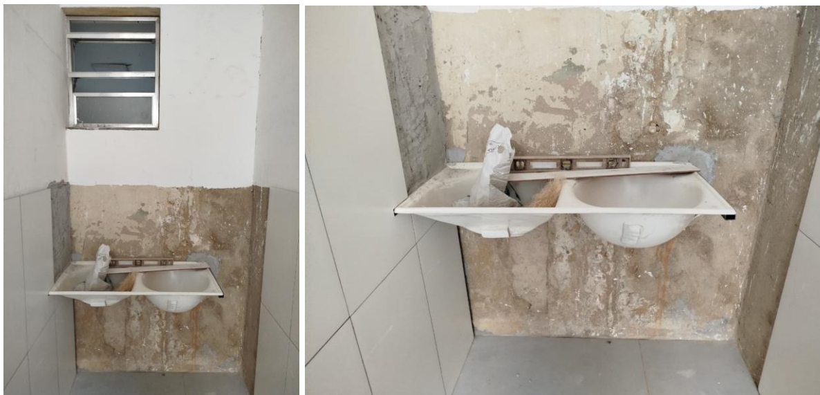
Figuras 16 e 17 – Item 15.01 - Tanque em mármore sintético com 2 bojos, inclusive válvula e sifão em PVC.
