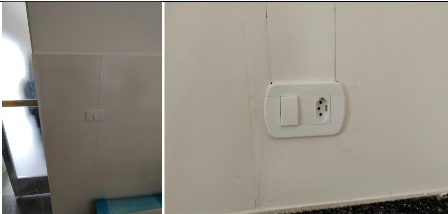
Figuras 22 e 23 – Item 16.05 - Interruptor de uma tecla paralelo 10A/250V, com placa 4x2".
