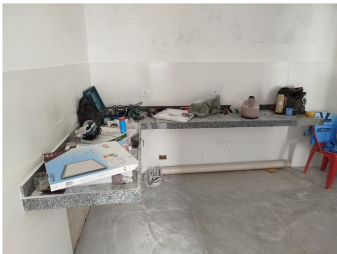
Figuras 7 e 8 – Item 08.18 – Bancada de granito com espessura de 2 cm.
