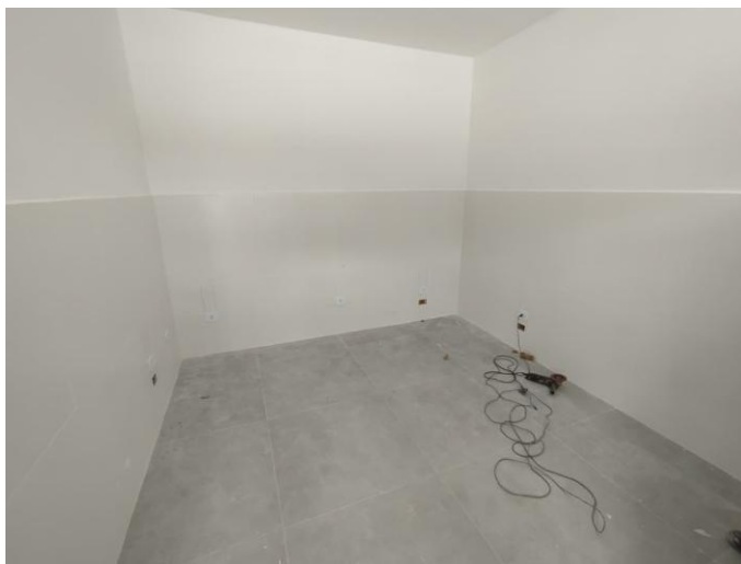
Figuras 9 e 10 – Itens 10.05, 10.08 e 16.02 – Piso cerâmico esmaltado, PEI 5, acabamento semibrilho, dim. 45x45cm, ref. de cor CARGO PLUS WHITE Eliane/equiv. assentado com argamassa de cimento colante, inclusive rejuntamento; Porcelanato esmaltado, acabamento acetinado, dim. 60x60cm, ref. de cor CIMENTO CINZA BOLD Portobello/equiv, utilizando dupla colagem de argamassa colante para porcelanato tipo ACIII e rejunte 3mm; Tomada padrão brasileiro linha branca, NBR 14136 2 polos + terra 10A/250V, com placa 4x2".
