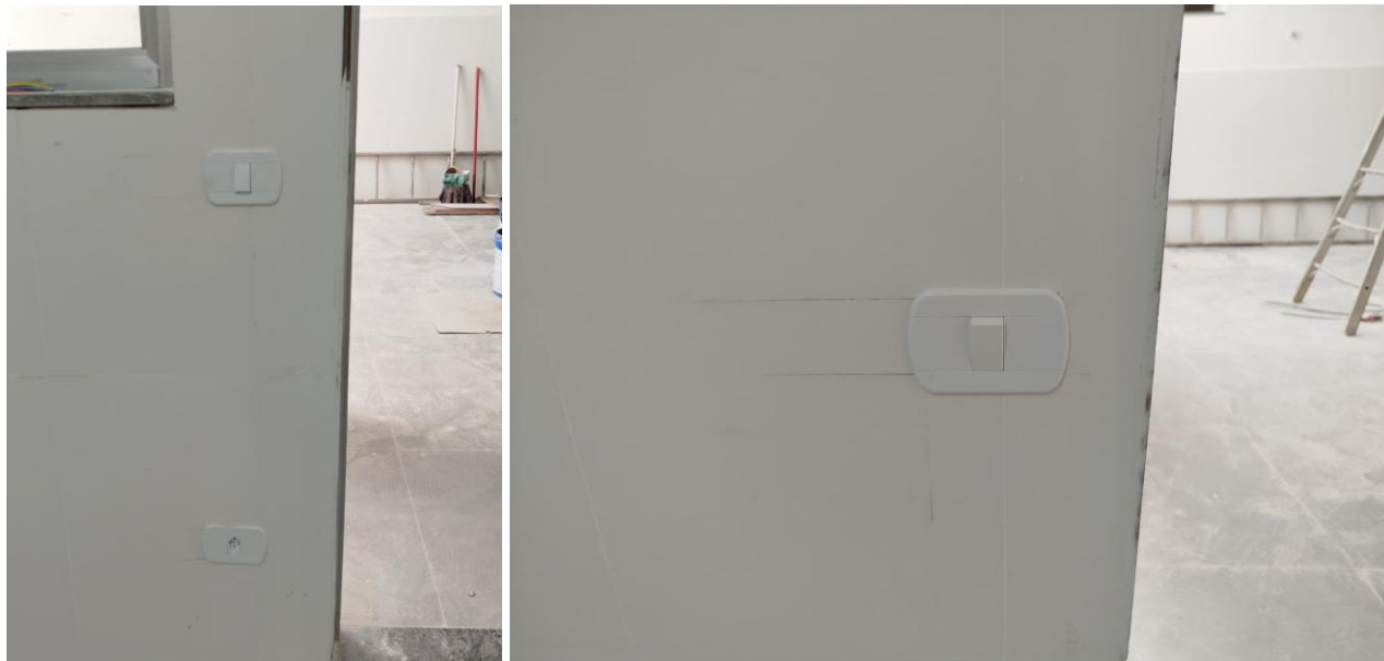
Figuras 18 e 19 – Item 16.03 - Interruptor de uma tecla simples 10A/250V, com placa 4x2".
