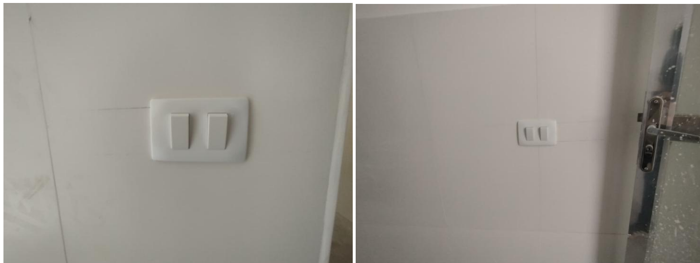
Figuras 20 e 21 – Item 16.04 - Interruptor de duas teclas simples 10A/250V, com placa 4x2".
