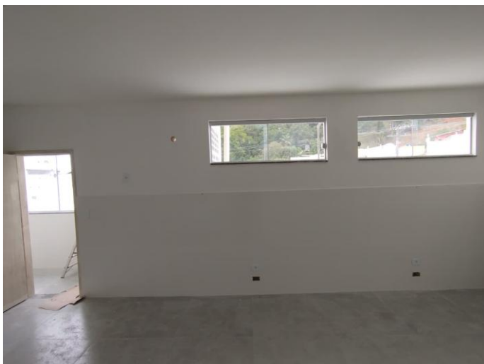
Figuras 9 e 10 – Itens 10.05, 10.08 e 16.02 – Piso cerâmico esmaltado, PEI 5, acabamento semibrilho, dim. 45x45cm, ref. de cor CARGO PLUS WHITE Eliane/equiv. assentado com argamassa de cimento colante, inclusive rejuntamento; Porcelanato esmaltado, acabamento acetinado, dim. 60x60cm, ref. de cor CIMENTO CINZA BOLD Portobello/equiv, utilizando dupla colagem de argamassa colante para porcelanato tipo ACIII e rejunte 3mm; Tomada padrão brasileiro linha branca, NBR 14136 2 polos + terra 10A/250V, com placa 4x2".
