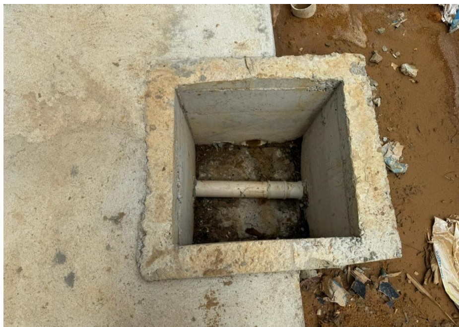
Fotos 06 e 07- Caixas de alvenaria
