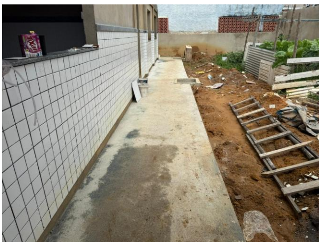
Fotos 04 e 05 – Lastro de concreto
