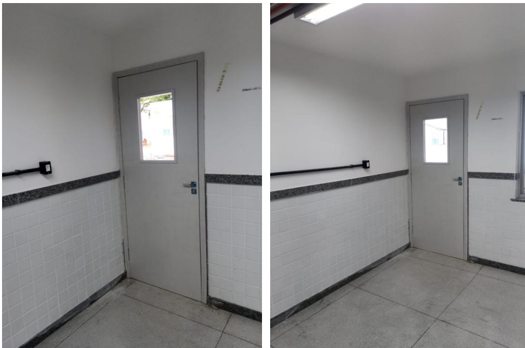
Fotos 11 e 12 – Item 03.07.12 - Pintura com tinta esmalte sintético, marcas de referência Suvinil, Coral ou Metalatex, inclusive fundo branco nivelador, em madeira, a duas demãos.
