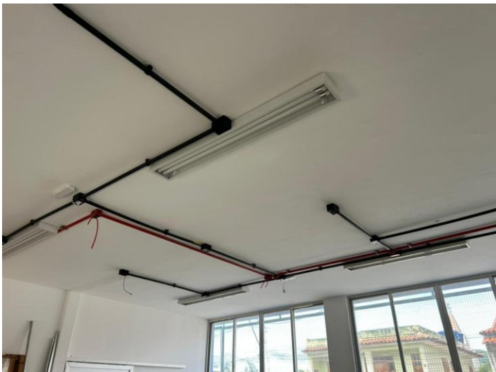
Fotos 03 e 04 – Item 03.04.02 - PINTURA COM TINTA LÁTEX PVA, MARCAS DE REFERÊNCIA SUVINIL, CORAL OU METALATEX, INCLUSIVE SELADOR EM PAREDES E FORROS, A TRÊS DEMÃOS.
