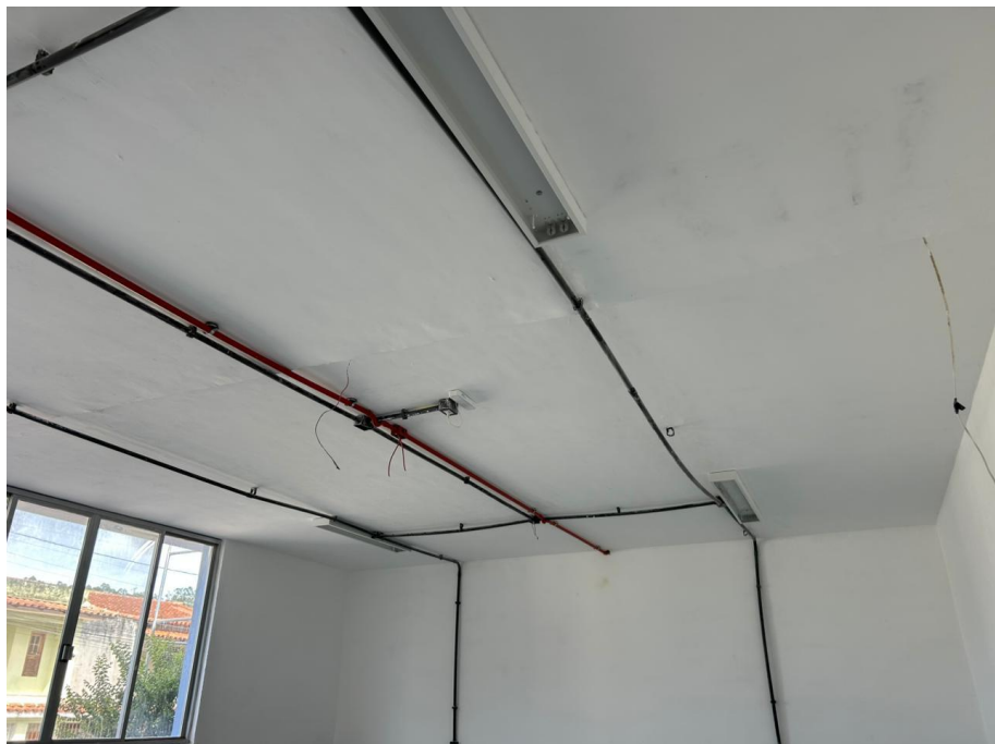
Fotos 05 e 06 – Item 03.04.03 - Emassamento de paredes e forros, com duas demãos de massa à base de PVA, marcas de referência Suviniil, Coral ou Metalatex.
