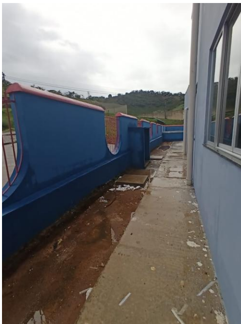
Foto 17 – Item 03.08.10 - Tela de proteção de arame galvanizado 1/2" fio 12, com quadro em tubo de ferro galvanizado 1 1/2" e cantoneira de ferro 1/2" x 1/2" x1/8", conforme detalhe em projeto.
