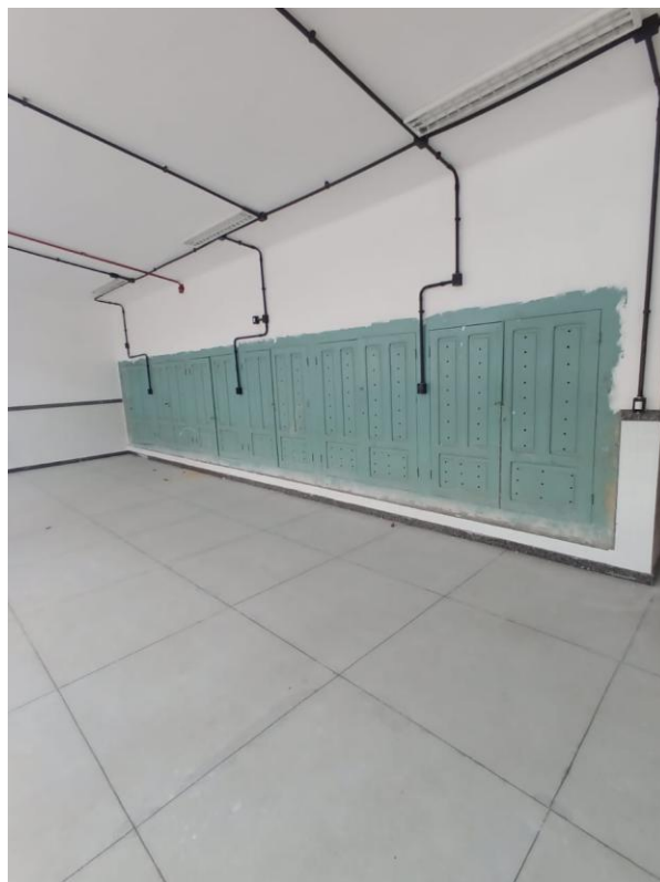
Foto 13 – Item 05.02 - RESTAURAÇÃO DE ARMARIOS DE MADEIRA.
