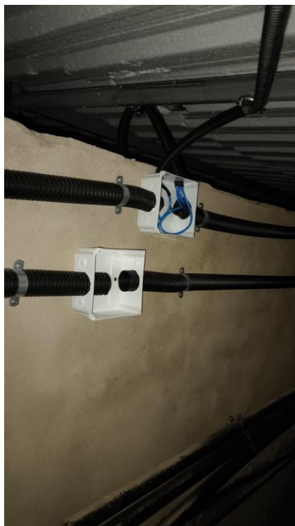
Foto 15 – Item 10.03.01 - FORNECIMENTO E INSTALAÇÃO DE CABO DE REDE PAR TRANÇADO 4 PARES CATEGORIA 5E.
