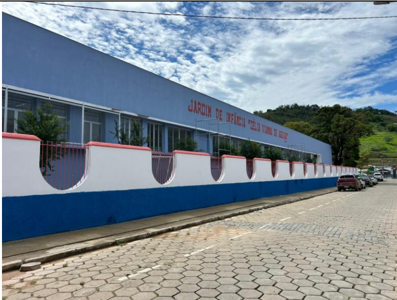
Foto 14 – Item 06.05.02.04 - PINTURA COM TINTA ACRÍLICA, MARCAS DE REFERÊNCIA SUVINIL, CORAL E METALATEX, INCLUSIVE SELADOR ACRÍLICO, EM PAREDES E FORROS, A DUAS DEMÃOS . Item 03.02.08 - EMASSAMENTO DE PAREDES E FORROS, COM DUAS DEMÃOS DE MASSA ACRÍLICA, MARCAS DE REFERÊNCIA SUVINIL, CORAL OU METALATEX
