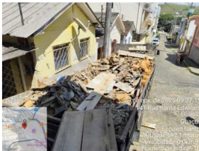
Foto 6: Remoção de entulho.
