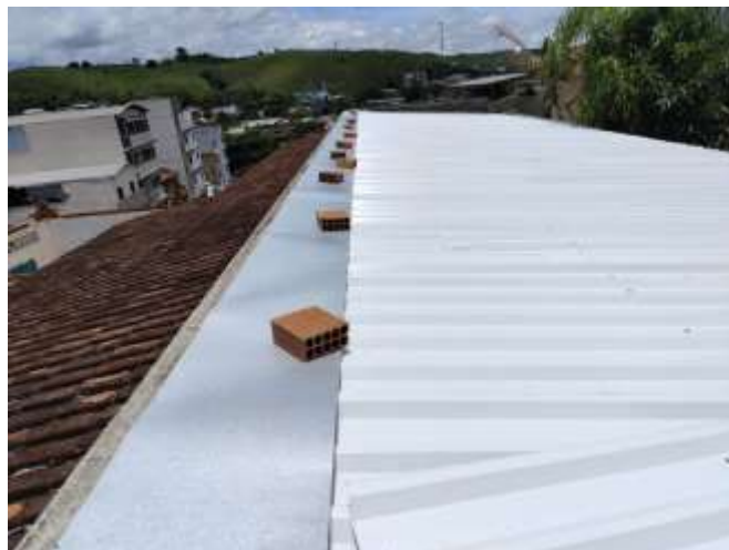
Foto 10: Rufo e telha.
