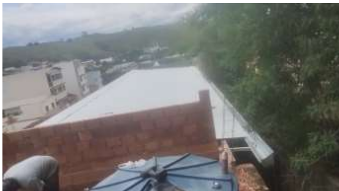
Foto 7: Platibanda, telha e calha.
