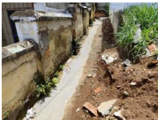
Foto 12: Demolição de piso, lastro de concreto e piso cimentado.
