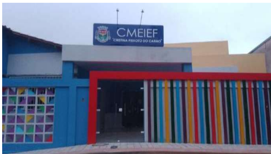
Foto de como ficou o acesso de entrada e fachada da escola, após a pintura.
