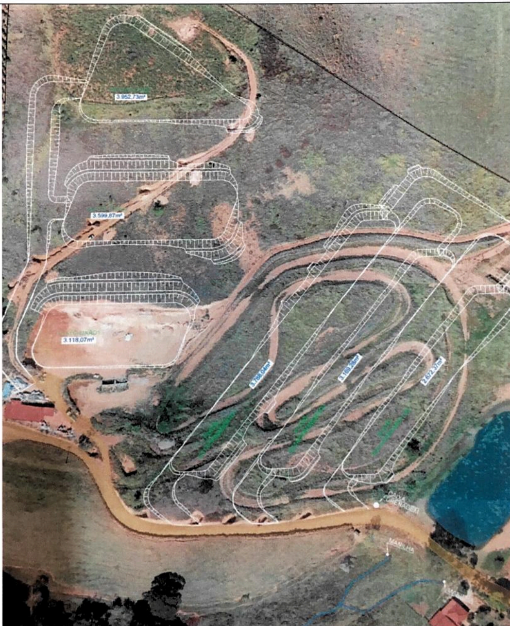
Foto 09 – Ortofotomosaico que indica nos traçado de linha na cor branca a execução de corte e aterro na criação de patamares para futura área de estacionamento no Parque de Exposição.
