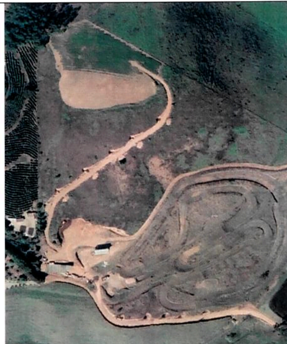
Foto 06 – Vista superior do empreendimento
