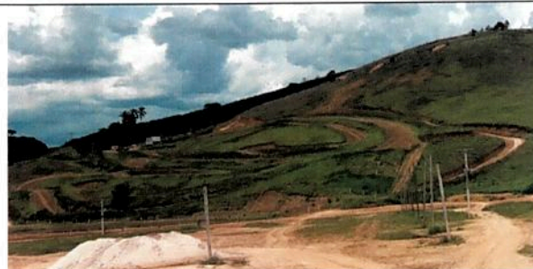
Foto 04 – Vista Lateral direita
