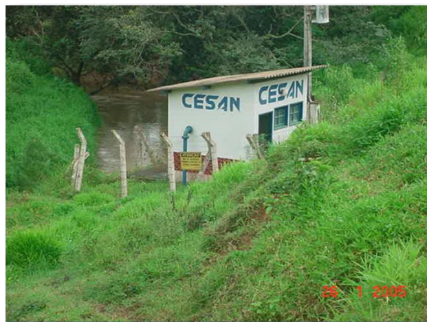
Figura 16: Captação Rio Preto
