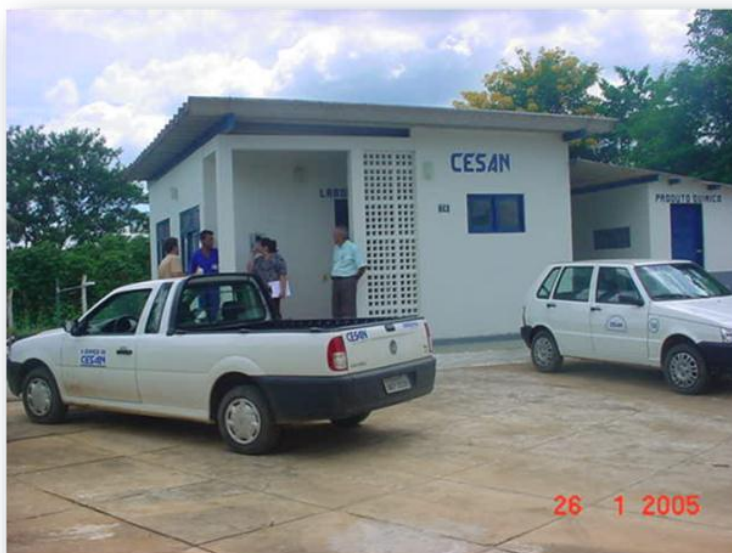
Figura 17: Estação de tratamento de água.
