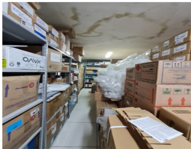
Figura 3: Visão dos espaços (corredores) para a circulação dos servidores.
