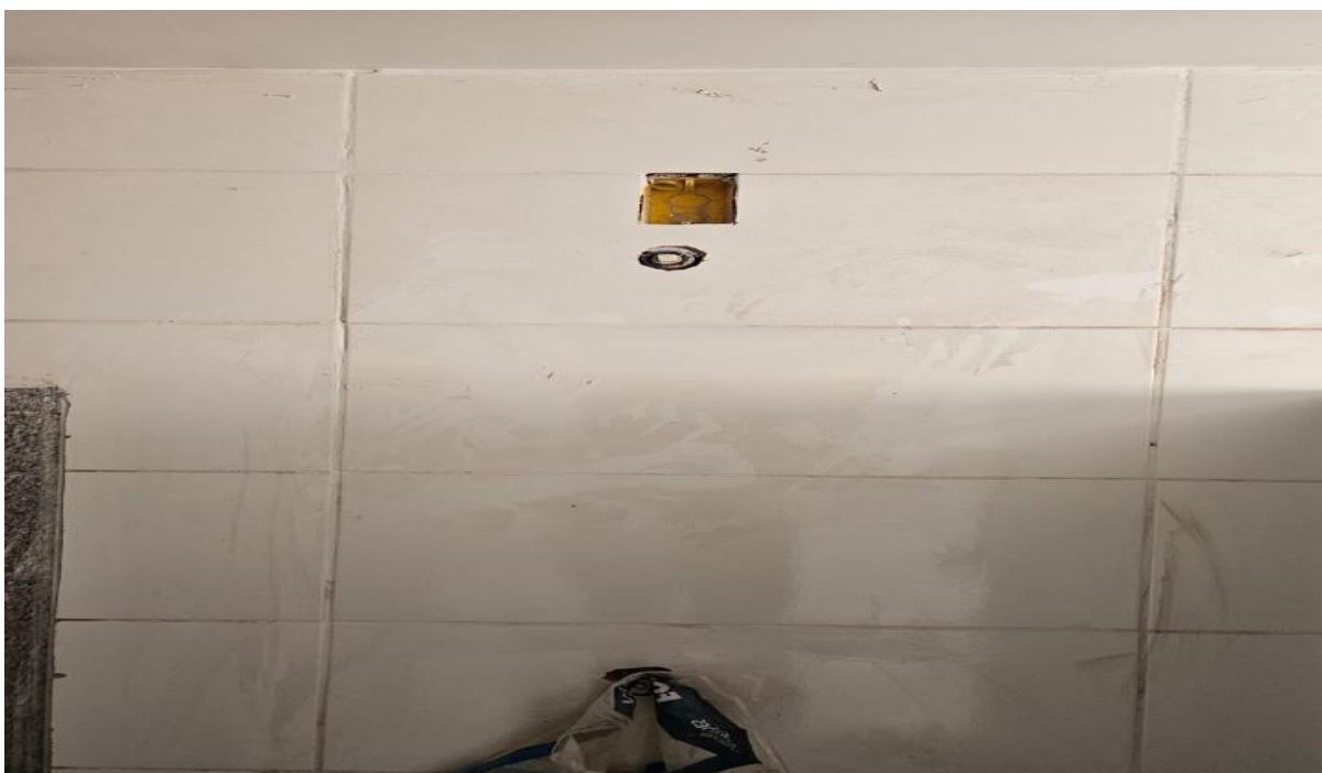
Foto 18: Pontos de água
