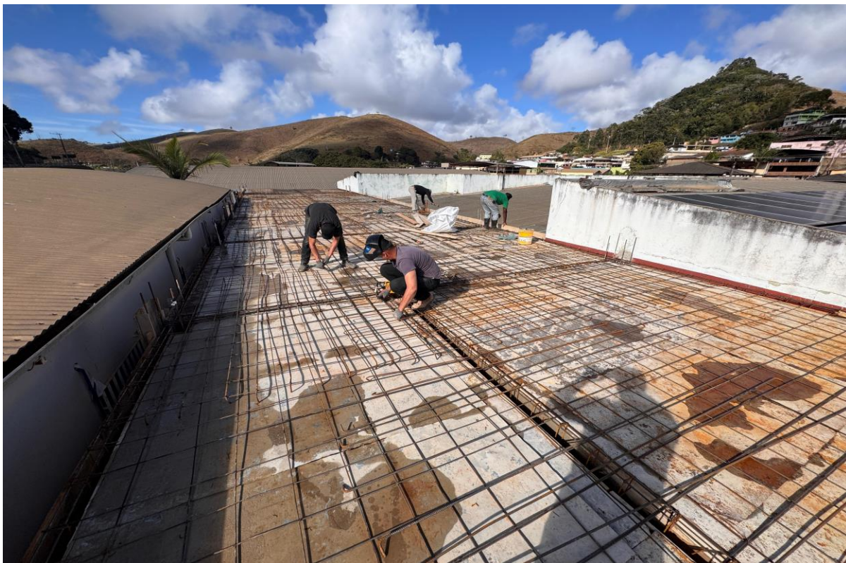
Foto 07: armação da laje
