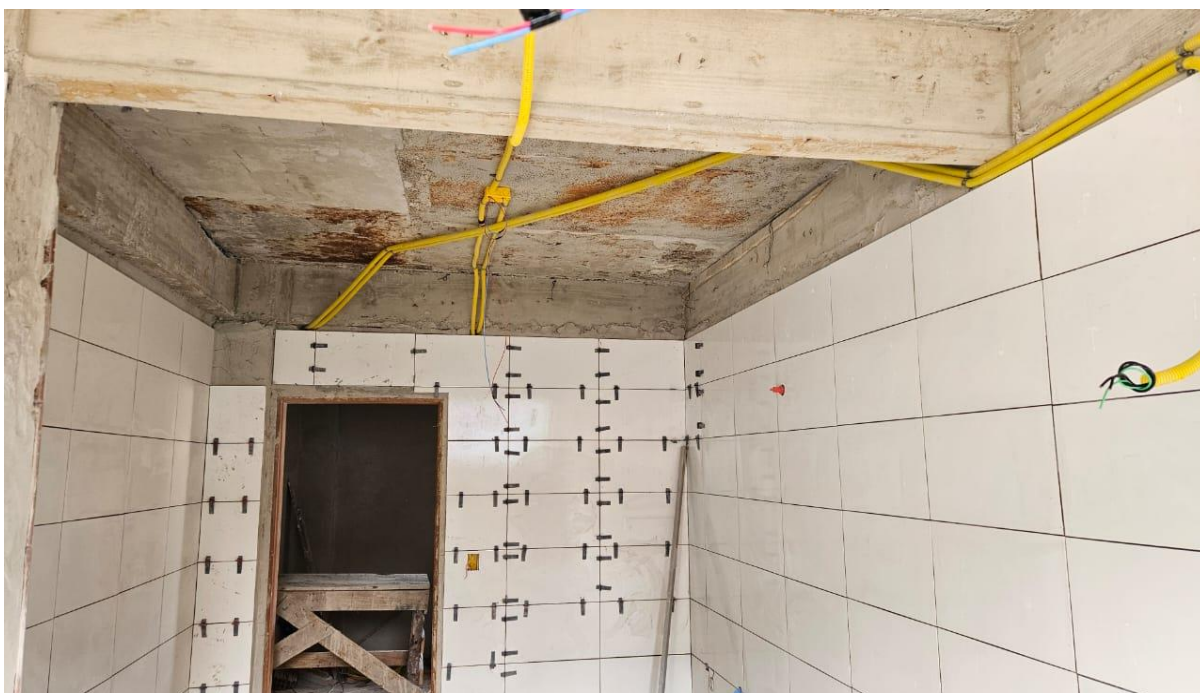
Foto 28: distribuição elétrica
