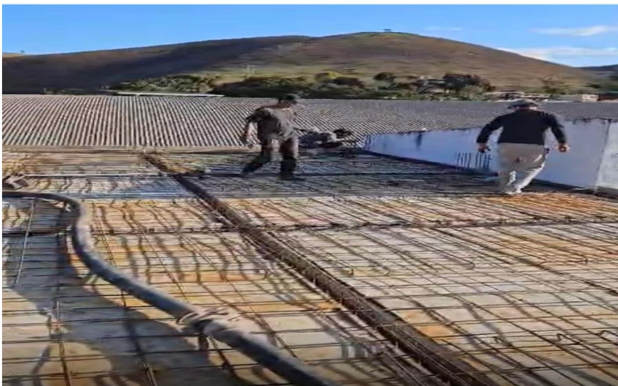
Foto 09: concretagem da laje
