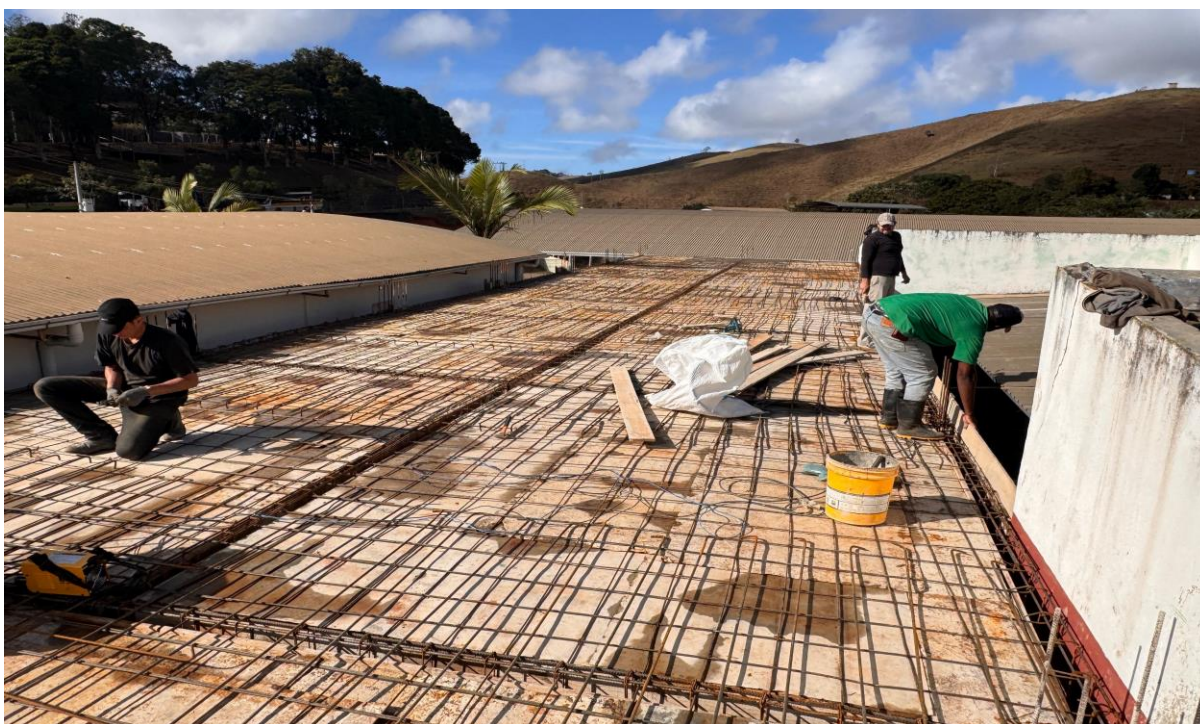
Foto 08: armação da laje
