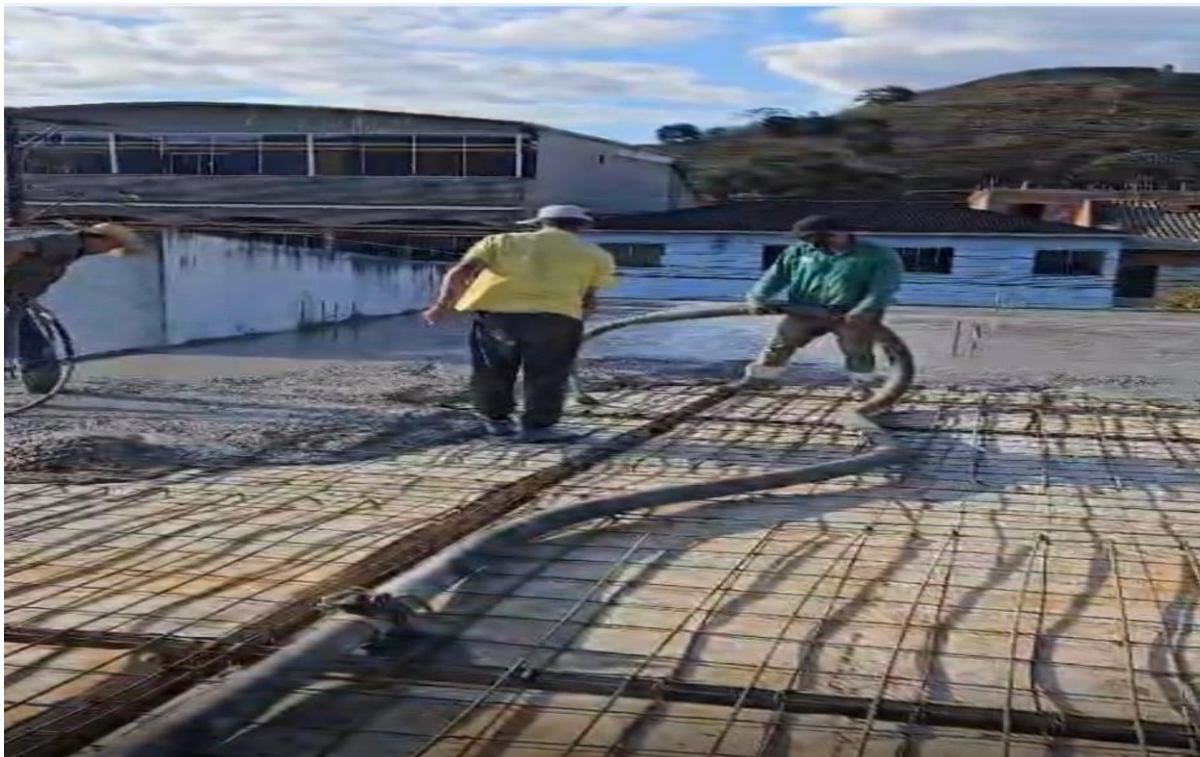
Foto 11: concretagem da laje
