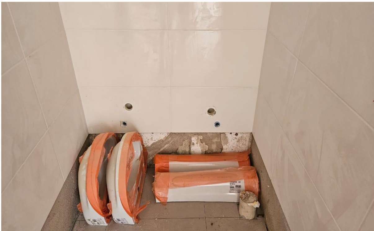
Foto 19: Pontos de água
