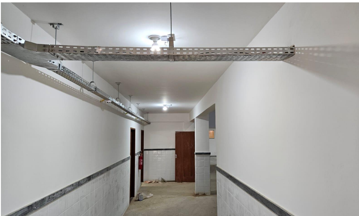
Foto 43: pintura teto e paredes
