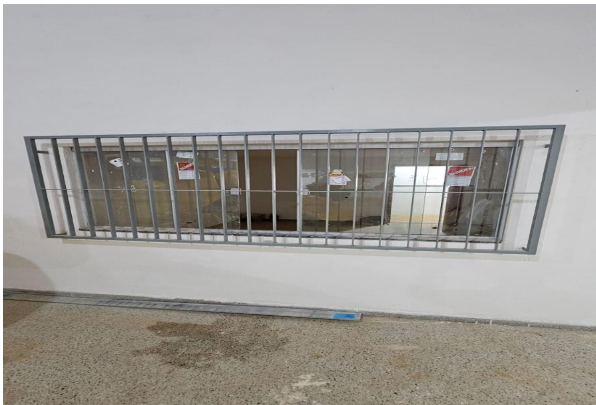
Foto 03: Grade de Ferro (janela)
