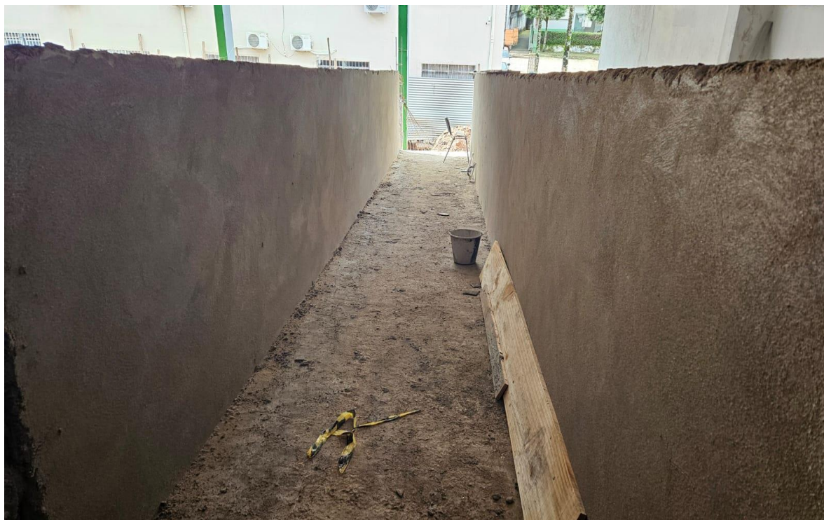
Foto 46: emboço/reboco
