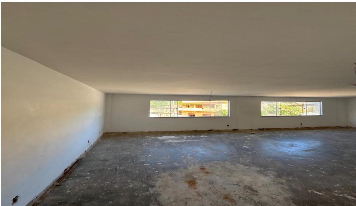
Foto 59: emassamento de teto e parede
