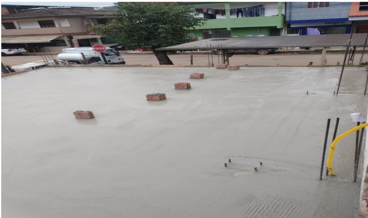
Foto 17: laje da ampliação
