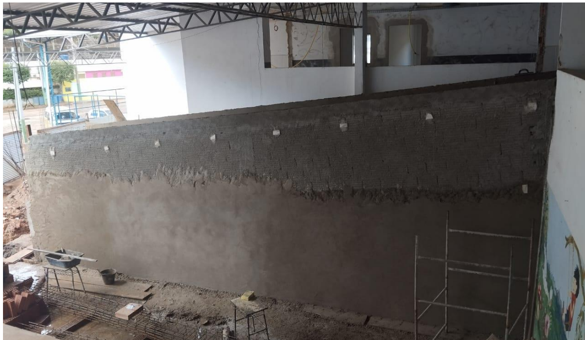
Foto 45: emboço/reboco
