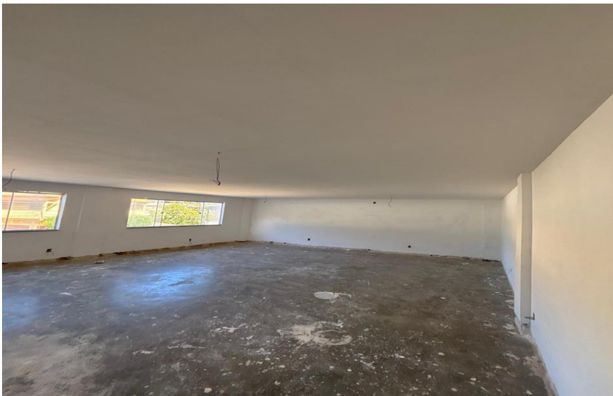
Foto 60: emassamento de teto e parede
