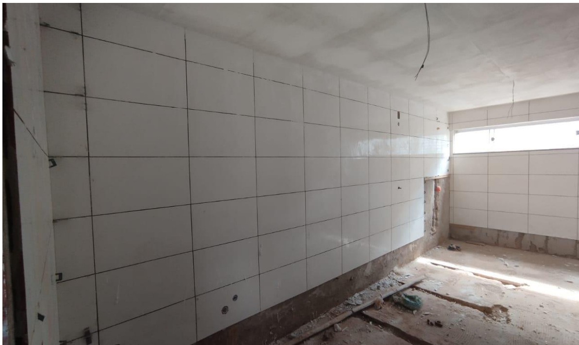
Foto 43: cerâmica de parede
