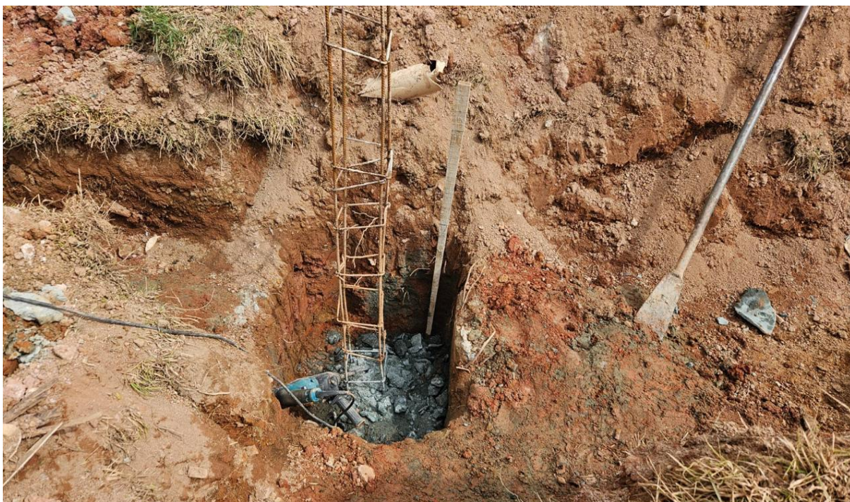
Foto 15: Arrasamento de Estacas
