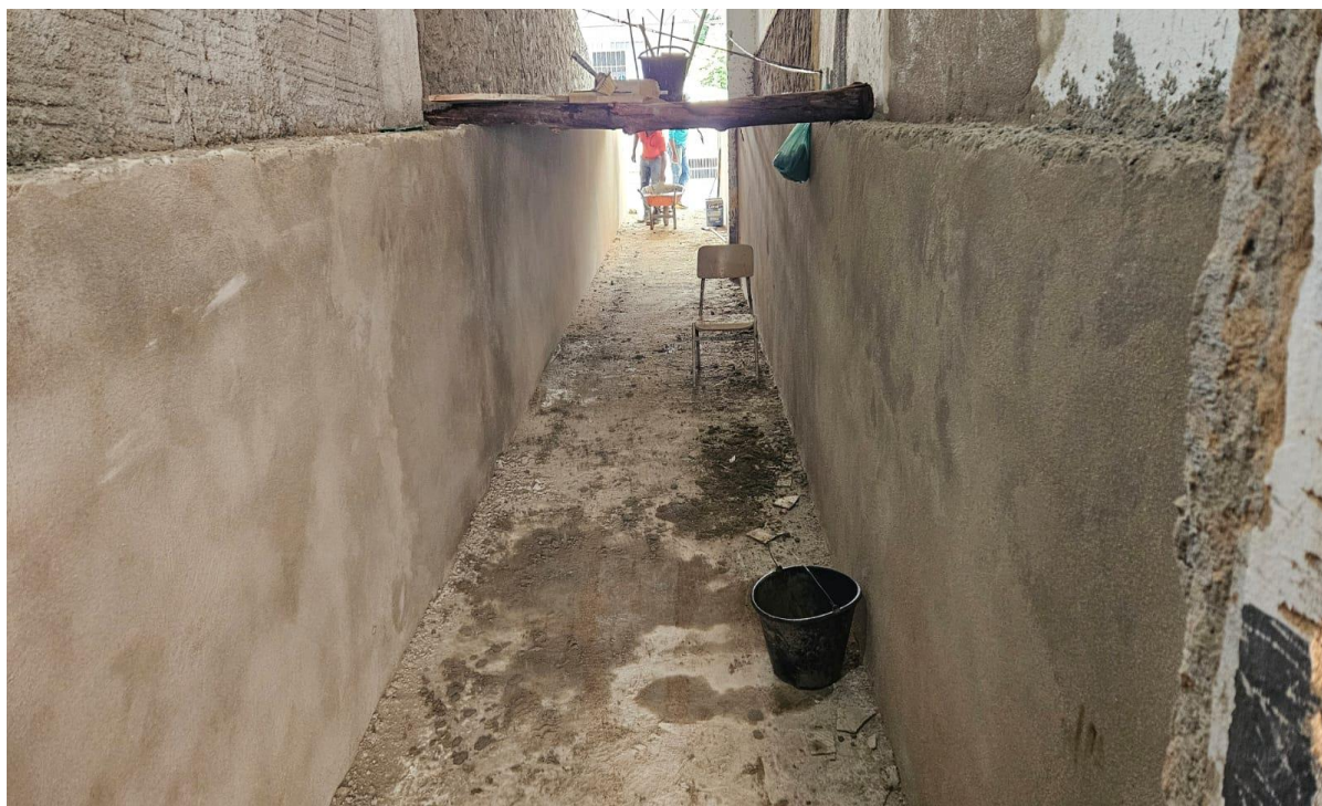
Foto 47: emboço/reboco
