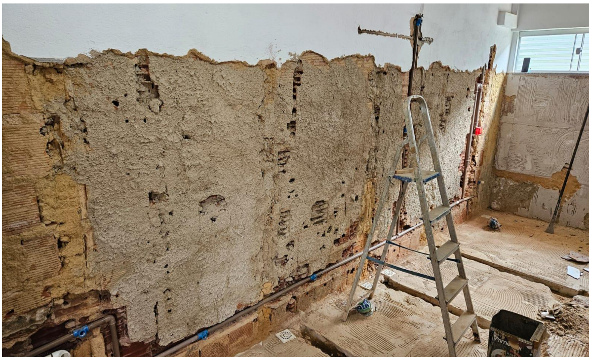
Foto 49: rasgos para hidráulica
