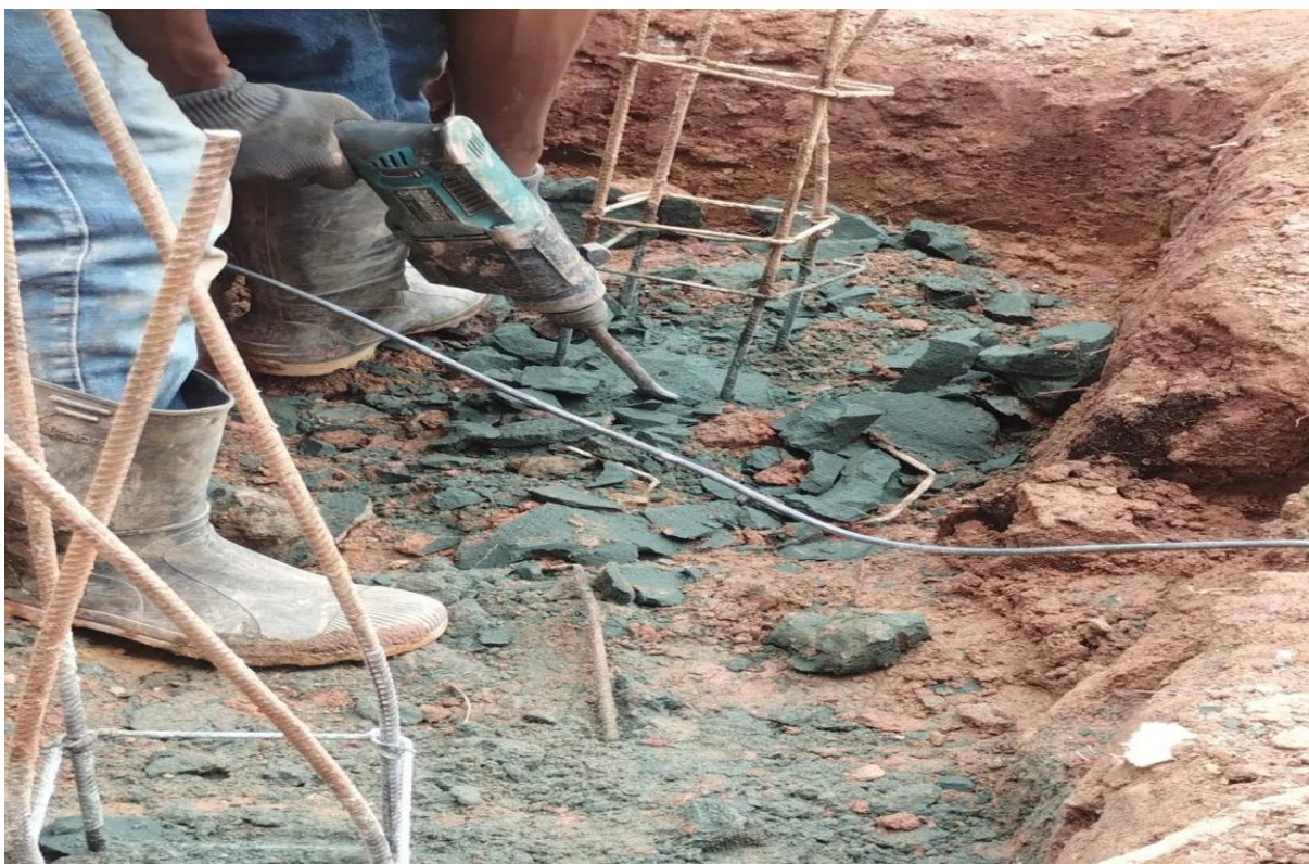
Foto 14: Arrasamento de Estacas
