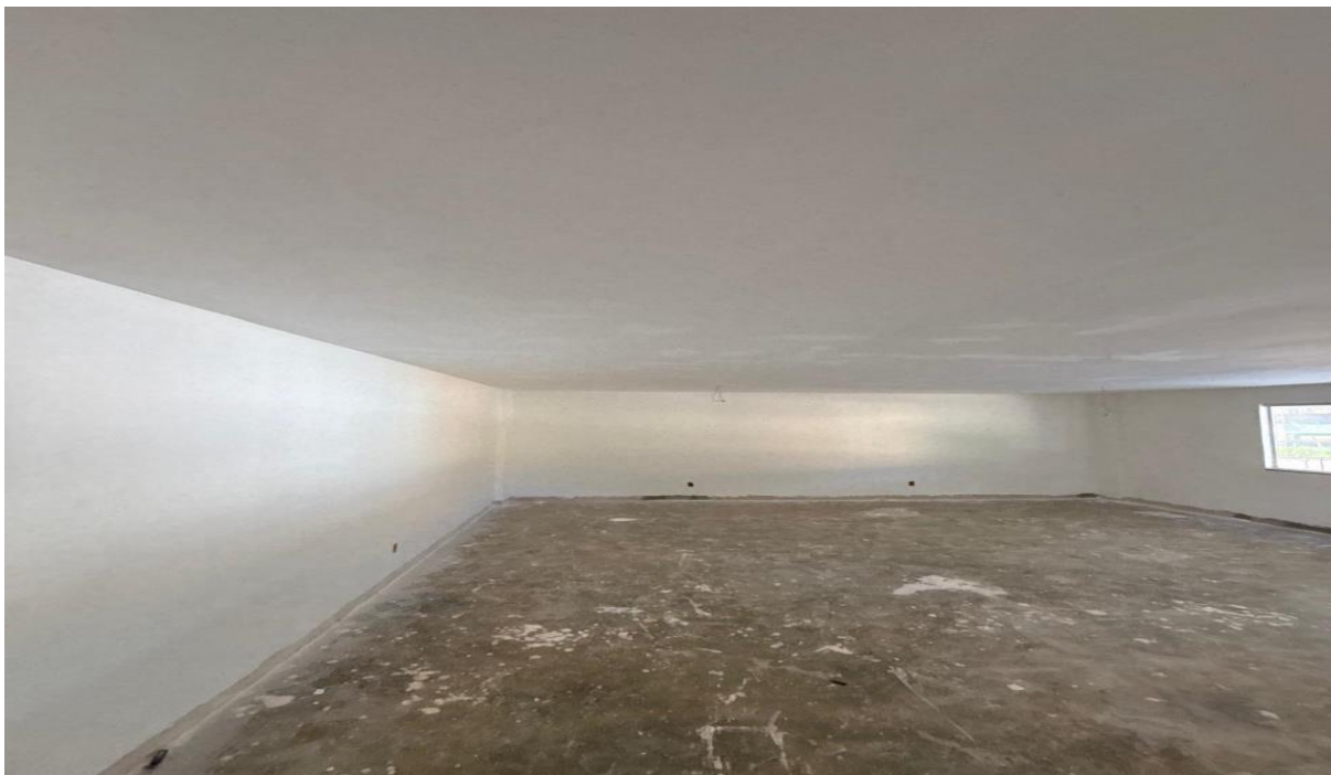
Foto 63: emassamento de teto e parede
