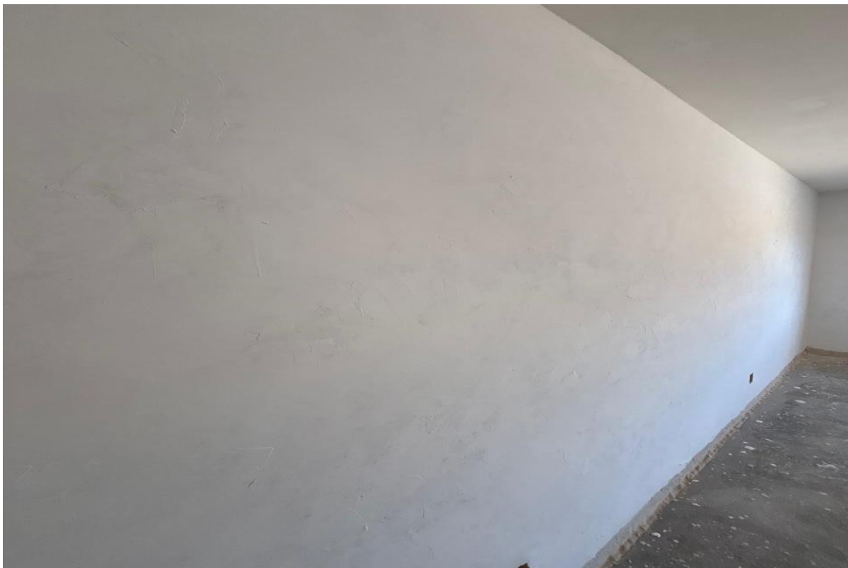
Foto 61: emassamento de teto e parede
