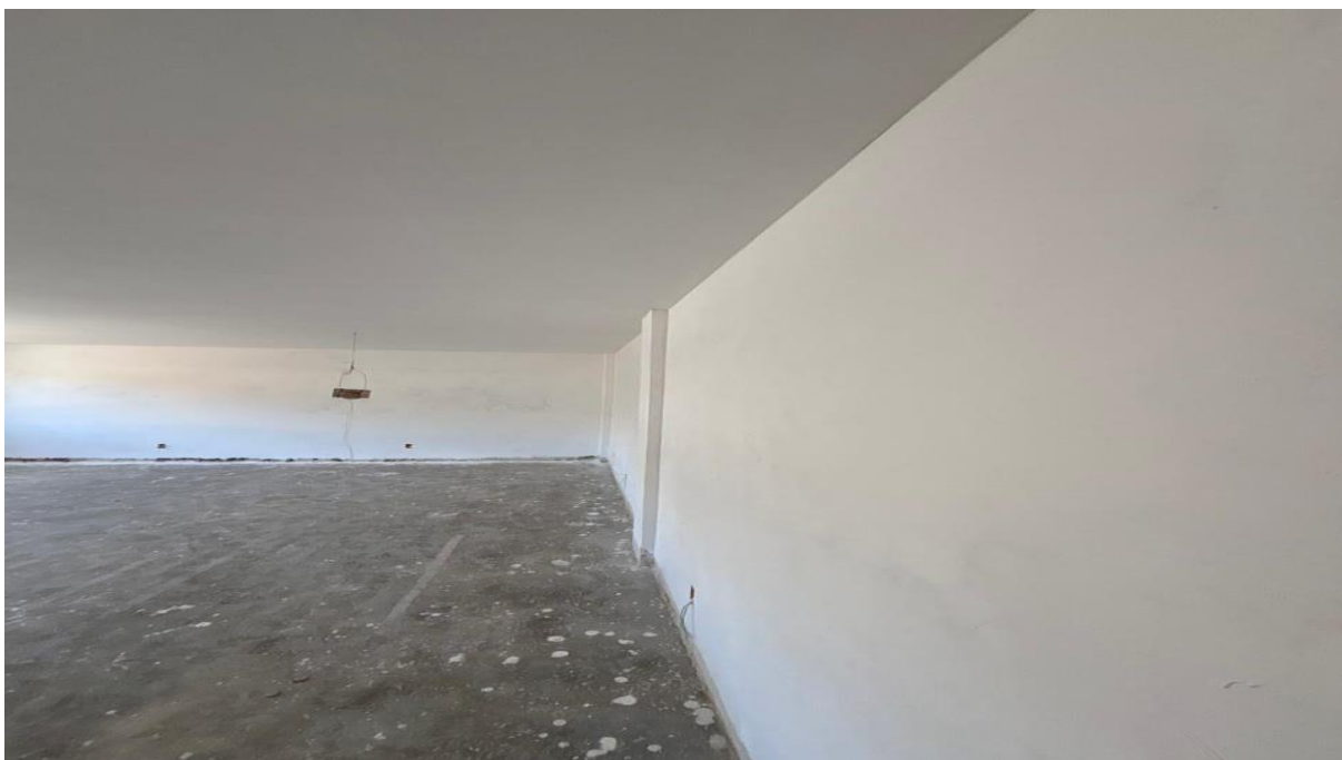
Foto 62: emassamento de teto e parede
