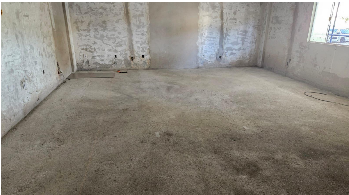
Foto 19: Lastro de Concreto
