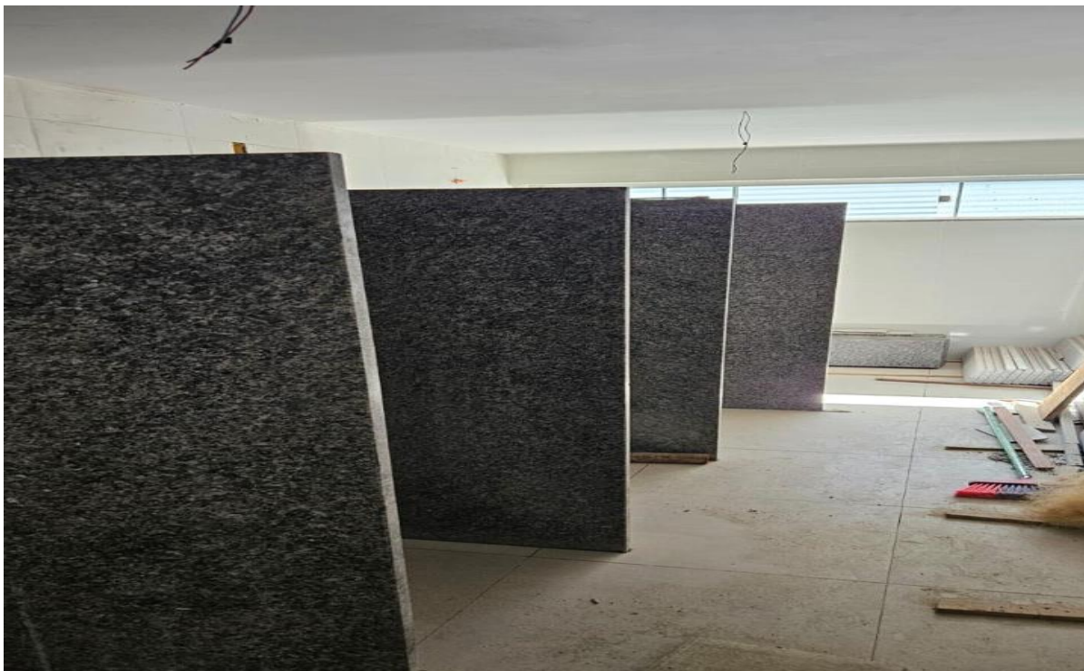
Foto 09: Instalação de Divisórias
