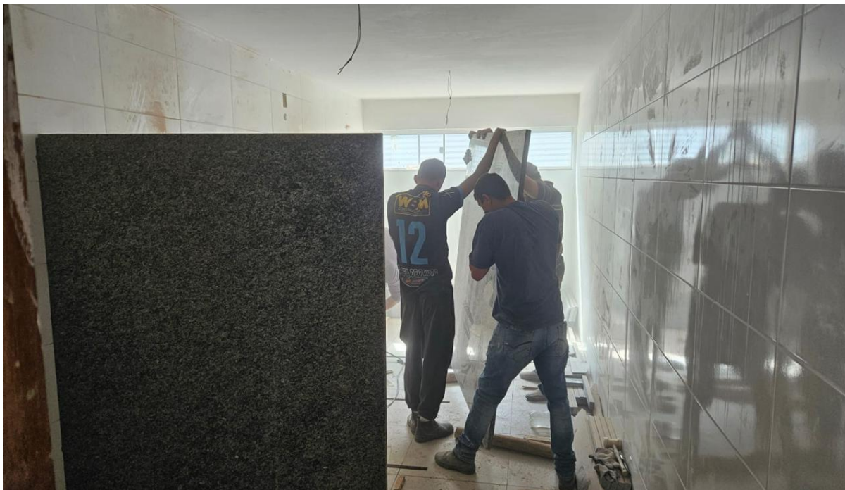
Foto 08: Instalação de Divisórias
