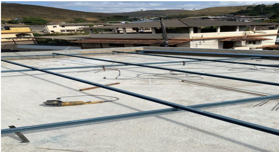
Foto 10: Trama de aço telhado
