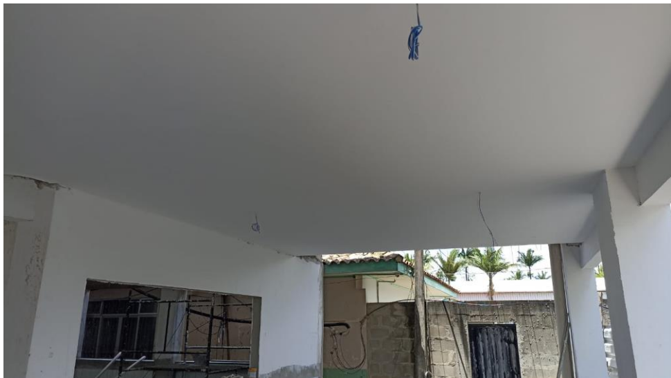
Figura 18 - Detalhe para forro de gesso
