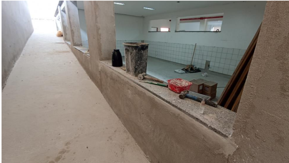
Figura 25 - Detalhe para peitoril das janelas
