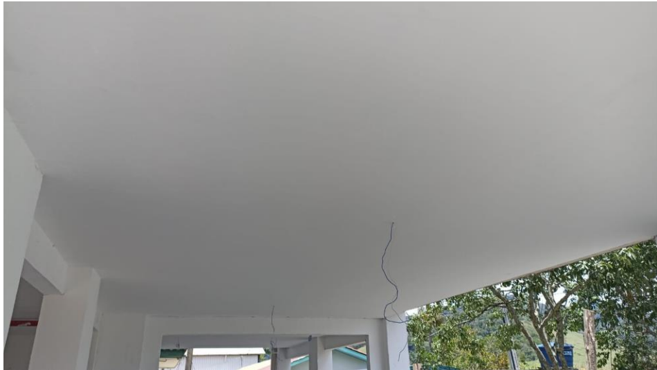
Figura 21 - Detalhe para forro de gesso
