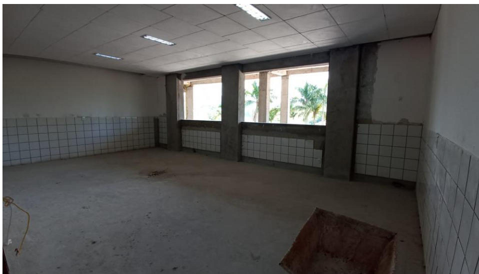
Figura 5- Detalhe para barrado cerâmico das paredes
