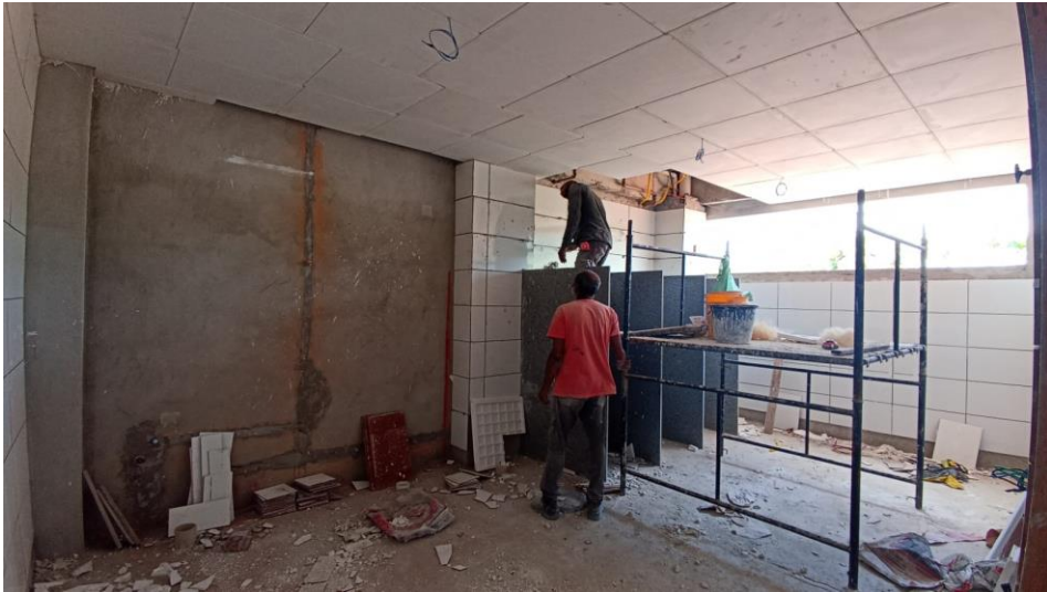
Figura 23 - Detalhe para forro de gesso
