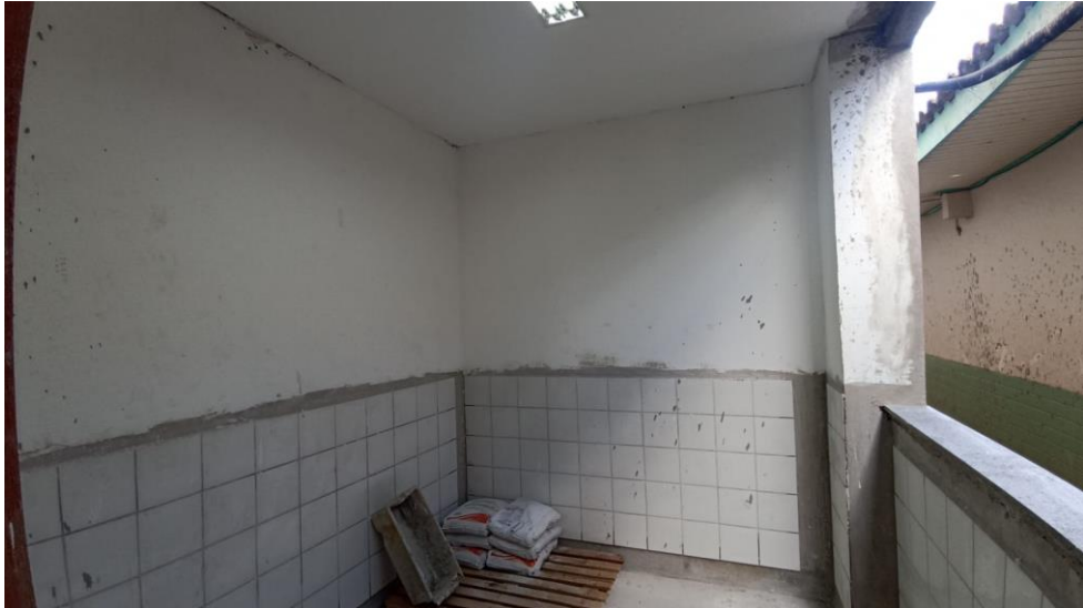
Figura 13 - Detalhe emassamento das paredes
