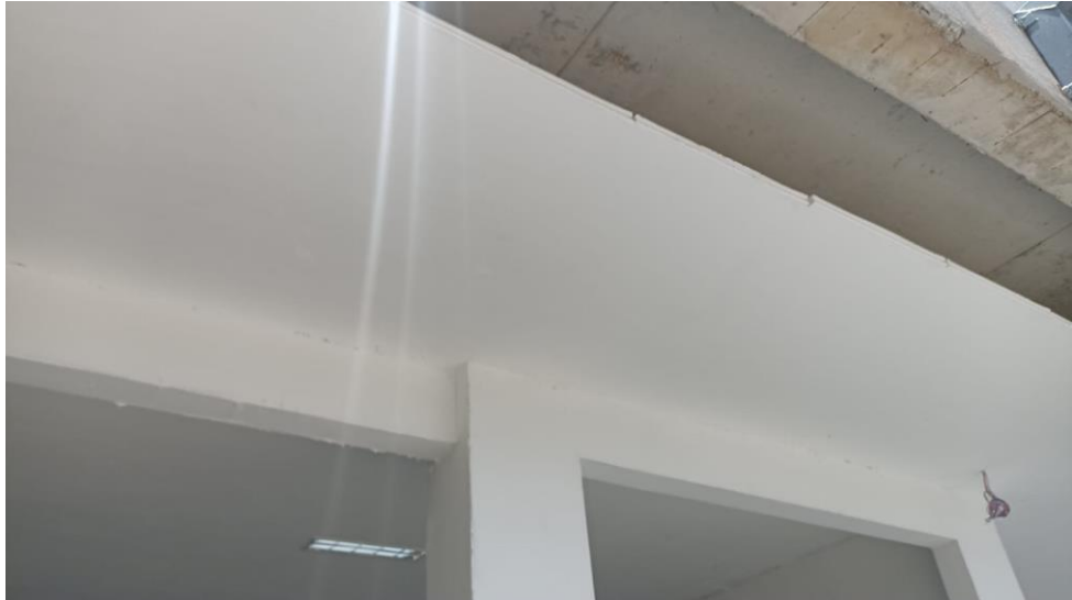
Figura 19 - Detalhe para forro de gesso
