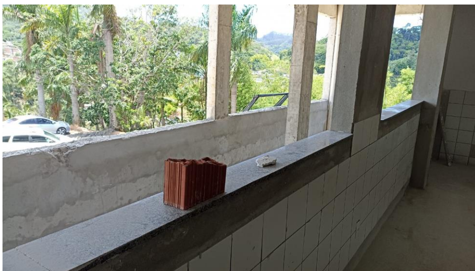
Figura 29 – Detalhe para peitoril das janelas
