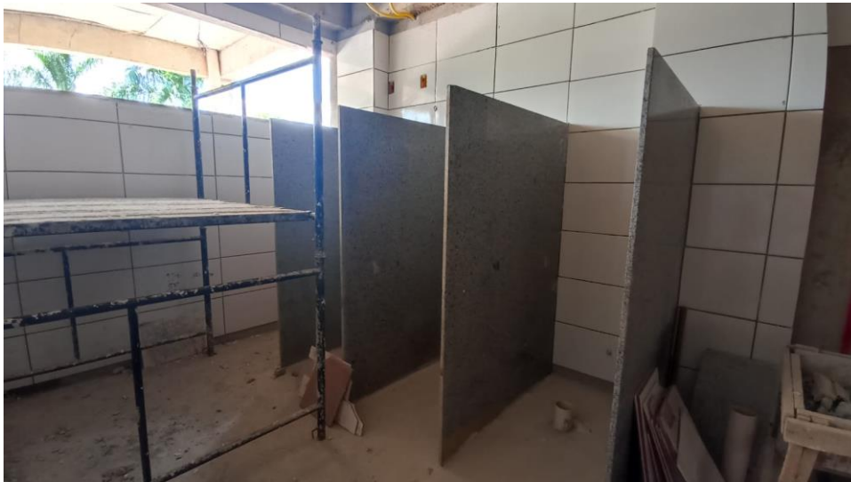
Figura 1 - Detalhe para divisórias dos banheiros
