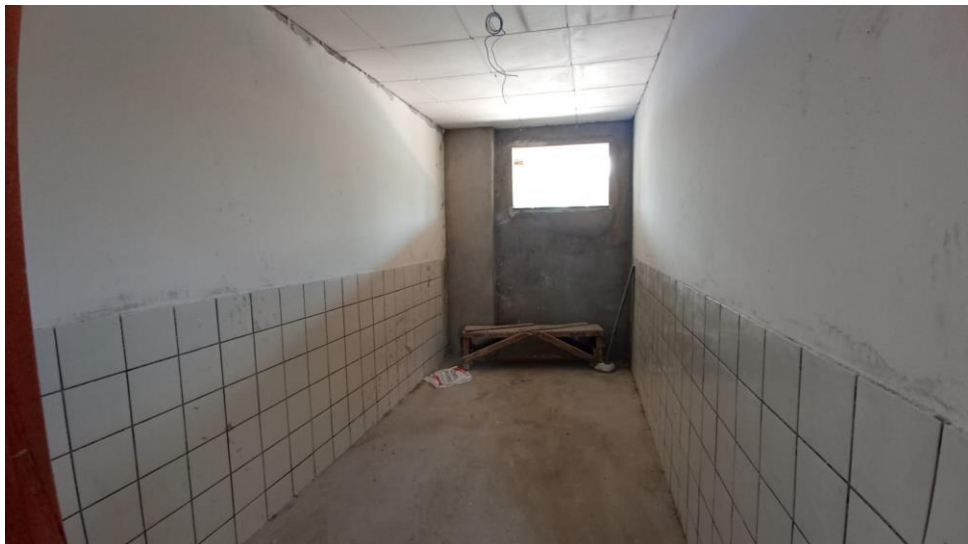
Figura 16 - Detalhe emassamento das paredes
