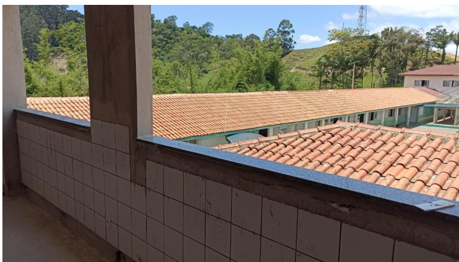
Figura 30 – Detalhe para peitoril das janelas
