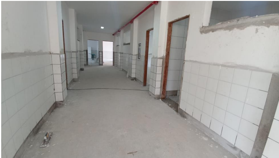
Figura 14 - Detalhe emassamento das paredes
