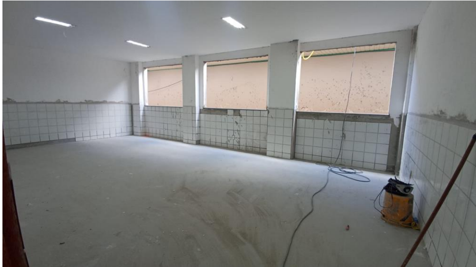
Figura 15 - Detalhe emassamento das paredes
