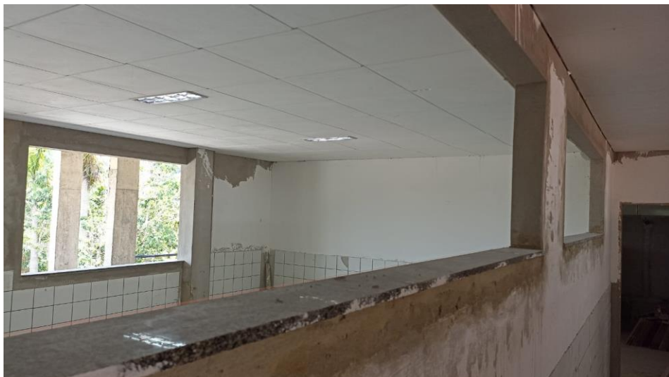
Figura 28 - Detalhe para peitoril das janelas
