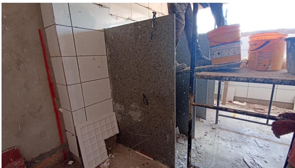
Figura 2 - Detalhe para divisórias dos banheiros
