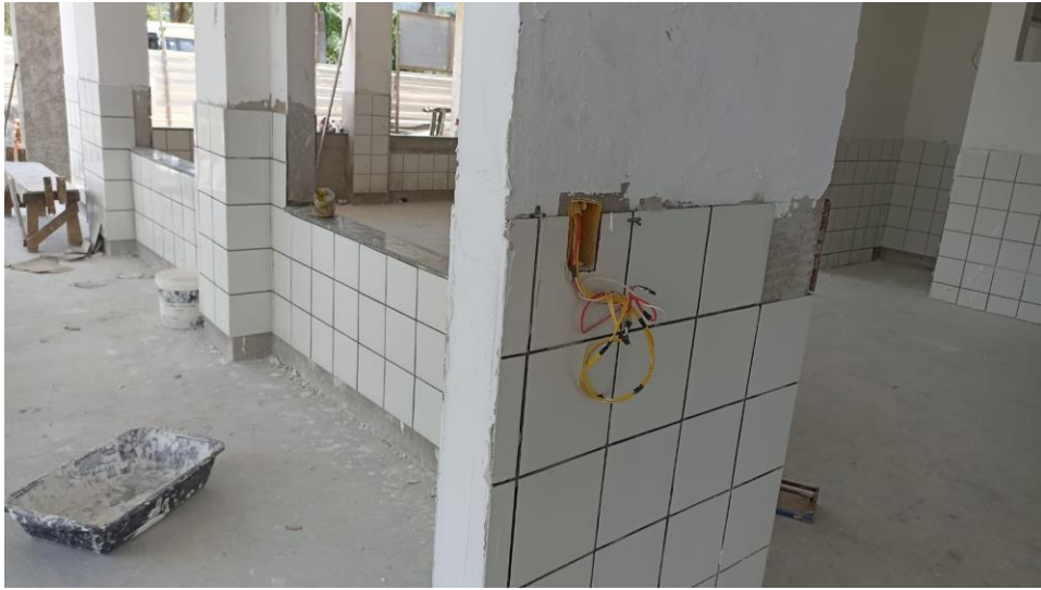
Figura 3 - Detalhe para barrado cerâmico das paredes
