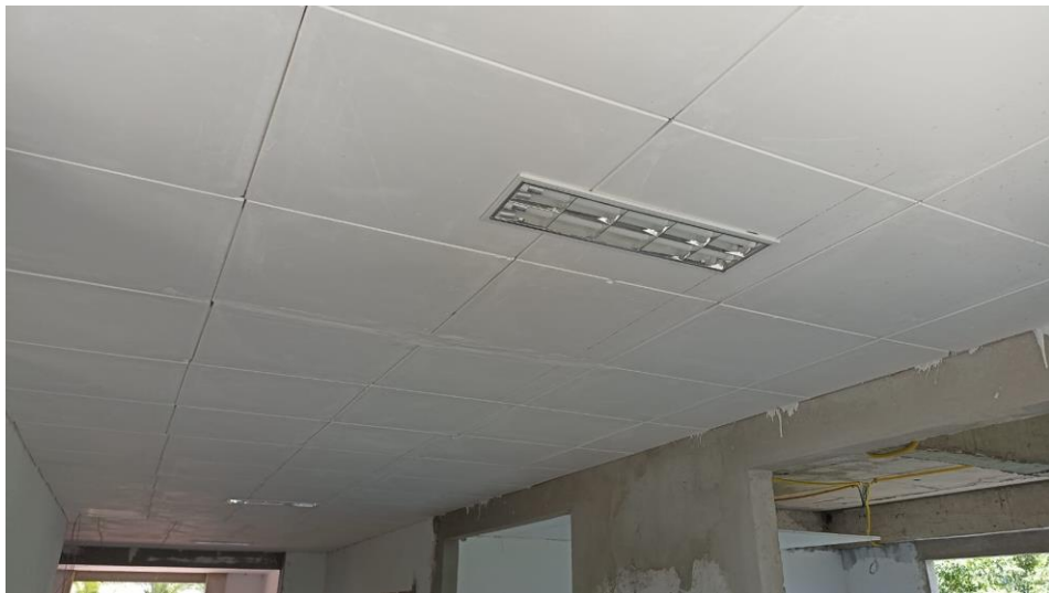
Figura 22 - Detalhe para forro de gesso
