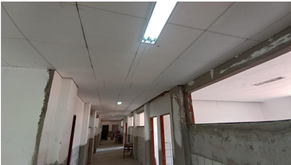
Figura 24 – Detalhe para forro de gesso
