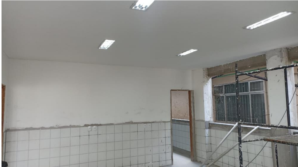
Figura 17 - Detalhe emassamento das paredes
