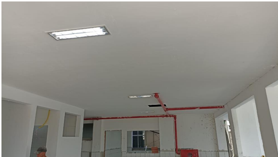
Figura 20 - Detalhe para forro de gesso
