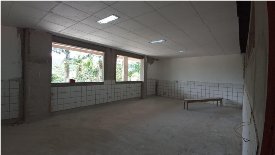
Figura 4 - Detalhe para barrado cerâmico das paredes
