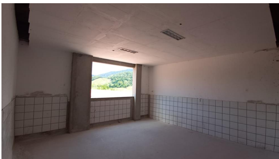
Figura 6 - Detalhe para barrado cerâmico das paredes
