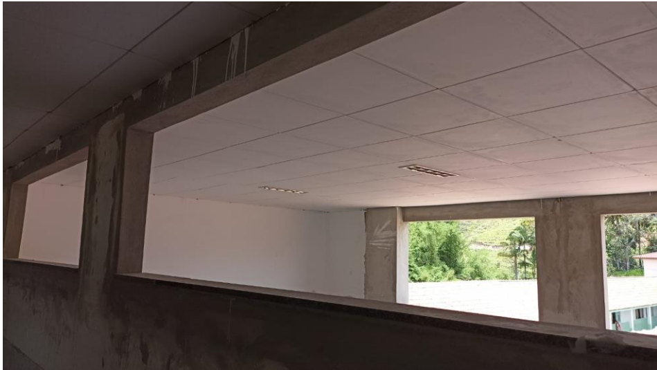
Figura 27 - Detalhe para peitoril das janelas
