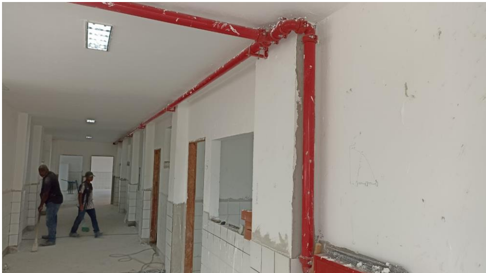
Figura 12 - Detalhe para emassamento das paredes
