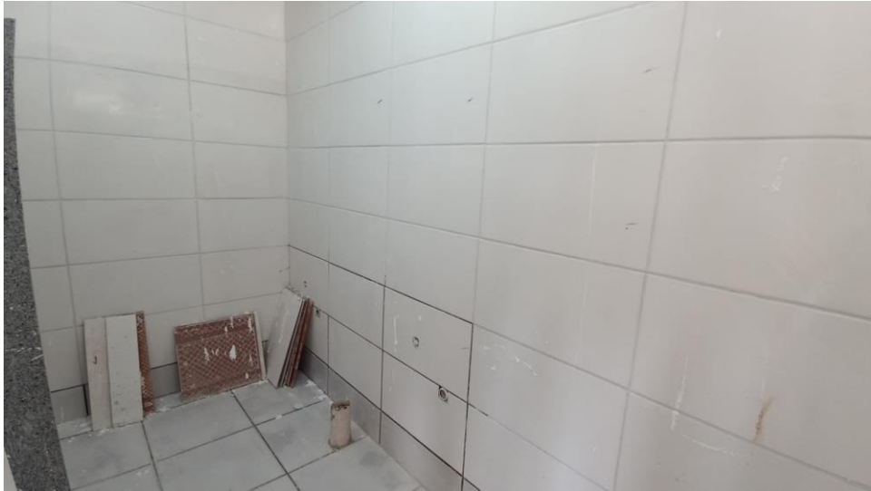
Figura 9 - Detalhe para revestimento das paredes e do piso
