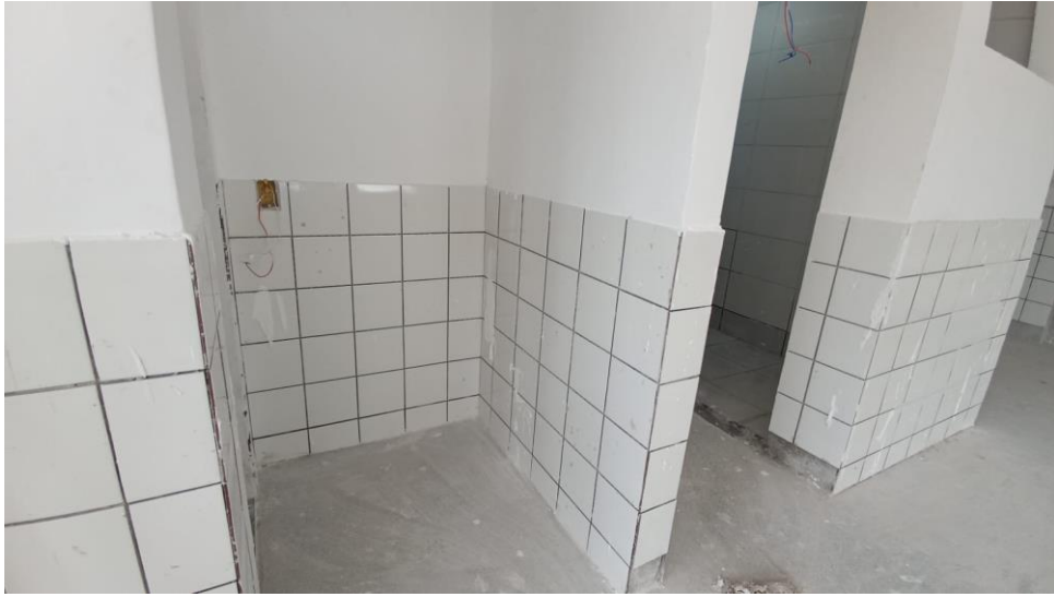
Figura 7 - Detalhe para barrado cerâmico das paredes
