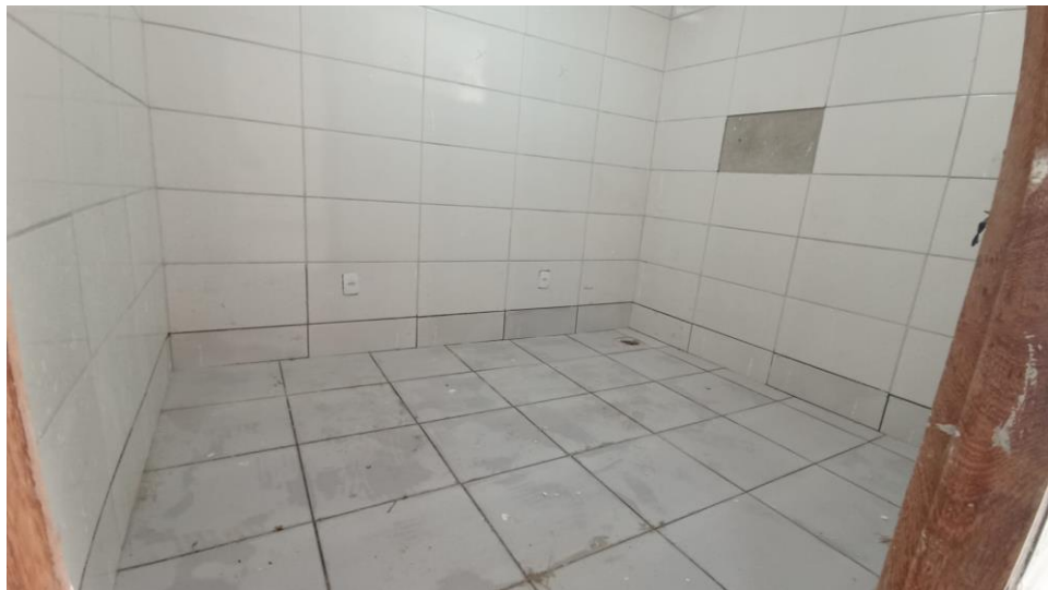
Figura 10 - Detalhe para revestimento das paredes e do piso
