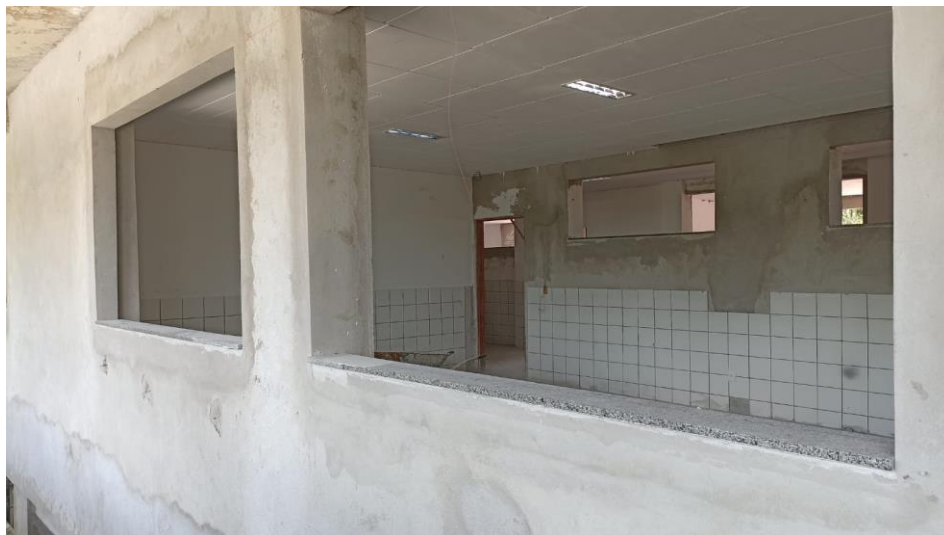
Figura 26 - Detalhe para peitoril das janelas
