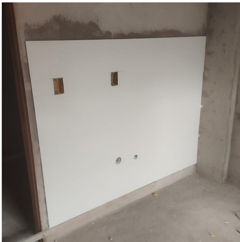
Execução de revestimento em paredes
