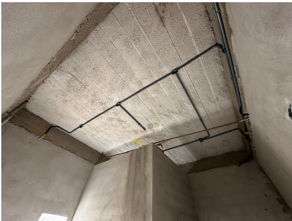
Instalação de infraestrutura de cabeamento estruturado e elétrica
