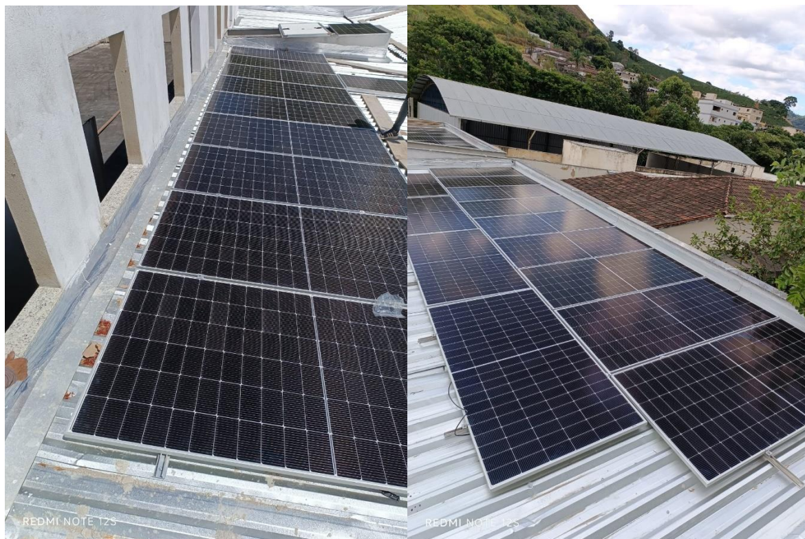
Instalação de Usina Solar Fotovoltaica
