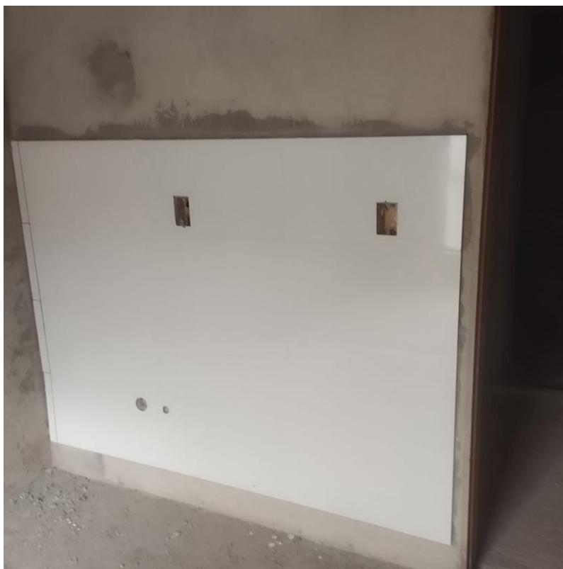
Execução de revestimento em paredes
