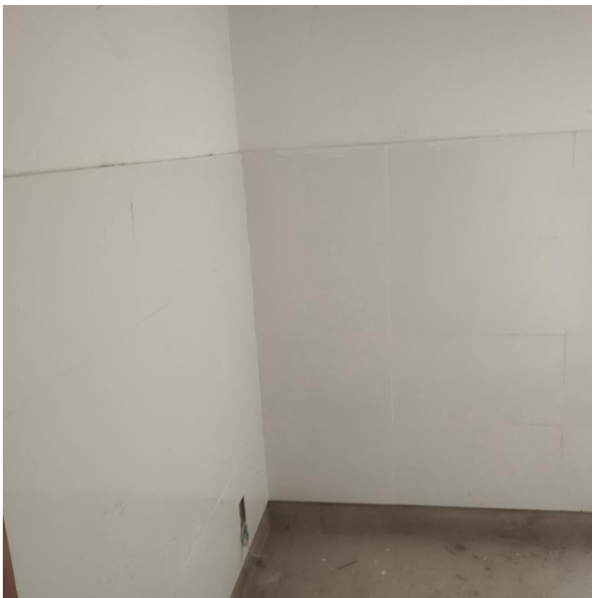
Execução de revestimento em paredes
