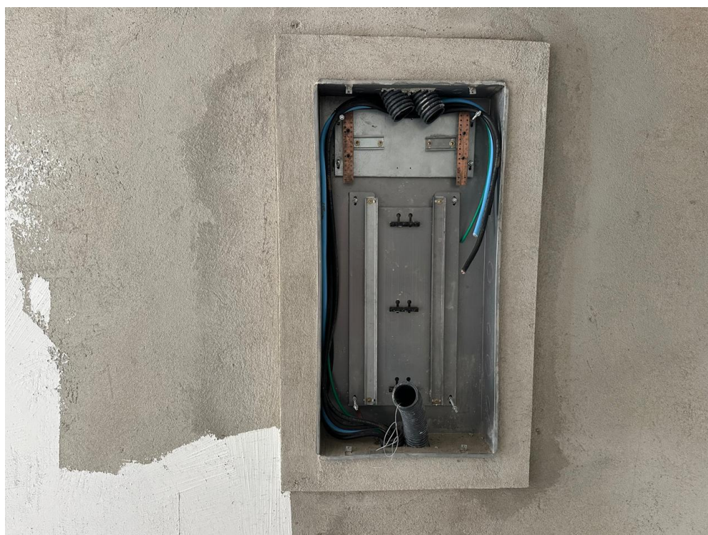
Instalação de quadro de distribuição e eletrodutos
