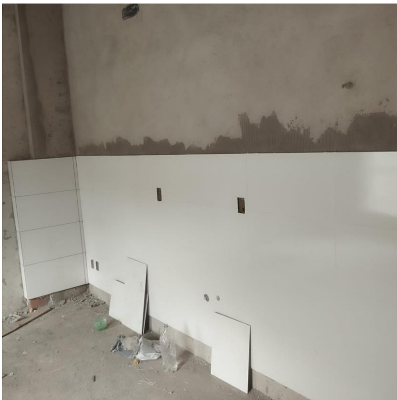
Execução de revestimento em paredes
