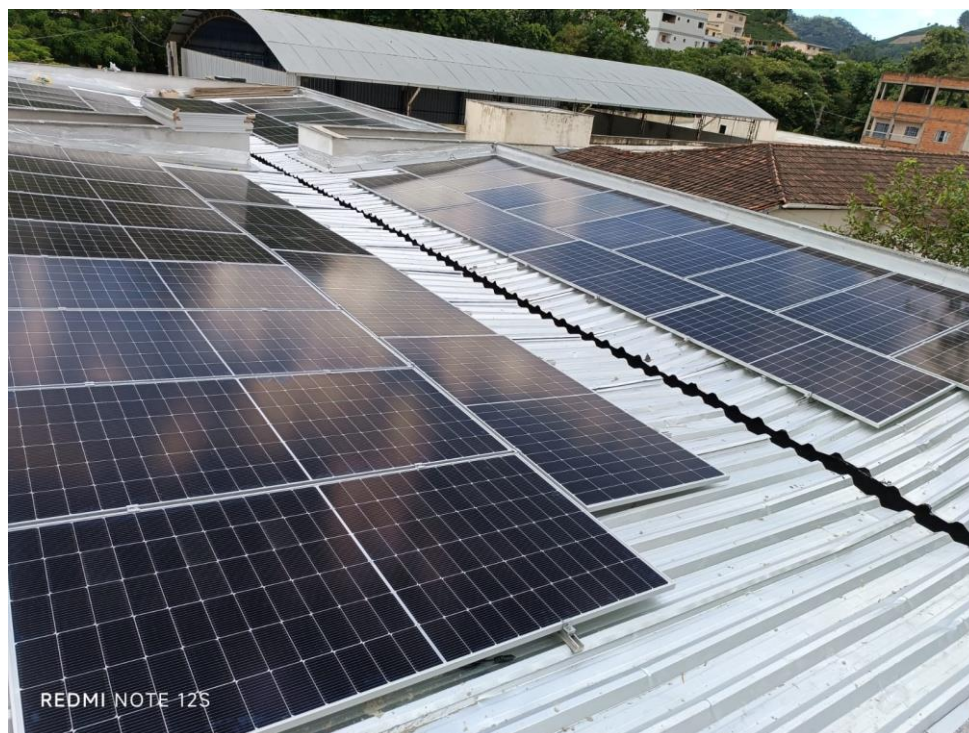
Instalação de Usina Solar Fotovoltaica
