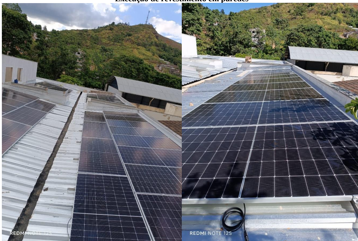
Instalação de Usina Solar Fotovoltaica
