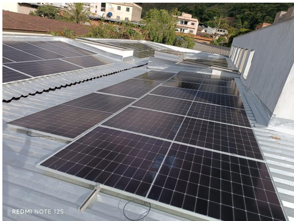
Instalação de Usina Solar Fotovoltaica
