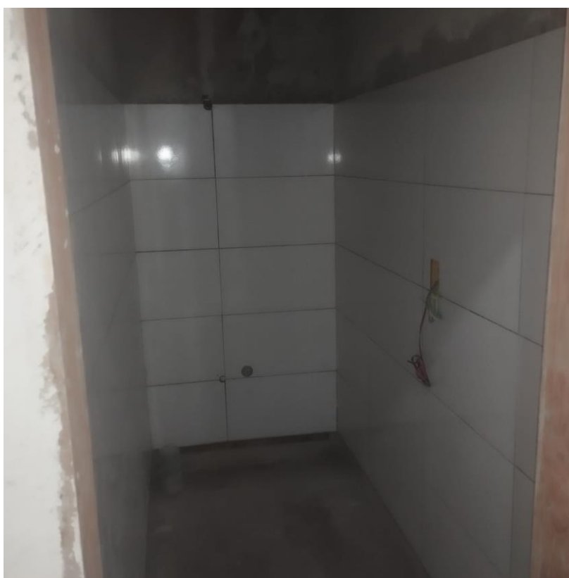
Execução de revestimento em paredes
