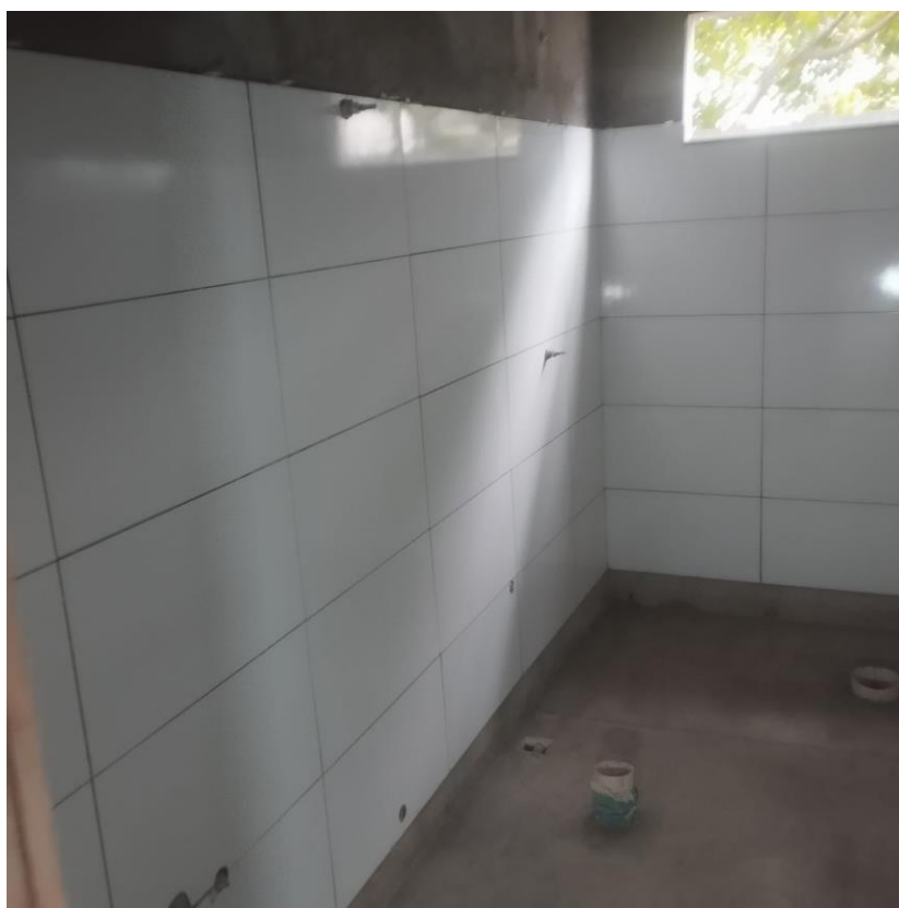
Execução de revestimento em paredes
