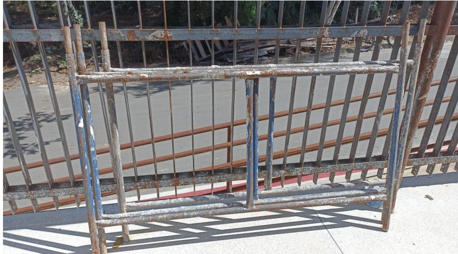
Figura 1 – Detalhe para andaimes serviços fachadas externas
