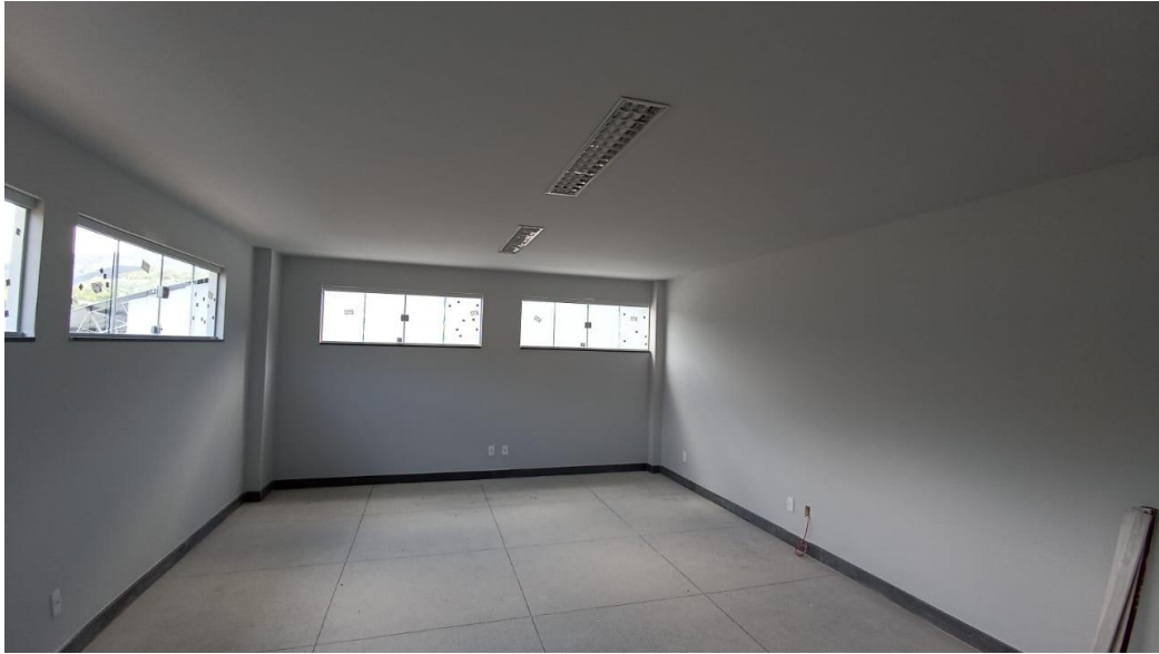
Figura 21 - Detalhe para pintura interna
