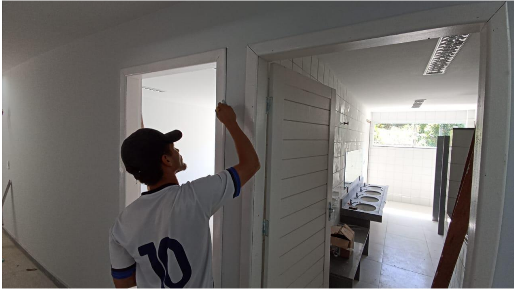
Figura 27 - Detalhe para pintura de portas, marcos e alisares
