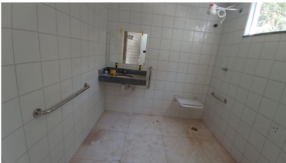
Figura 5 - Detalhe para barras de apoio, torneira de pressão, cuba e espelho banheiro PCD
