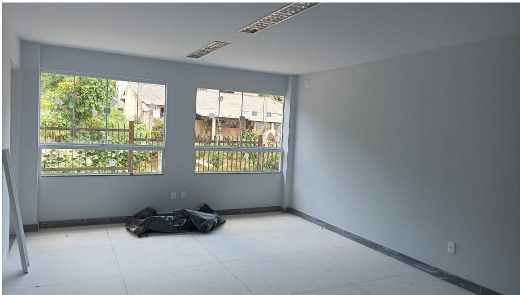
Figura 24 - Detalhe para pintura interna
