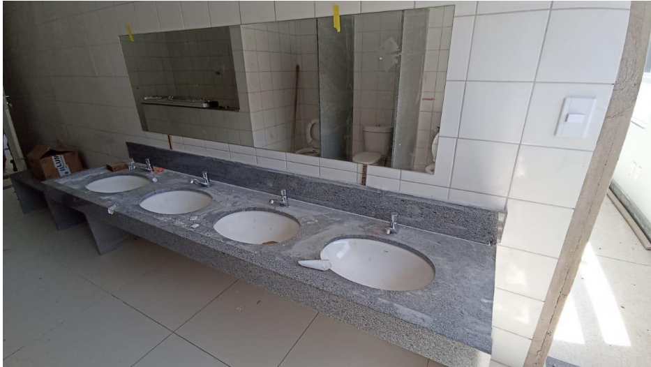
Figura 7 - Detalhe cuba de embutir oval, espelho e torneiras de pressão
