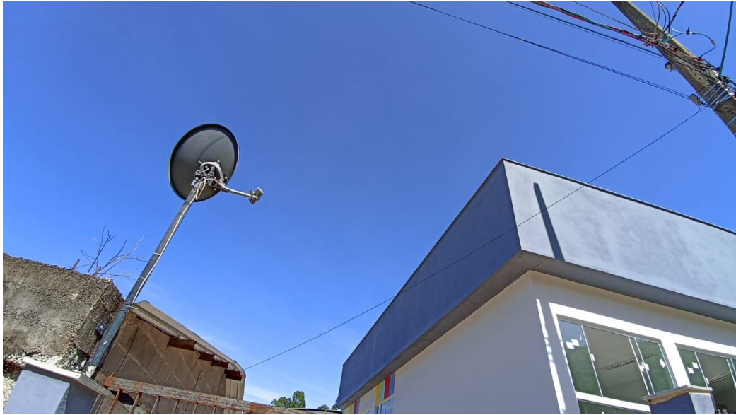
Figura 19 - Detalhe para pintura externa
