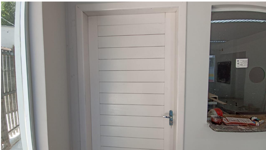
Figura 34 - Detalhe para porta instalada e pintada
