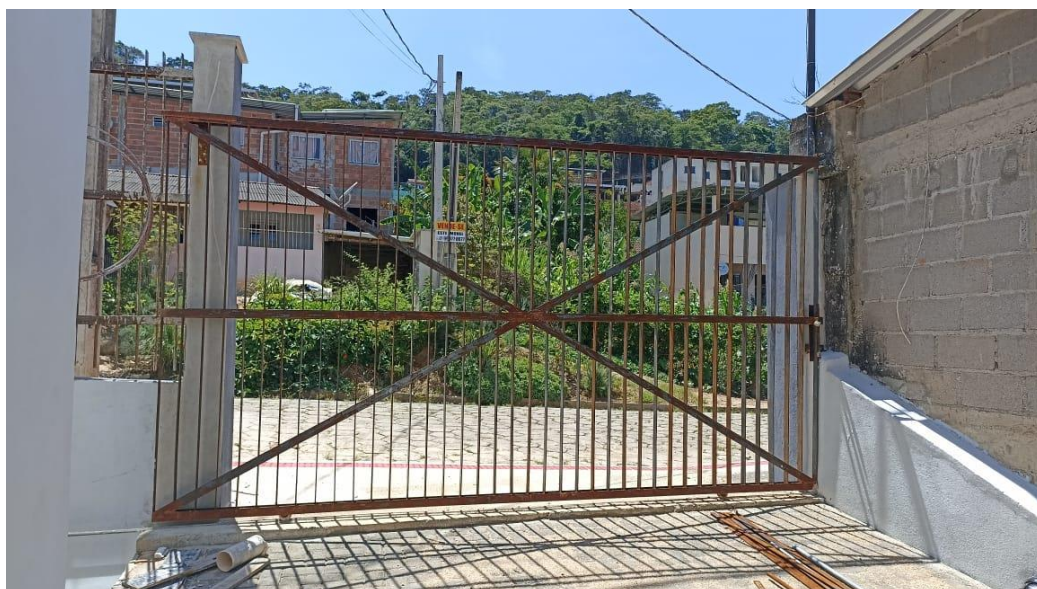
Figura 38 - Detalhe para portão de ferro de correr
