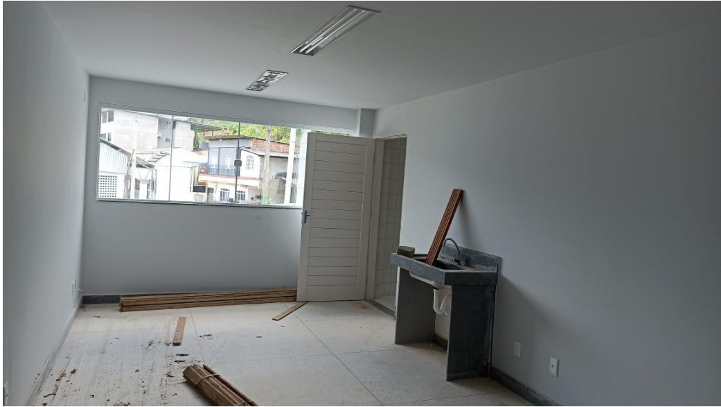
Figura 25 - Detalhe para pintura interna
