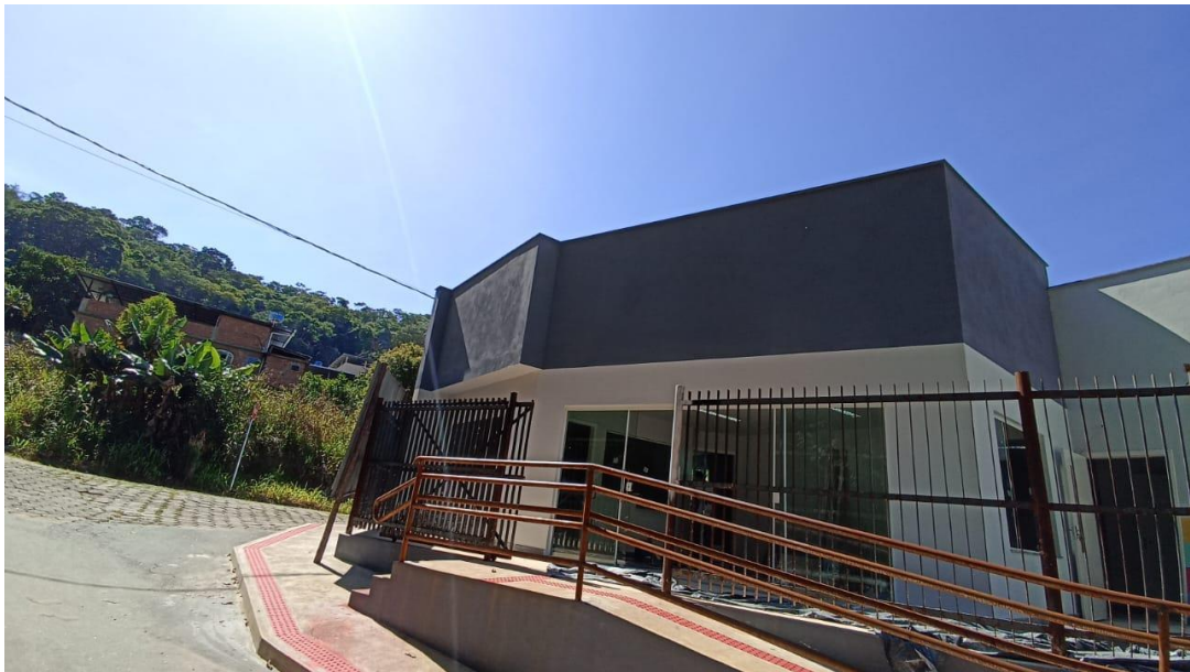
Figura 16 - Detalhe para pintura externa
