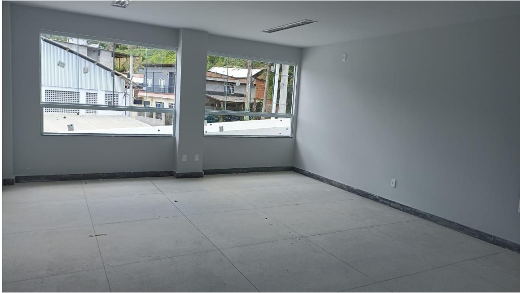
Figura 23 - Detalhe para pintura interna
