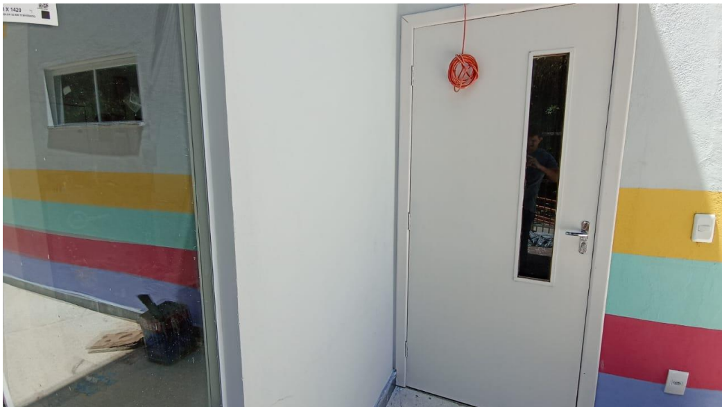
Figura 32 - Detalhe para porta instalada e pintada
