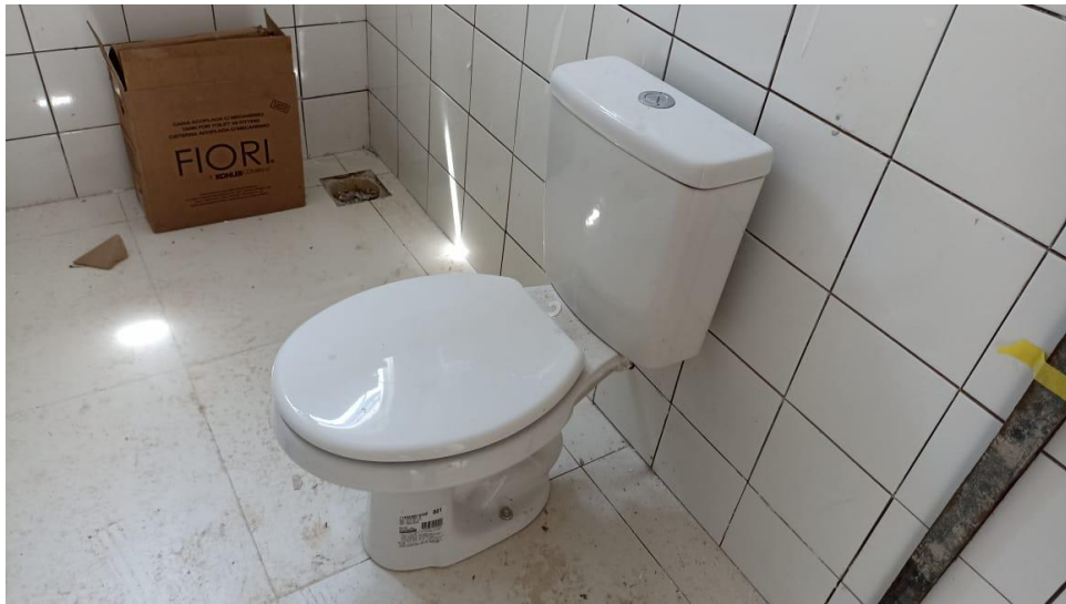
Figura 3 – Detalhe para bacia sifonada de louça branca
