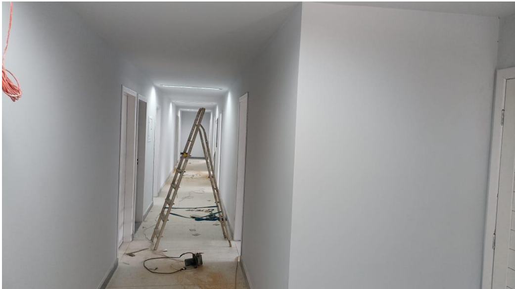
Figura 22 – Detalhe para pintura interna
