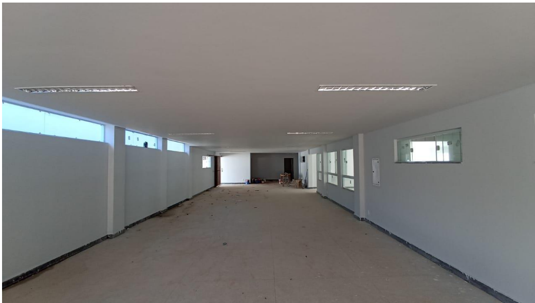
Figura 26 - Detalhe para pintura interna
