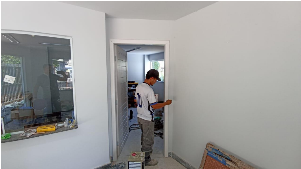
Figura 28 - Detalhe para pintura de portas, marcos e alisares
