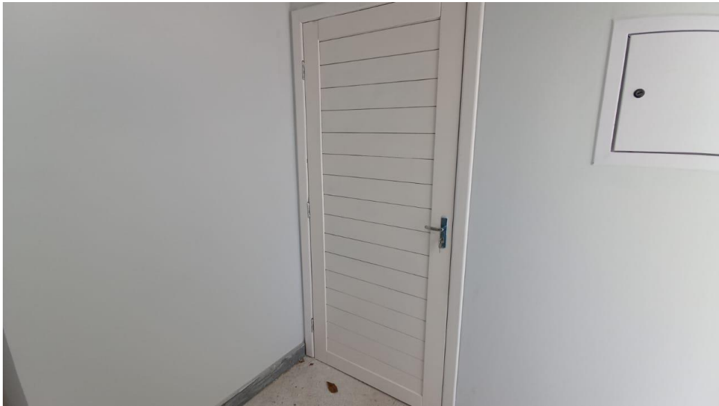
Figura 33 - Detalhe para porta instalada e pintada
