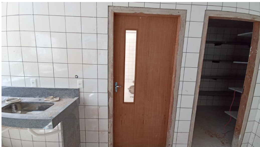
Figura 37 - Detalhe para porta instalada
