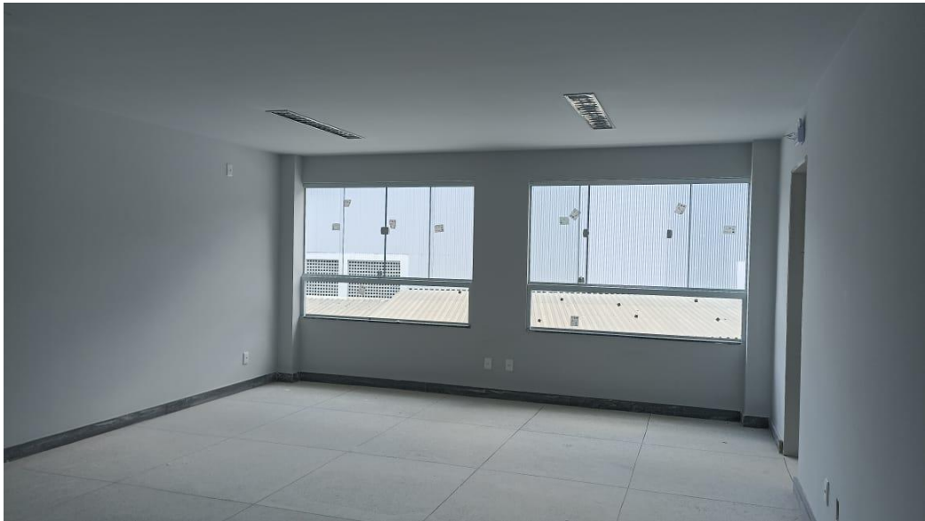
Figura 20 - Detalhe para pintura interna
