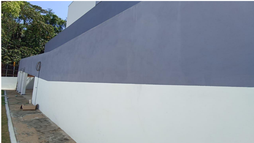
Figura 18 – Detalhe para pintura externa
