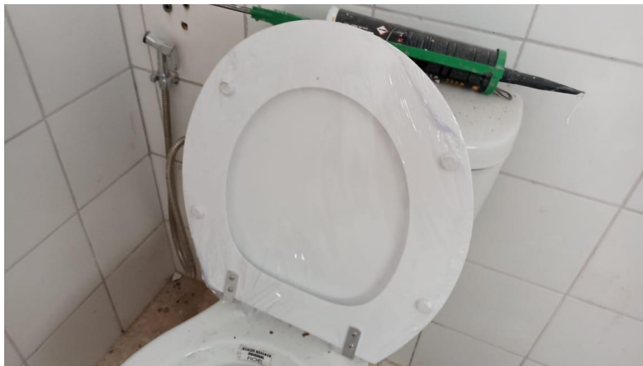
Figura 2 – Detalhe para assento em poliéster banheiro PCD
