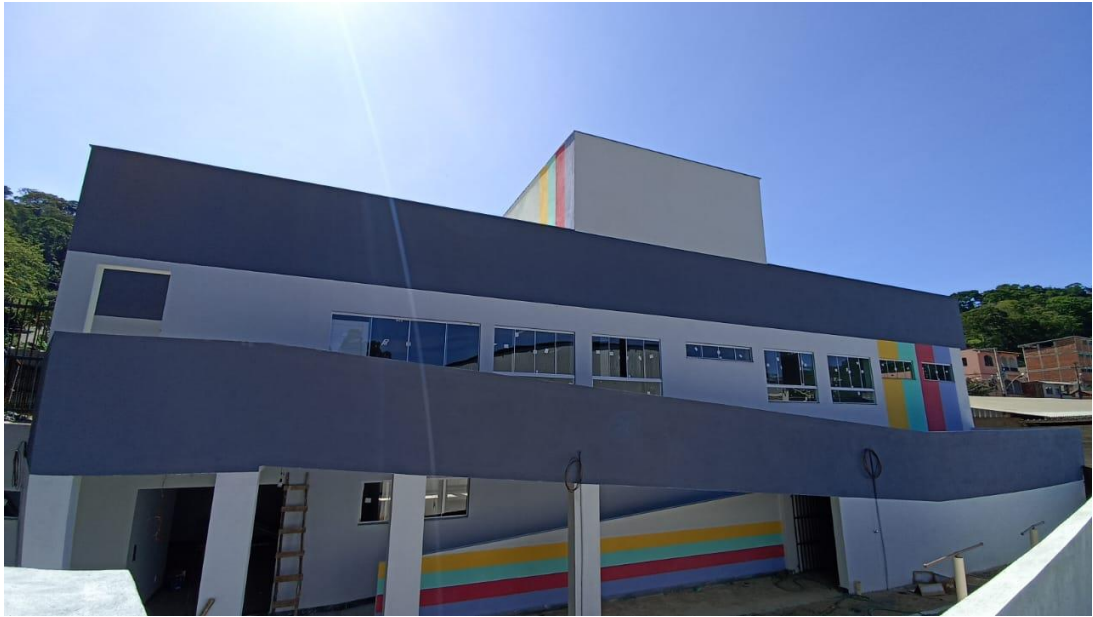
Figura 15 – Detalhe para pintura externa
