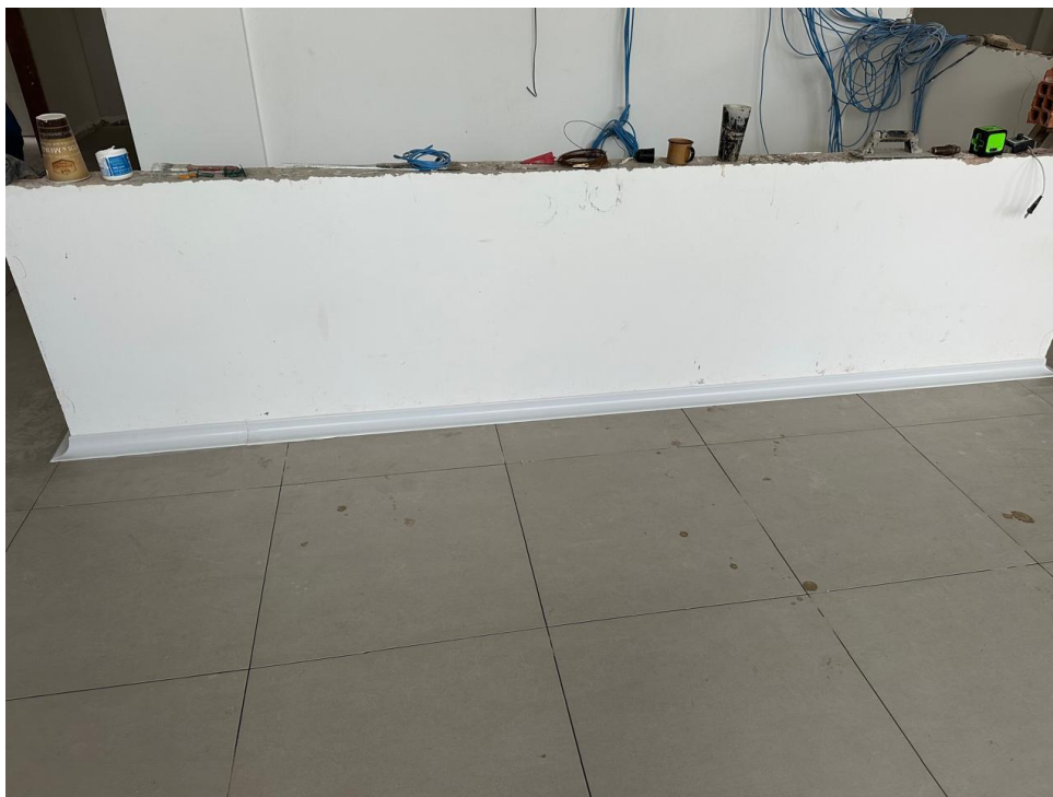
Instalação de rodapé
