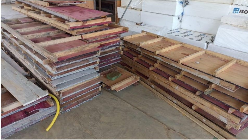
Figura 7 - Detalhe para montagem de fôrmas do pavimento superior
