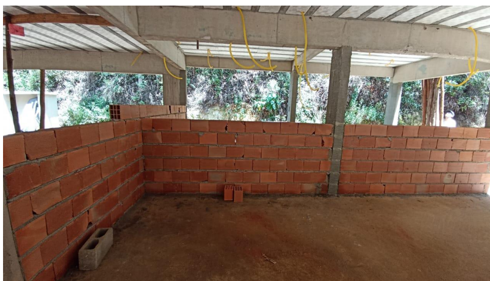
Figura 4- Detalhe para alvenaria de vedação pavimento térreo
