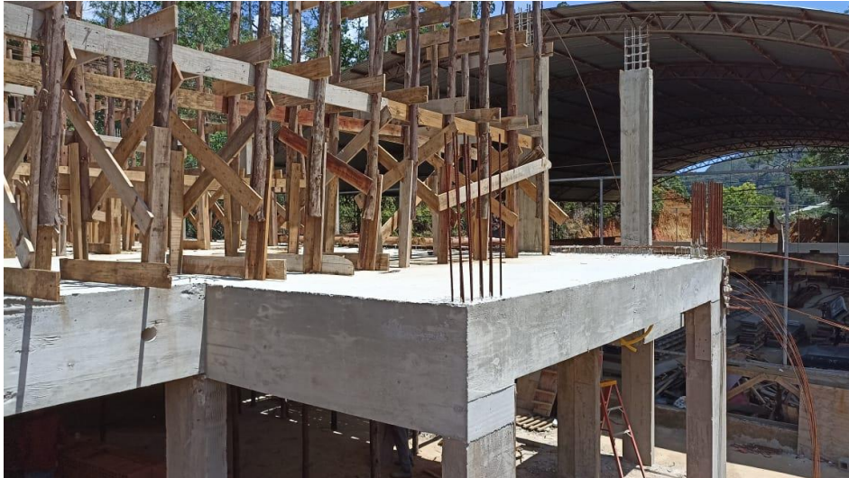
Figura 11 – Detalhe para armadura das vigas e pilares do pavimento superior
