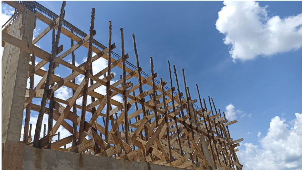
Figura 9 – Detalhe para armadura das vigas e pilares do pavimento superior
