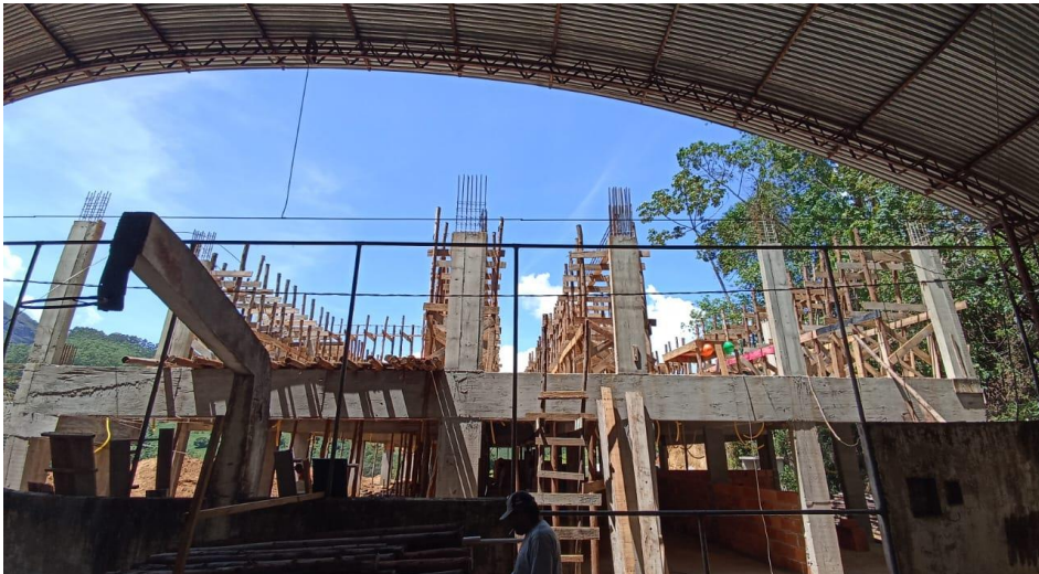
Figura 12 – Detalhe para armadura das vigas e pilares do pavimento superior
