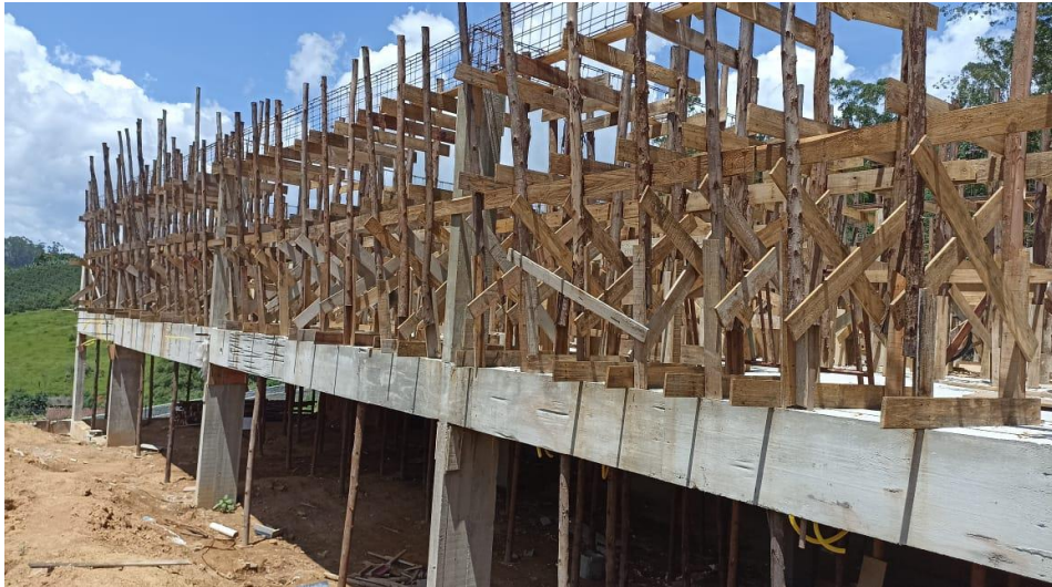
Figura 10 – Detalhe para armadura das vigas e pilares do pavimento superior
