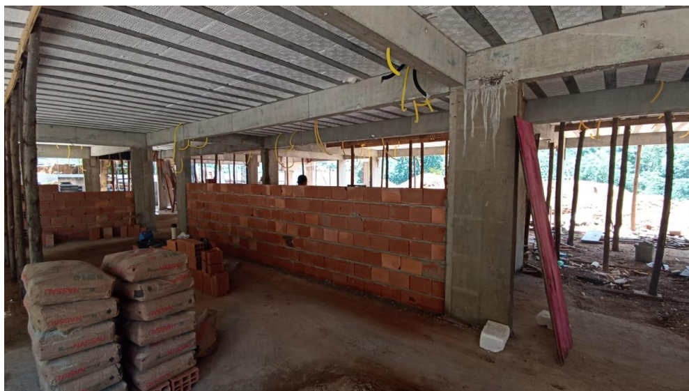
Figura 3 – Detalhe para alvenaria de vedação pavimento térreo
