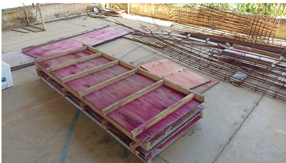
Figura 6 - Detalhe para montagem de fôrmas do pavimento superior
