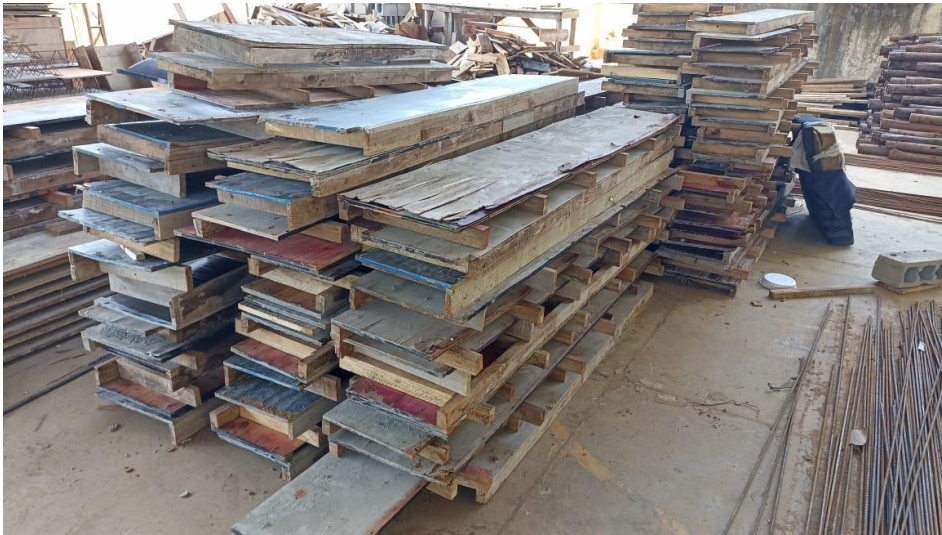
Figura 8 - Detalhe para montagem de fôrmas do pavimento superior
