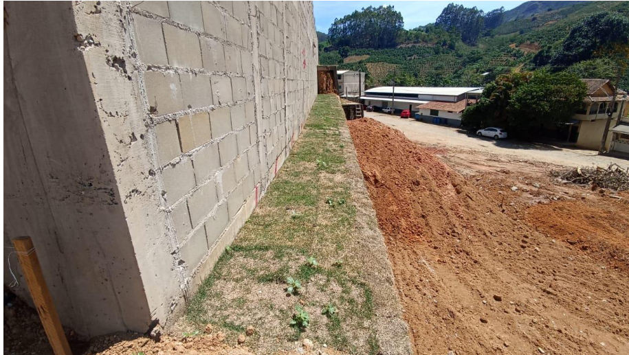
Figura 17 – Detalhe para plantio de grama frente muro de arrimo
