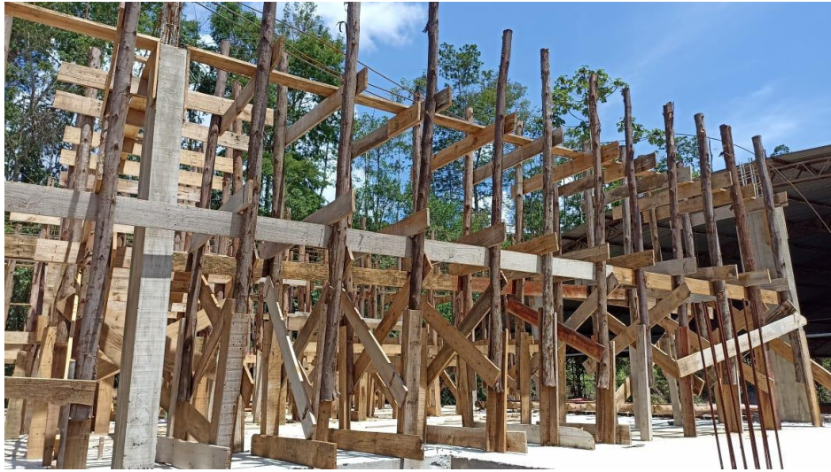
Figura 13 – Detalhe para armadura das vigas e pilares do pavimento superior
