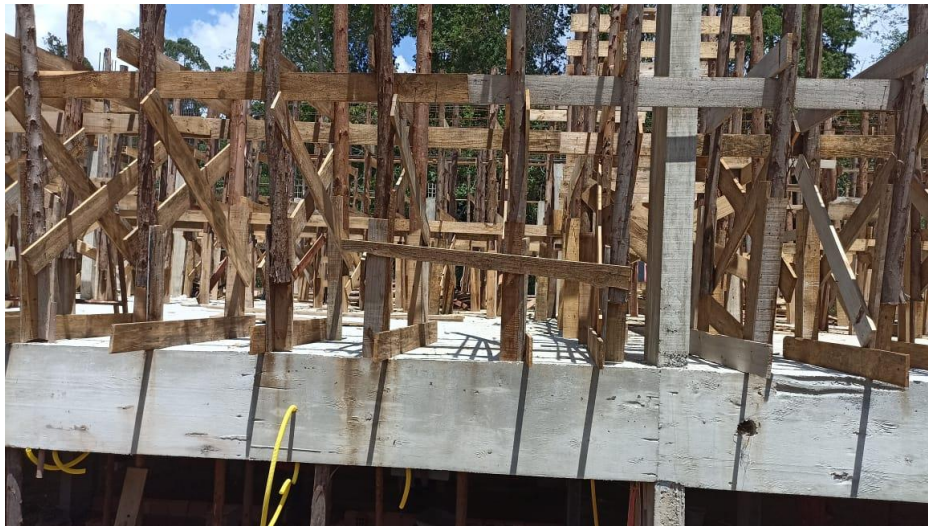
Figura 14 – Detalhe para armadura das vigas e pilares do pavimento superior
