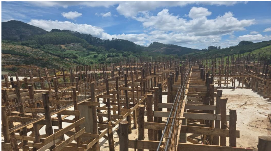
Figura 16 – Detalhe para armadura das vigas e pilares do pavimento superior
