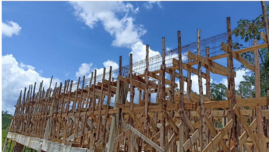
Figura 15 - Detalhe para armadura das vigas e pilares do pavimento superior
