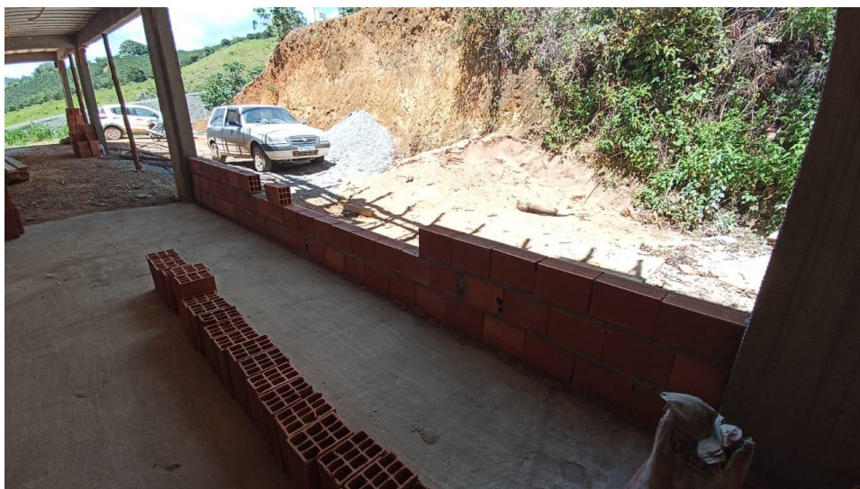
Figura 5- Detalhe para alvenaria de vedação pavimento térreo
