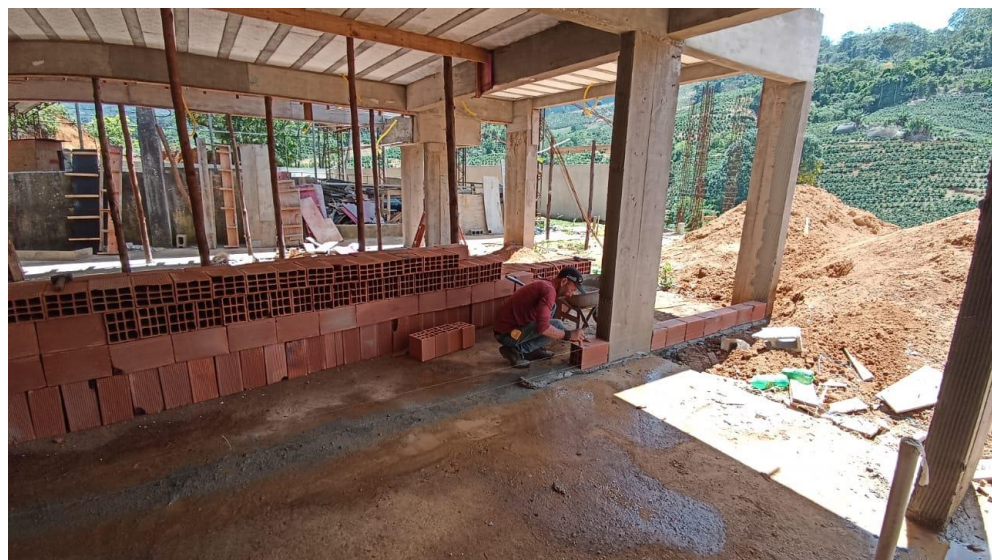
Figura 2 – Detalhe para alvenaria de vedação pavimento térreo
