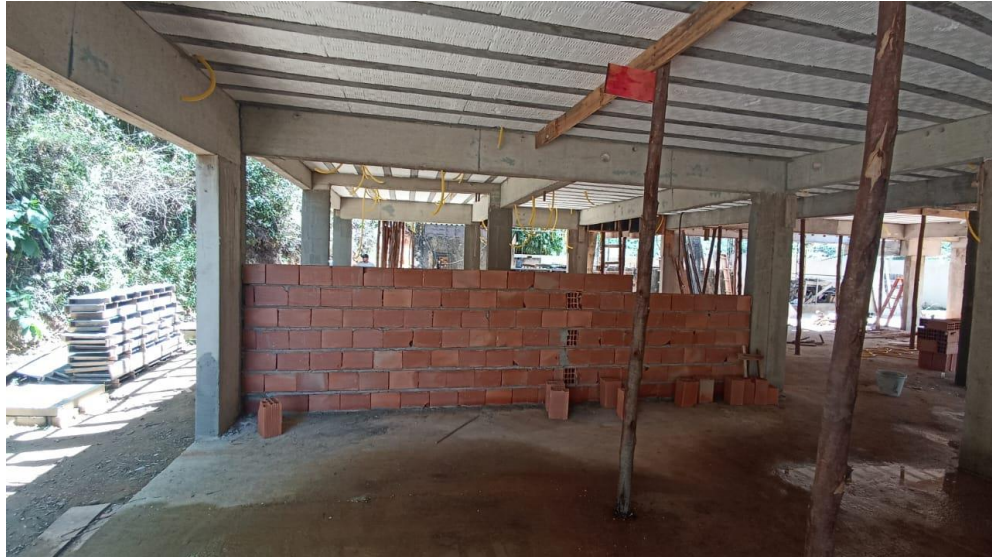
Figura 1 – Detalhe para alvenaria de vedação pavimento térreo
