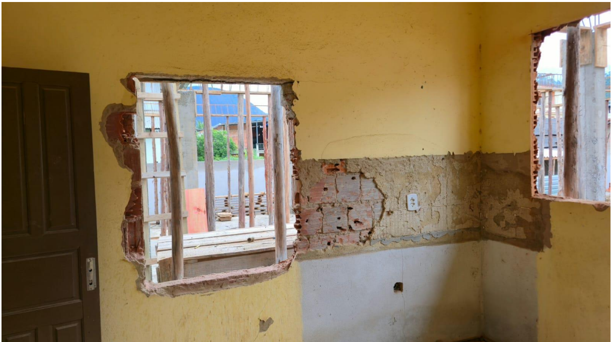
Imagem 03: Detalhe para a remoção da janela.
