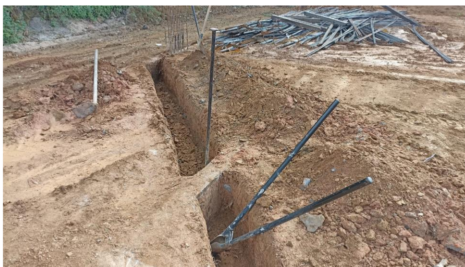
Figura 10 – Detalhe para escavação para passagem das tubulações hidrossanitárias
