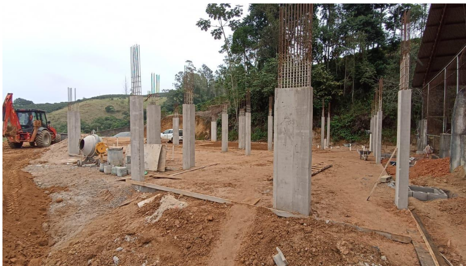
Figura 7 - Detalhe para pilares concretados da edificação
