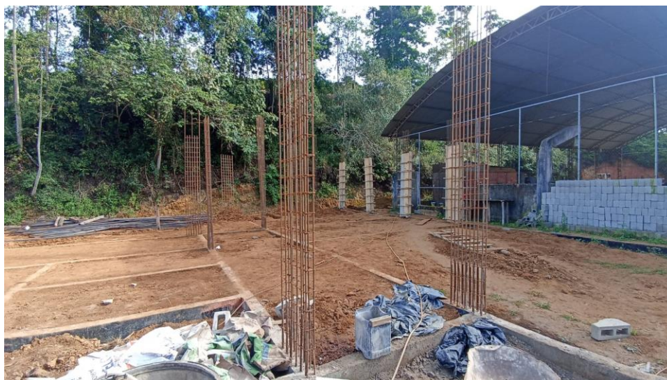
Figura 5- Detalhe para armadura dos pilares da edificação
