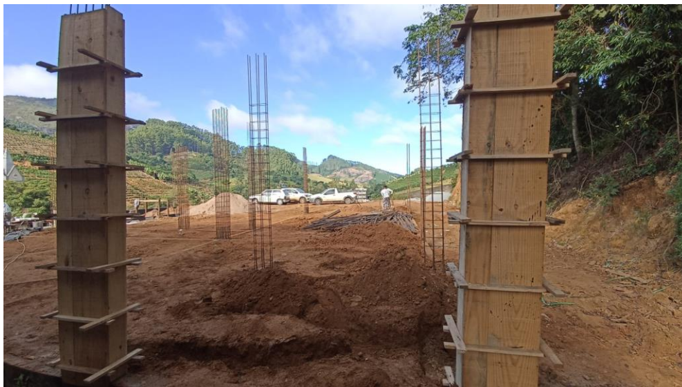
Figura 1 – Detalhe para armadura e formas dos pilares da edificação
