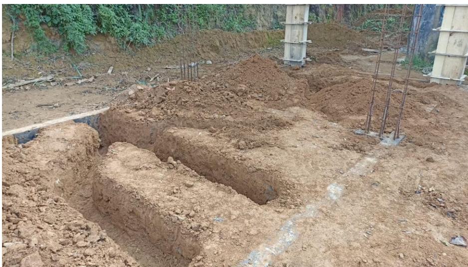
Figura 11 – Detalhe para escavação para passagem das tubulações hidrossanitárias
