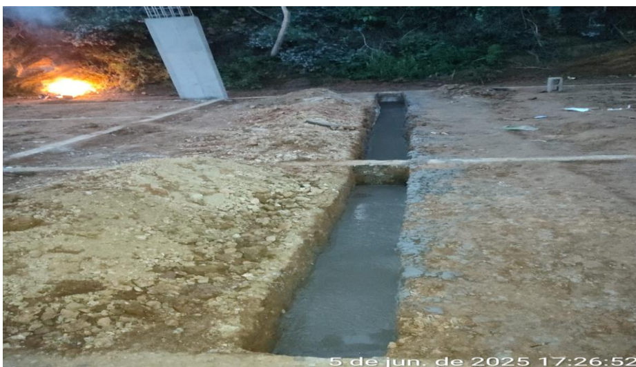
Figura 19 – Detalhe para instalação de gás canalizado (tubulação de gás envelopada)
