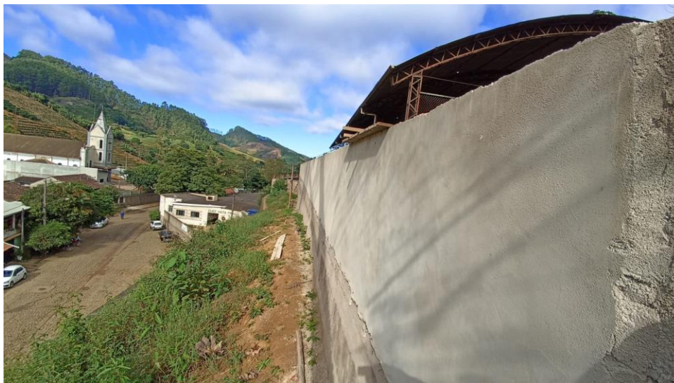
Figura 9 – Detalhe para reboco do muro dos fundos
