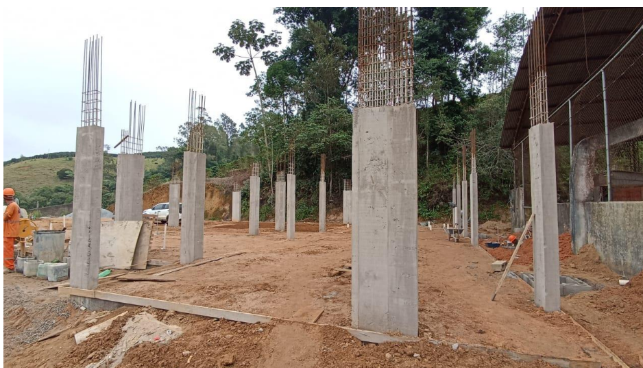
Figura 8 - Detalhe para pilares concretados da edificação
