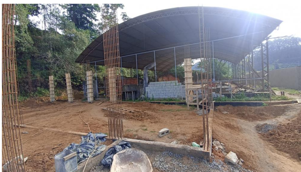
Figura 4- Detalhe para armadura dos pilares da edificação
