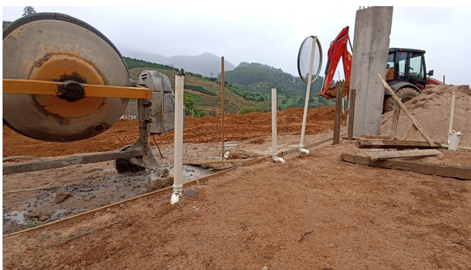
Figura 16 – Detalhe para instalações hidrossanitárias
