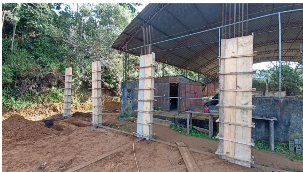
Figura 2 – Detalhe para armadura e formas dos pilares da edificação
