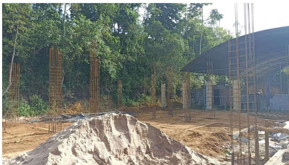
Figura 6 - Detalhe para armadura dos pilares da edificação
