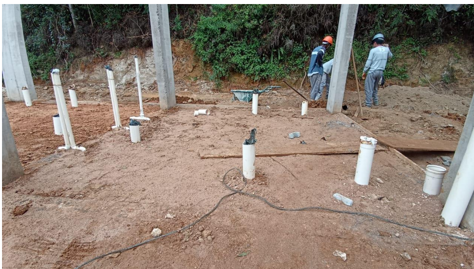
Figura 13 – Detalhe para instalações hidrossanitárias
