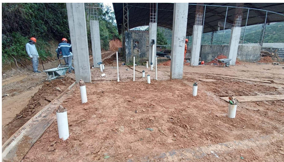
Figura 14 – Detalhe para instalações hidrossanitárias
