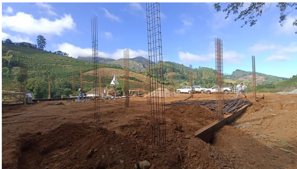
Figura 3 – Detalhe para armadura dos pilares da edificação
