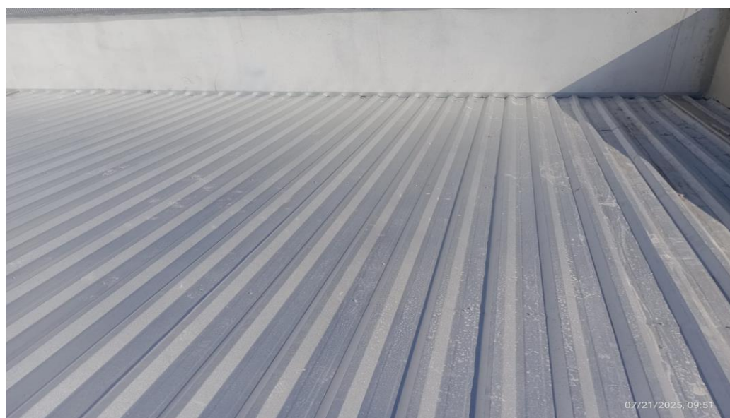
Figura 40 - Detalhe para telhamento em aço
