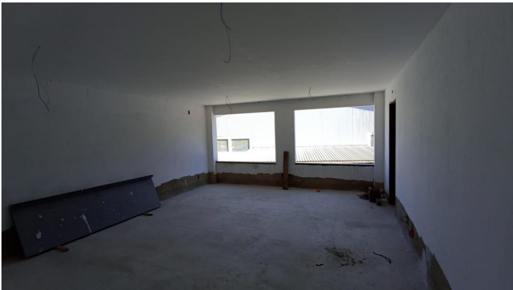
Figura 14 - Detalhe para emassamento das paredes - pavimento superior
