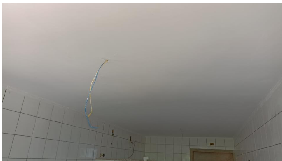
Figura 8 - Detalhe para forro de gesso - pavimento superior
