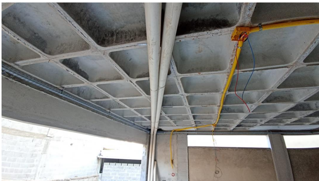
Figura 22 - Detalhe para instalações hidrossanitárias (tubulação)
