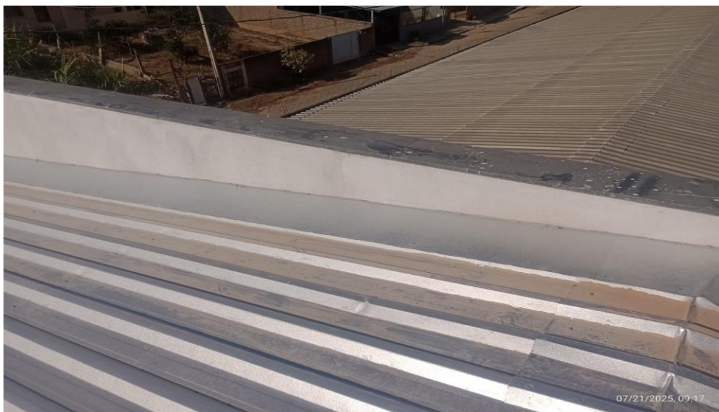
Figura 48 - Detalhe para rufo do telhado
