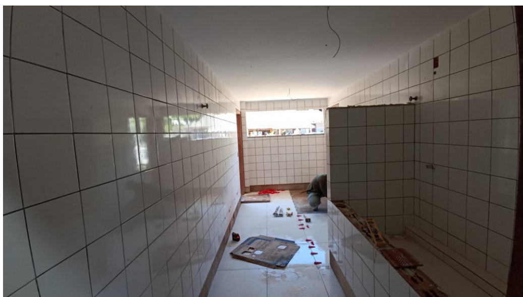
Figura 34 - Detalhe para execução de revestimento cerâmico das paredes – pavimento superior
