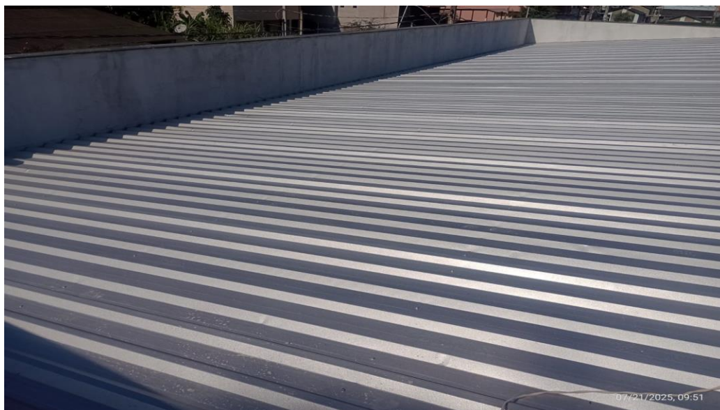
Figura 39 - Detalhe para telhamento em aço
