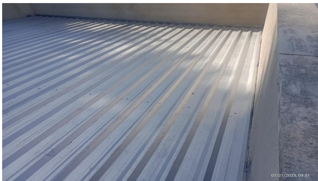
Figura 38 - Detalhe para telhamento em aço
