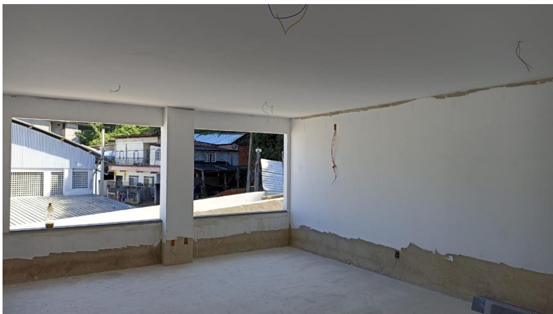
Figura 15 – Detalhe para emassamento das paredes - pavimento superior
