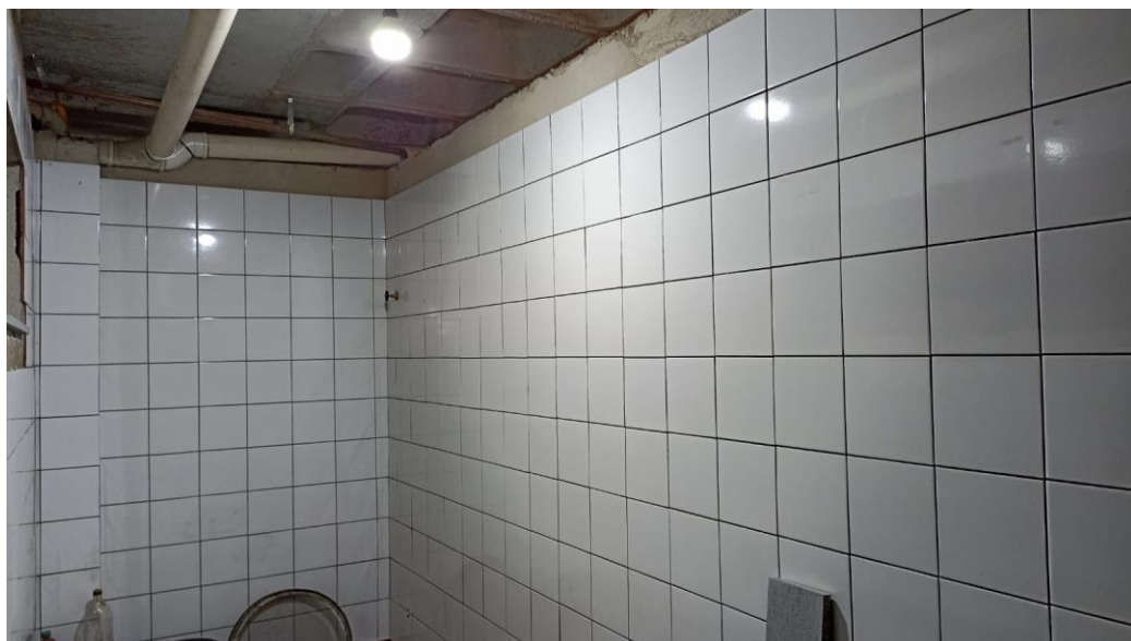
Figura 37 - Detalhe para execução de revestimento cerâmico das paredes – pavimento superior
