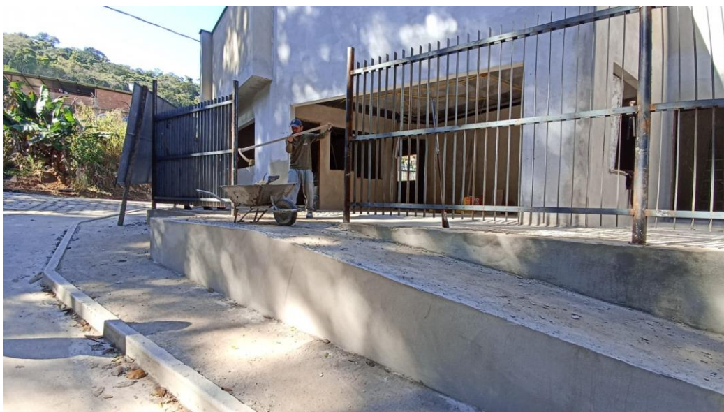
Figura 17 - Detalhe para gradil frente da edificação
