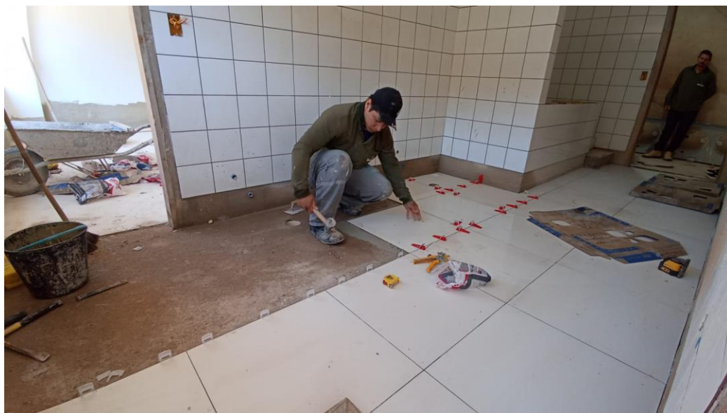
Figura 35 - Detalhe para execução de revestimento cerâmico das paredes e do piso – pavimento superior
