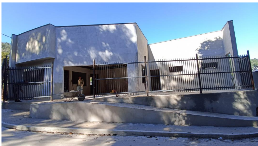
Figura 18 - Detalhe para gradil frente da edificação
