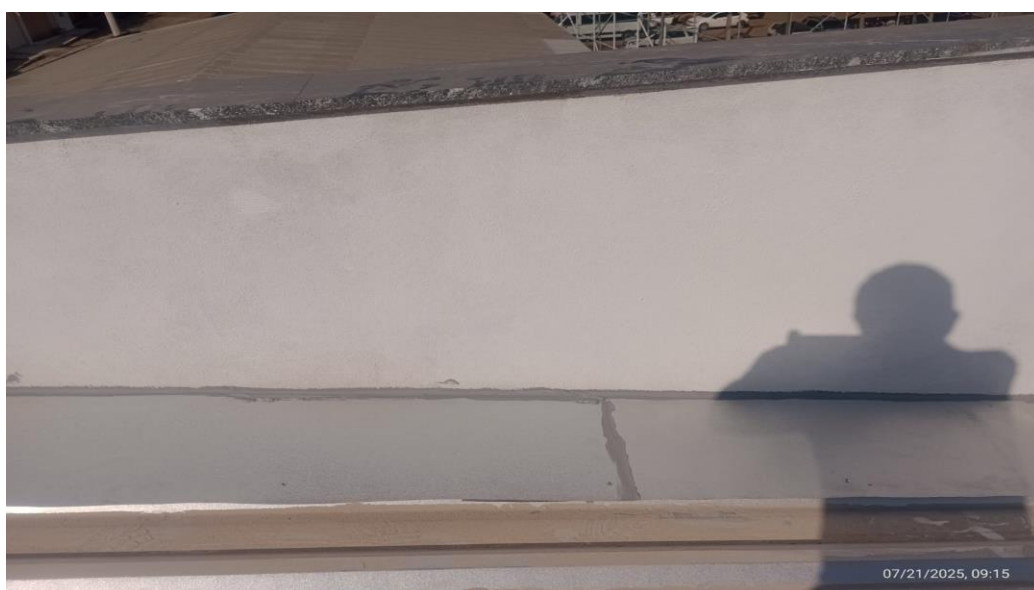
Figura 46 - Detalhe para rufo do telhado
