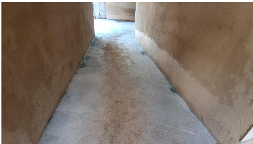
Figura 33 - Detalhe para execução piso em granilite
