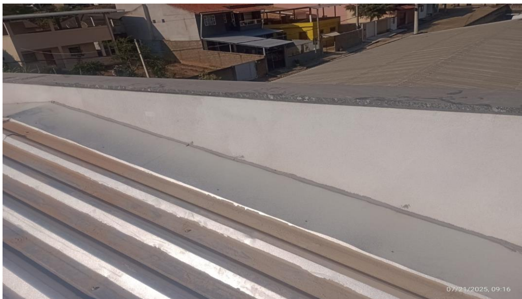
Figura 47 - Detalhe para rufo do telhado
