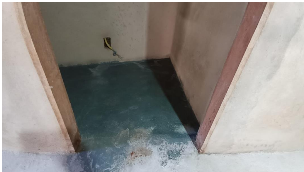
Figura 27 - Detalhe para execução piso em granilite
