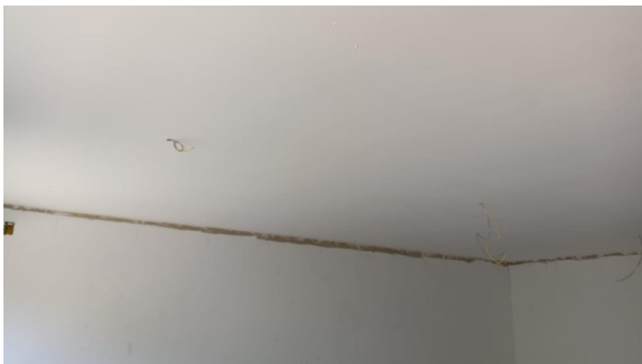
Figura 7 - Detalhe para forro de gesso - pavimento superior
