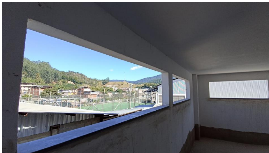
Figura 10 - Detalhe para emassamento das paredes - pavimento superior
