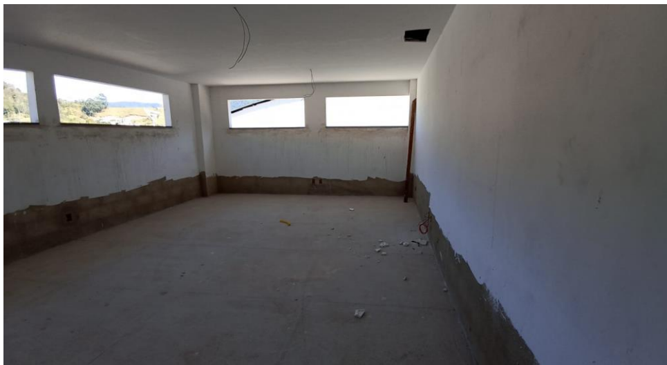
Figura 11 - Detalhe para emassamento das paredes - pavimento superior
