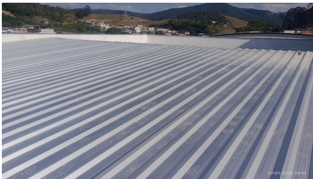
Figura 41 - Detalhe para telhamento em aço
