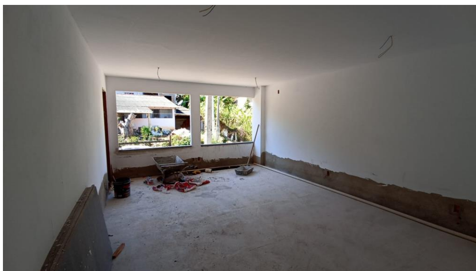
Figura 12 - Detalhe para emassamento das paredes - pavimento superior
