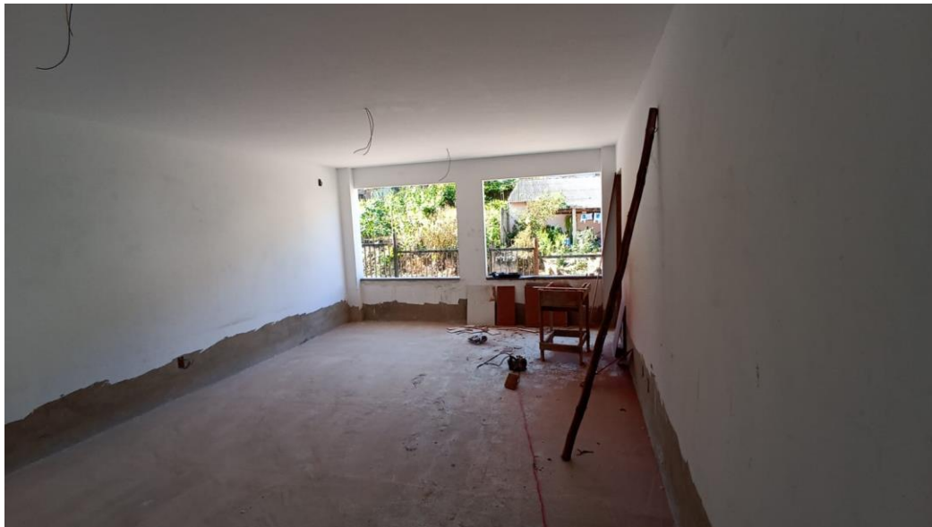
Figura 13 - Detalhe para emassamento das paredes - pavimento superior
