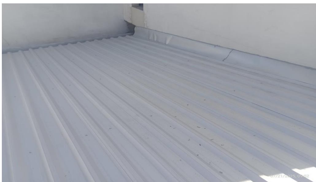
Figura 42 - Detalhe para telhamento em aço, rufo e calha
