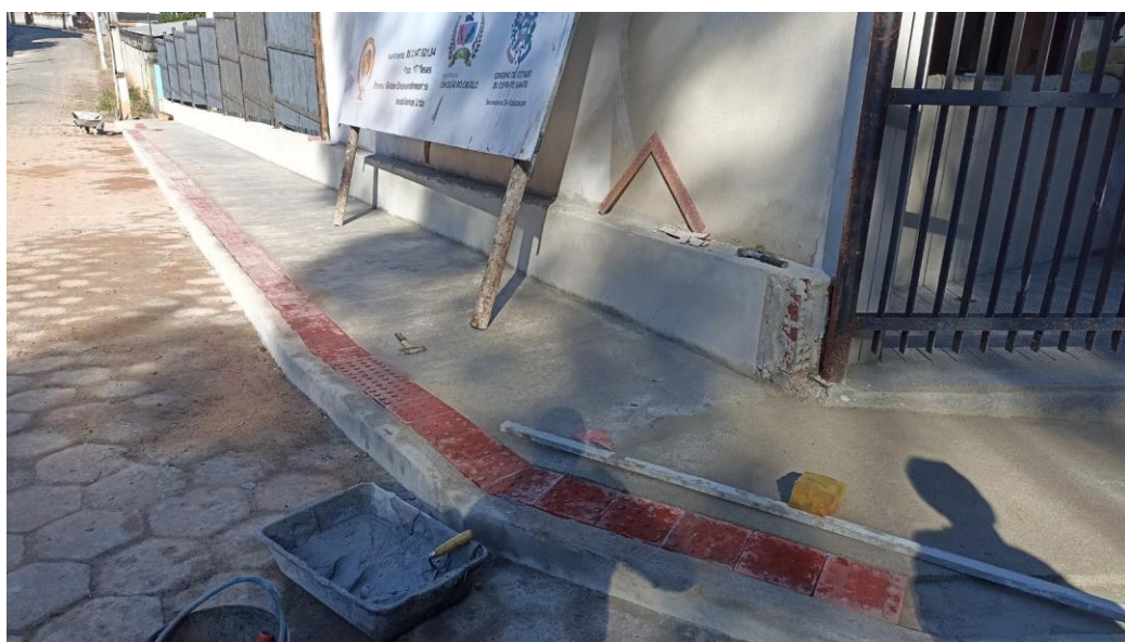
Figura 26 - Detalhe para assentamento dos ladrilhos hidráulicos
