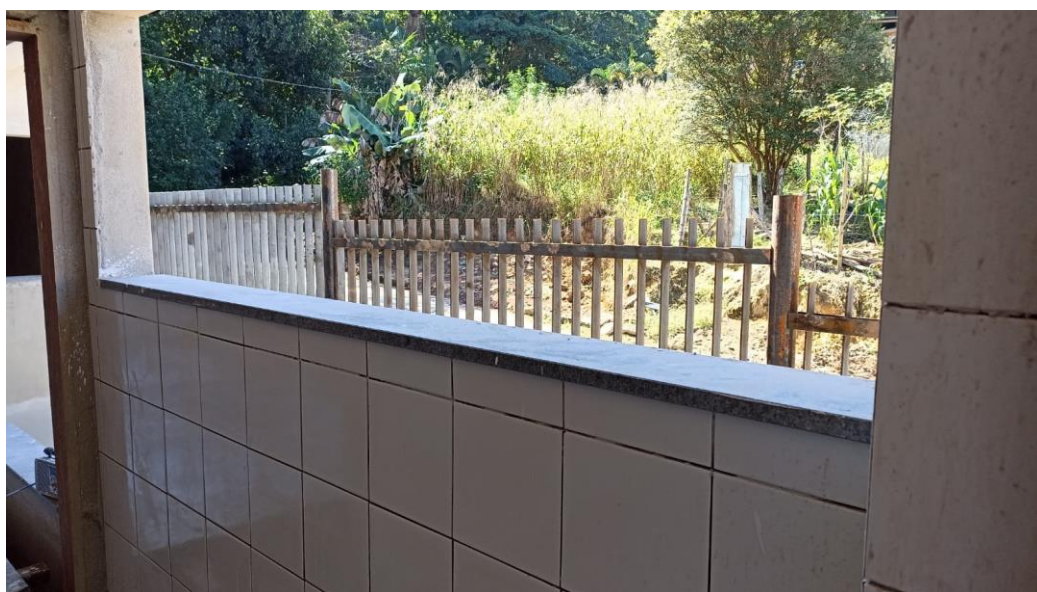
Figura 36 - Detalhe para execução de revestimento cerâmico das paredes – pavimento superior
