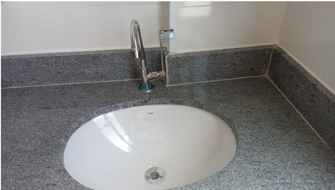
Figura 57 – Detalhe para torneira tipo alavanca do lavatório
