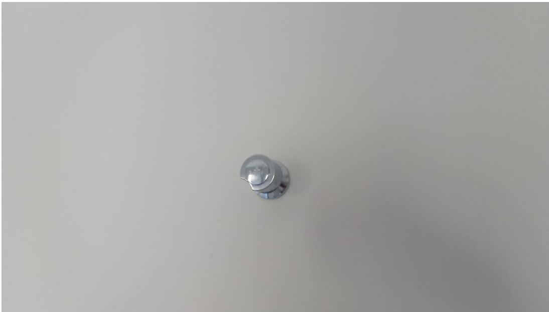
Figura 63 – Detalhe para registro geral dos banheiros
