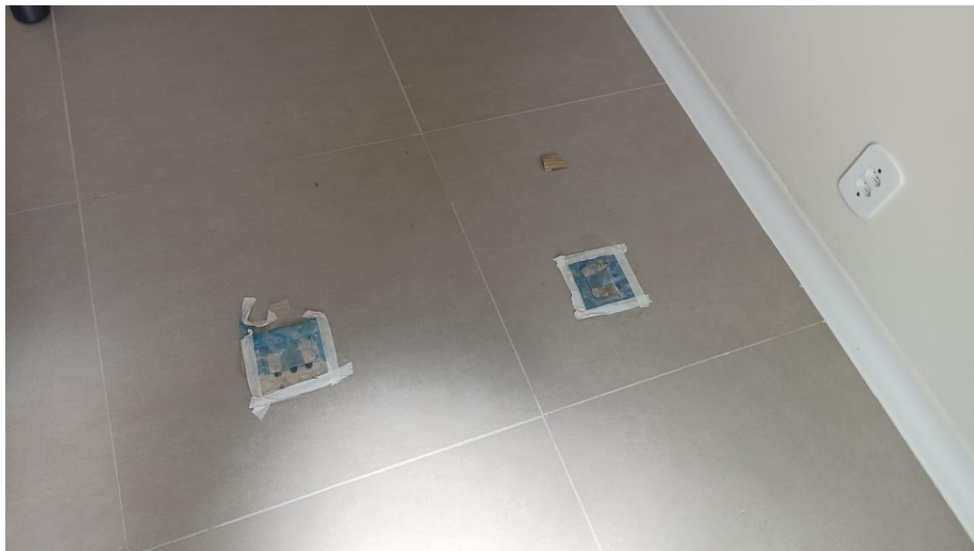
Figura 46 – Detalhe para tomadas do piso e da parede
