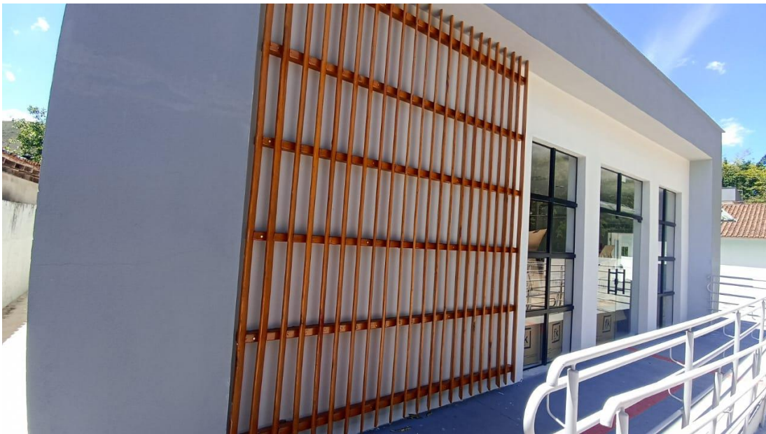
Figura 64 – Detalhe para Brise em madeira pau d' arco da fachada
