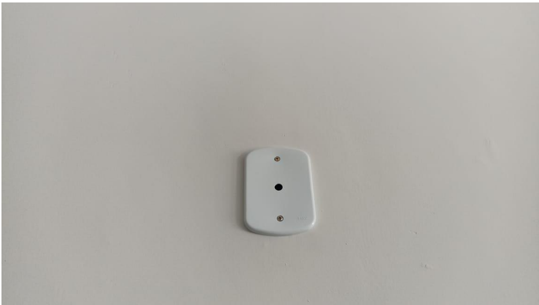
Figura 34 – Detalhe para placa com 1 furo para passagem de cabeamento
