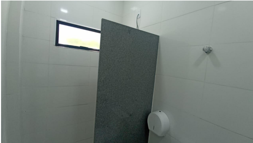
Figura 1 – Detalhe para porta divisória de granito dos banheiros
