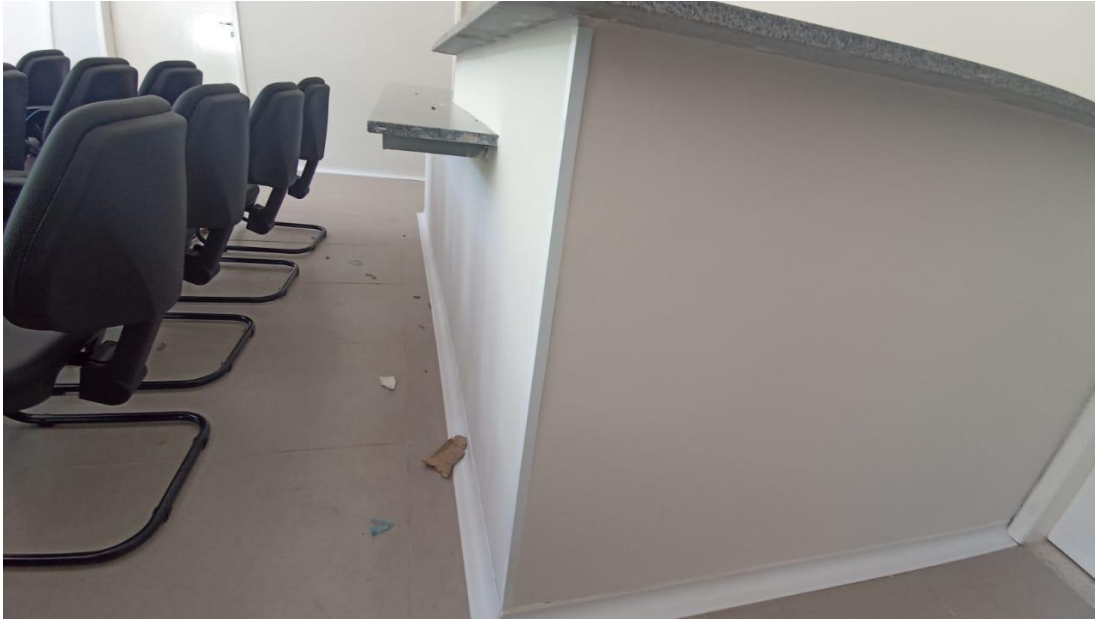
Figura 9 – Detalhe para acabamento de alumínio das paredes
