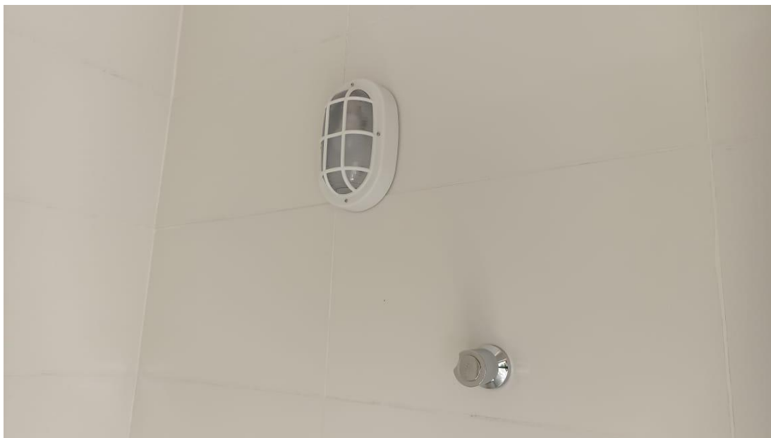
Figura 39 – Detalhe luminária arandela tipo tartaruga
