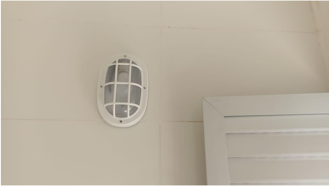
Figura 37 – Detalhe luminária arandela tipo tartaruga
