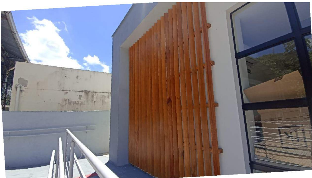
Figura 65 – Detalhe para Brise em madeira pau d' arco da fachada
