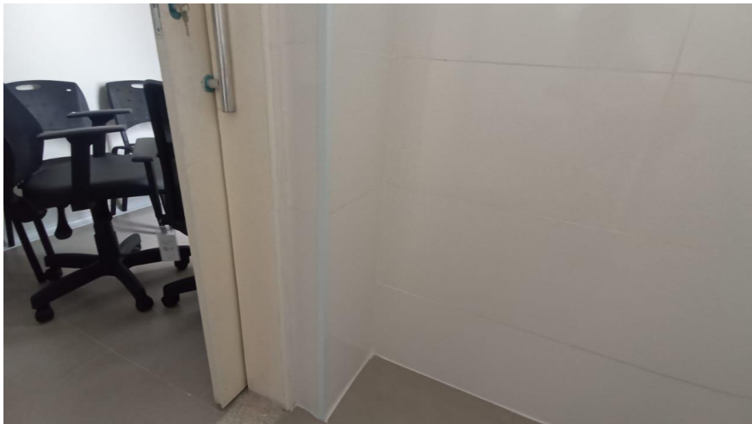
Figura 10 – Detalhe para acabamento de alumínio das paredes
