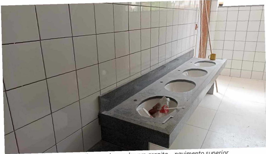
Figura 9 - Detalhe para bancadas em granito – pavimento superior
