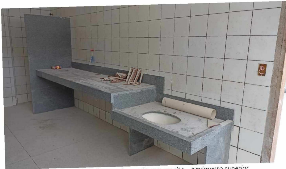
Figura 10 - Detalhe para bancadas em granito – pavimento superior
