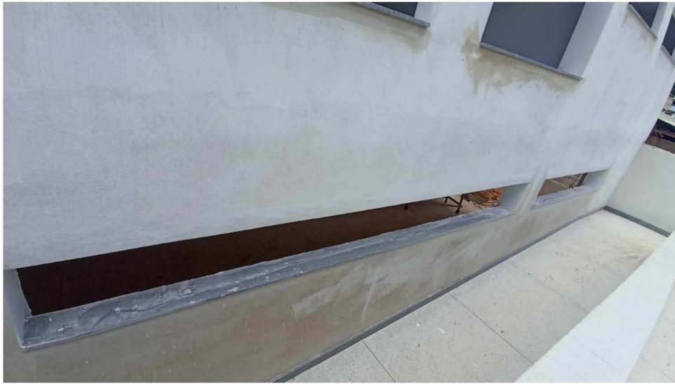
Figura 3 – Detalhe para soleiras das janelas – pavimento térreo
