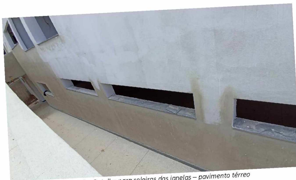
Figura 1 – Detalhe para soleiras das janelas – pavimento térreo
