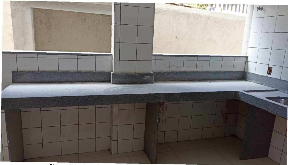
Figura 12 - Detalhe para bancadas em granito – pavimento térreo
