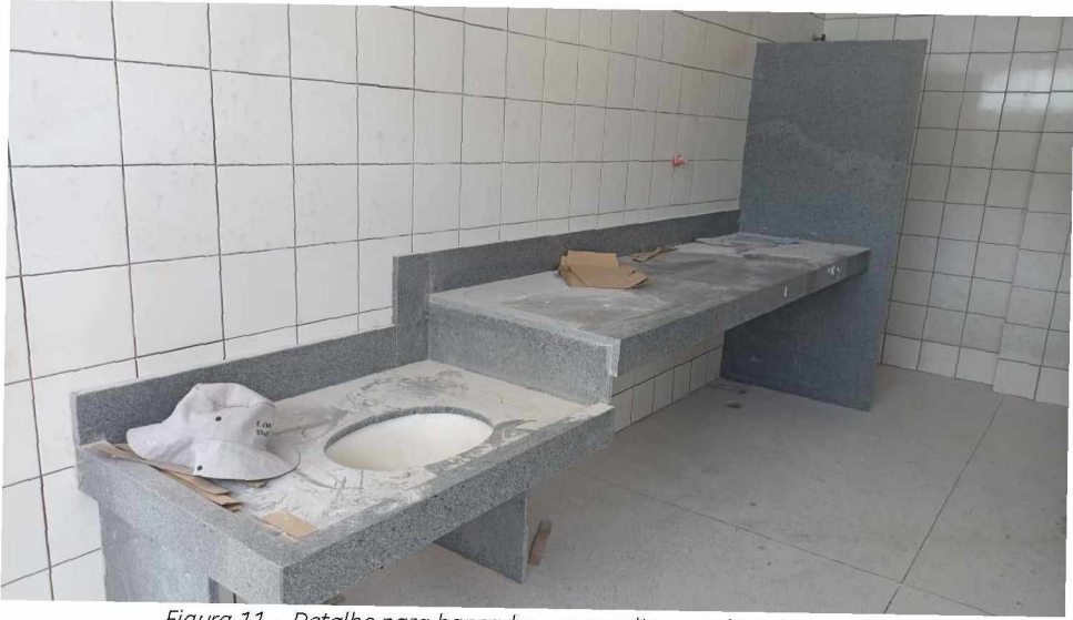
Figura 11 - Detalhe para bancadas em granito – pavimento superior
