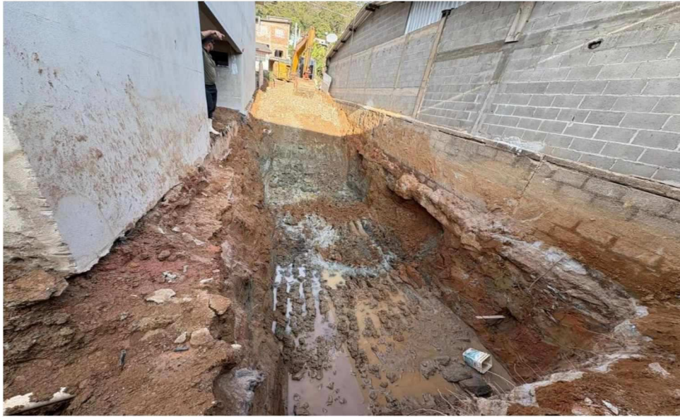
Figura 13 - Detalhe para escavação para execução tanque séptico e filtro anaeróbio
