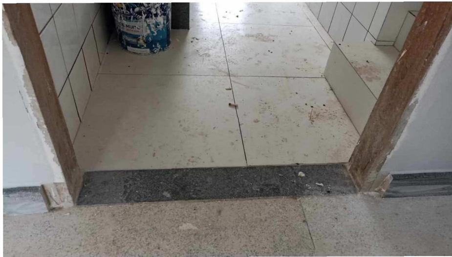
Figura 8 - Detalhe para soleiras das portas – pavimento superior
