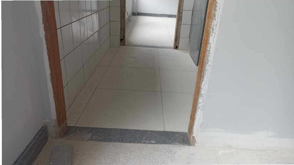
Figura 7 - Detalhe para soleiras das portas – pavimento superior
