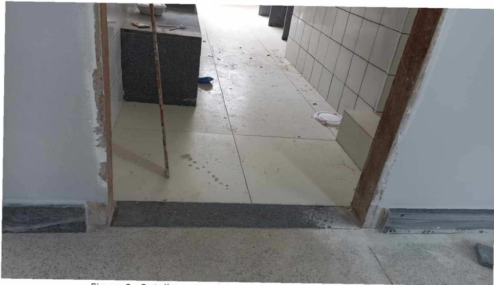
Figura 6 - Detalhe para soleiras das portas – pavimento superior
