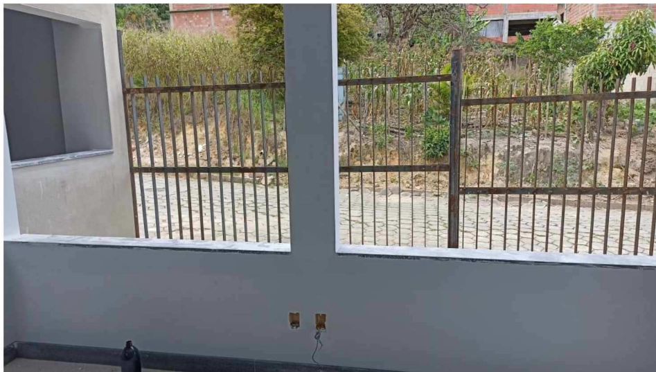
Figura 4 – Detalhe para soleiras das janelas – pavimento superior
