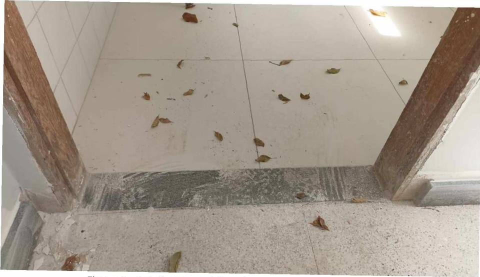
Figura 5 - Detalhe para soleiras das portas – pavimento superior
