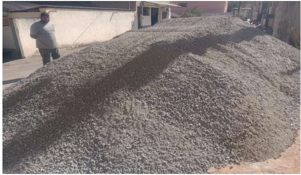
Base de brita graduada, inclusive fornecimento e transporte da brita
