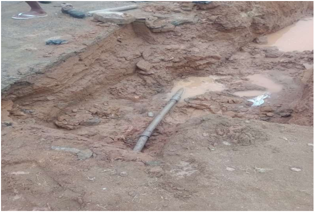
Religação de rede de água em PVC DN 25 mm, inclusive conexões, em Vias Urbanas
