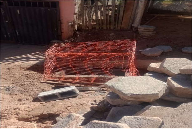
ISOLAMENTO DE OBRA COM TELA PLÁSTICA COM MALHA DE 5MM E ESTRUTURA DE MADEIRA PONTALETEADA
