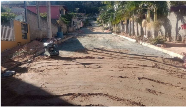
REGULARIZAÇÃO E COMPACTAÇÃO DE SUBLEITO DE SOLO PREDOMINANTEMENTE ARENOSO. AF_11/2019
