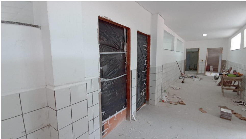
Figura 6 - Detalhe para emassamento das paredes
