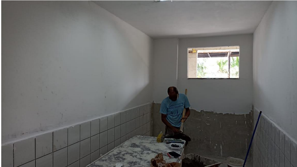
Figura 7 - Detalhe para emassamento das paredes
