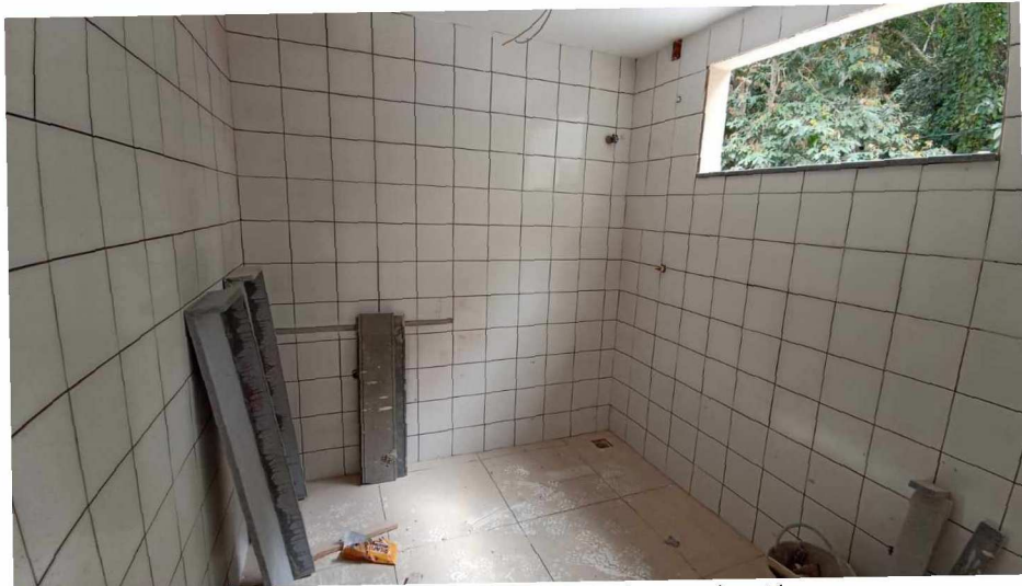
Figura 10 - Detalhe para revestimento das paredes - térreo
