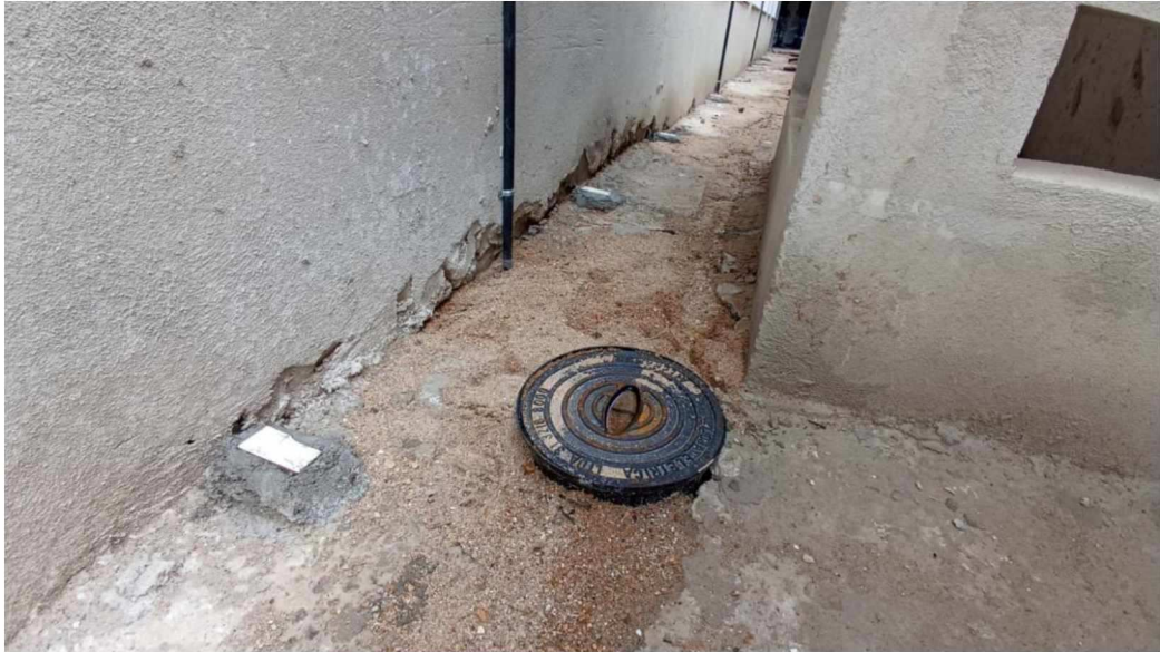
Figura 29 - Detalhe para execução de sistema spda (caixas de inspeção) – térreo
