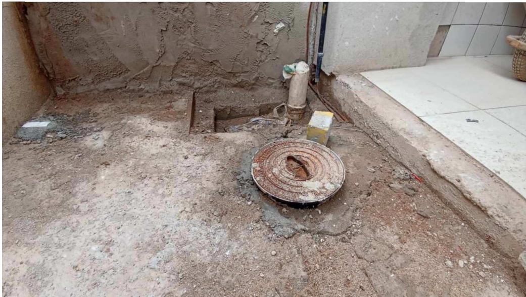
Figura 28 - Detalhe para execução de sistema spda (caixas de inspeção) – térreo
