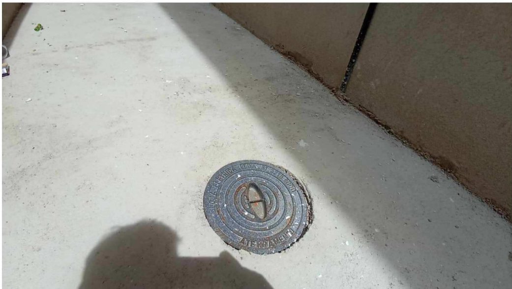
Figura 30 - Detalhe para execução de sistema spda (caixas de inspeção) – térreo
