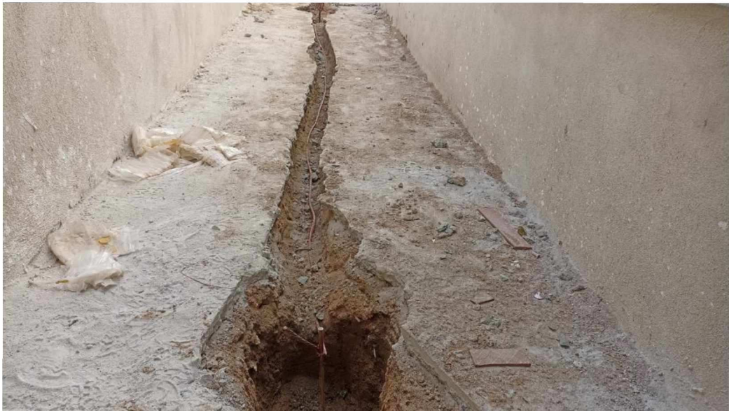
Figura 24 - Detalhe para execução de sistema spda (cabos e hastes) – térreo
