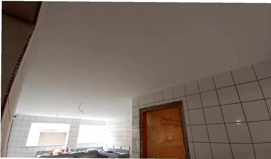
Figura 12 - Detalhe para revestimento das paredes - térreo
