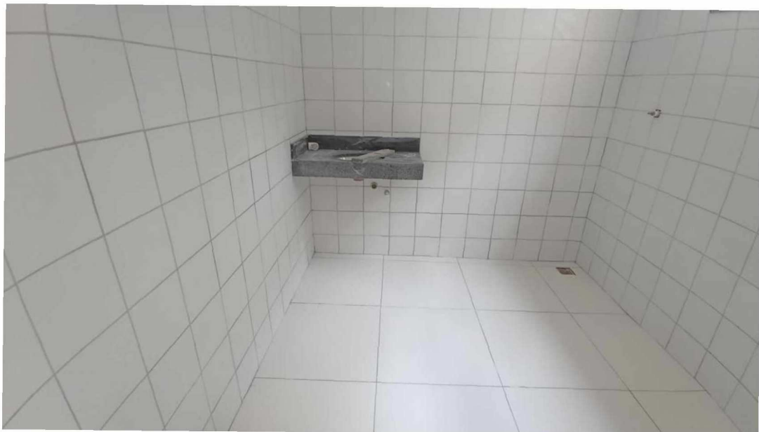
Figura 16 - Detalhe para revestimento das paredes – pavimento superior
