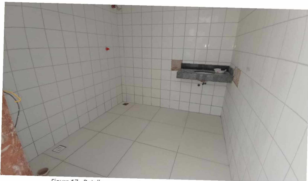
Figura 17 - Detalhe para revestimento das paredes – pavimento superior
