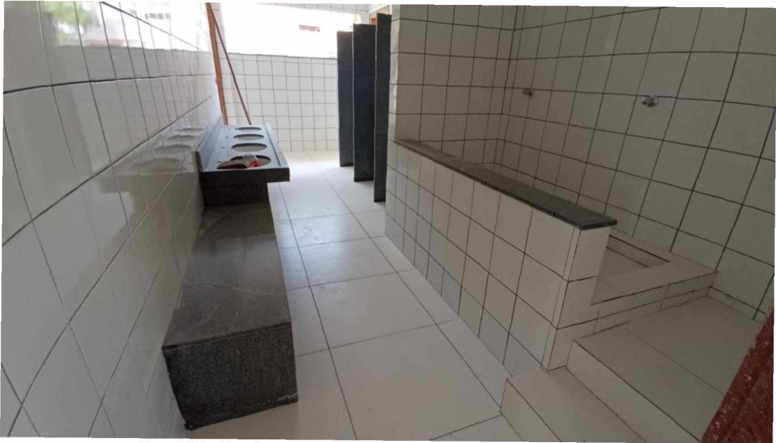
Figura 15 – Detalhe para revestimento das paredes – pavimento superior
