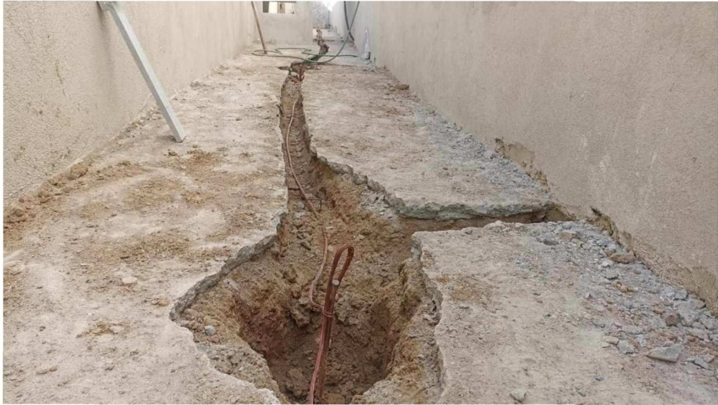
Figura 23 - Detalhe para execução de sistema spda (cabos e hastes) – térreo
