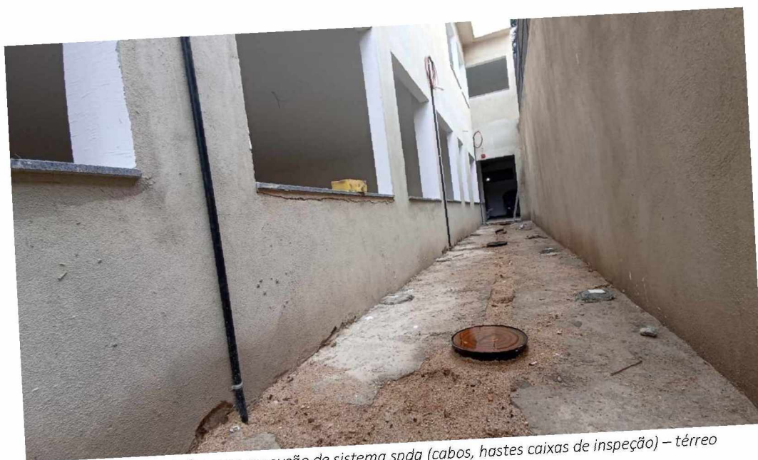
Figura 25 - Detalhe para execução de sistema spda (cabos e hastes) – térreo
