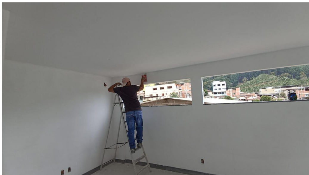
Figura 31 - Detalhe para emassamento das paredes – pavimento superior
