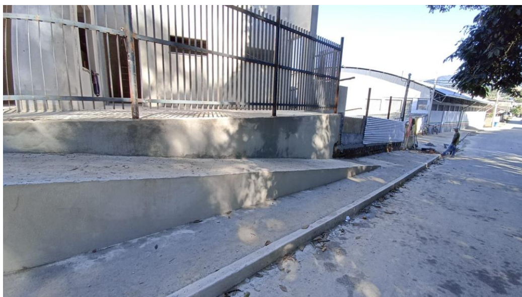
Figura 30 - Detalhe para mureta em alvenaria – pavimento superior
