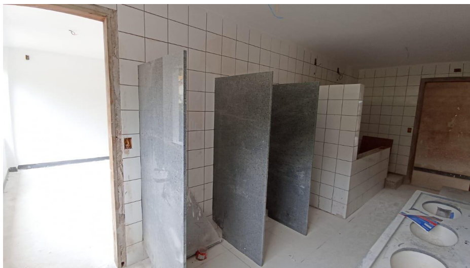
Figura 2 – Detalhe para divisórias dos banheiros instaladas – pavimento superior
