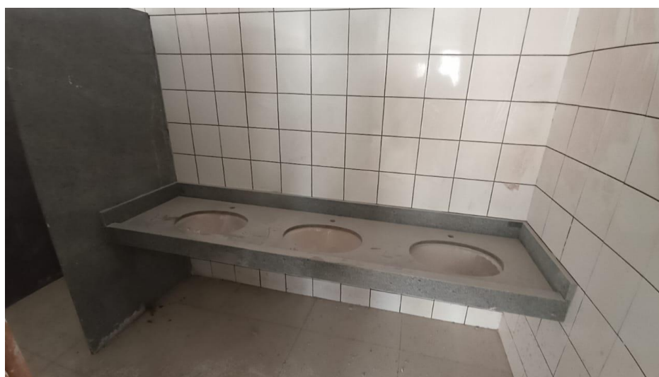
Figura 8 - Detalhe para bancadas e cubas de embutir ovais – pavimento superior
