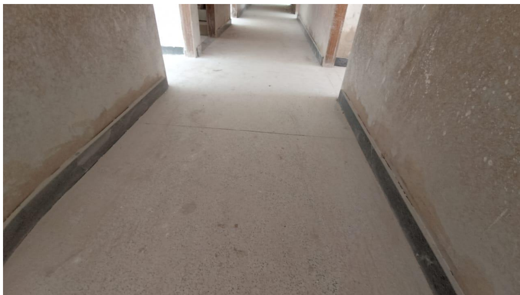
Figura 19 - Detalhe para piso em granilite e rodapés – pavimento superior
