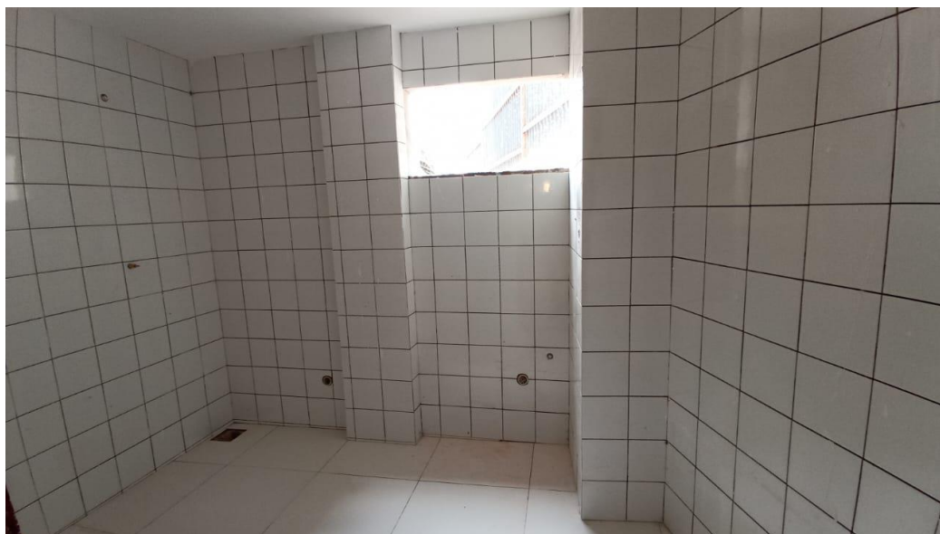
Figura 27 - Detalhe para revestimento cerâmicos das paredes e do piso – pavimento superior
