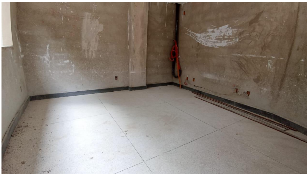
Figura 43 – Detalhe para piso rodapés – pavimento superior
