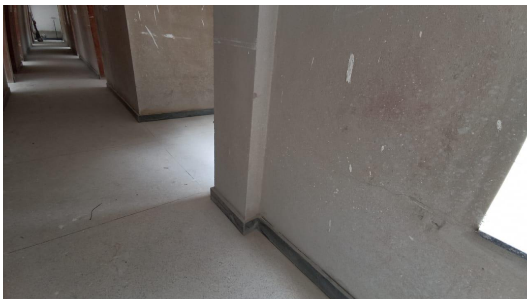
Figura 20 - Detalhe para piso em granilite e rodapés – pavimento superior
