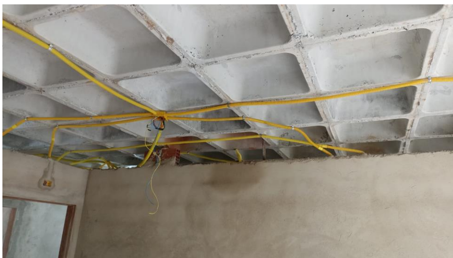
Figura 11 - Detalhe para cabos elétricos passados pelos tubos corrugados - térreo e pavimento superior
