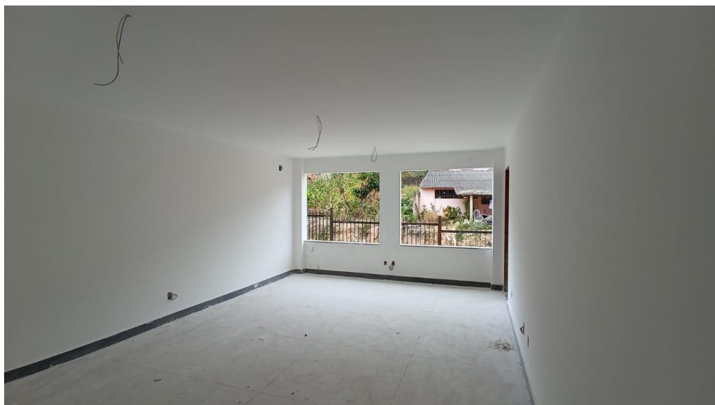
Figura 33 - Detalhe para emassamento das paredes – pavimento superior
