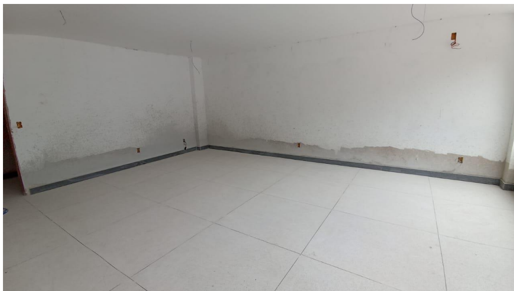
Figura 35 - Detalhe para emassamento das paredes – pavimento superior
