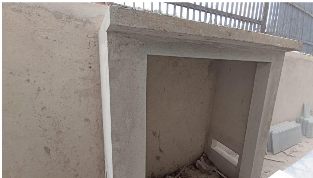
Figura 17 - Detalhe para execução abrigo de gás - térreo
