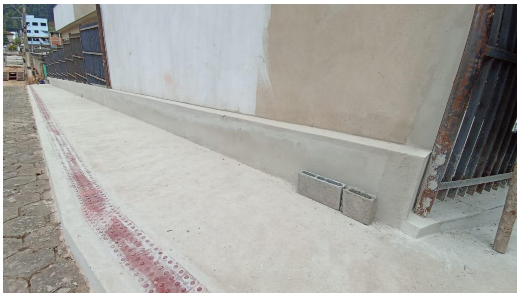
Figura 29 - Detalhe para mureta em alvenaria – pavimento superior
