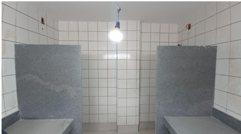
Figura 1 – Detalhe para divisórias dos banheiros instaladas – pavimento superior
