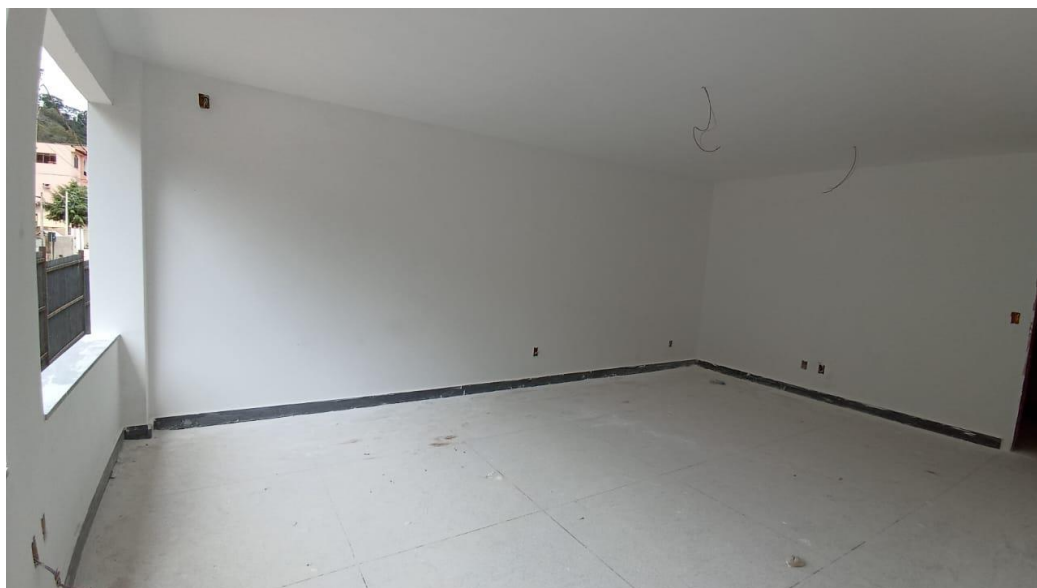
Figura 37 - Detalhe para emassamento das paredes – pavimento superior
