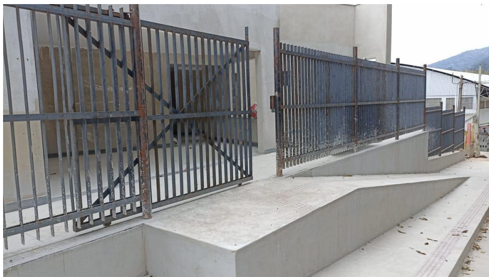
Figura 5 - Detalhe para portão de correr – pavimento superior
