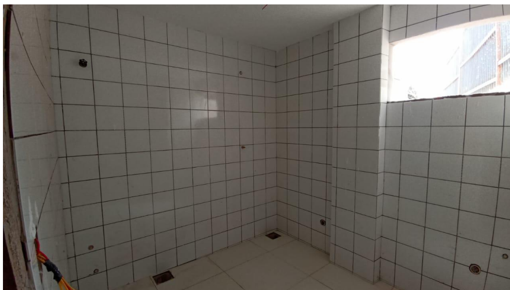
Figura 25 - Detalhe para revestimento cerâmicos das paredes e do piso – pavimento superior
