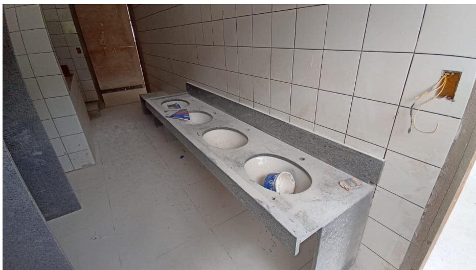
Figura 7 - Detalhe para bancadas e cubas de embutir ovais – pavimento superior
