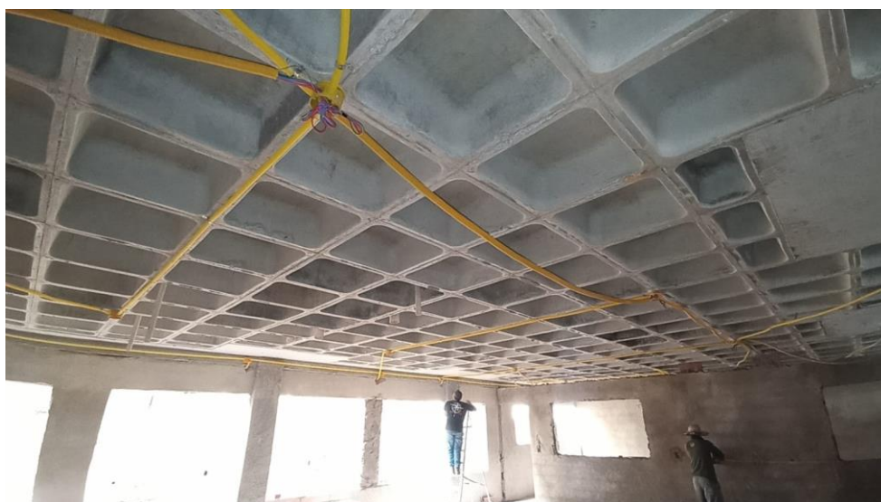
Figura 12 - Detalhe para cabos elétricos passados pelos tubos corrugados - térreo e pavimento superior
