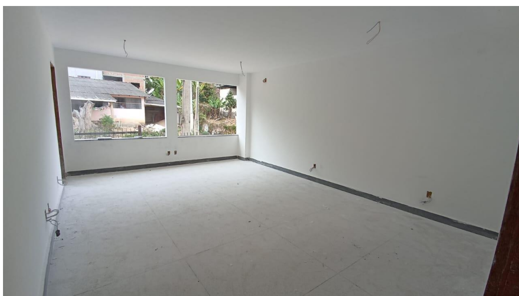
Figura 32 - Detalhe para emassamento das paredes – pavimento superior
