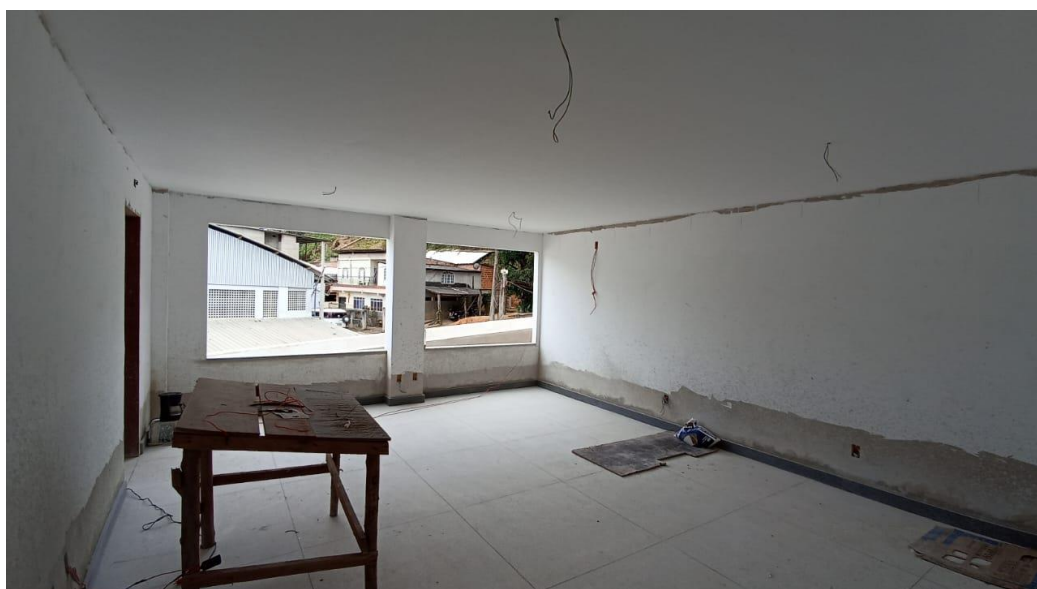
Figura 36 - Detalhe para emassamento das paredes – pavimento superior
