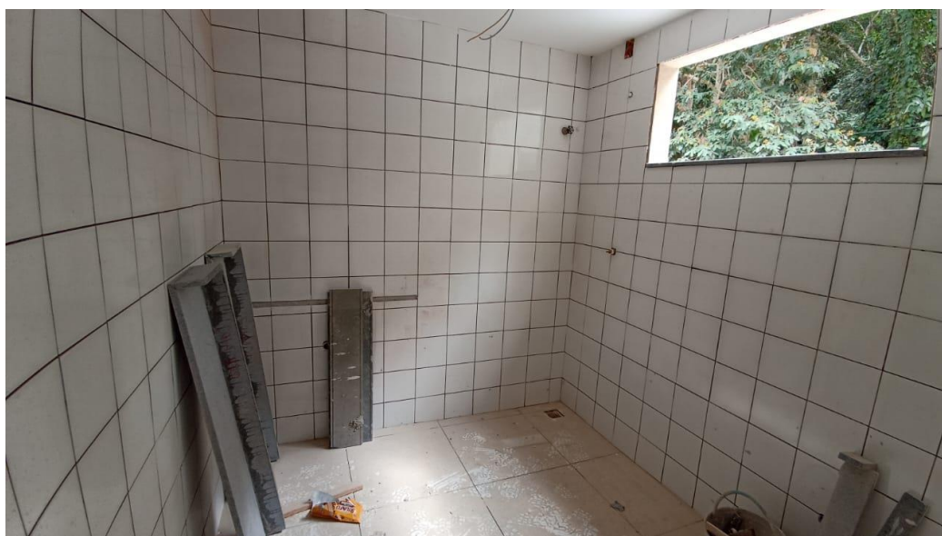
Figura 24 - Detalhe para revestimento cerâmicos das paredes e do piso – pavimento superior
