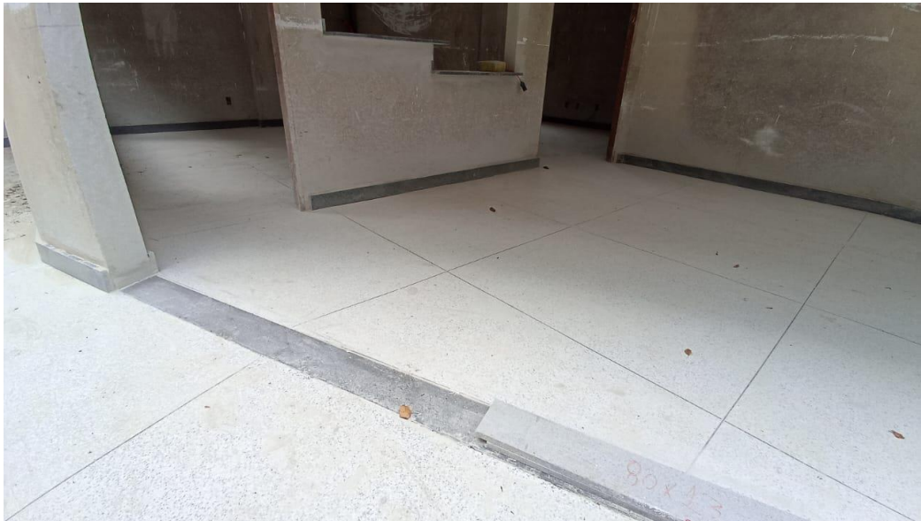
Figura 21 - Detalhe para piso em granilite e rodapés – pavimento superior
