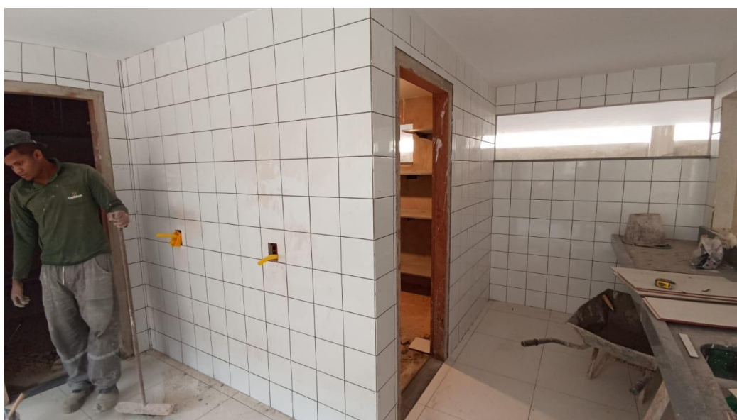
Figura 26 - Detalhe para revestimento cerâmicos das paredes e do piso – térreo
