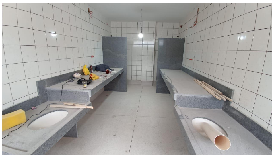
Figura 6 - Detalhe para bancadas e cubas de embutir ovais – pavimento superior
