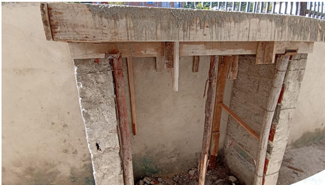
Figura 15 – Detalhe para execução abrigo de gás - térreo
