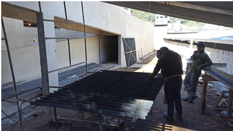
Figura 4 – Detalhe para execução dos portões – térreo
