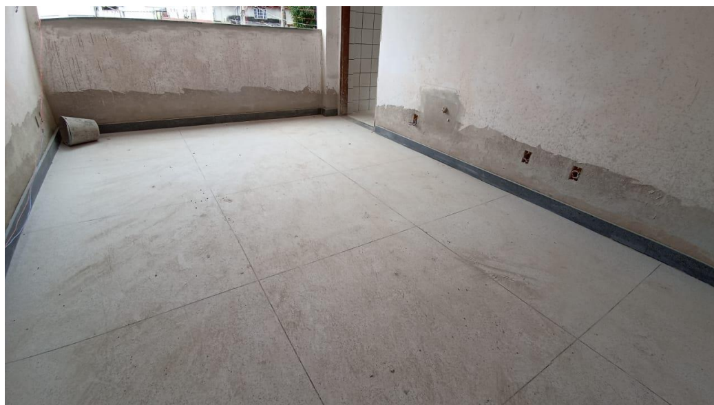
Figura 18 - Detalhe para piso em granilite e rodapés – pavimento superior
