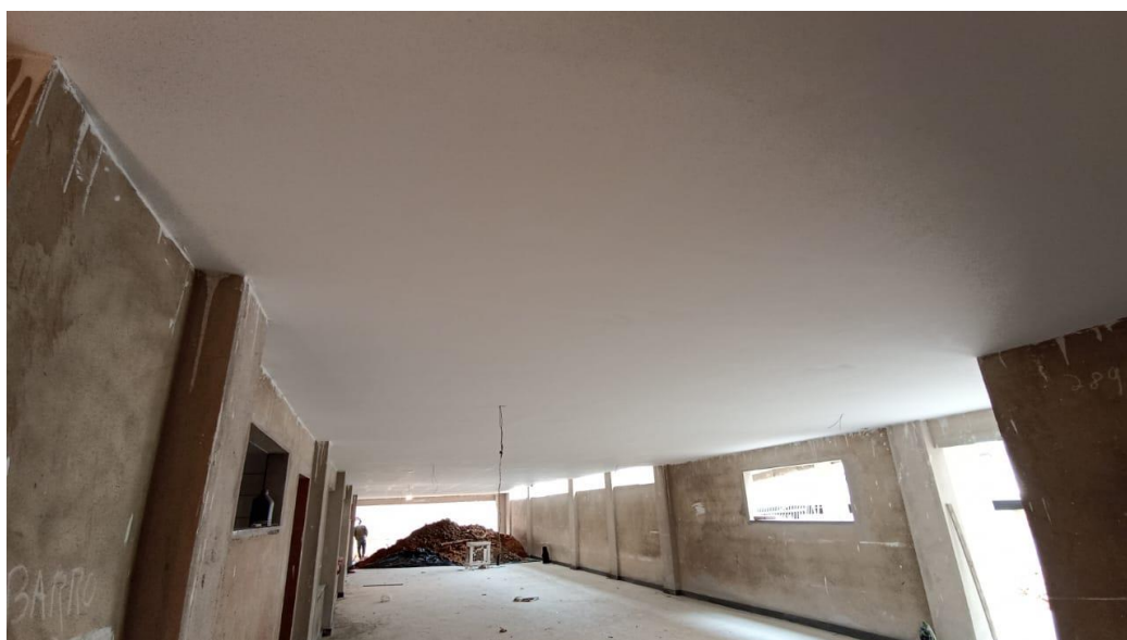
Figura 38 - Detalhe para forro de gesso emassado - térreo
