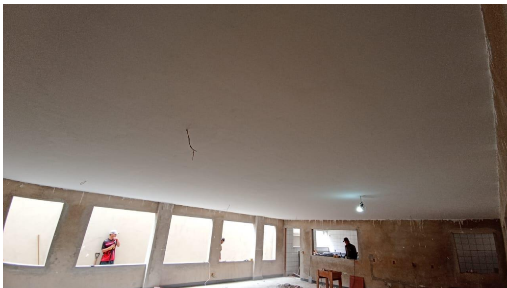
Figura 41 - Detalhe para forro de gesso emassado - térreo
