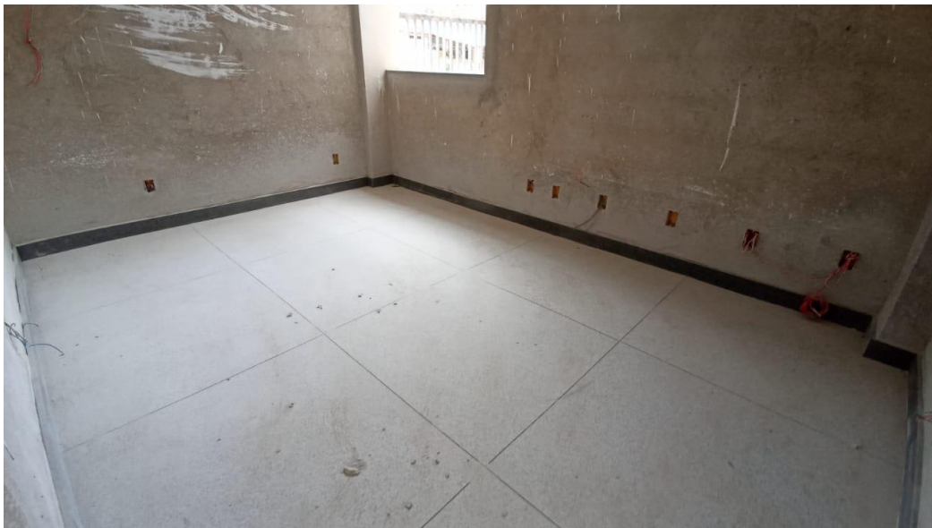
Figura 22 - Detalhe para piso em granilite e rodapés – pavimento superior
