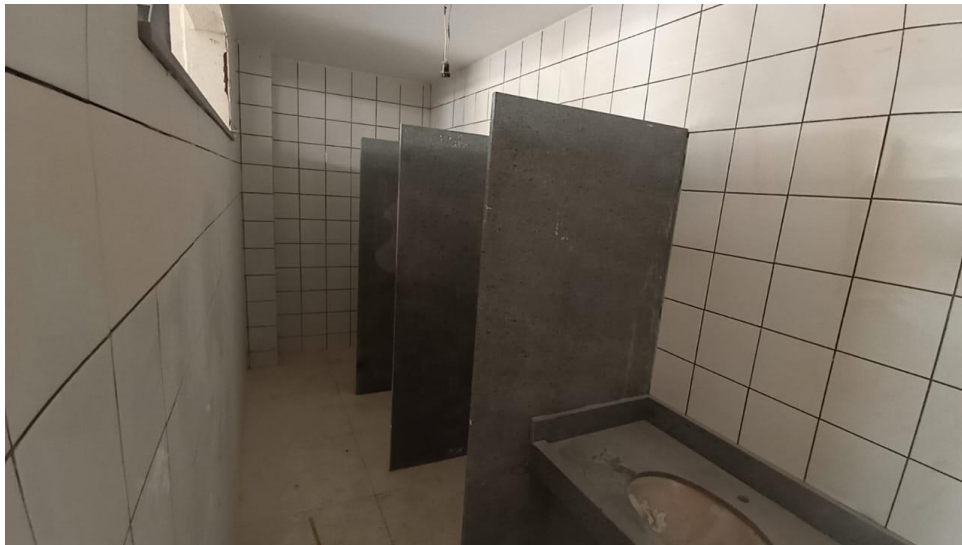
Figura 3 – Detalhe para divisórias dos banheiros instaladas – pavimento superior
