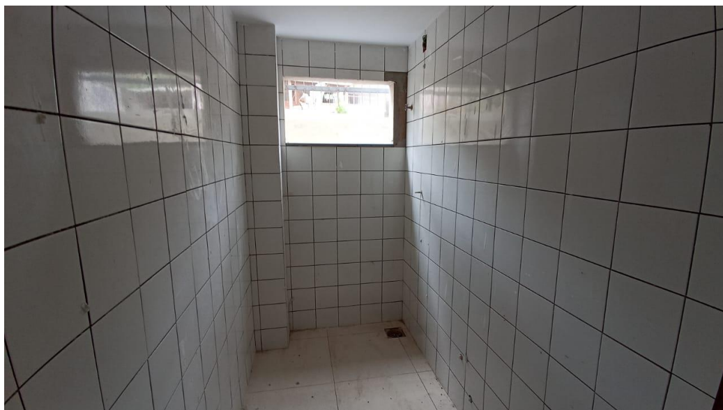
Figura 23 - Detalhe para revestimento cerâmicos das paredes e do piso – pavimento superior
