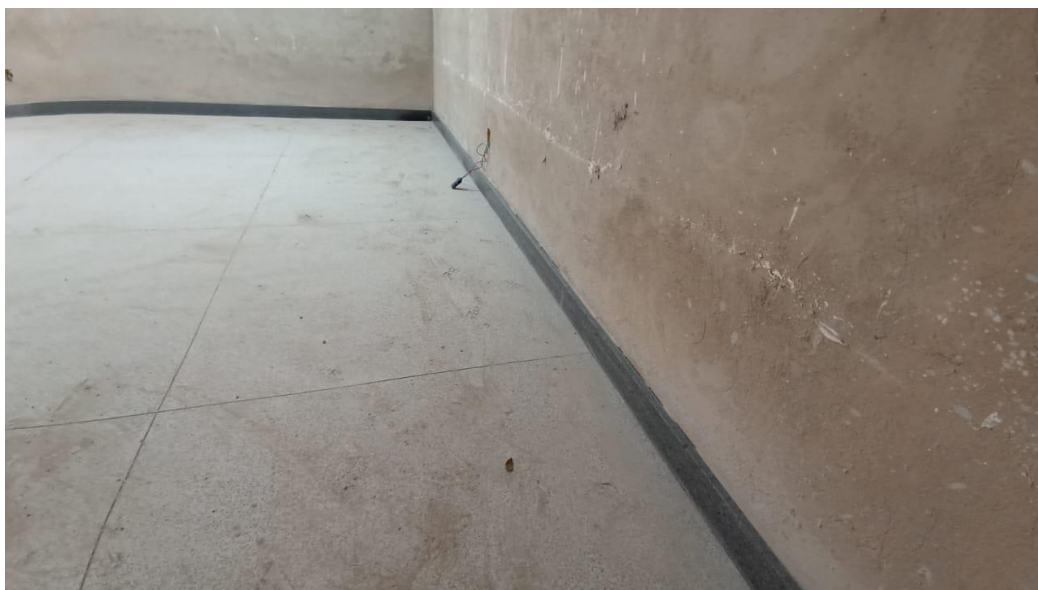
Figura 45 - Detalhe para rodapés - térreo
