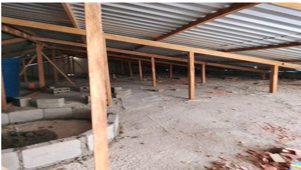
Figura 15 - Detalhe para execução de estrutura de madeira do telhado
