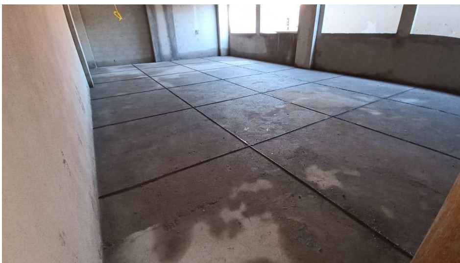
Figura 32 - Detalhe para preparação do contra piso para receber o piso granilite
