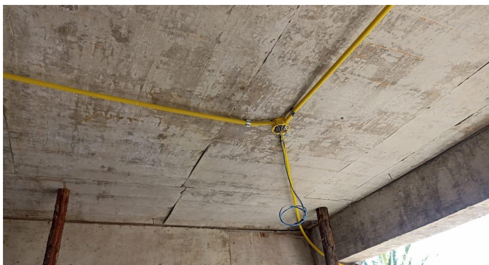
Figura 24 - Detalhe para infraestrutura parte elétrica (passagem dos cabos elétricos pelas tubulações)
