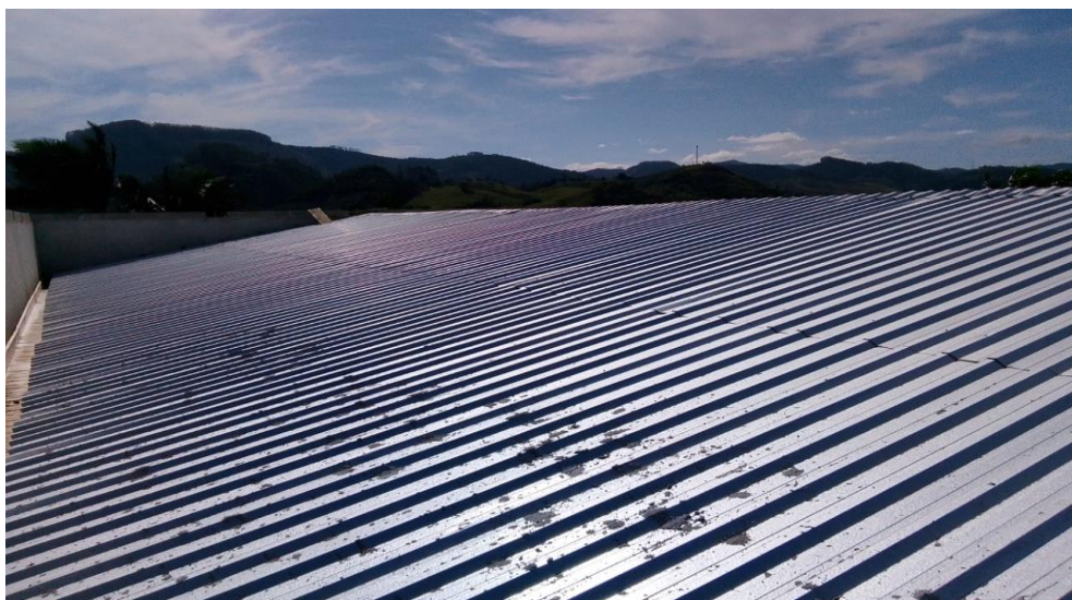
Figura 19 - Detalhe para telhado em telha de aço
