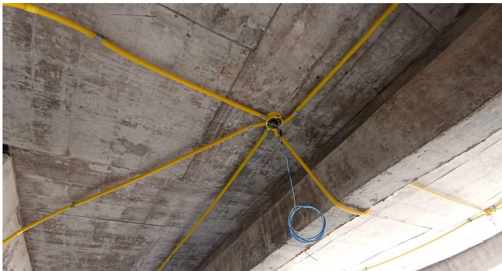
Figura 25 - Detalhe para infraestrutura parte elétrica (passagem dos cabos elétricos pelas tubulações)
