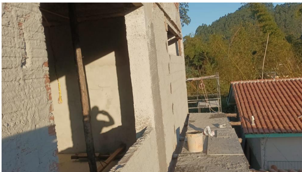
Figura 7 - Detalhe para execução chapisco das fachadas
