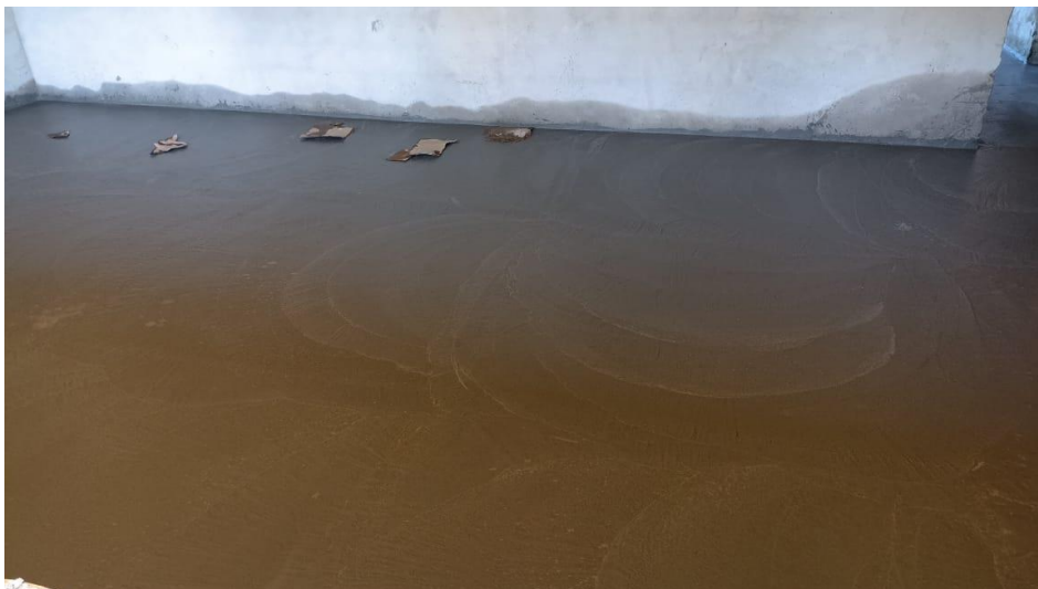
Figura 33 - Detalhe para execução do piso granilite
