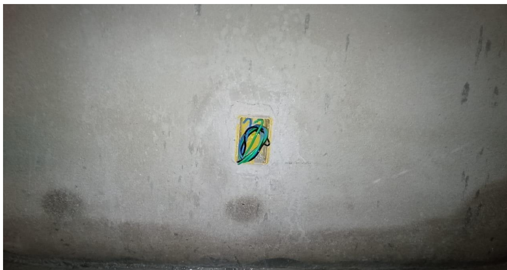
Figura 27 - Detalhe para infraestrutura parte elétrica (passagem dos cabos elétricos pelas tubulações)
