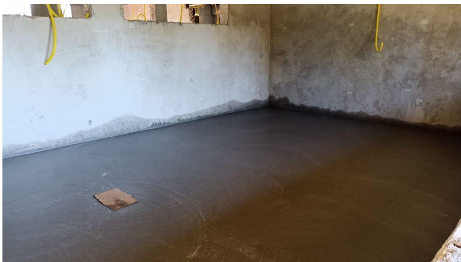
Figura 34 - Detalhe para execução do piso granilite
