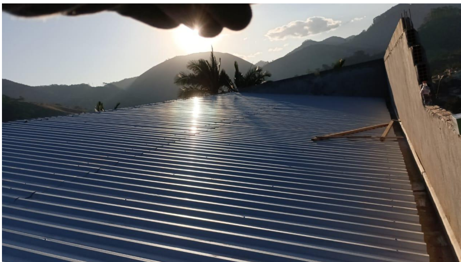
Figura 22 - Detalhe telhado em telha de aço
