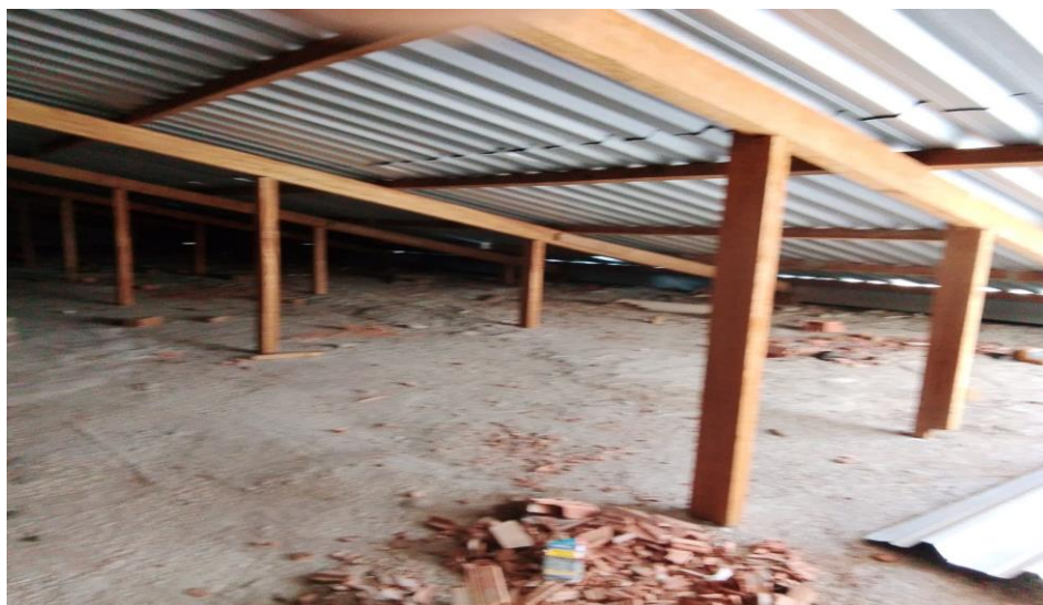
Figura 14 - Detalhe para execução de estrutura de madeira do telhado
