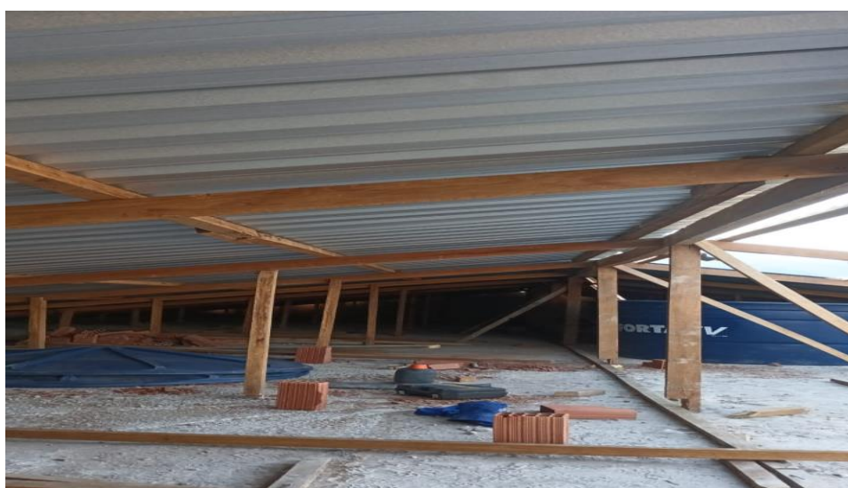
Figura 16 - Detalhe para execução de estrutura de madeira do telhado
