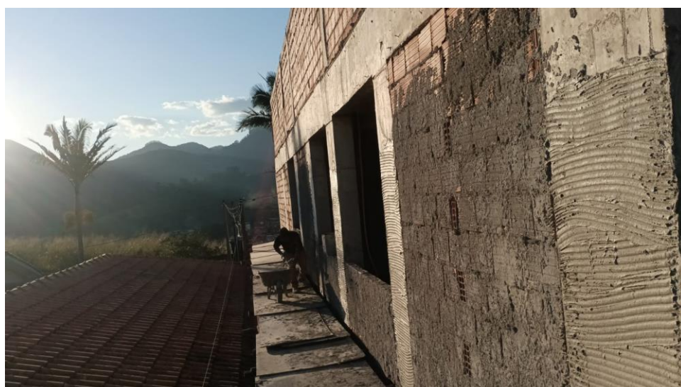
Figura 8 - Detalhe para execução chapisco das fachadas
