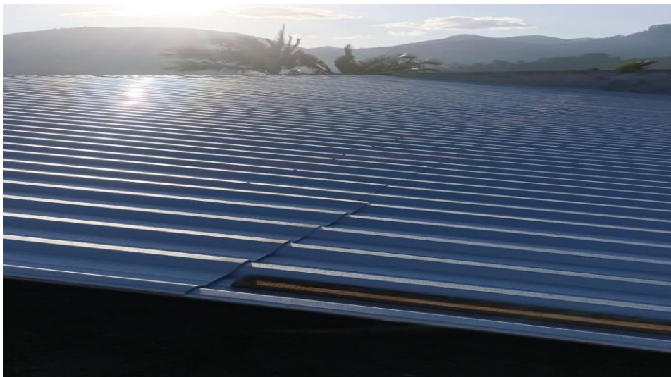
Figura 21 - Detalhe telhado em telha de aço
