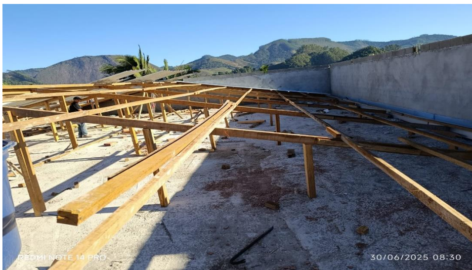
Figura 13 - Detalhe para execução de estrutura de madeira do telhado
