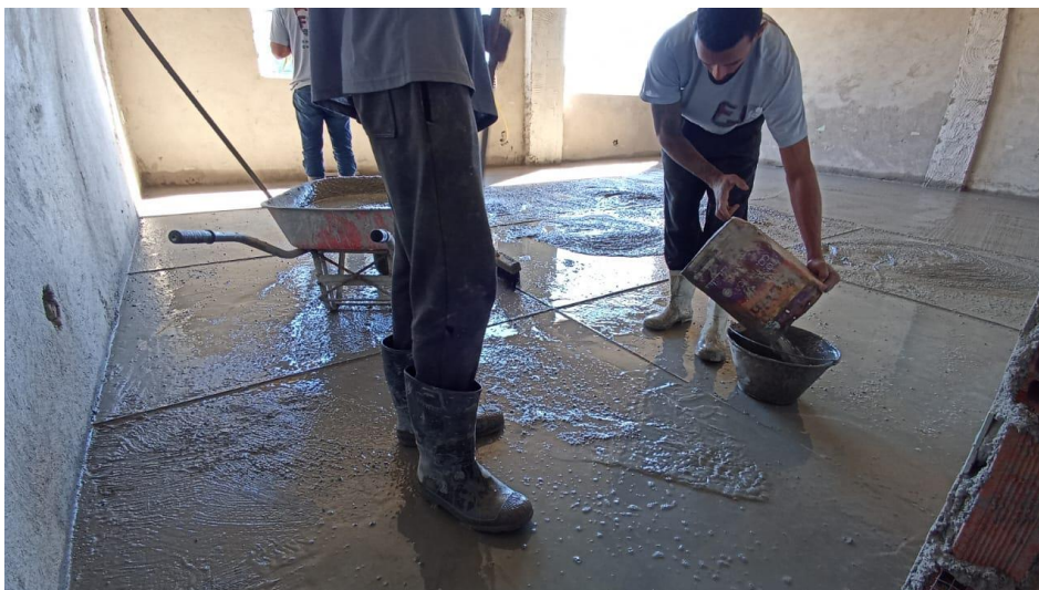
Figura 31 - Detalhe para execução do piso em granilite
