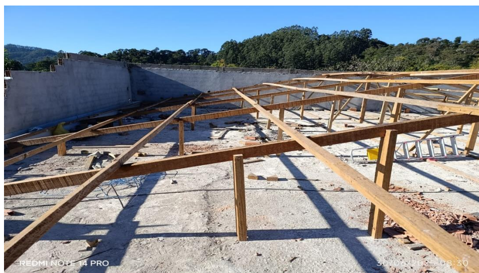
Figura 12 - Detalhe para execução de estrutura de madeira do telhado
