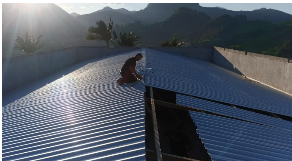
Figura 20 - Detalhe telhado em telha de aço
