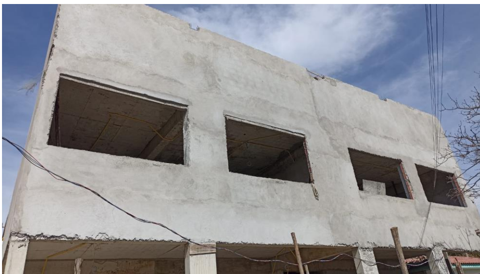
Figura 9 - Detalhe para execução de reboco das fachadas
