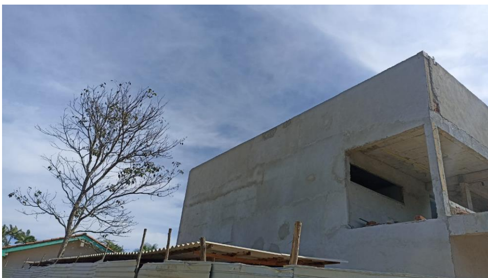
Figura 10 - Detalhe para execução de reboco das fachadas
