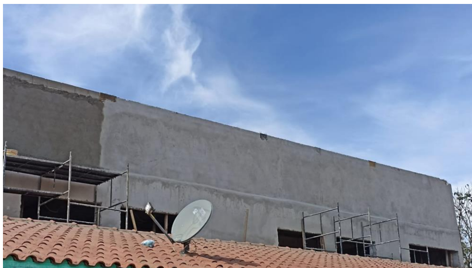
Figura 11 - Detalhe para execução de reboco das fachadas
