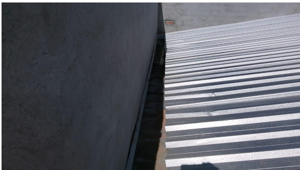
Figura 17 - Detalhe para calha e telhado em telha em aço
