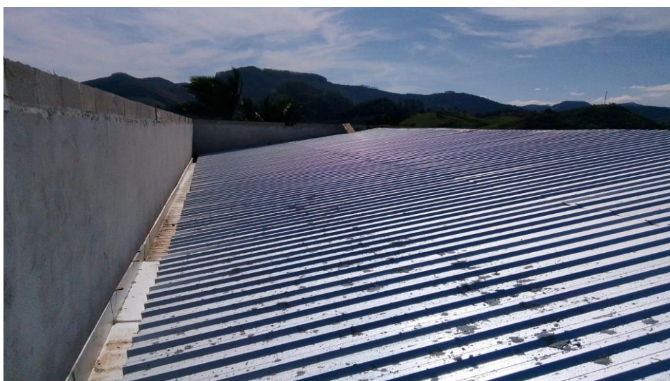
Figura 18 - Detalhe para calha e telhado em telha em aço
