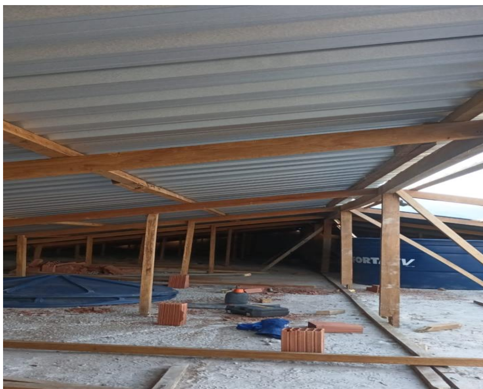
Figura 10 - Detalhe para reservatório instalado na cobertura
