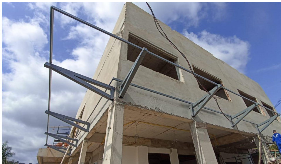
Figura 1 - Detalhe para estrutura treliçada de cobertura (pergolado frente a fachada)
