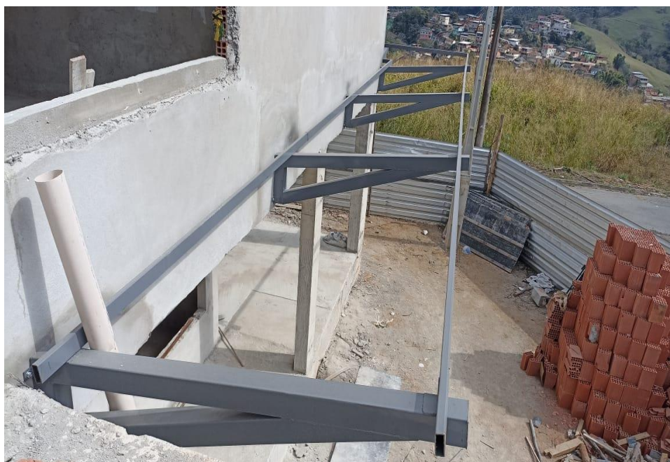
Figura 2 - Detalhe para estrutura treliçada de cobertura (pergolado frente a fachada)
