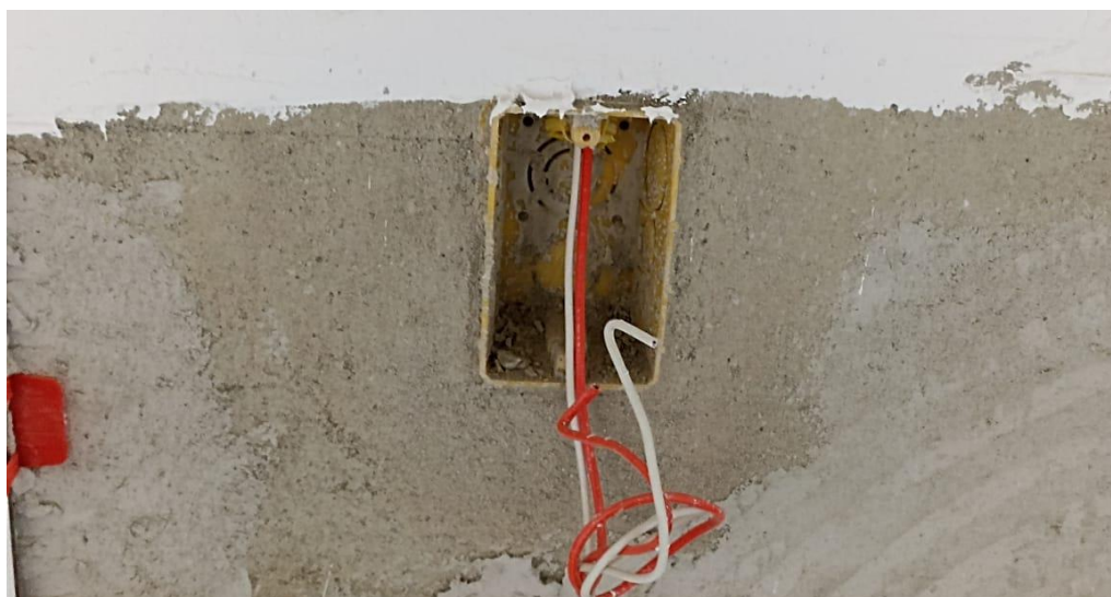
Figura 18 - Detalhe para execução de infraestrutura elétrica (caixa de embutir e cabo elétrico)
