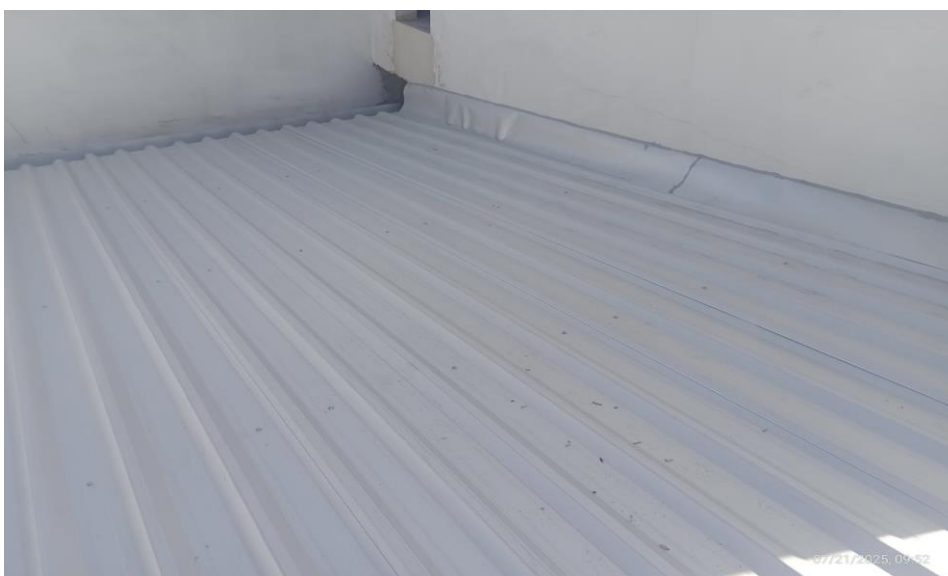
Figura 4 - Detalhe para rufo sobre telhamento metálico
