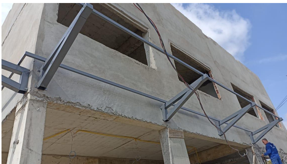
Figura 3 - Detalhe para estrutura treliçada de cobertura (pergolado frente a fachada)
