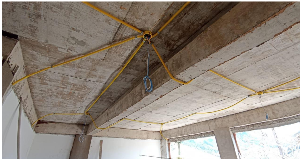
Figura 14 - Detalhe para execução de infraestrutura elétrica (caixa octagonal, tubulação e cabo elétrico)
