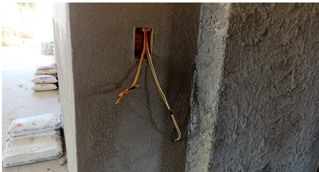
Figura 17 - Detalhe para execução de infraestrutura elétrica (caixa de embutir e cabo elétrico)
