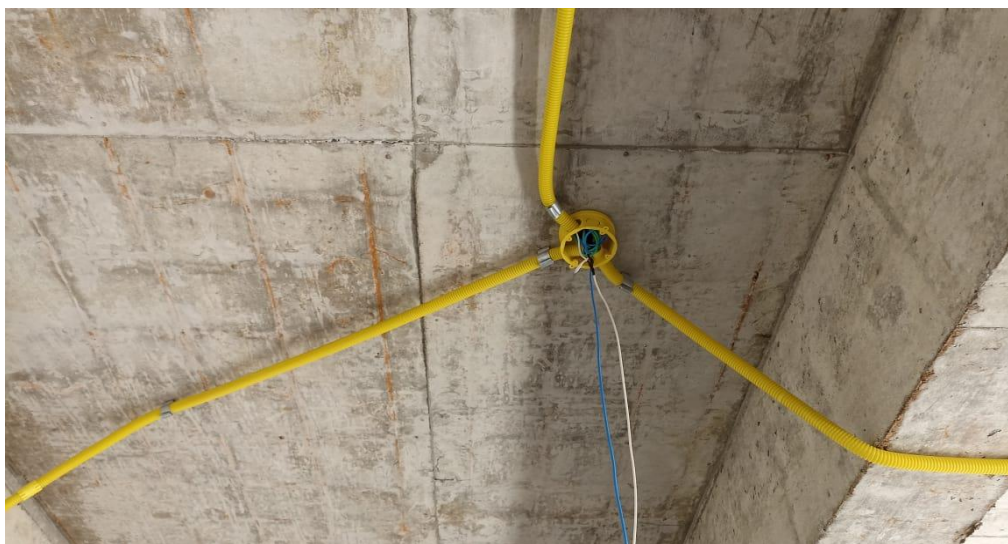
Figura 11 - Detalhe para execução de infraestrutura elétrica (caixa octagonal, tubulação e cabo elétrico)
