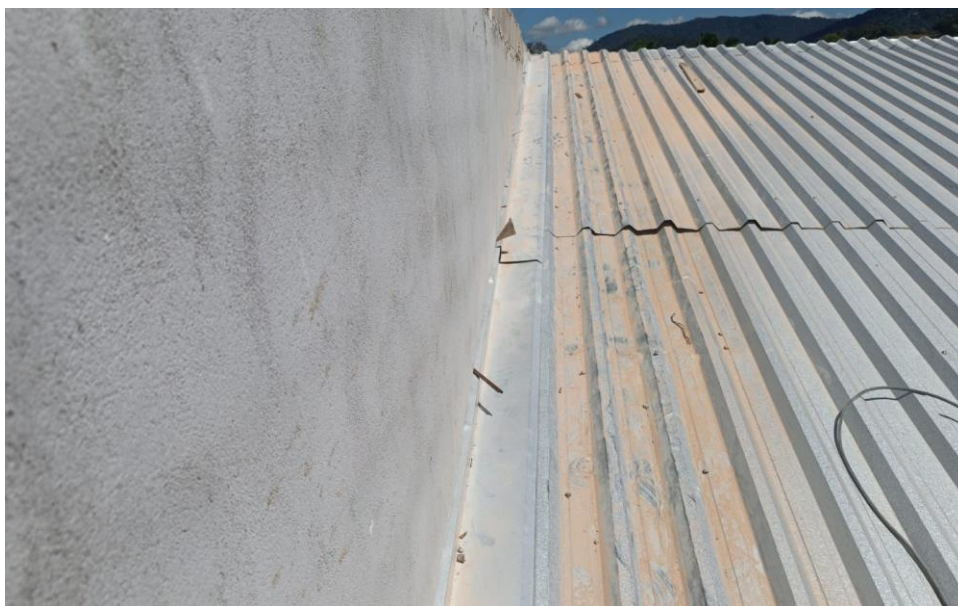
Figura 5- Detalhe para rufo sobre telhamento metálico
