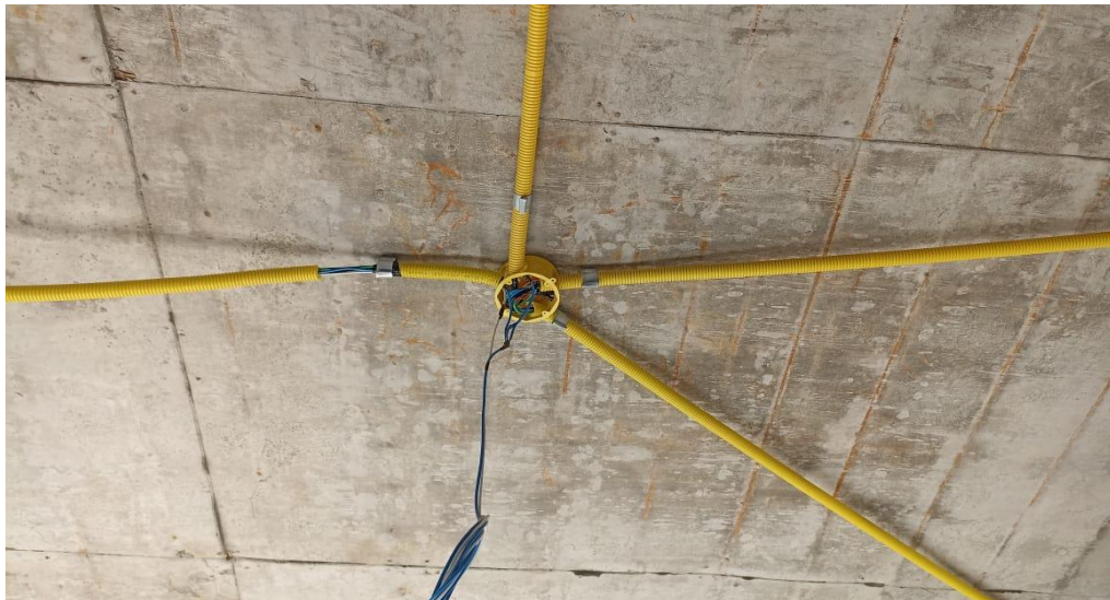
Figura 13 - Detalhe para execução de infraestrutura elétrica (caixa octagonal, tubulação e cabo elétrico)
