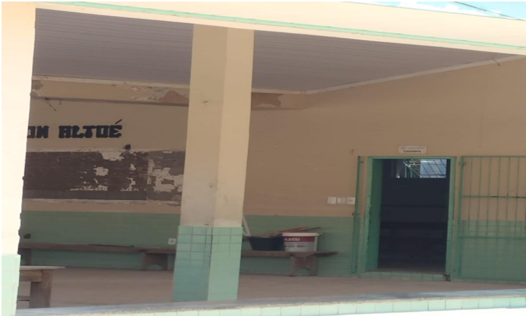
Imagens que registram a situação estrutural da Escola Edson Altoé no início da gestão (janeiro de 2025).
