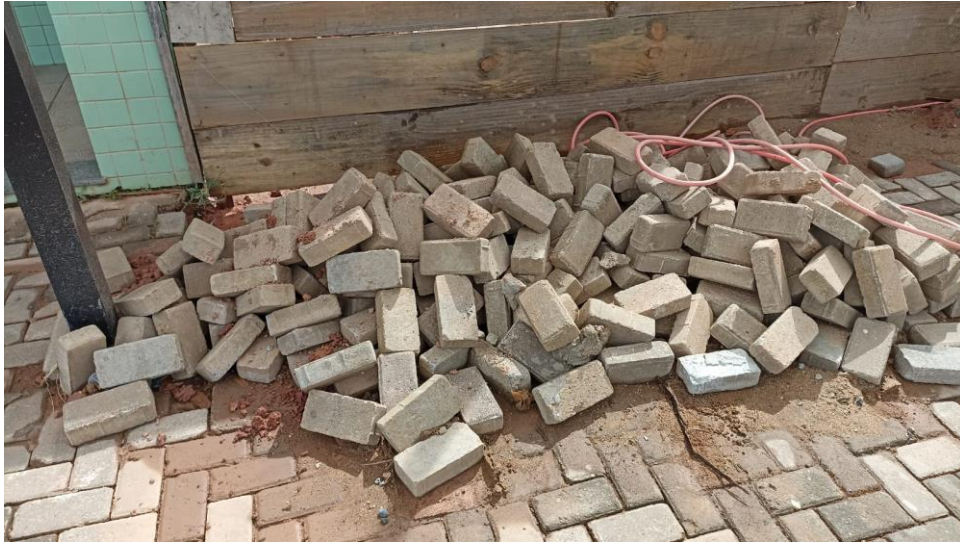
Figura 9 - Detalhe retirada manual dos blokrets
