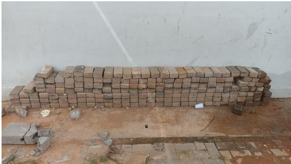
Figura 10 - Detalhe para empilhamento do blokrets para reaproveitamento
