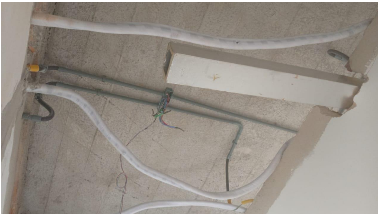
Instalação do sistema de climatização e refrigeração
