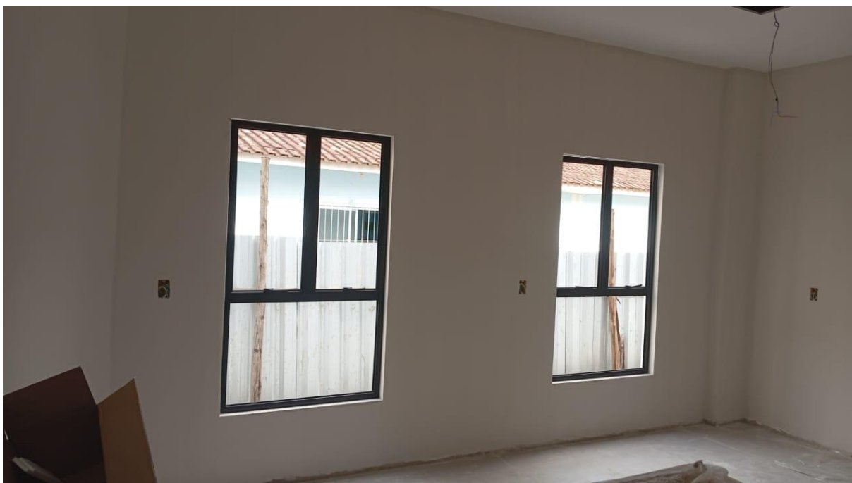
Instalação das esquadrias metálicas
