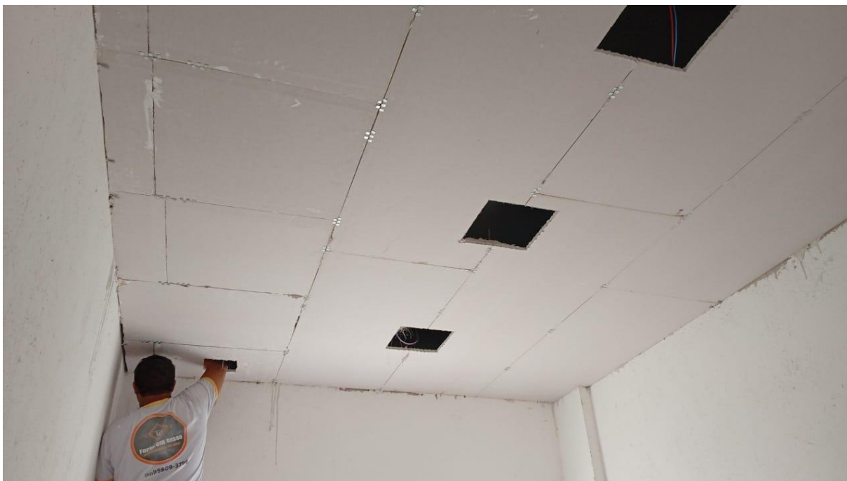
Instalação de forro de gesso
