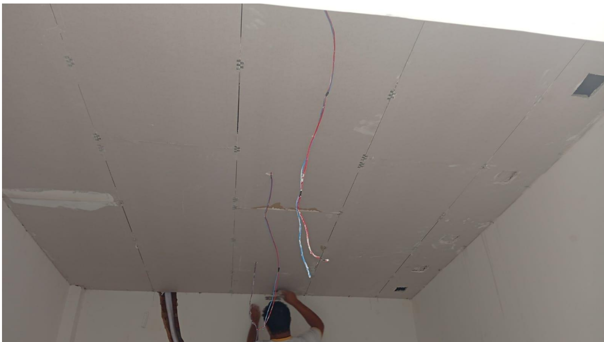
Instalação de forro de gesso
