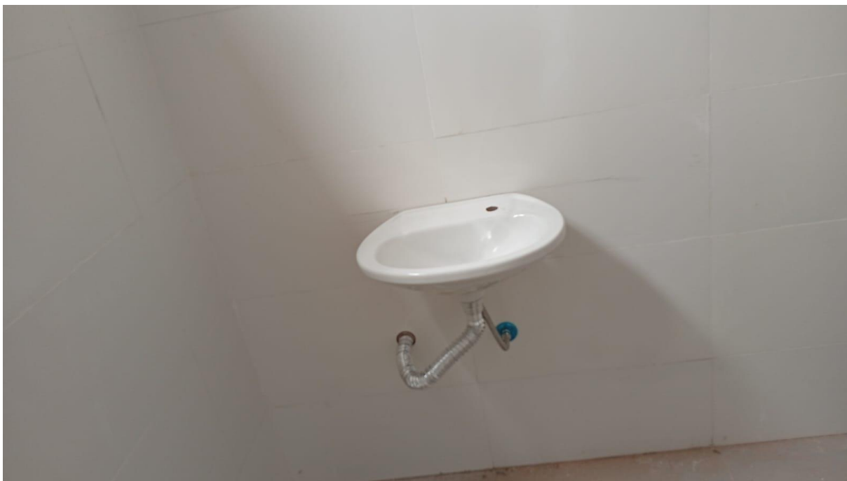
Instalação de lavatório
