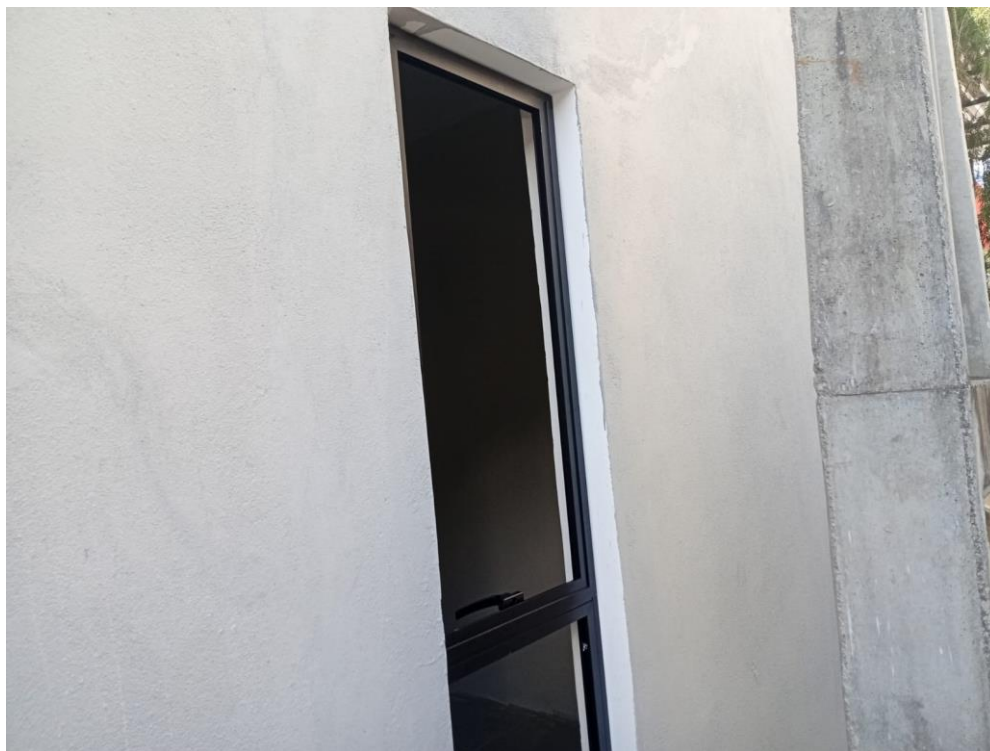
Instalação das esquadrias metálicas
