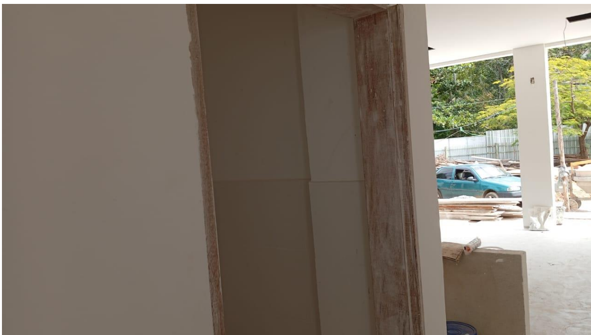
Emassamento das esquadrias de madeira
