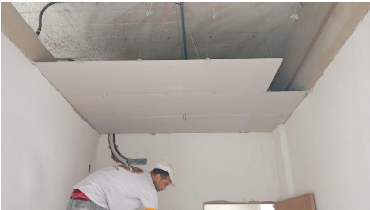
Instalação de forro de gesso
