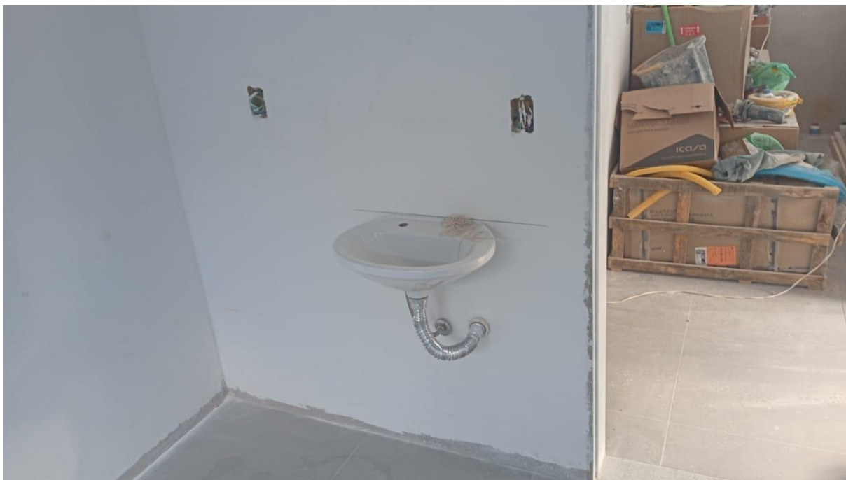
Instalação de lavatório
