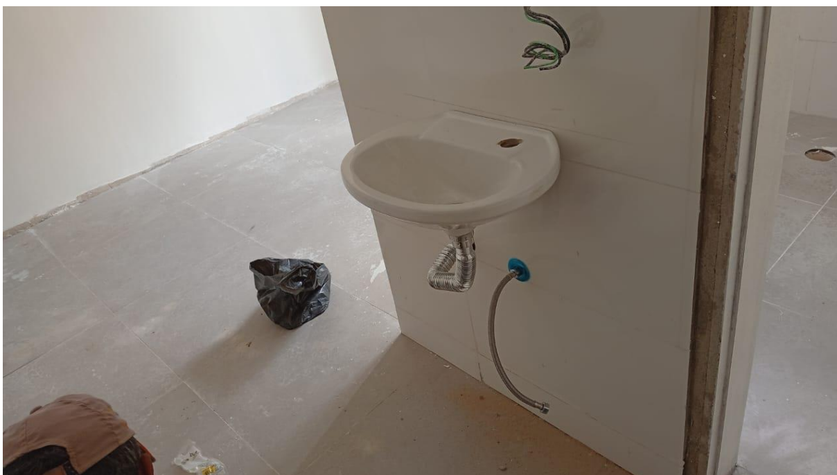
Instalação de lavatório
