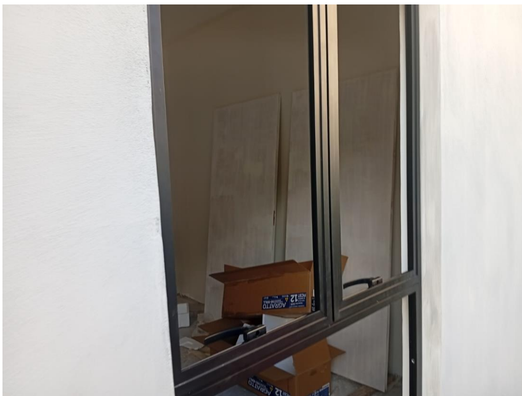
Instalação das esquadrias metálicas
