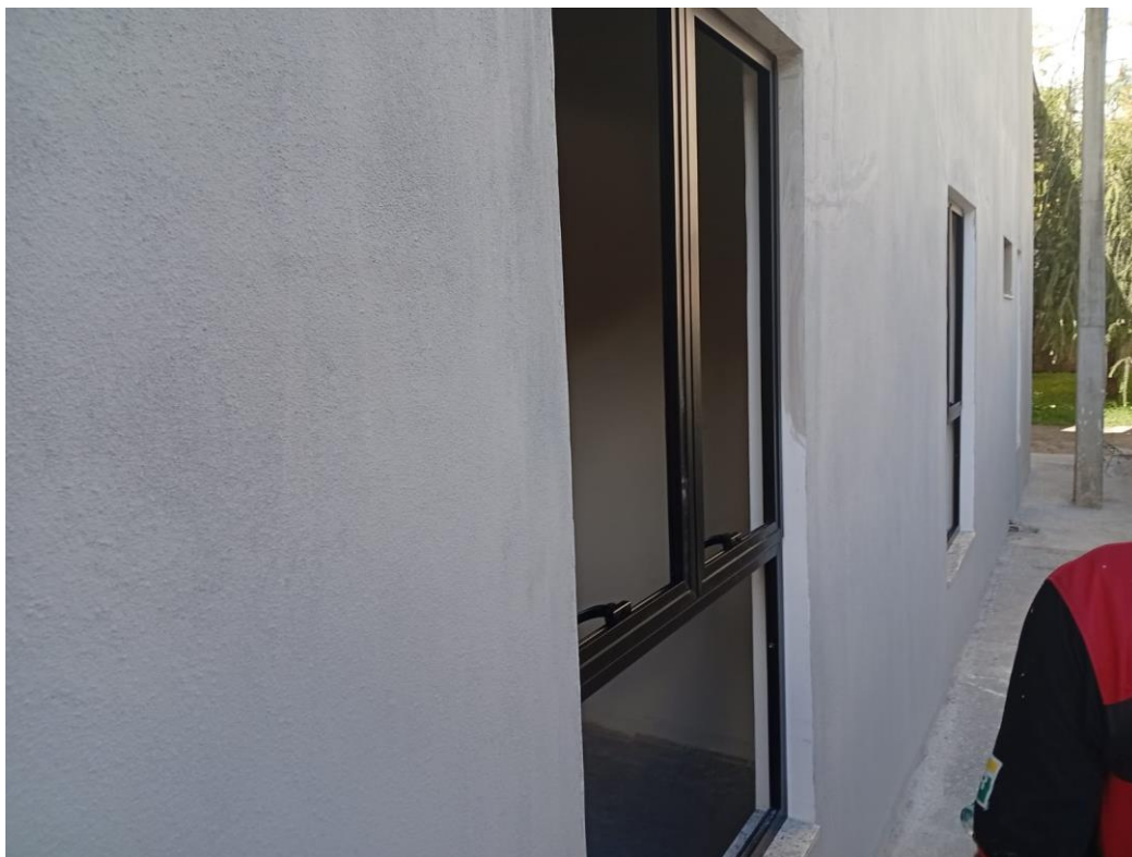
Instalação das esquadrias metálicas
