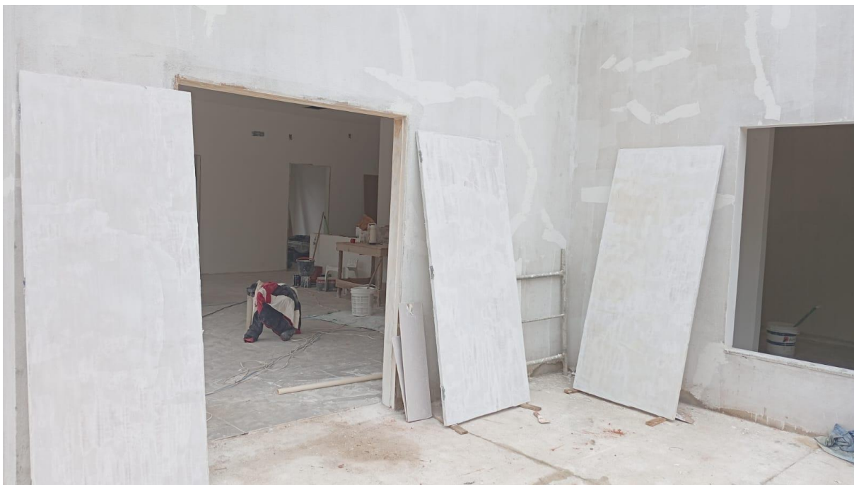
Emassamento das esquadrias de madeira
