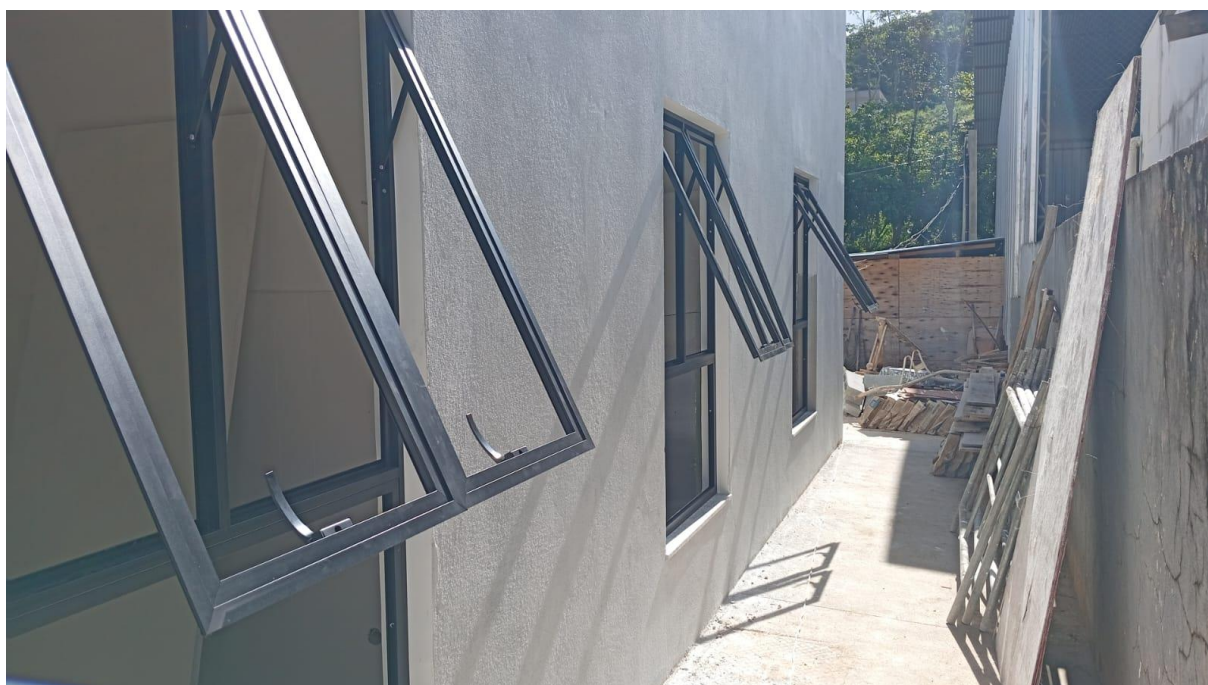
Instalação das esquadrias metálicas
