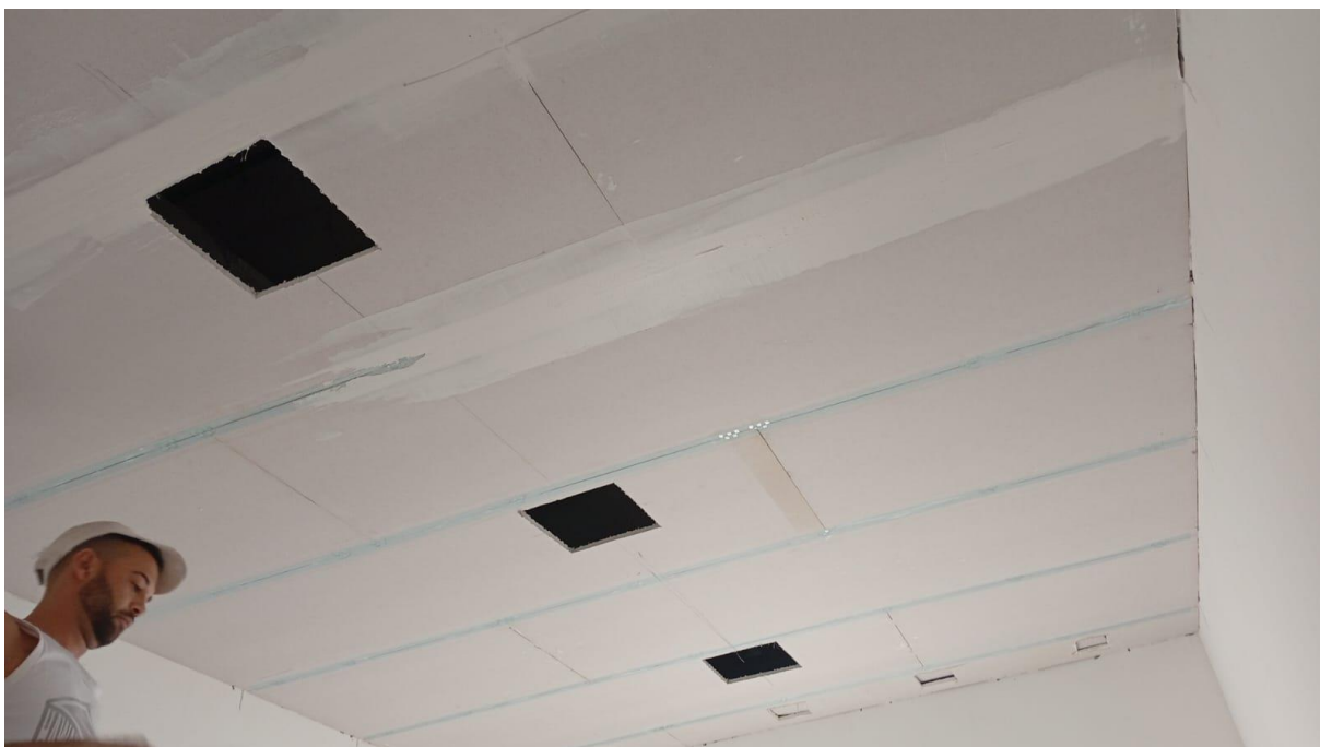
Instalação de forro de gesso
