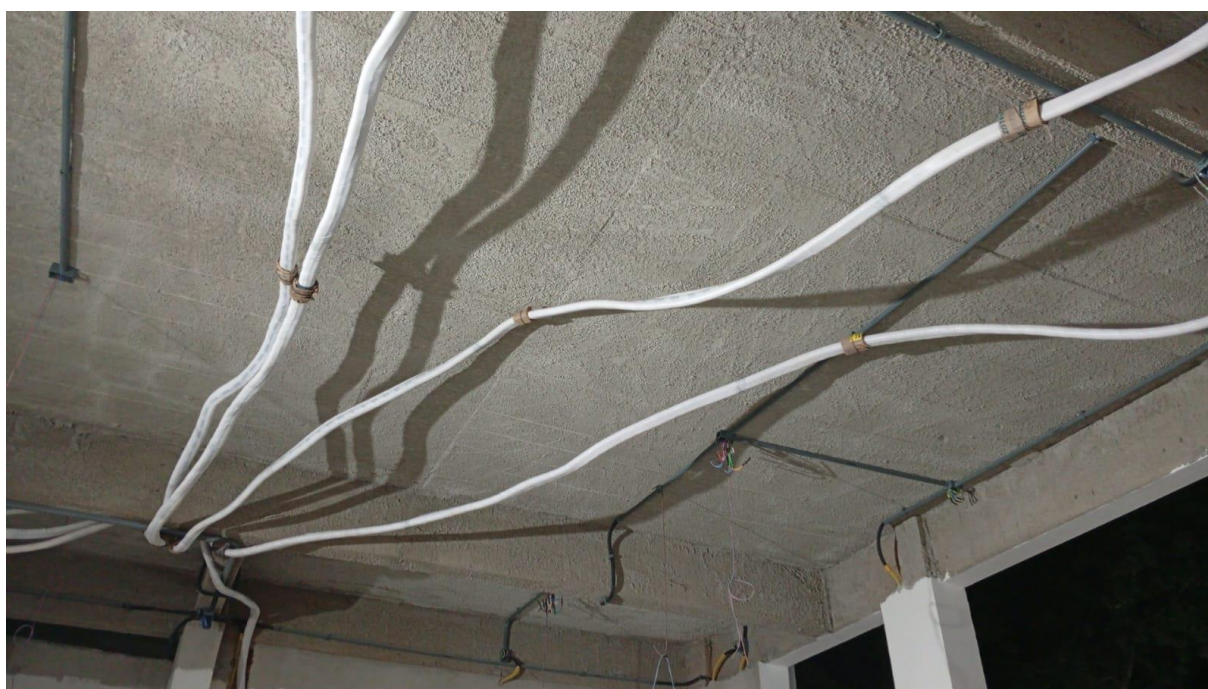
Instalação do sistema de climatização e refrigeração
