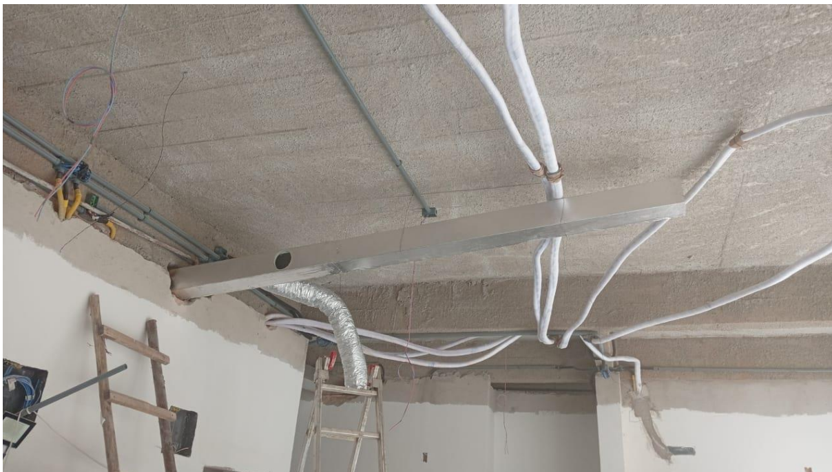
Instalação do sistema de climatização e refrigeração
