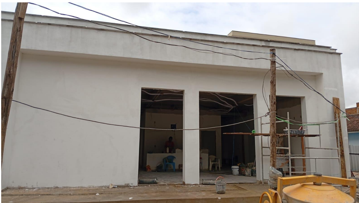
Aplicação de fundo selador acrílico
