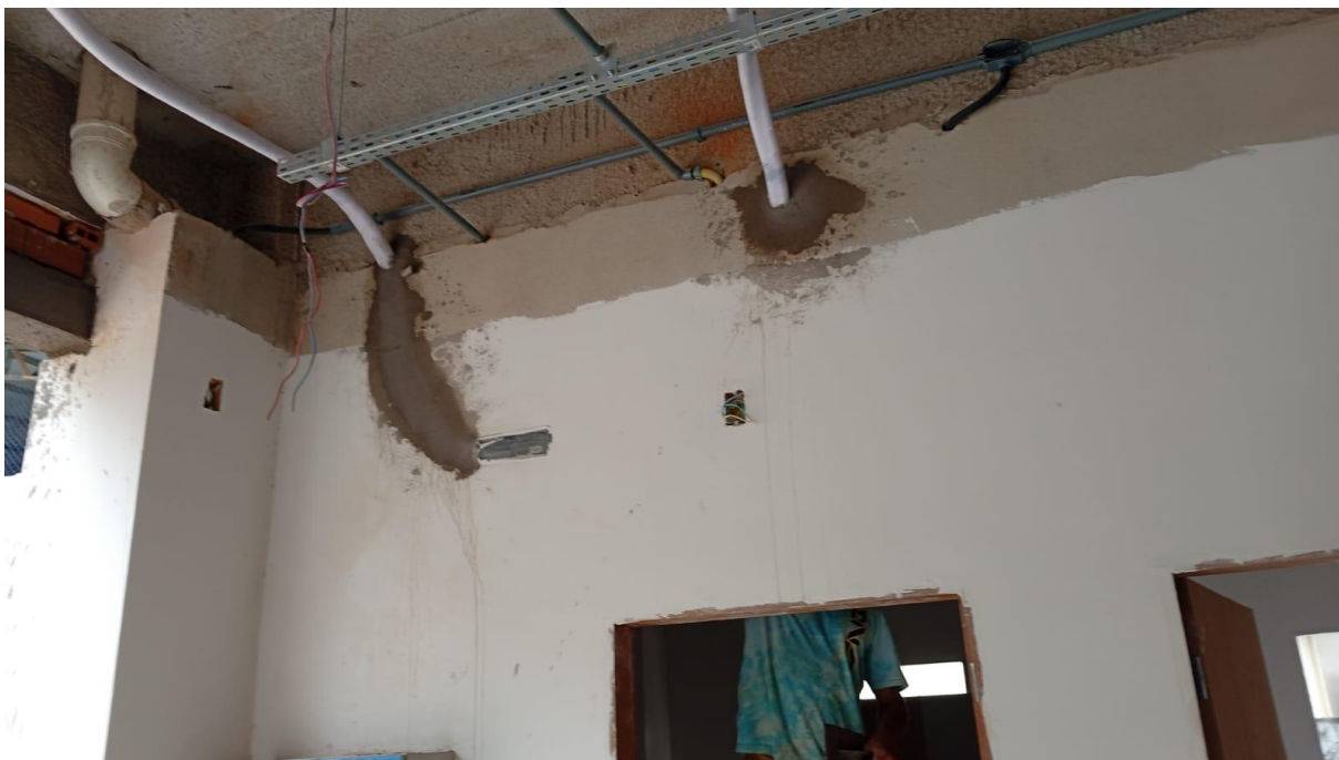
Instalação do sistema de climatização e refrigeração
