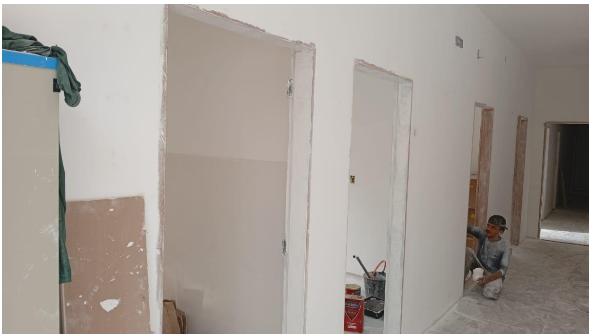
Emassamento e pintura das esquadrias de madeira
