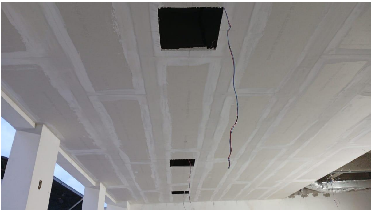
Instalação de forro de gesso
