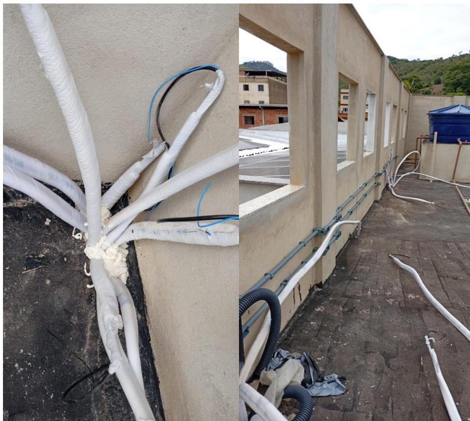
Instalação do sistema de climatização e refrigeração
