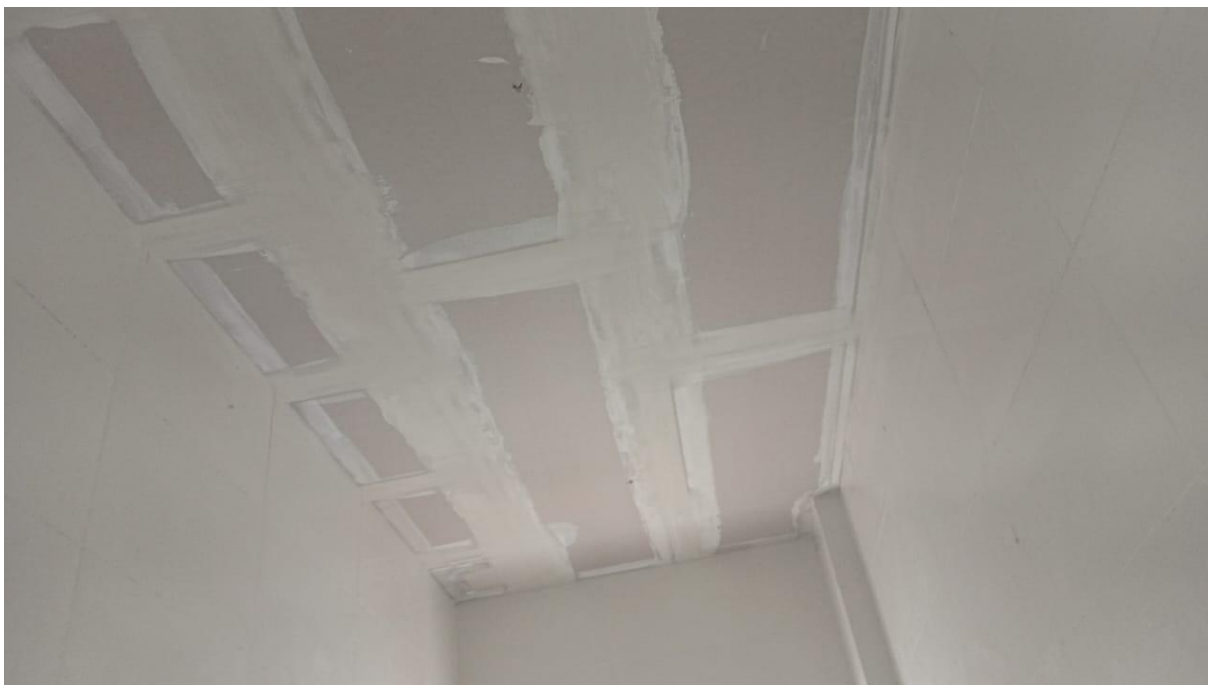
Instalação de forro de gesso
