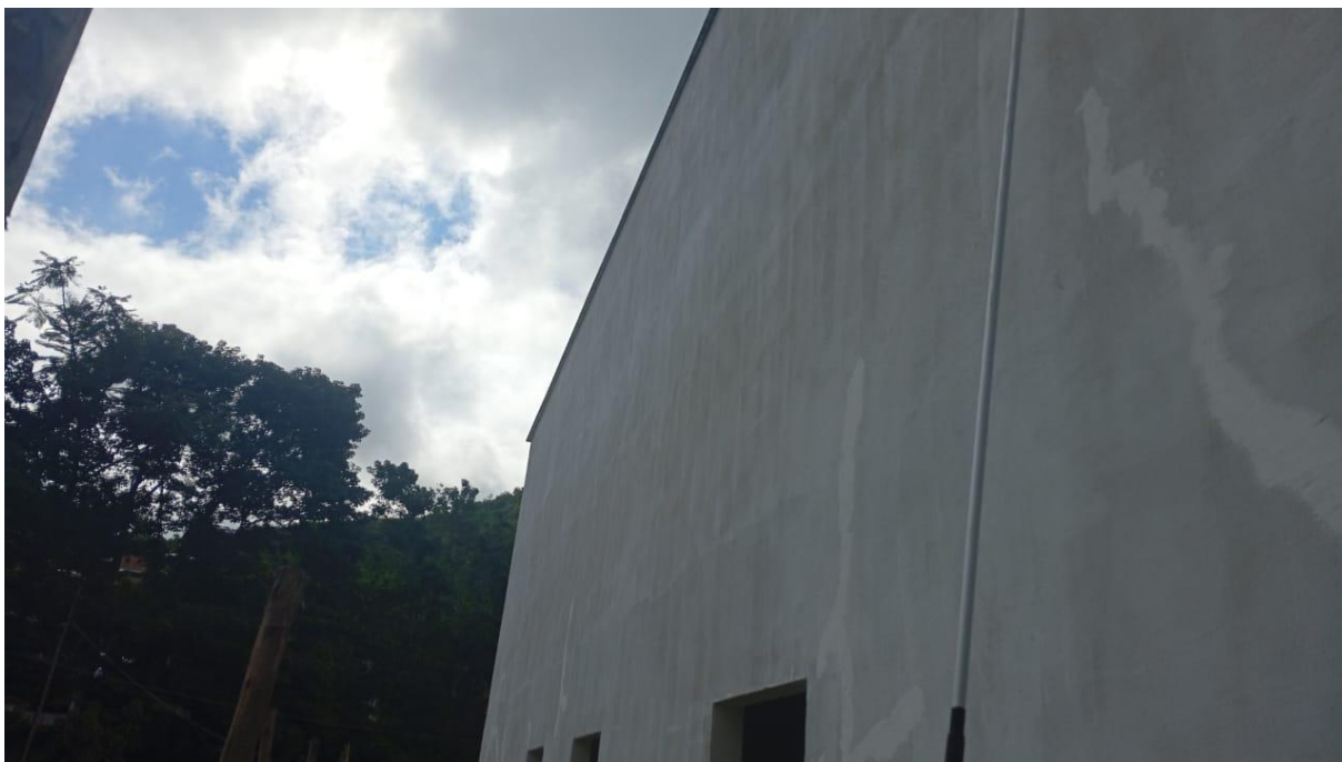
Aplicação de fundo selador acrílico
