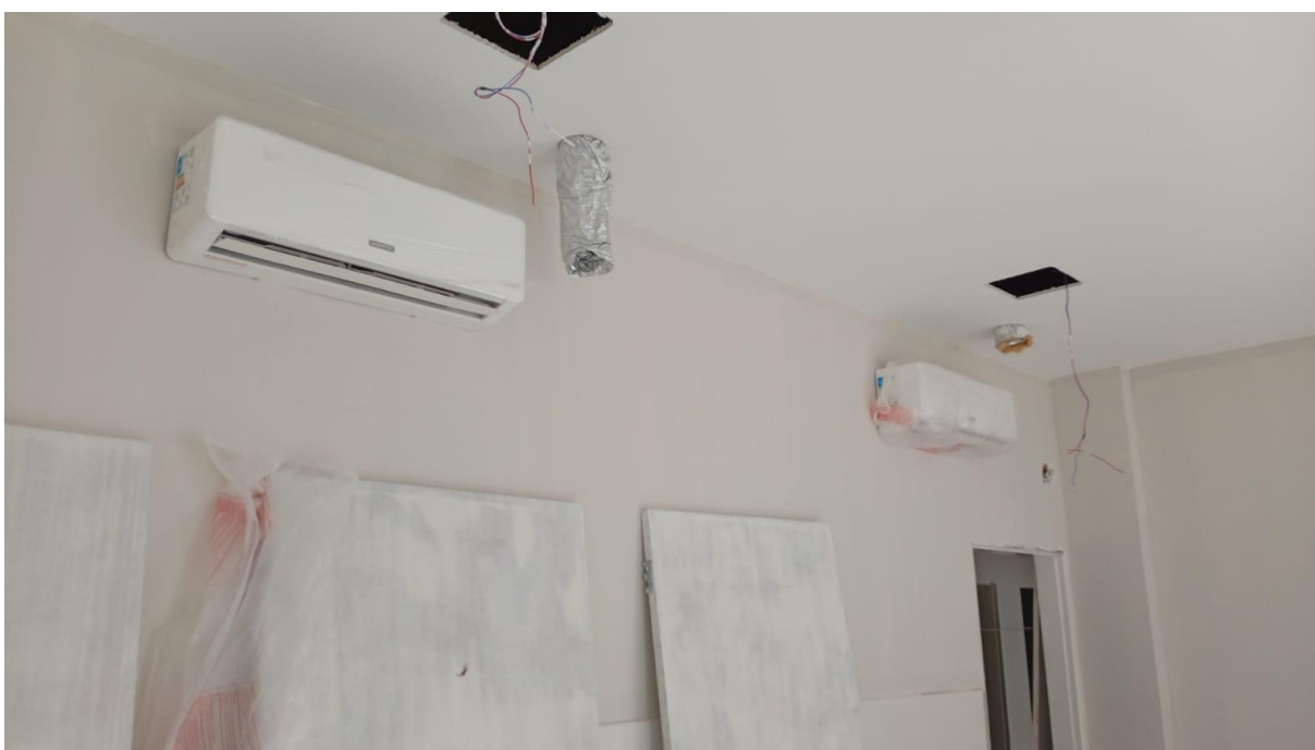
Instalação do sistema de climatização, refrigeração e instalação das máquinas de ar condicionado
