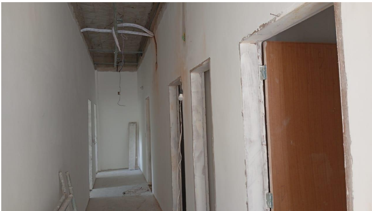
Emassamento das esquadrias de madeira
