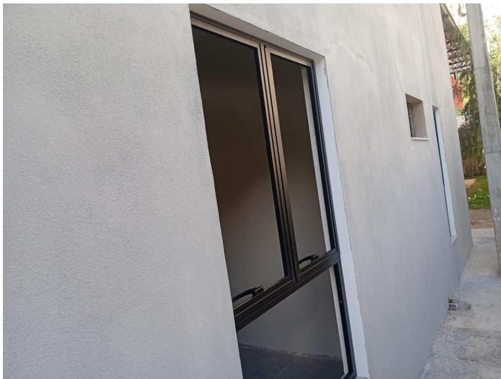
Instalação das esquadrias metálicas
