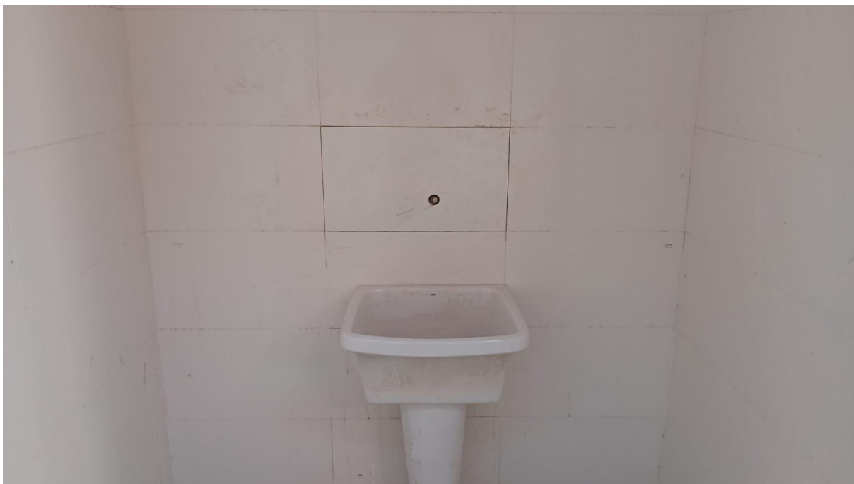
Instalação do tanque
