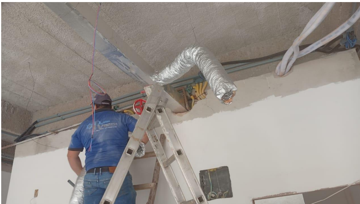
Instalação do sistema de climatização e refrigeração
