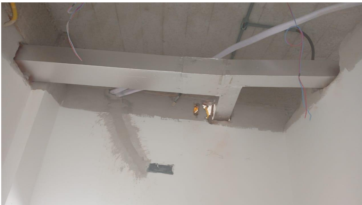
Instalação do sistema de climatização e refrigeração
