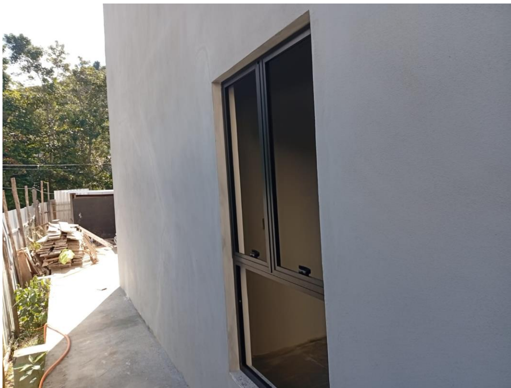
Instalação das esquadrias metálicas
