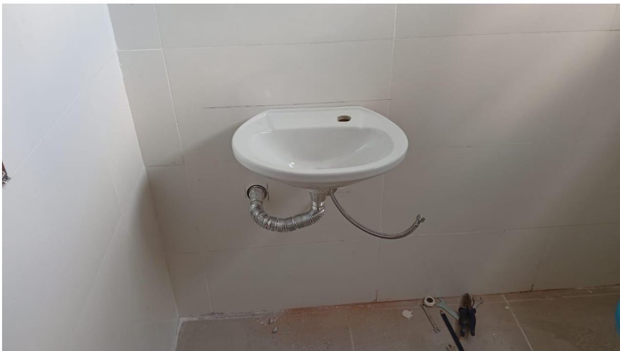
Instalação de lavatório
