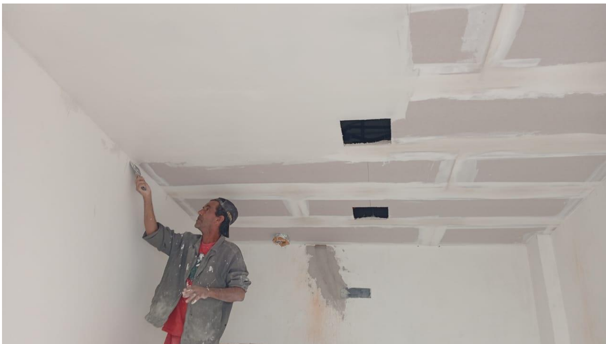
Emassamento de forro
