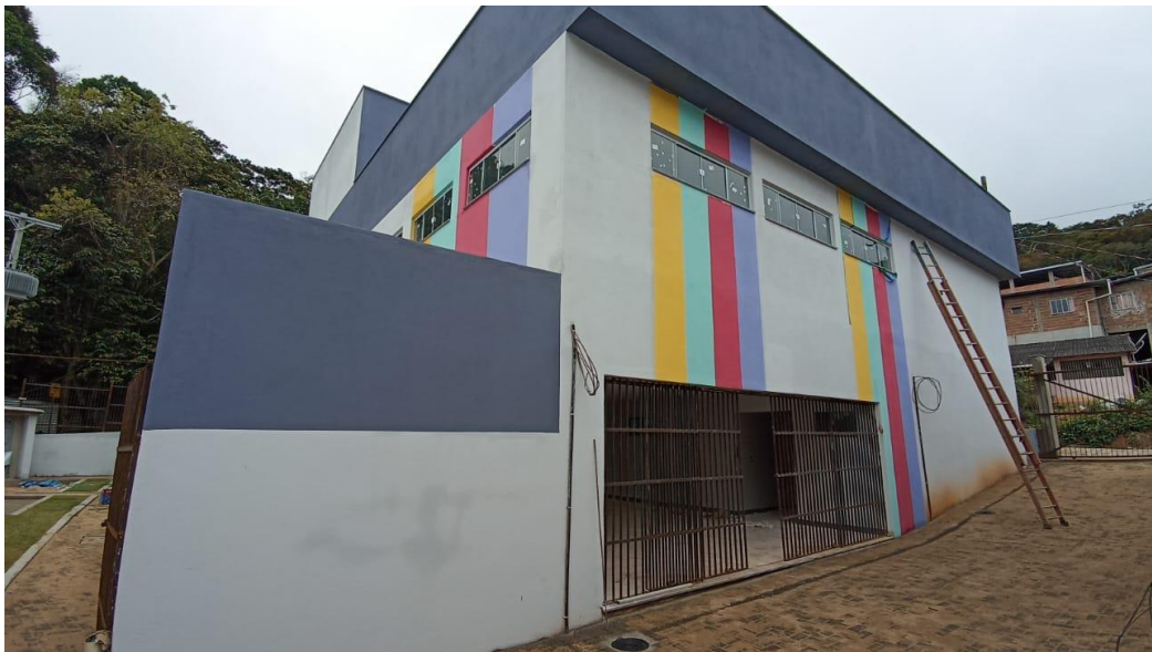
Figura 40 - Detalhe para pintura parte externa
