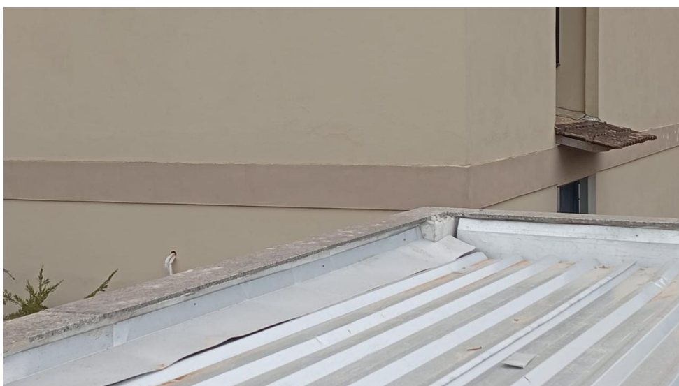
Figura 38 - Detalhe para rufo sobre o telhamento
