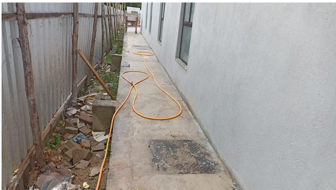
Figura 7 – Detalhe para calçada externa da edificação
