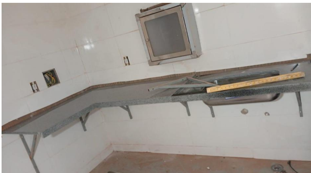
Figura 40 - Detalhe mão francesa para instalação das bancadas de granito
