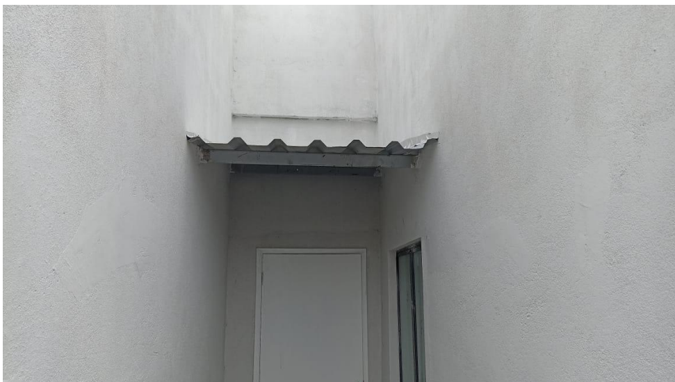
Figura 27 - Detalhe para execução estrutura metálica
