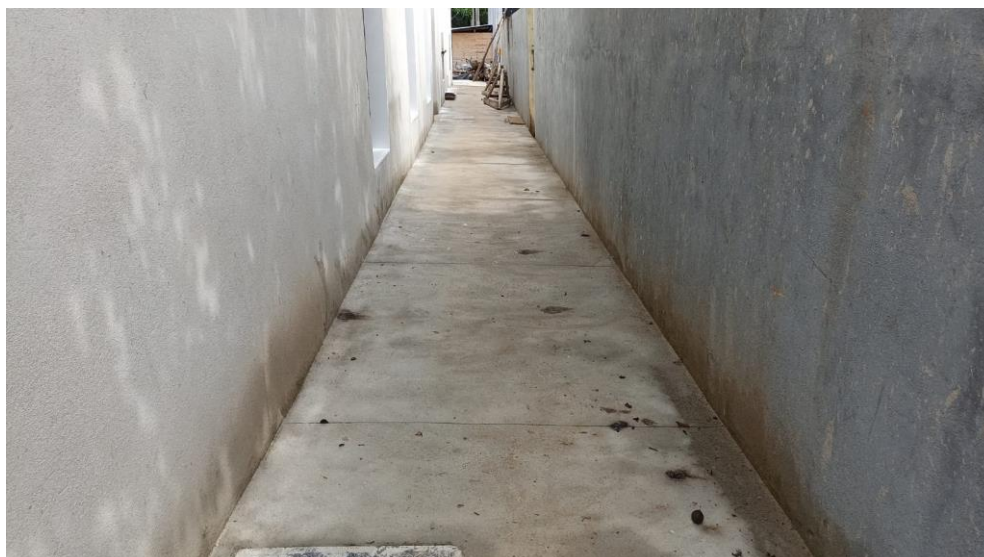
Figura 3 – Detalhe para calçada externa da edificação
