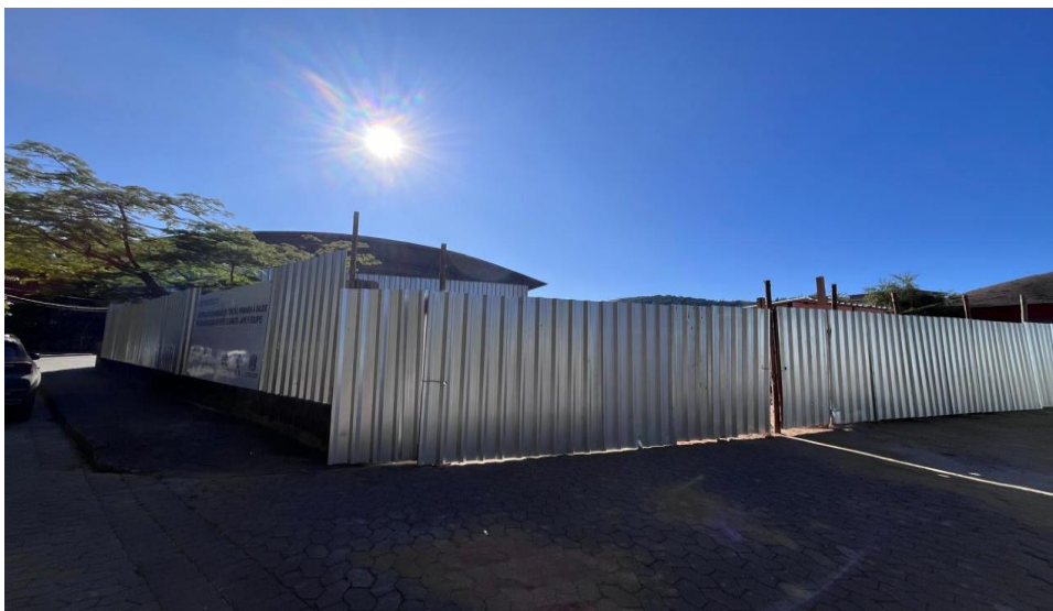
Figura 2 – Detalhe para tapume ao longo de toda obra
