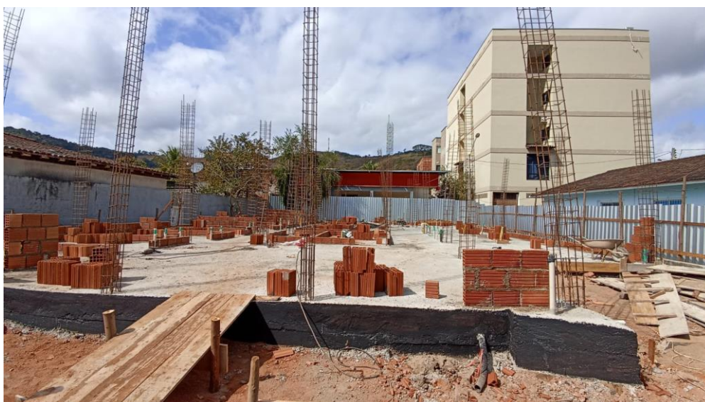
Figura 20 - Detalhe para impermeabilização das vigas baldrame
