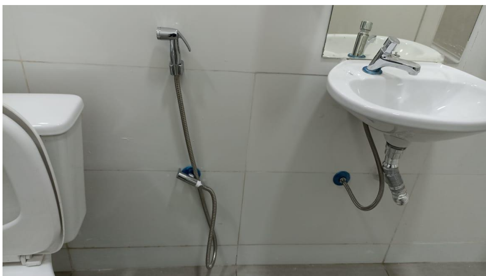
Figura 43 - Detalhe para ducha acqua jet
