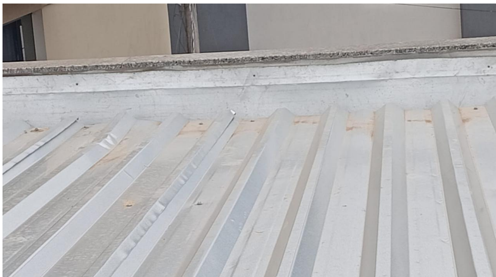
Figura 39 - Detalhe para rufo sobre o telhamento
