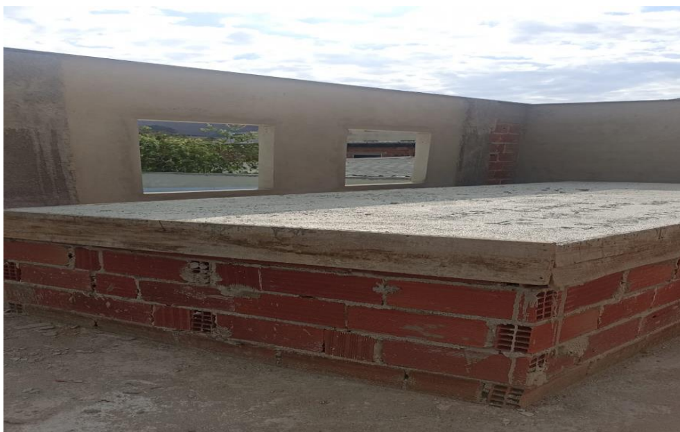
Figura 17 - Detalhe para execução de estrutura em alvenaria para suporte dos reservatórios de água
