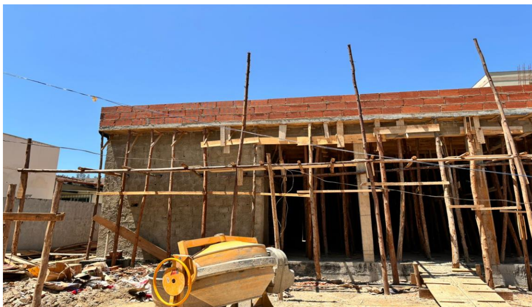
Figura 12 – Detalhe para escoramento de estrutura em balanço para execução do pórtico e alvenaria
