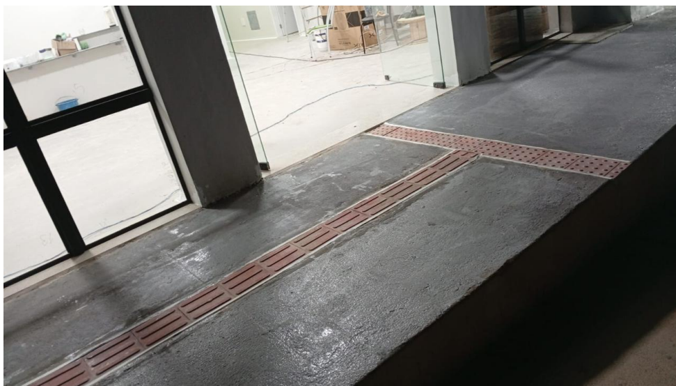
Figura 37 - Detalhe para ladrilhos hidráulicos da rampa de acesso a edificação
