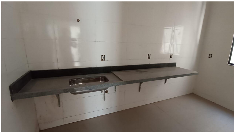
Figura 41 - Detalhe mão francesa para instalação das bancadas de granito
