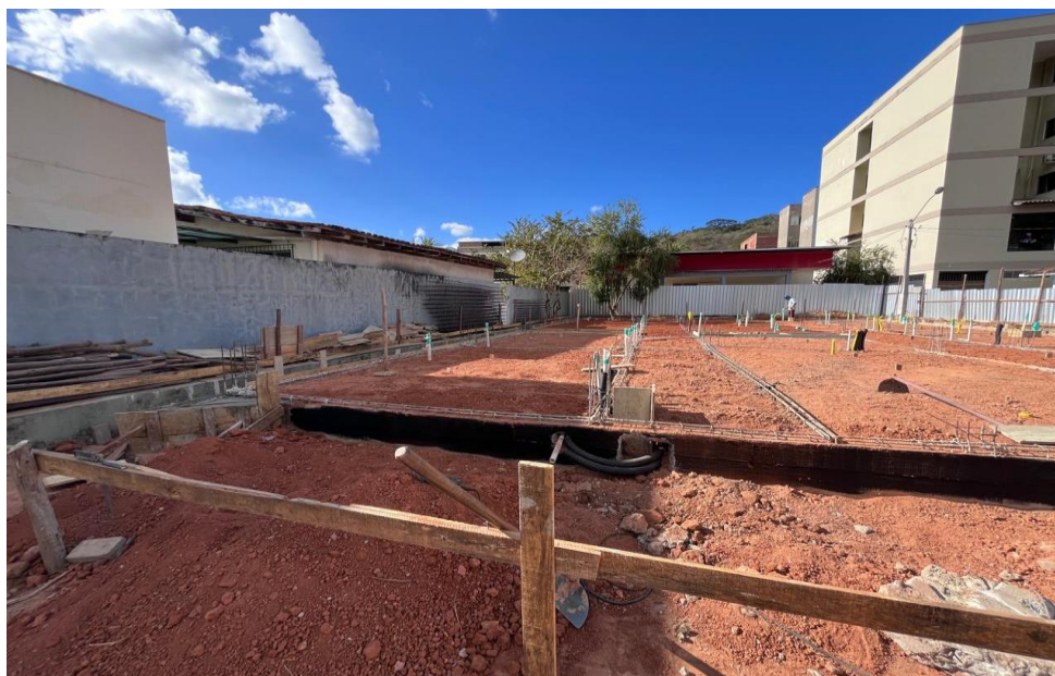
Figura 21 - Detalhe para impermeabilização das vigas baldrame
