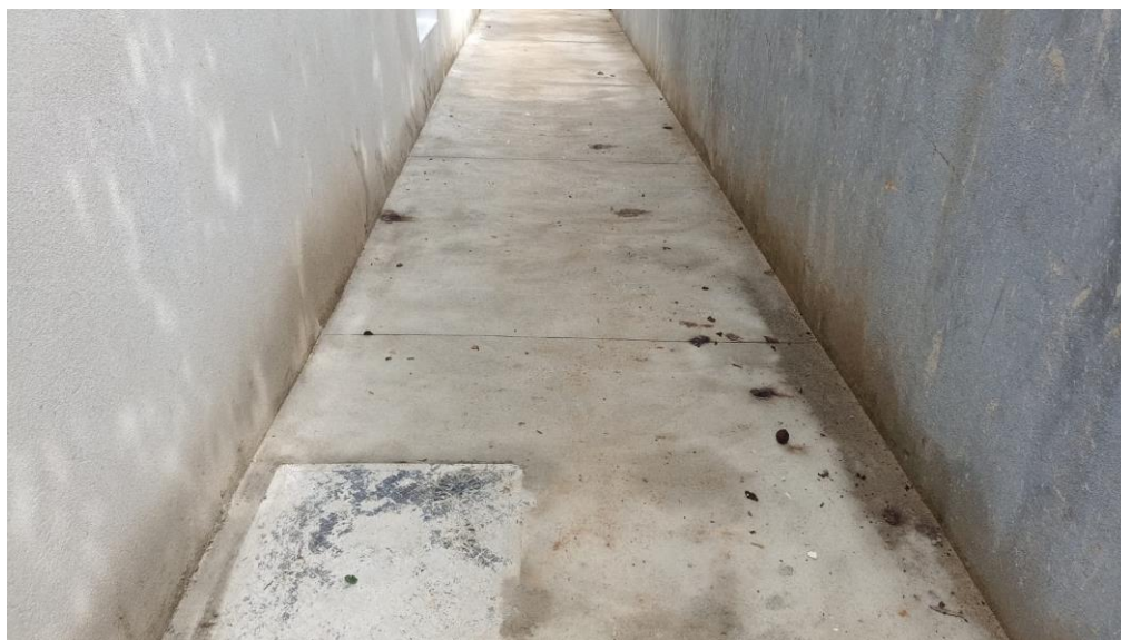
Figura 5 – Detalhe para calçada externa da edificação
