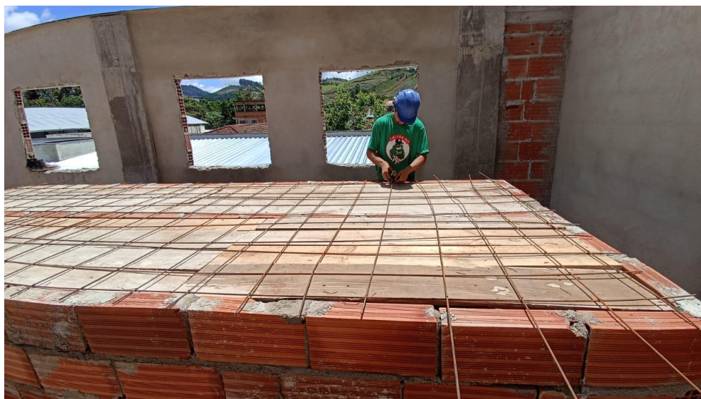
Figura 15 - Detalhe para execução de estrutura em alvenaria para suporte dos reservatórios de água
