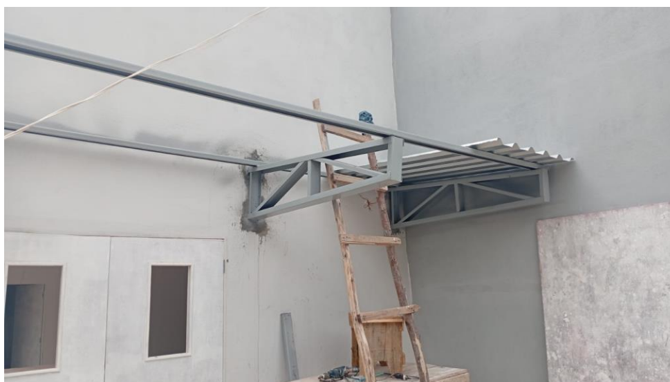
Figura 22 - Detalhe para execução estrutura metálica
