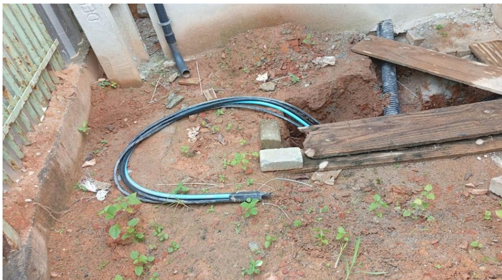
Figura 33 - Detalhe para infraestrutura elétrica parte externa (tubos PEAD e cabos)
