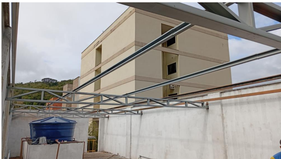
Figura 23 - Detalhe para execução estrutura metálica
