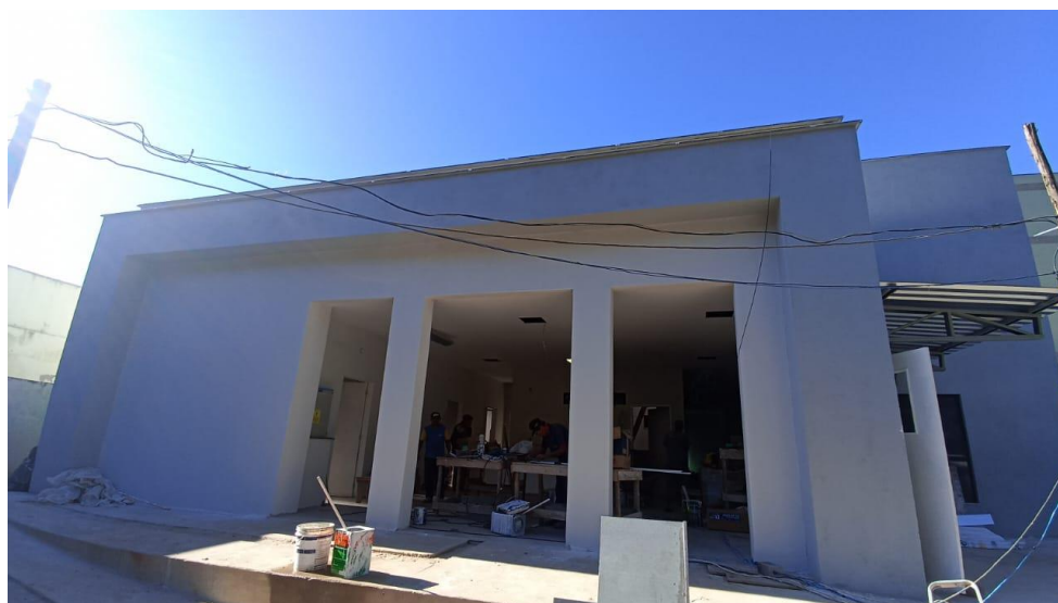
Figura 34 - Detalhe para pintura da fachada externa
