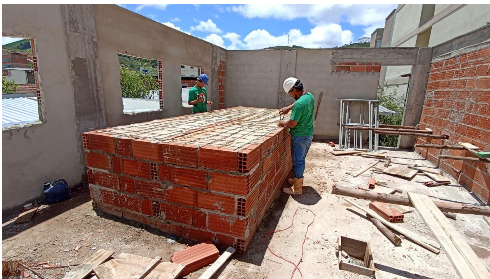
Figura 16 - Detalhe para execução de estrutura em alvenaria para suporte dos reservatórios de água
