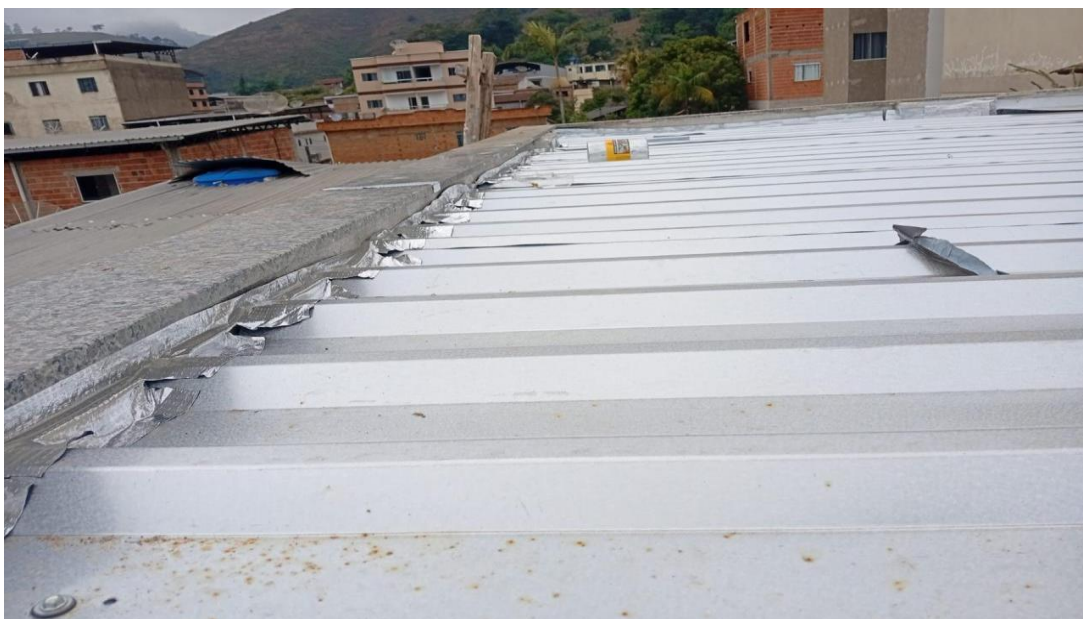
Figura 9 – Detalhe para chapim ao longo da edificação
