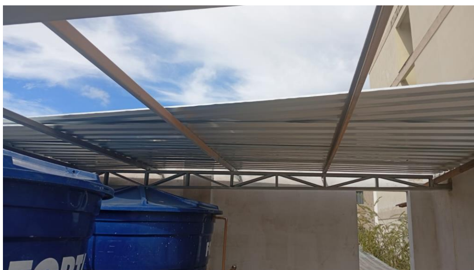
Figura 24 - Detalhe para execução estrutura metálica
