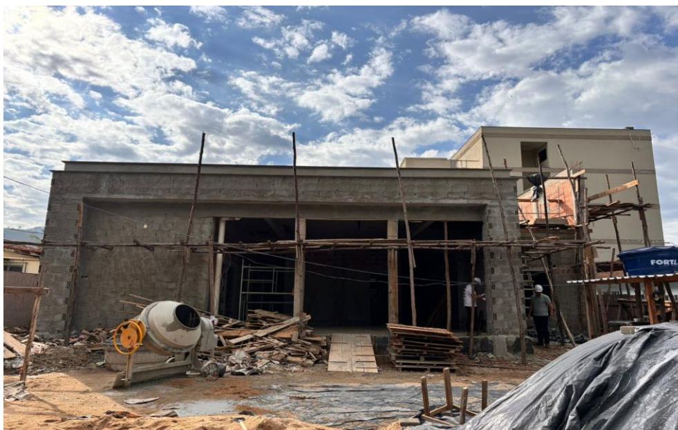
Figura 13 – Detalhe para chapisco pórtico fachada frontal
