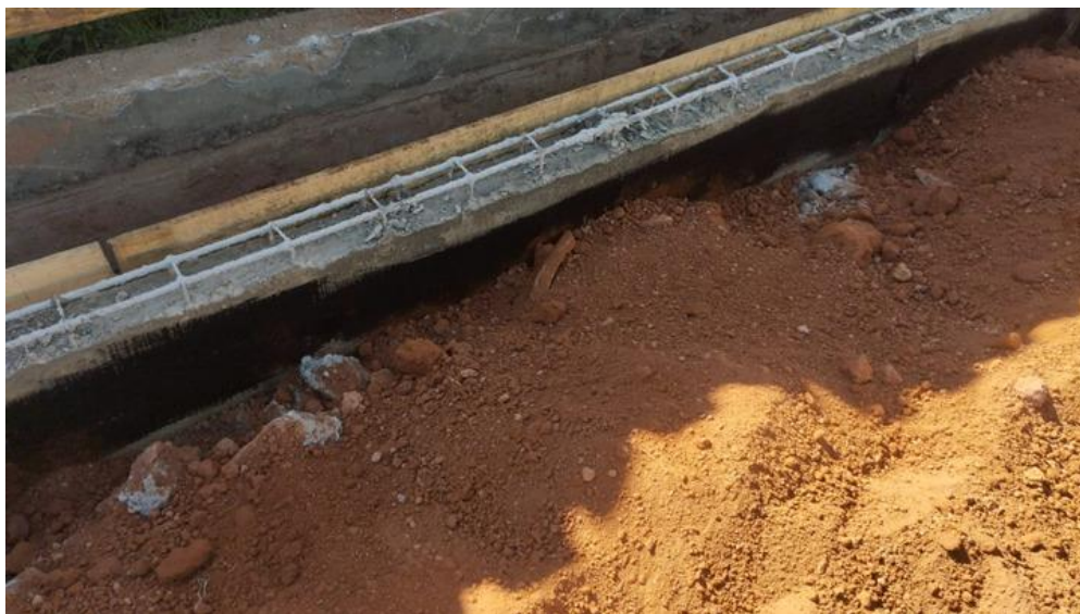
Figura 19 - Detalhe para impermeabilização das vigas baldrame
