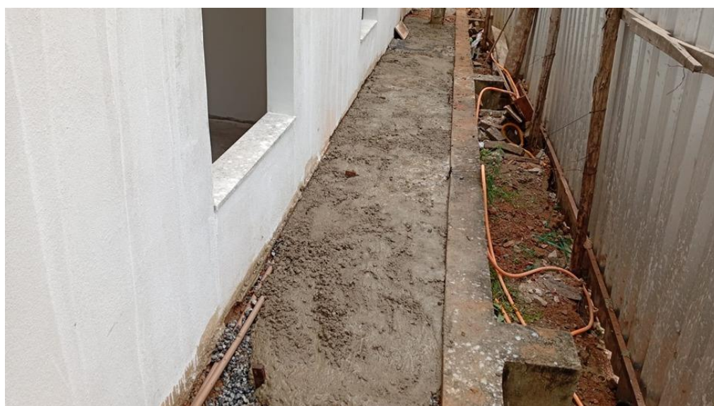
Figura 6 – Detalhe para execução calçada externa da edificação
