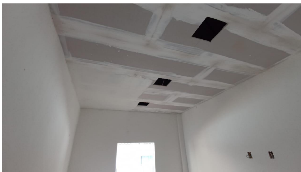
Figura 30 - Detalhe para execução do forro de gesso
