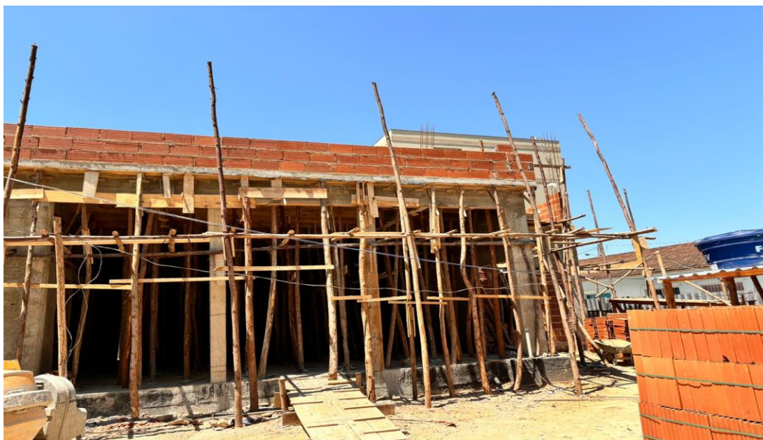
Figura 11 – Detalhe para escoramento de estrutura em balanço para execução do pórtico e alvenaria
