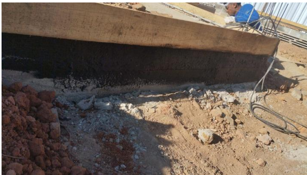
Figura 18 - Detalhe para impermeabilização das vigas baldrame
