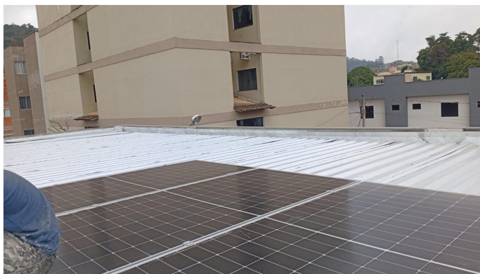
Figura 26 - Detalhe para execução estrutura metálica e instalação placas fotovoltaicas
