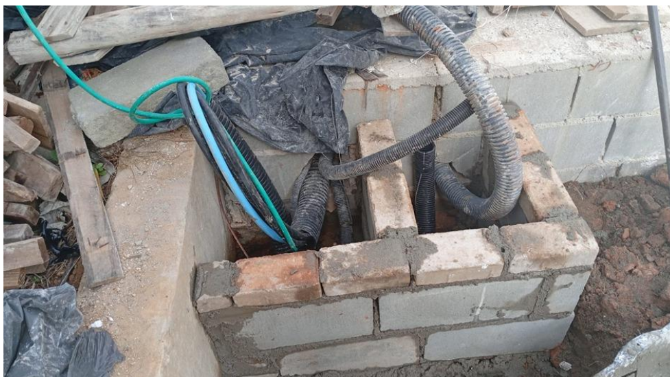
Figura 32 - Detalhe para infraestrutura elétrica parte externa (tubos PEAD e cabos)
