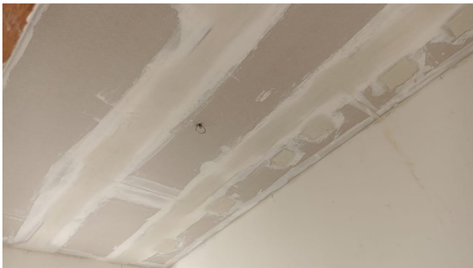
Figura 28 - Detalhe para execução do forro de gesso
