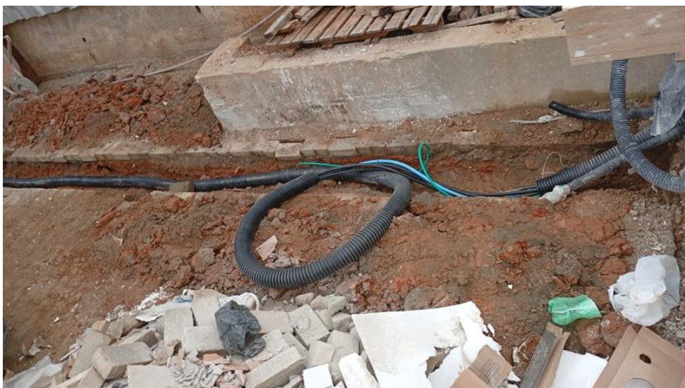
Figura 31 - Detalhe para infraestrutura elétrica parte externa (tubos PEAD e cabos)
