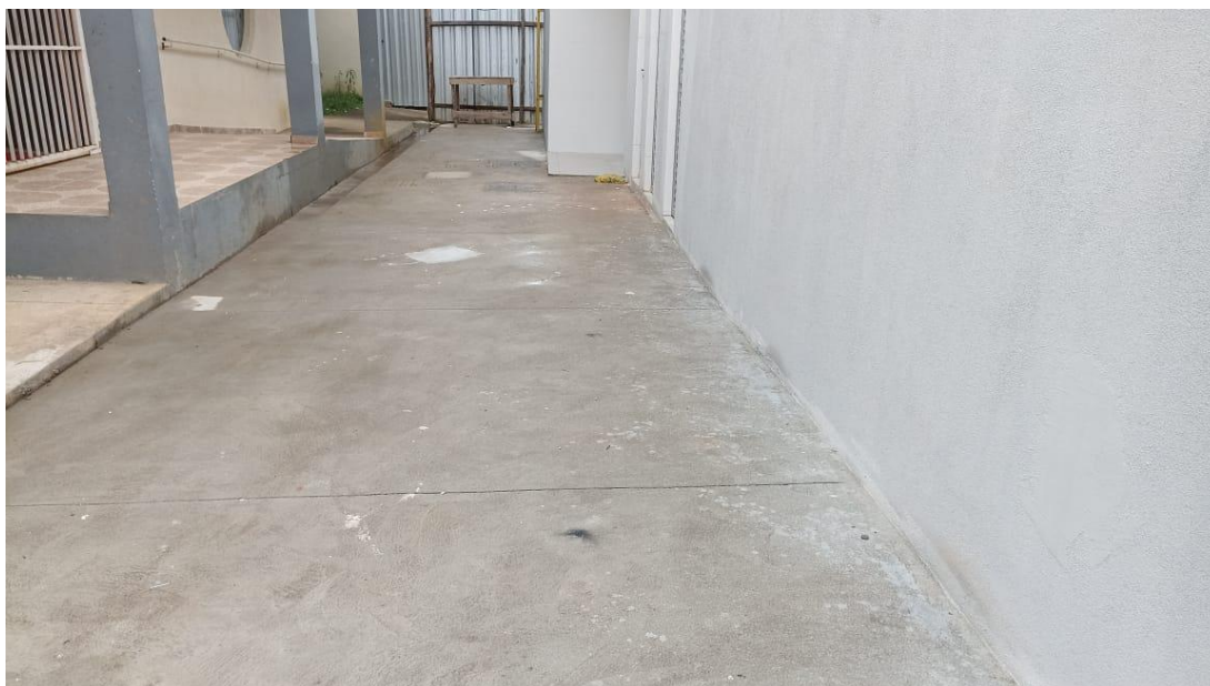
Figura 8 – Detalhe para calçada externa da edificação
