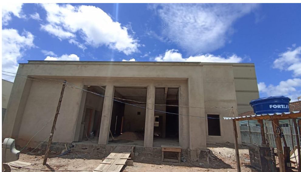
Figura 14 - Detalhe para reboco pórtico fachada frontal
