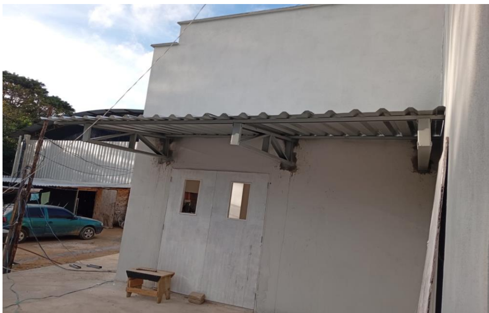
Figura 25 - Detalhe para execução estrutura metálica
