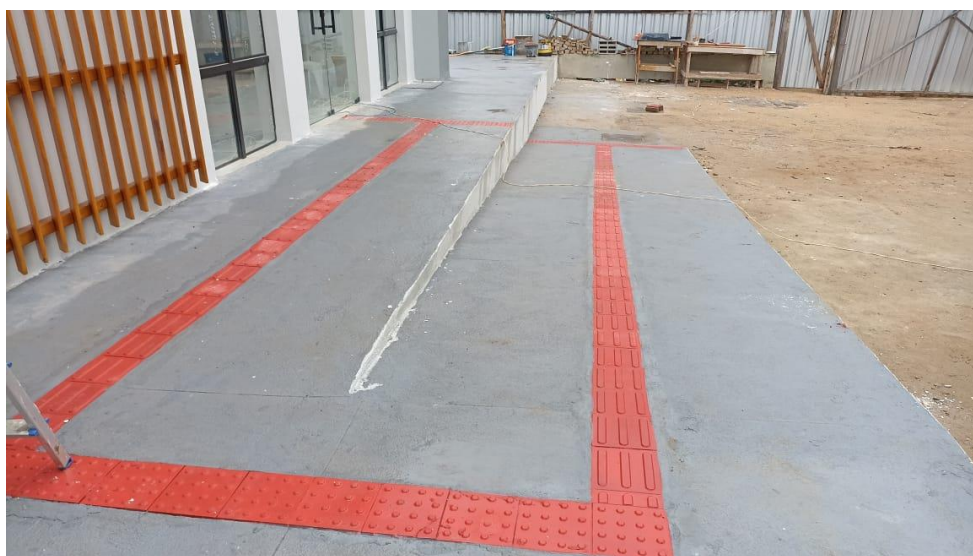
Figura 36 - Detalhe para ladrilhos hidráulicos da rampa de acesso a edificação
