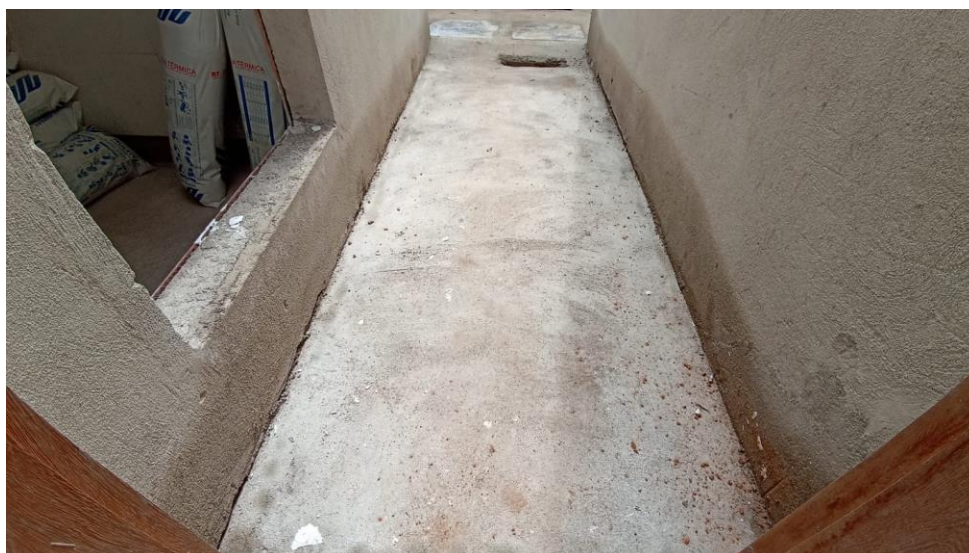
Figura 4 – Detalhe para calçada externa da edificação
