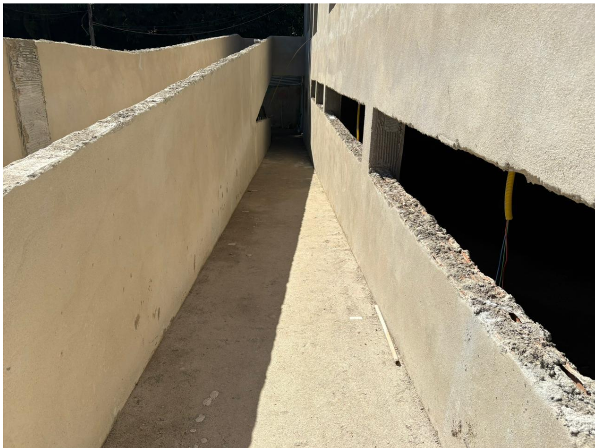
FOTO 12 – Contrapiso Rampa concluído.
