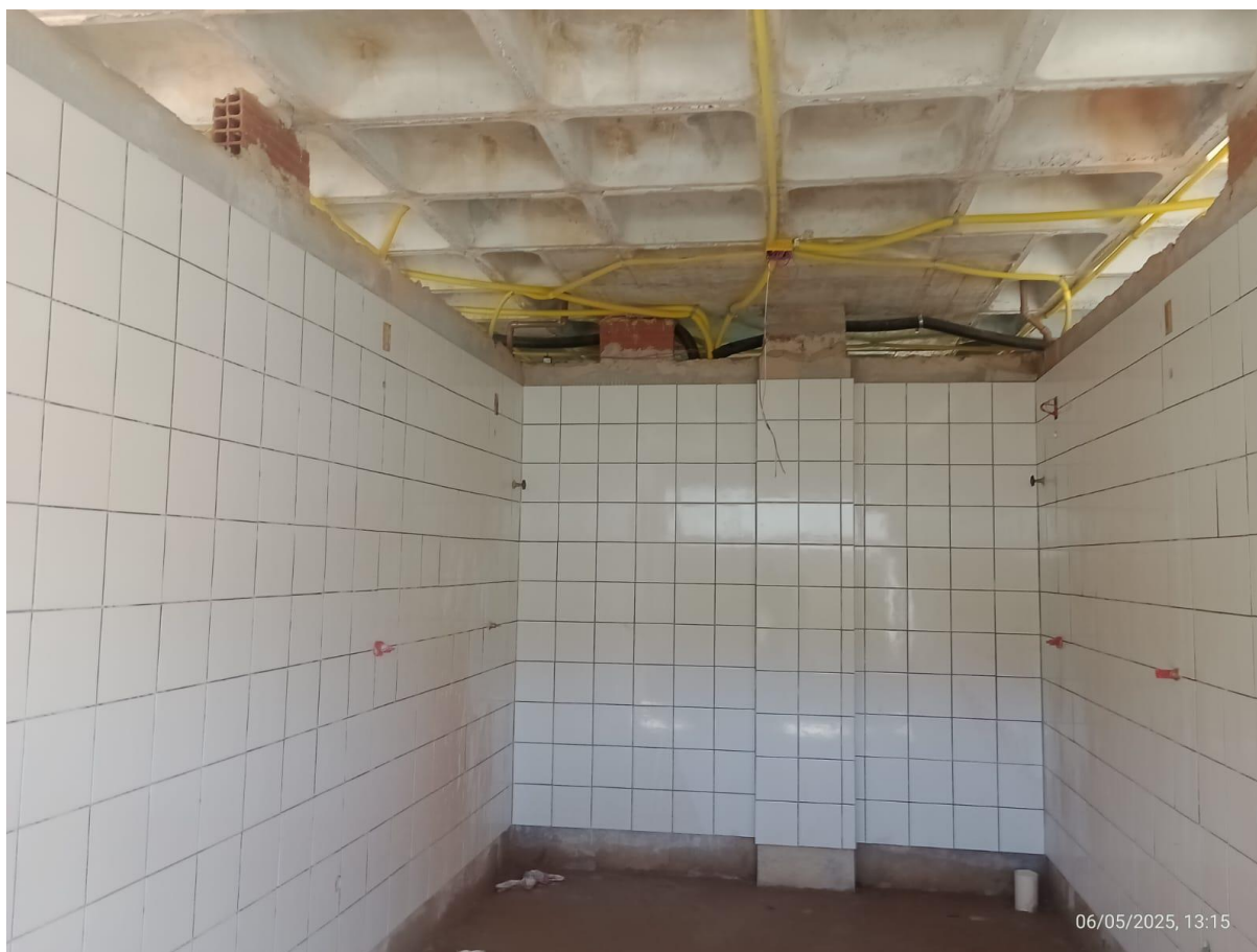
FOTO 15 – Revestimento das paredes dos banheiros, indicação dos registros hidráulicos.
