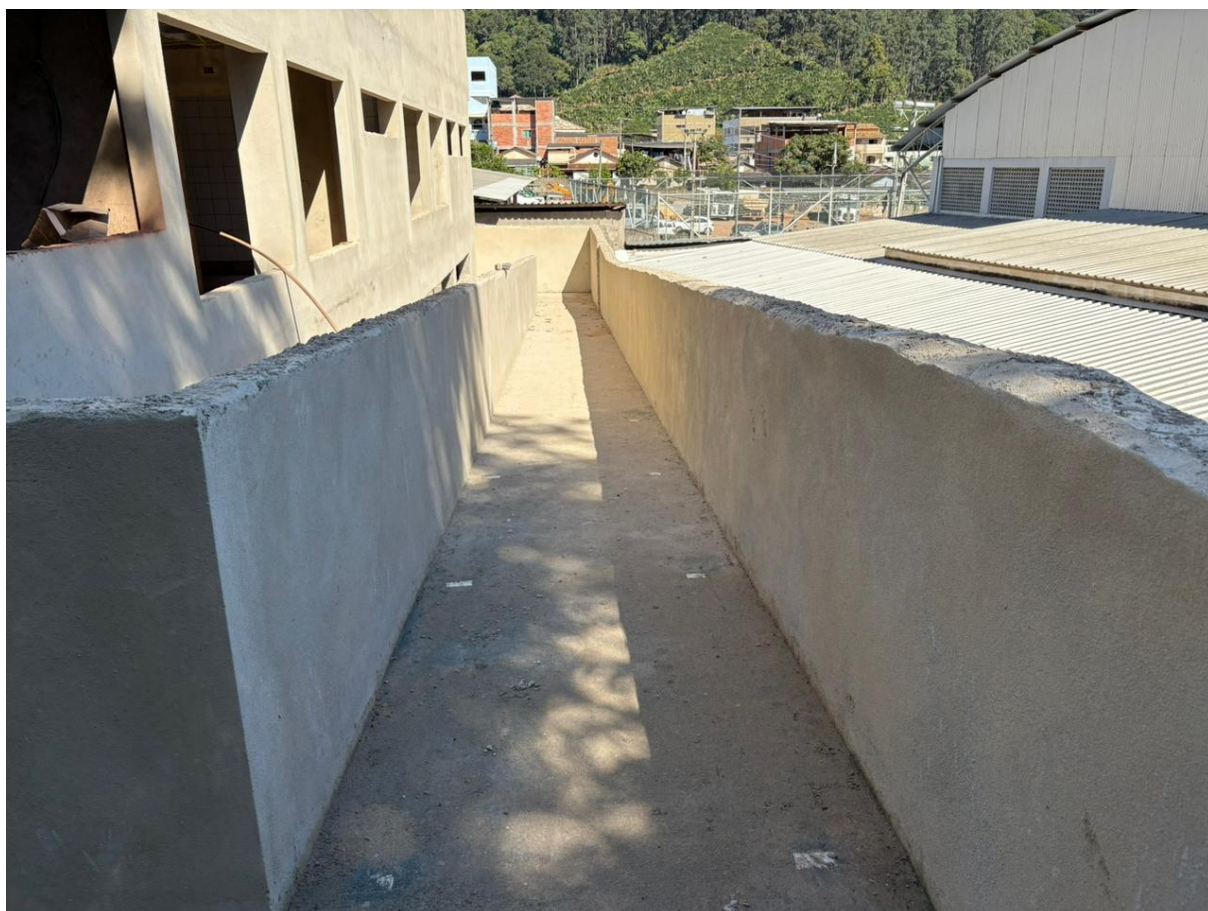
FOTO 10 – Contrapiso Rampa concluído.
