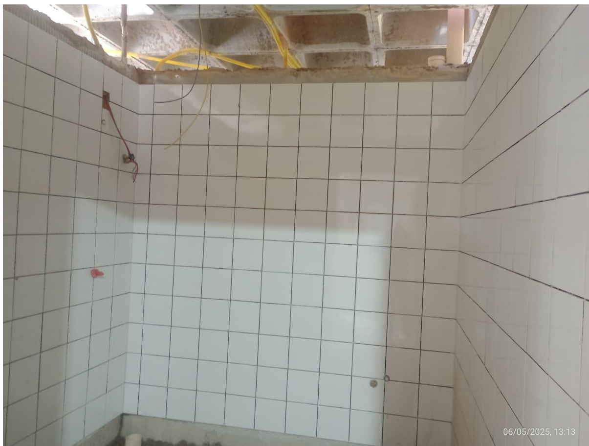
FOTO 14 – Revestimento das paredes dos banheiros do pavimento superior, instalações hidráulicas e elétrica.
