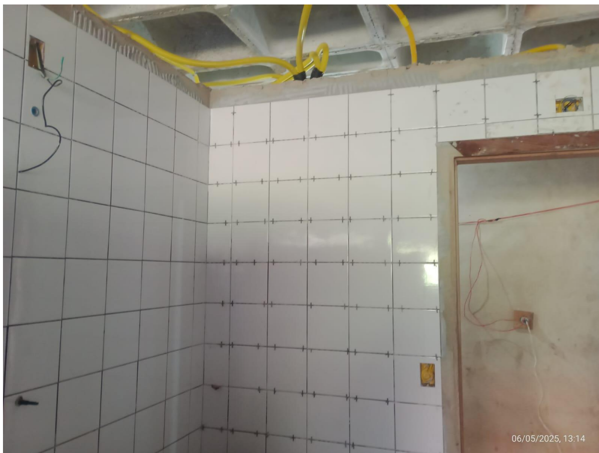
FOTO 16 – Aplicação do revestimento das paredes banheiros nível superior.
