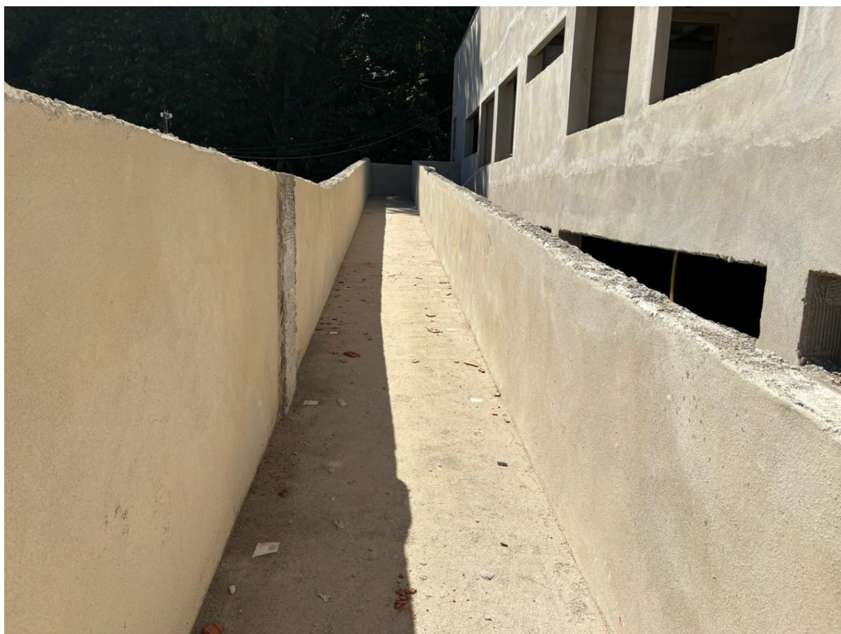
FOTO 11 – Contrapiso Rampa concluído.
