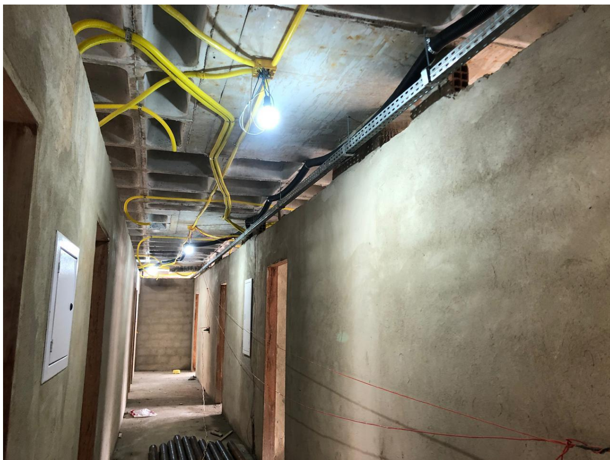
FOTO 04 – Eletrodutos PEAD, eletrocalhas instaladas.
