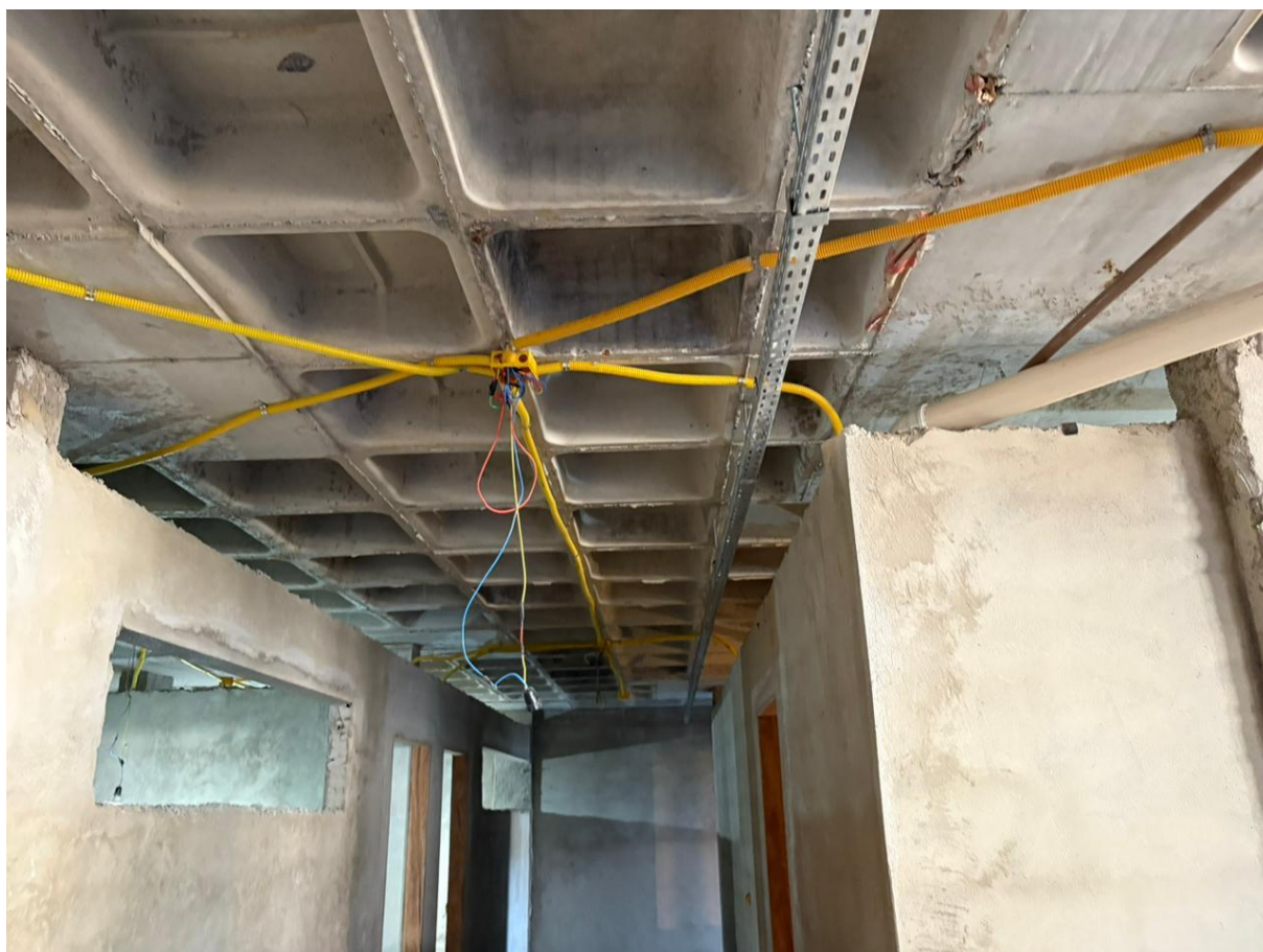
FOTO 06 – Eletrocalhas instaladas
