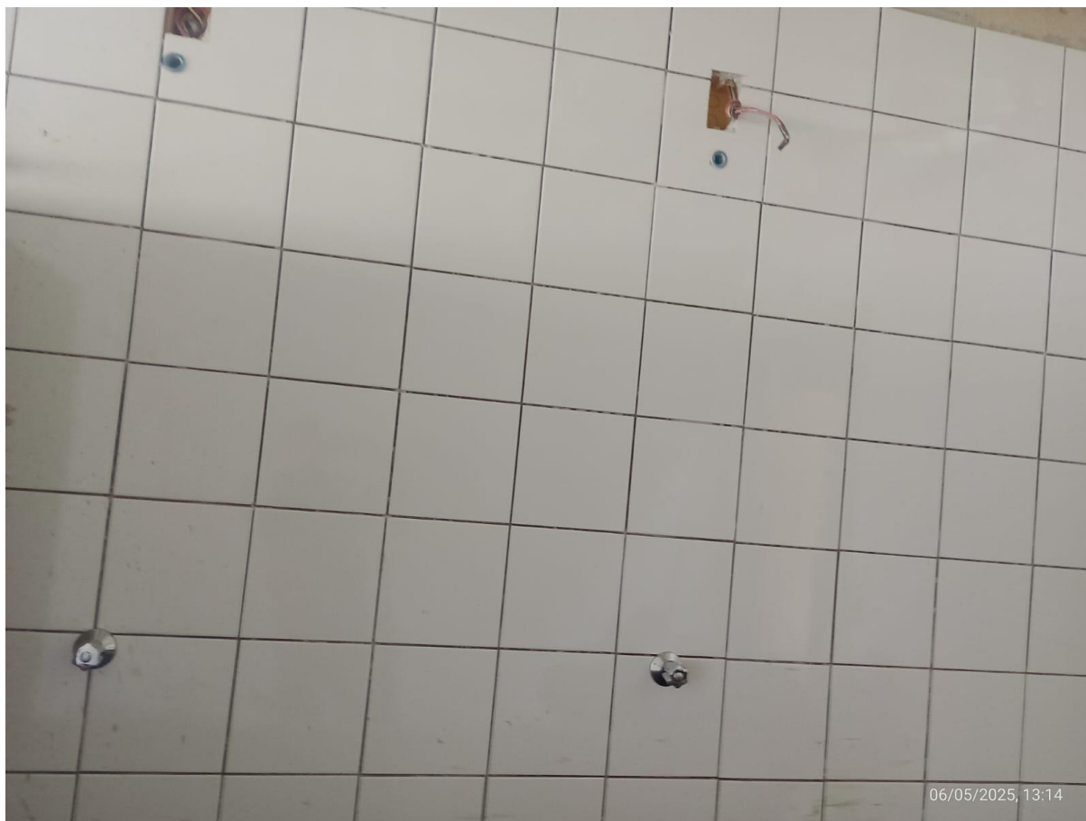
FOTO 01 – Instalações hidráulicas concluídas, aplicação de revestimento nas paredes. Pav. Superior.
